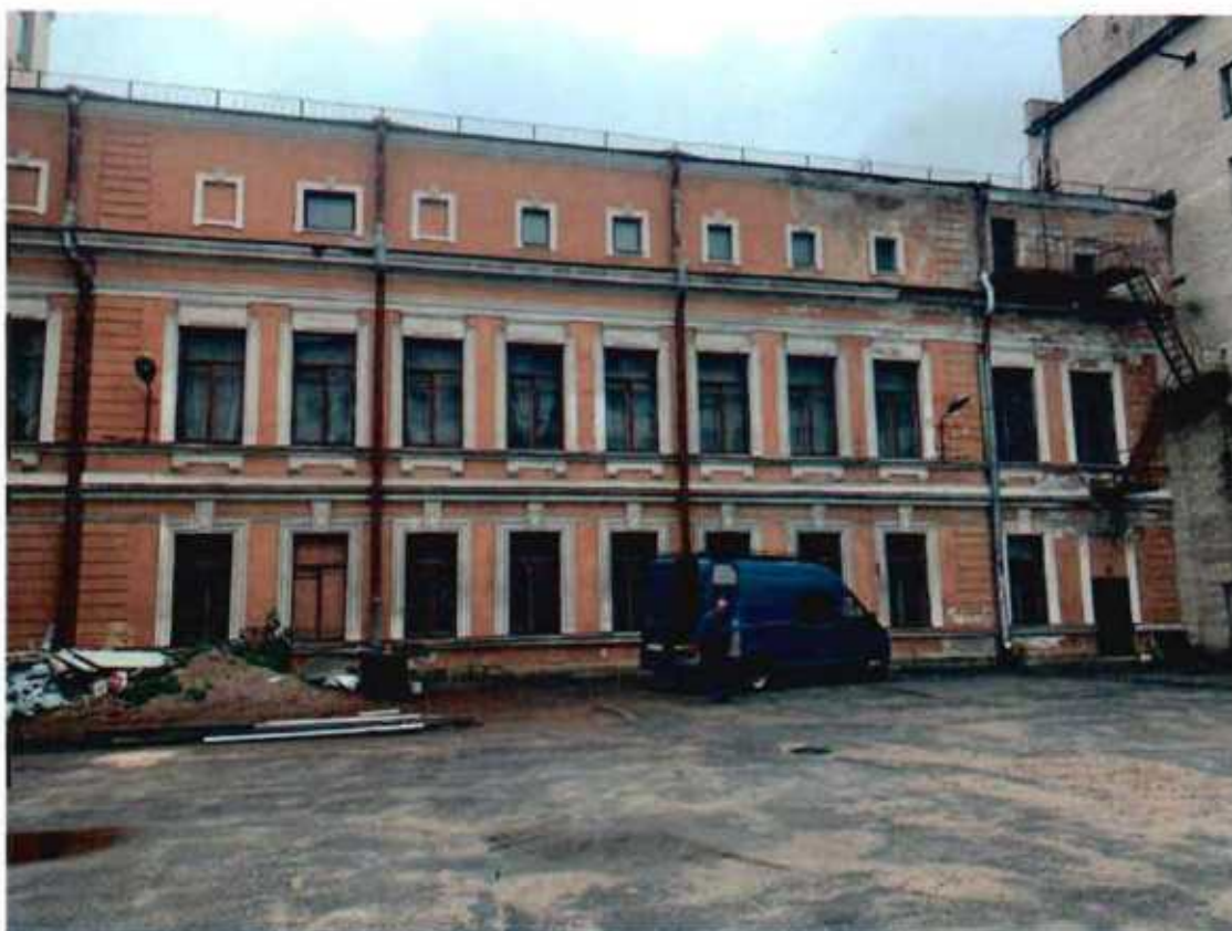
2. Вид на северный фасад объекта культурного наследия.
