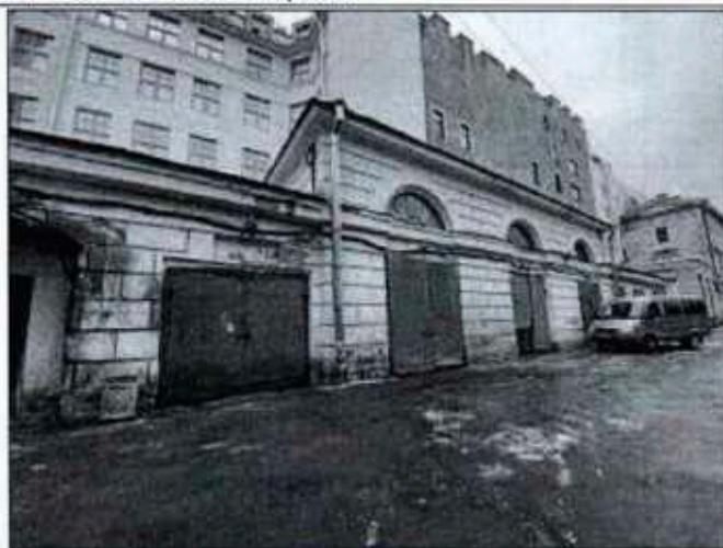
Фото 1. Фрагмент южного фасада объекта культурного наследия.
