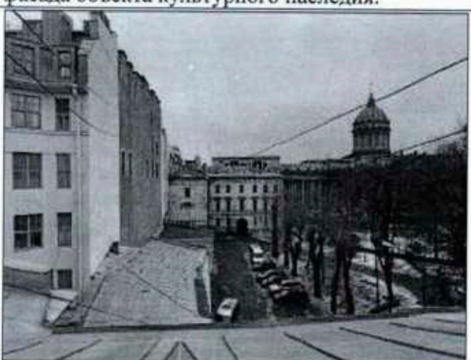
Фото 8. Фрагмент кровли объекта культурного наследия.
