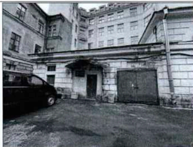
Фото 2. Фрагмент южного фасада объекта культурного наследия.
