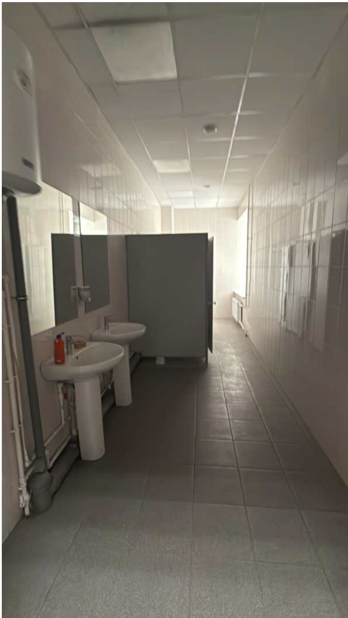
Фото 36. Общий вид на помещения 3-го этажа.
