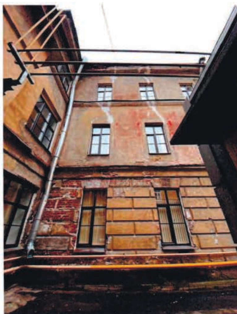
3. Фрагмент западного фасада объекта культурного наследия.
