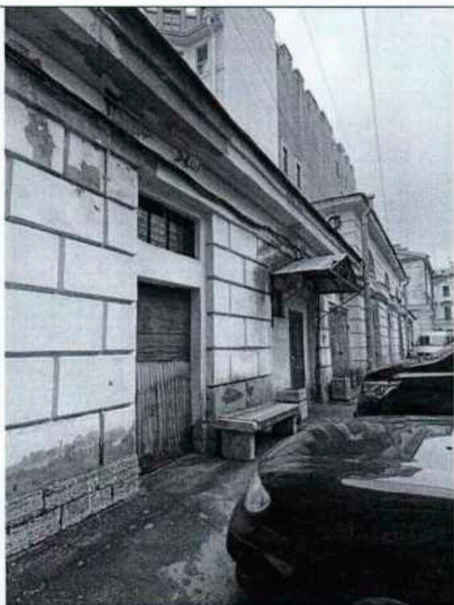
Фото 10. Фрагмент южного фасада объекта культурного наследия.
