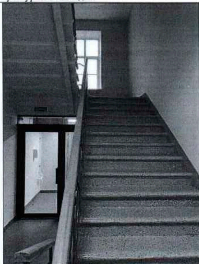
Фото 19. Лестница объекта культурного наследия.
