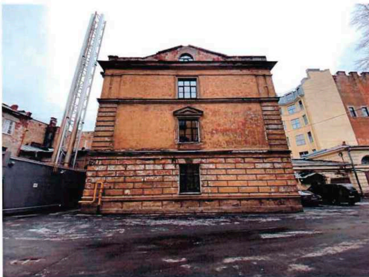
1. Фрагмент южного фасада объекта культурного наследия.
