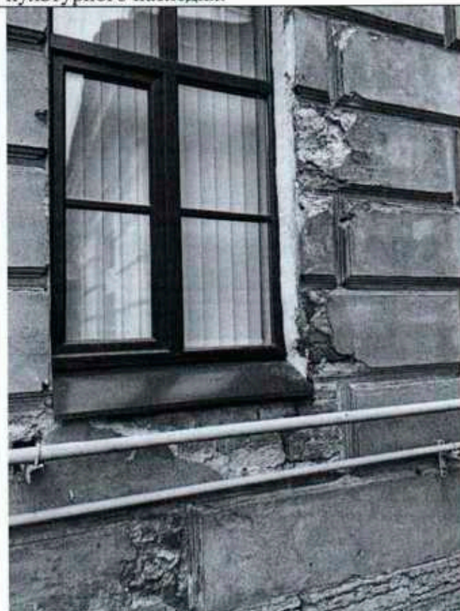
Фото 12. Фрагмент восточного фасада объекта культурного наследия.
