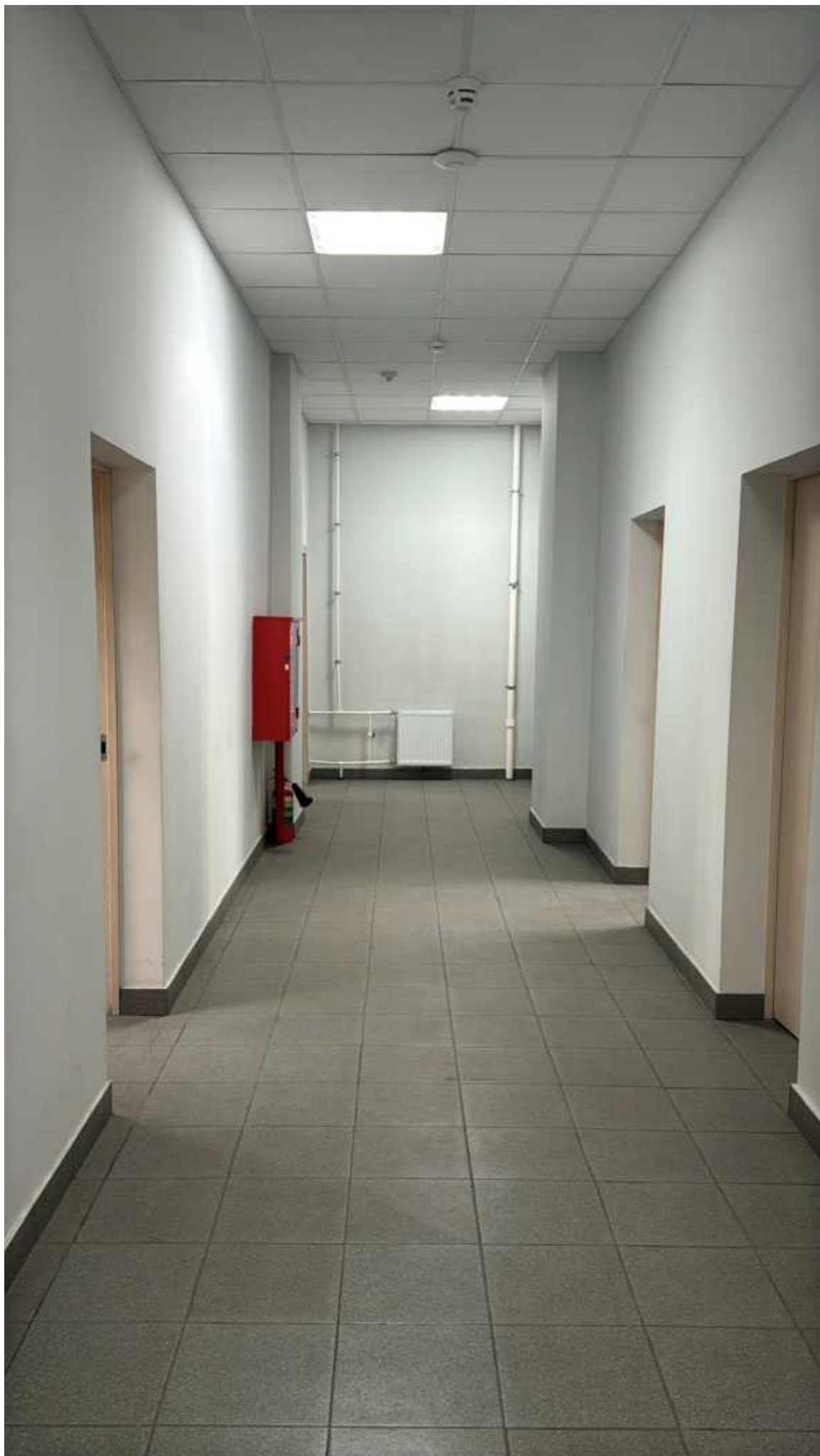
Фото 27. Общий вид на помещения 3-го этажа.
