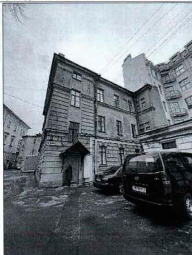
Фото 3. Восточный фасад объекта культурного наследия.
