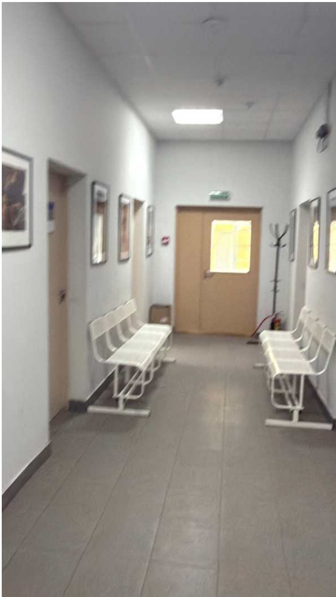
Фото 18. Общий вид на помещения 2-го этажа.
