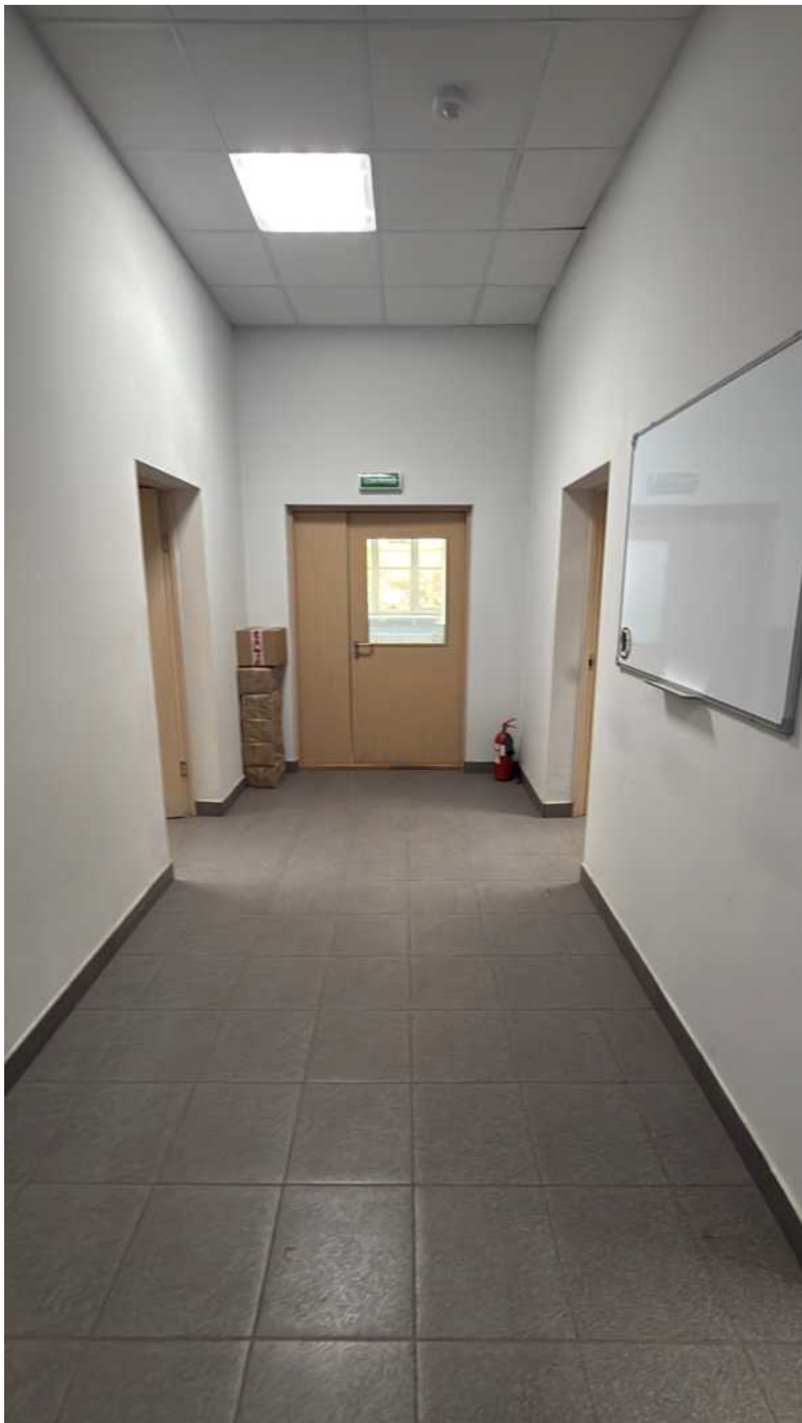
Фото 7. Общий вид на помещения 1-го этажа.
