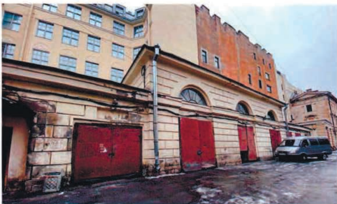
2. Фрагмент южного фасада объекта культурного наследия.
