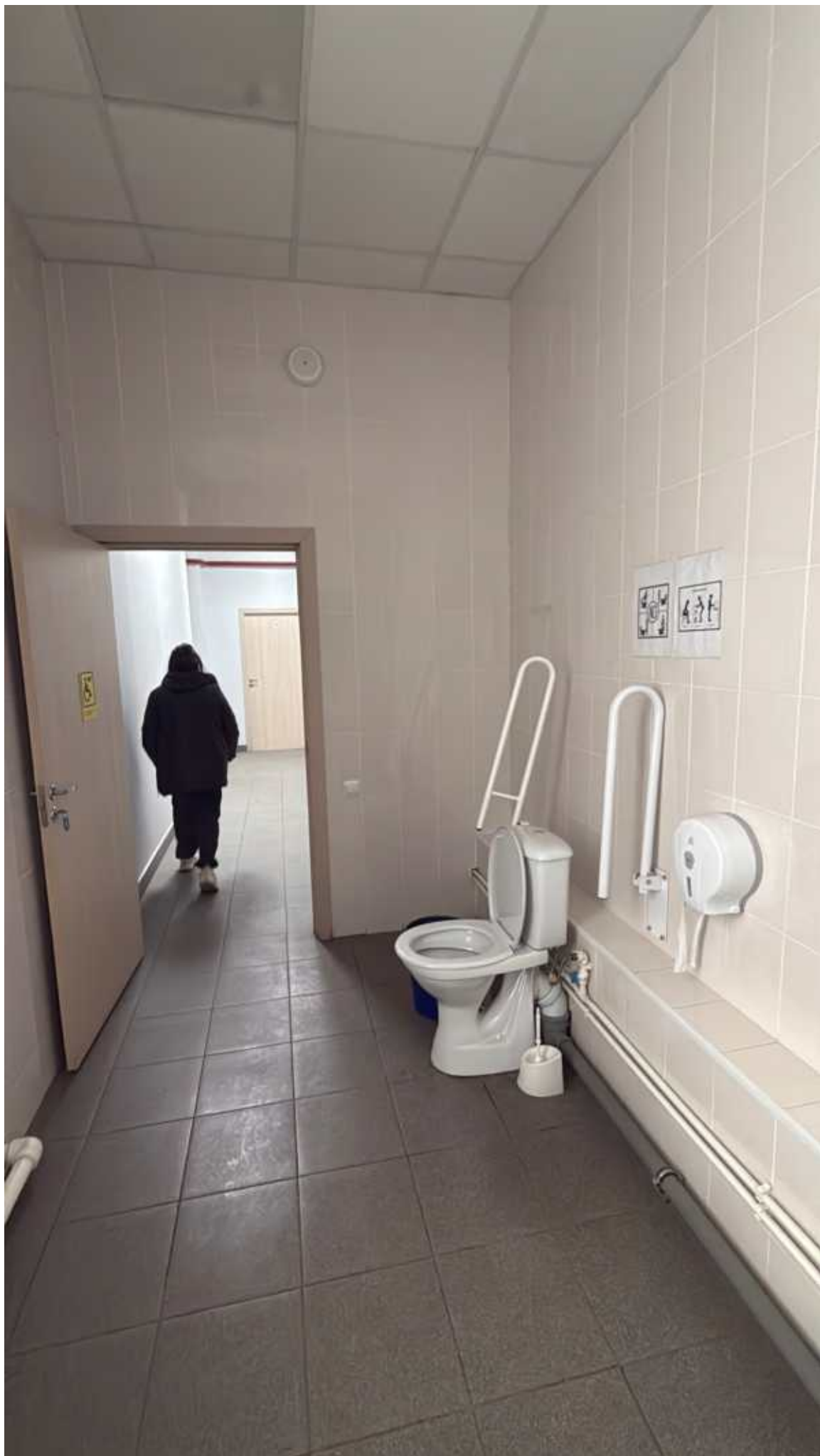
Фото 15. Общий вид на помещения 1-го этажа.
