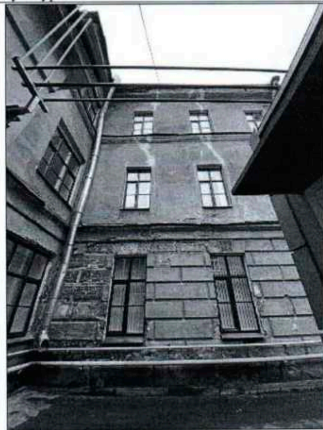
Фото 4. Западный фасад объекта культурного наследия.
