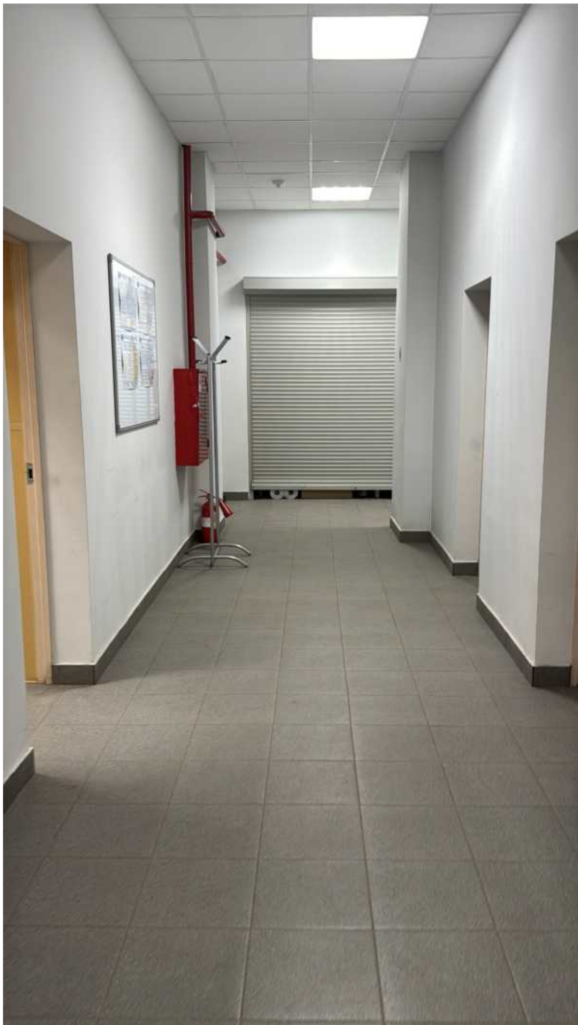
Фото 6. Общий вид на помещения 1-го этажа.
