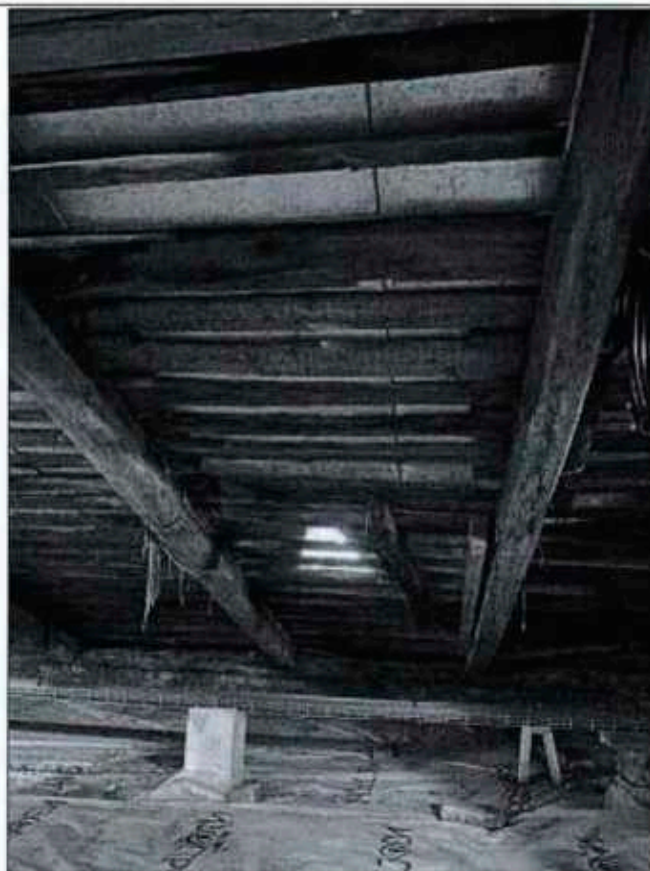
Фото 14. Чердачное помещение объекта культурного наследия.
