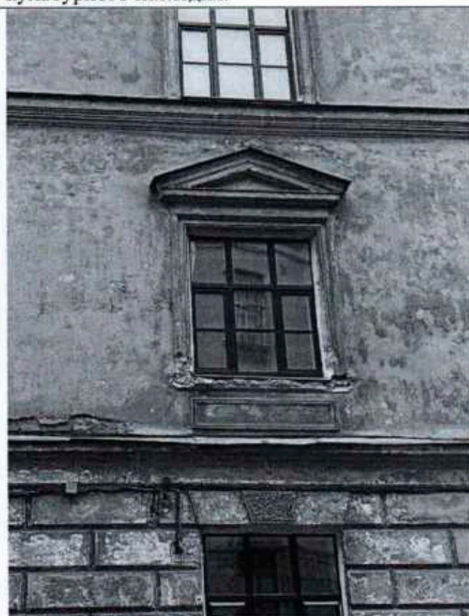
Фото 11. Фрагмент южного фасада объекта культурного наследия.
