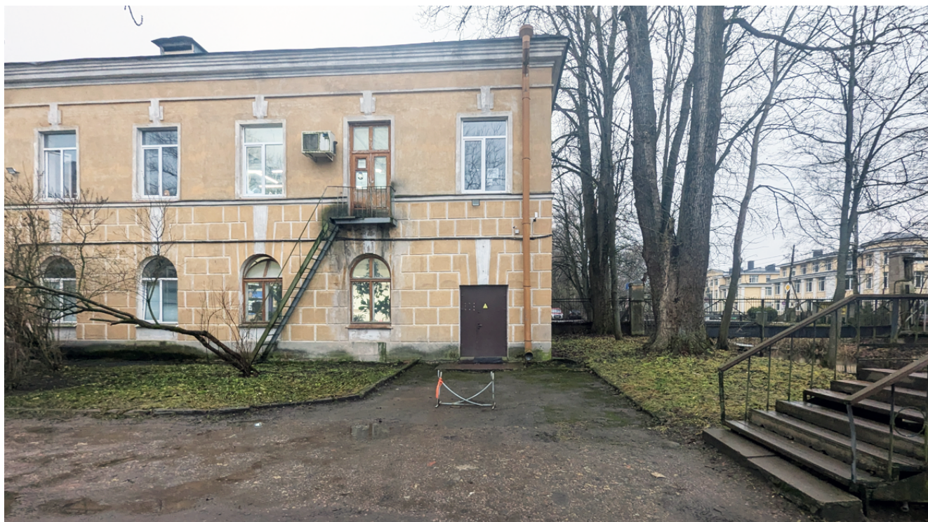
Фото №7. Производственный корпус, Фабричная ул., д. 1, лит. И, не являющийся объектом культурного наследия, дата фотосъемки 10.03.2026 г.
