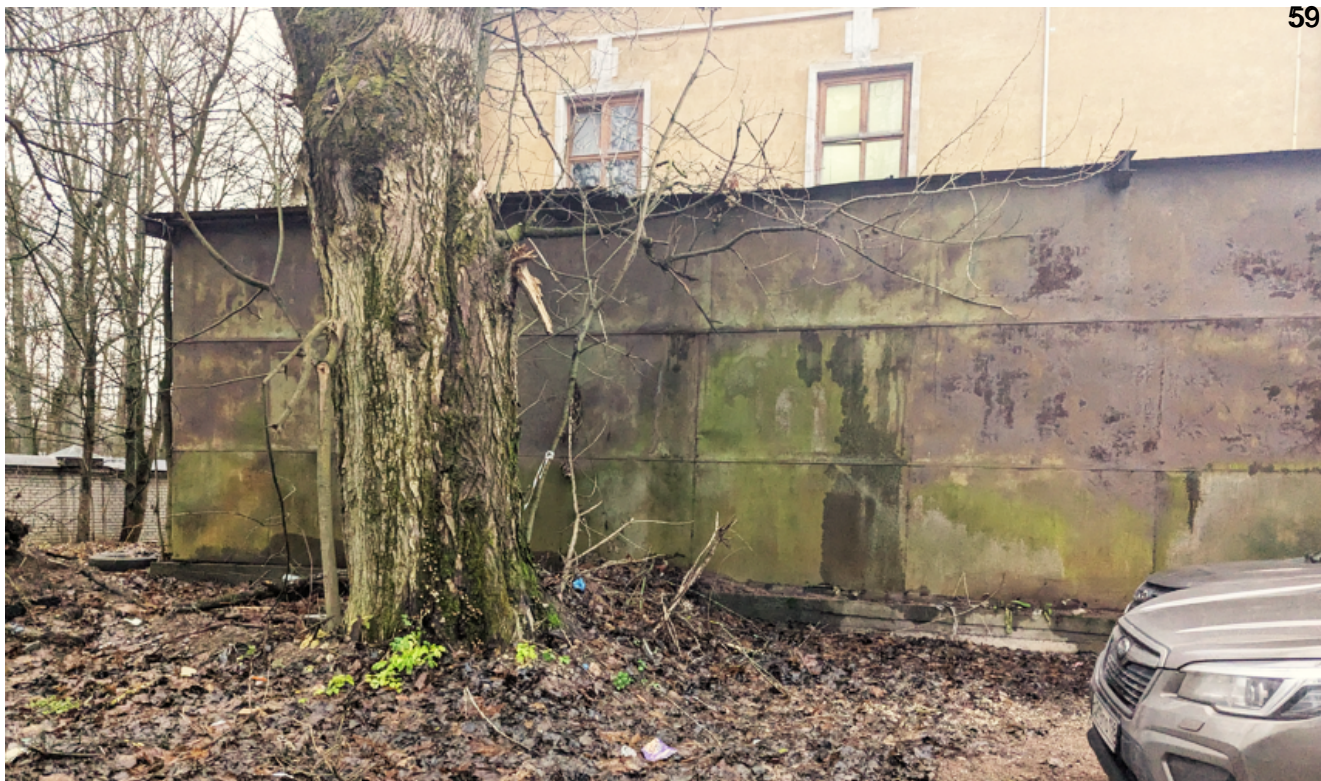
Фото №9. Производственный корпус, Фабричная ул., д. 1, лит. И, не являющийся объектом культурного наследия, дата фотосъемки 10.03.2026 г.
