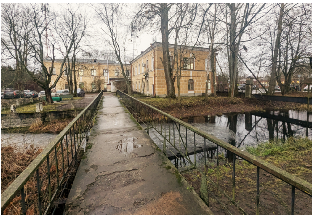
Фото №4. Производственный корпус, Фабричная ул., д. 1, лит. И, не являющийся объектом культурного наследия, дата фотосъемки 10.03.2026 г.
