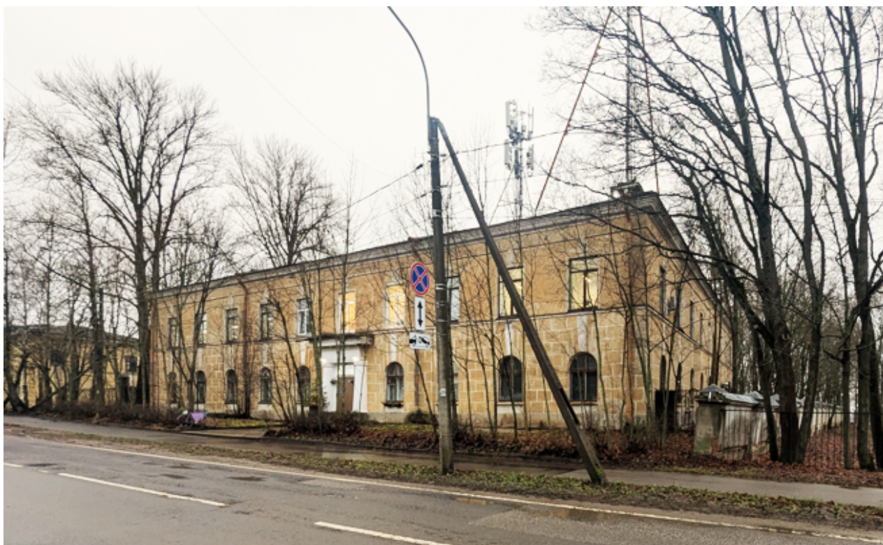
Фото №1. Производственный корпус, Фабричная ул., д. 1, лит. И, не являющийся объектом культурного наследия, дата фотосъемки 10.03.2026 г.
