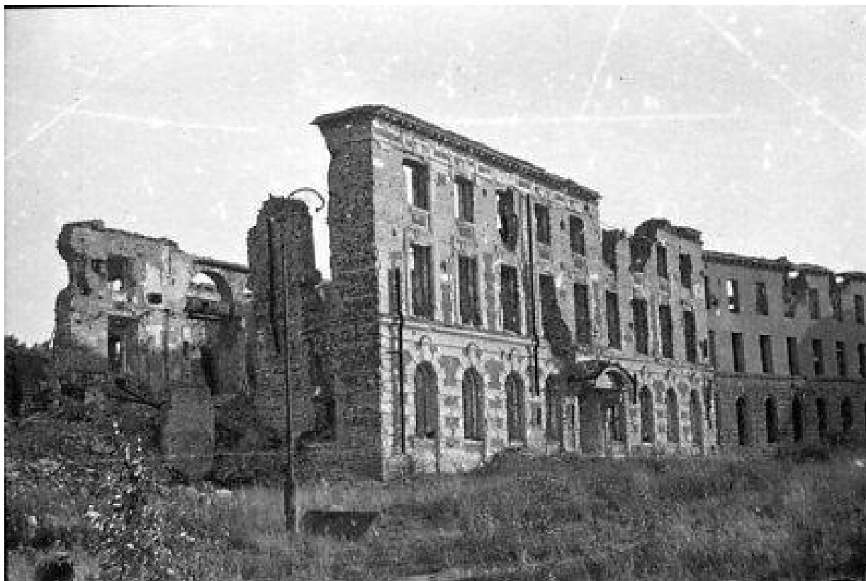
Фото 37. Разрушенная немцами Гранильная фабрика. 1947 г. РГАКФФД (Москва). 0-257631 ч/б.
