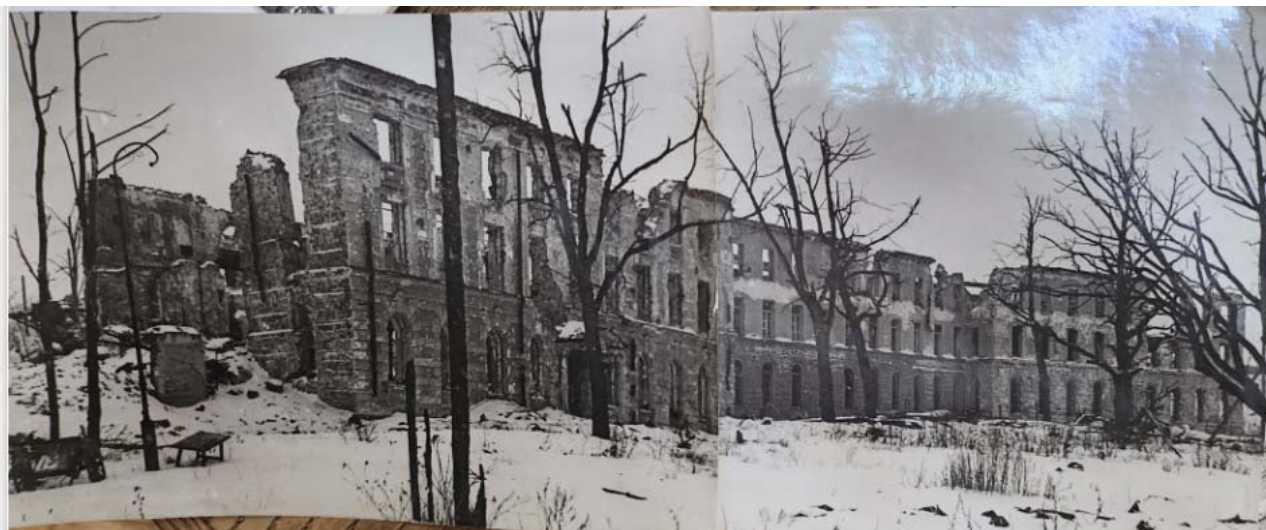
Фото 38. Разрушенная немцами Гранильная фабрика. 1947 г. РГАКФФД (Москва). 0-257632 ч/б.
