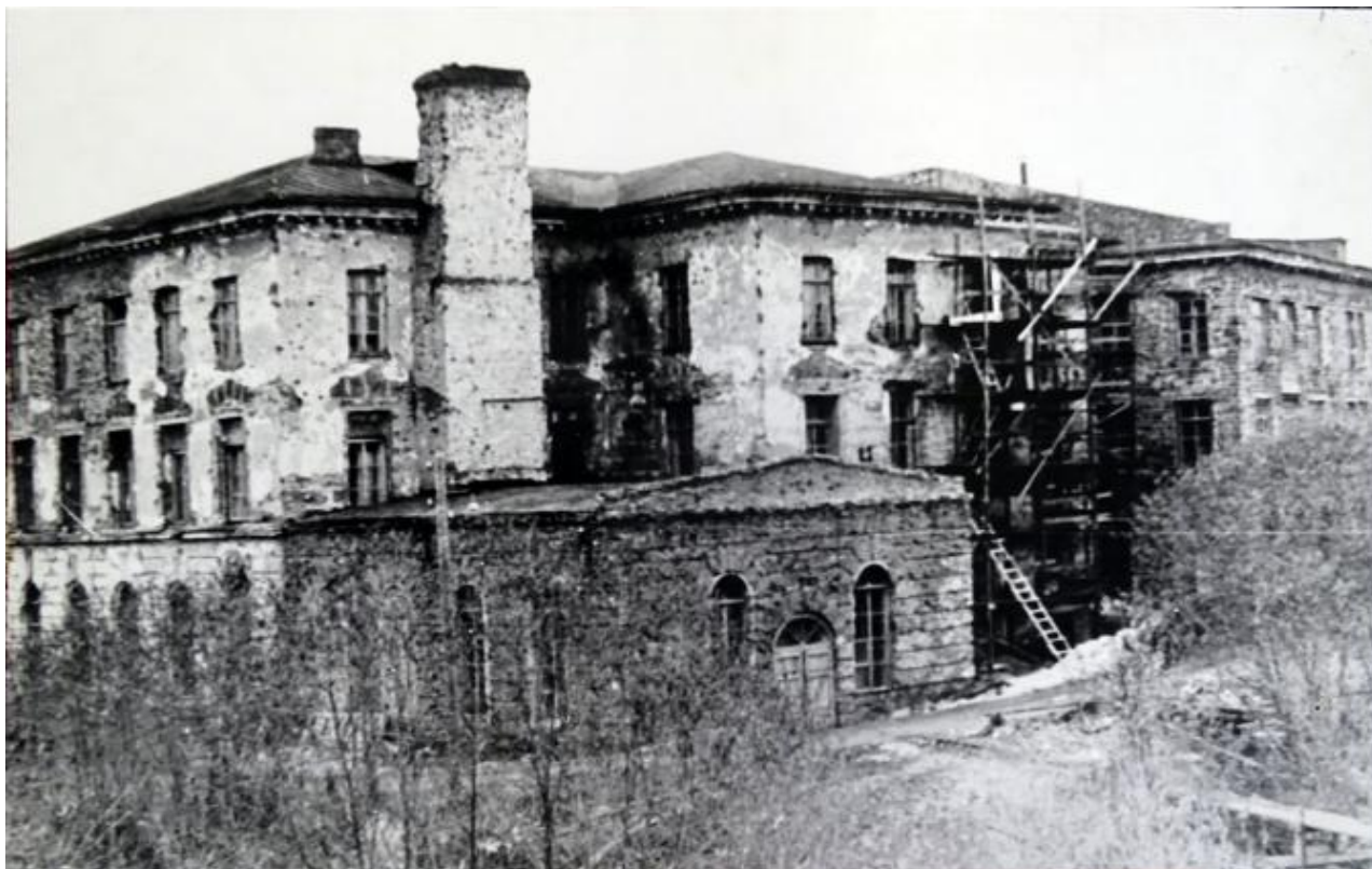
Фото 39. Восстановление Гранитной фабрики. 1940-е-1950-е гг. РГАКФФД (Москва). 0-257633 ч/б.
