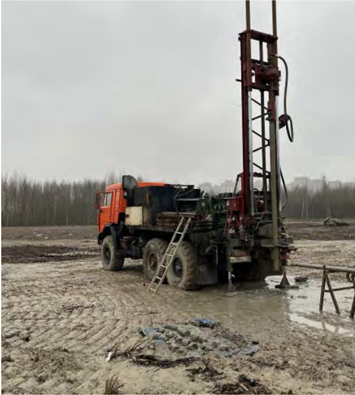
Рис. 1.1 Процесс бурения скважины
