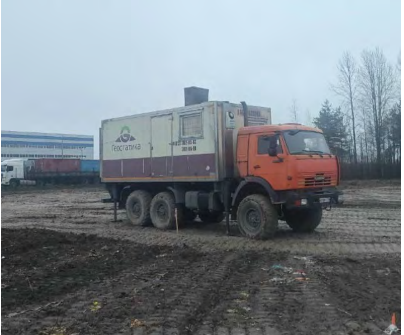
Рис.1.2 Процесс проведения испытания грунтов методом статического зондирования
