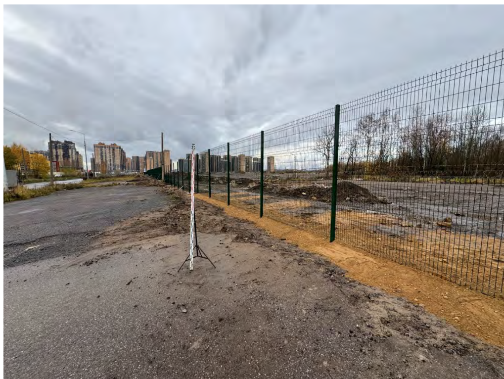
Илл. 96. г. Санкт-Петербург, Выборгский район – 2024 г. Точка фотофиксации №17. Вид с ЮВ.
