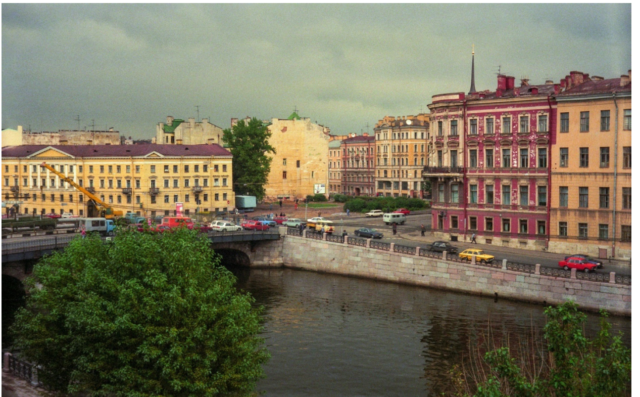
Илл.15. Мост Белинского в ходе капитального ремонта. Фото 1996 г. (из открытых источников)
