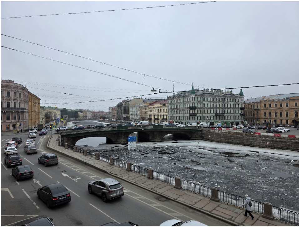
Фото 1. Мост Белинского и прилегающая часть набережной левого берега Фонтанки. Вид с северо-востока.
