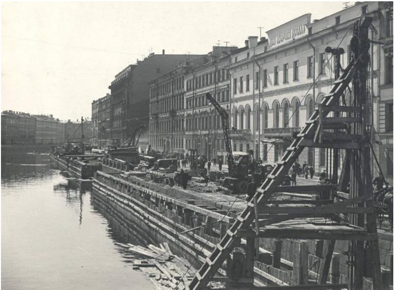
Илл. 12. Ремонт набережной Фонтанки у моста Белинского. 1950е гг. (из открытых источников)
