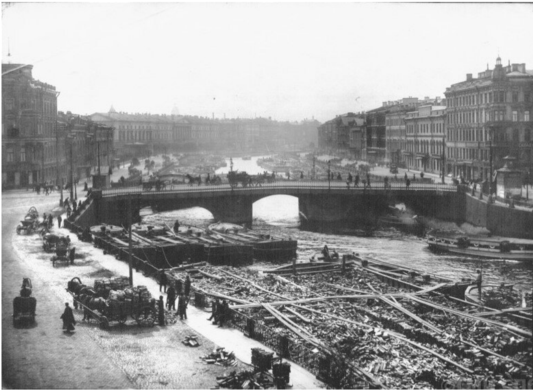
Илл.11. Симеоновский мост. Фото 1900 г. (из открытых источников)
