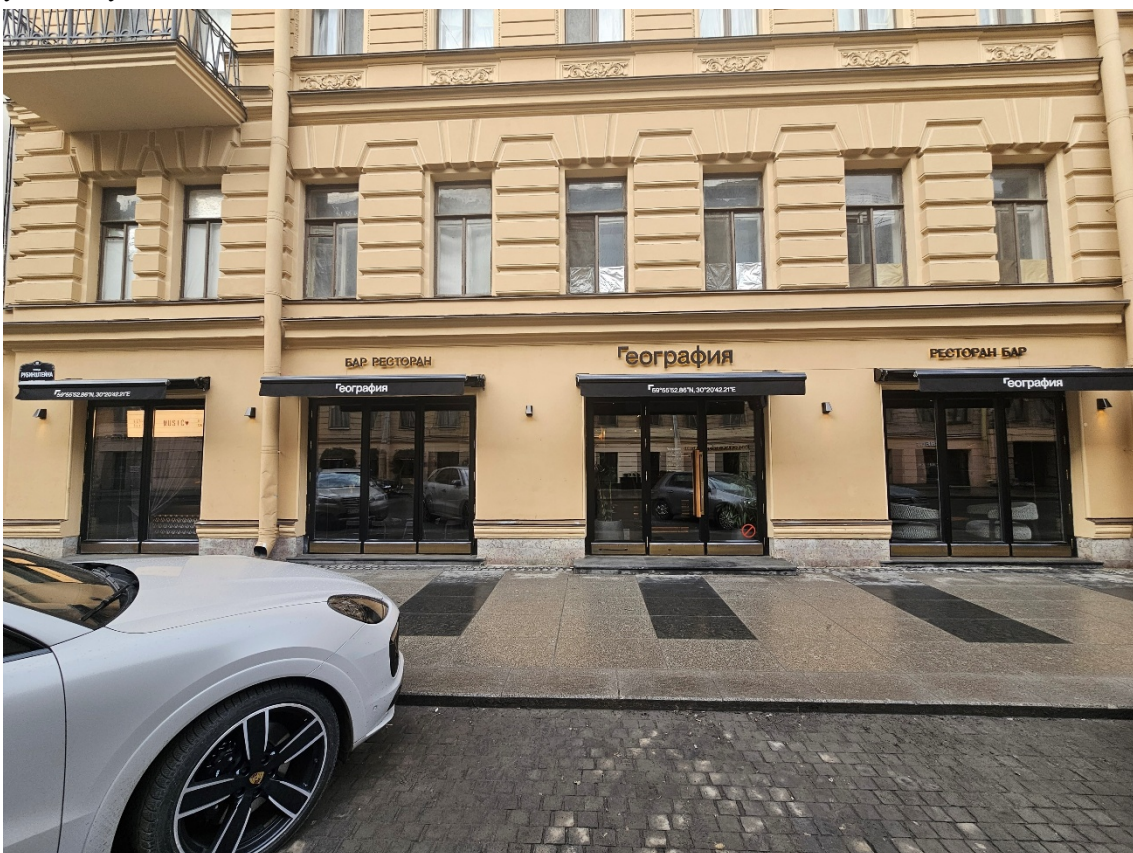
6. Выявленный объект культурного наследия «Дом Г.Г. Мекленбург-Стрелицкого», по адресу: г. Санкт-Петербург, ул. Рубинштейна, д. 5, лит. А. Фрагмент восточного лицевого фасада в границах пом. 14-Н по 1-му этажу.
