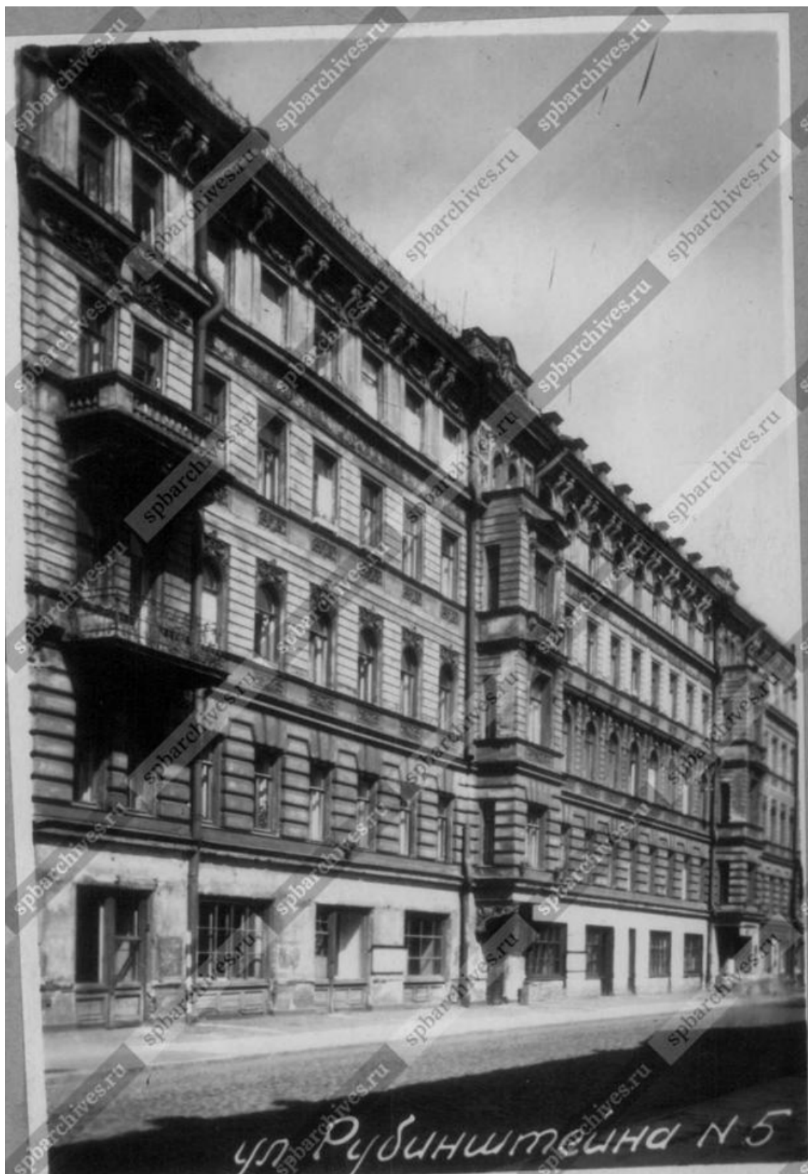
43. 1949 г. Фасад д. №5 на ул. Рубинштейна. ЦГАКФД СПб. Фотодокументы. Оп.1ГР-47. Ед.хр.72265.
