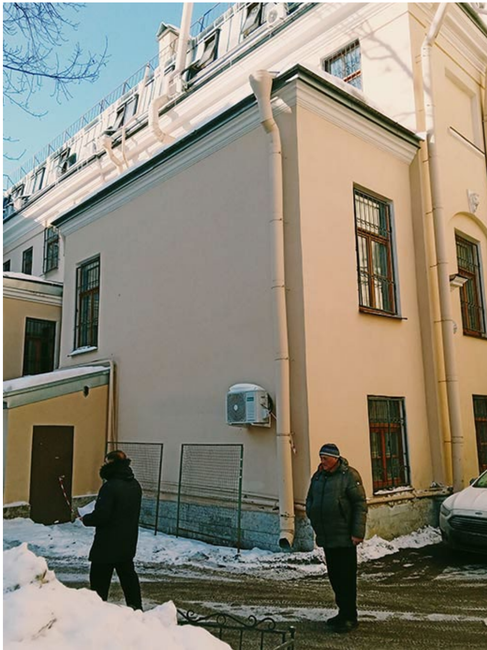
Фото 8. Объект культурного наследия федерального значения «Дом Пашковых», расположенный по адресу: г. Санкт-Петербург, наб. реки Фонтанки, д.18, лит. А. Фрагмент дворового фасада (северная часть). Место установки видеочамеры.
