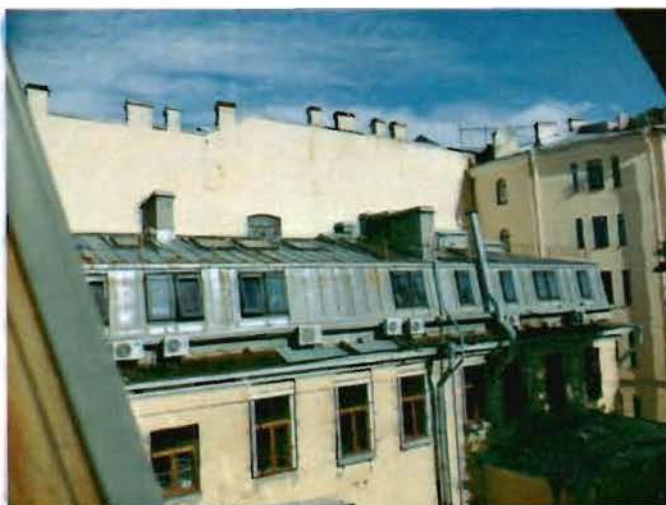
15. Мансардная надстройка над 3-им этажом
