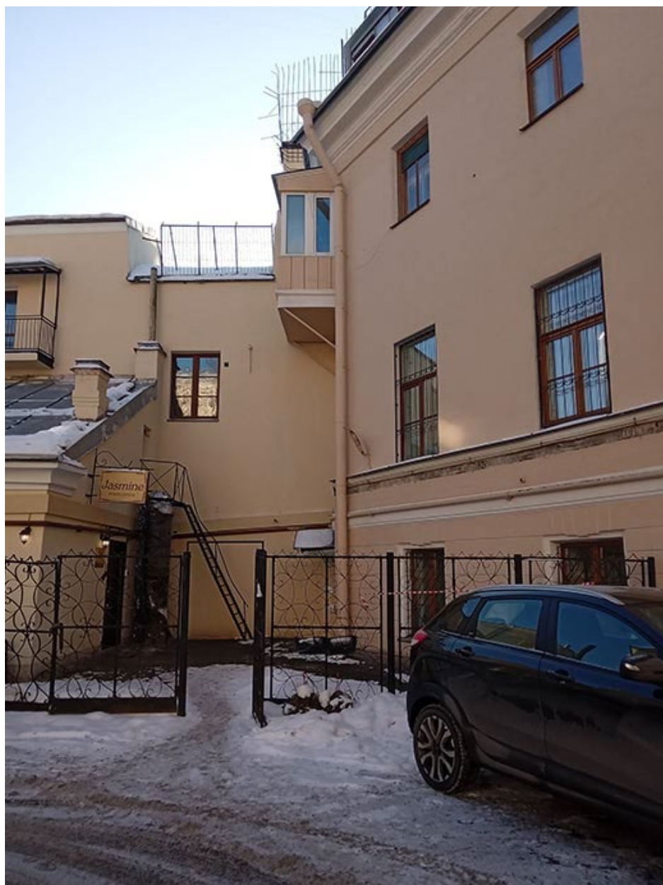
Фото 6. Объект культурного наследия федерального значения «Дом Пашковых», расположенный по адресу: г. Санкт-Петербург, наб. реки Фонтанки, д.18, лит. А.
