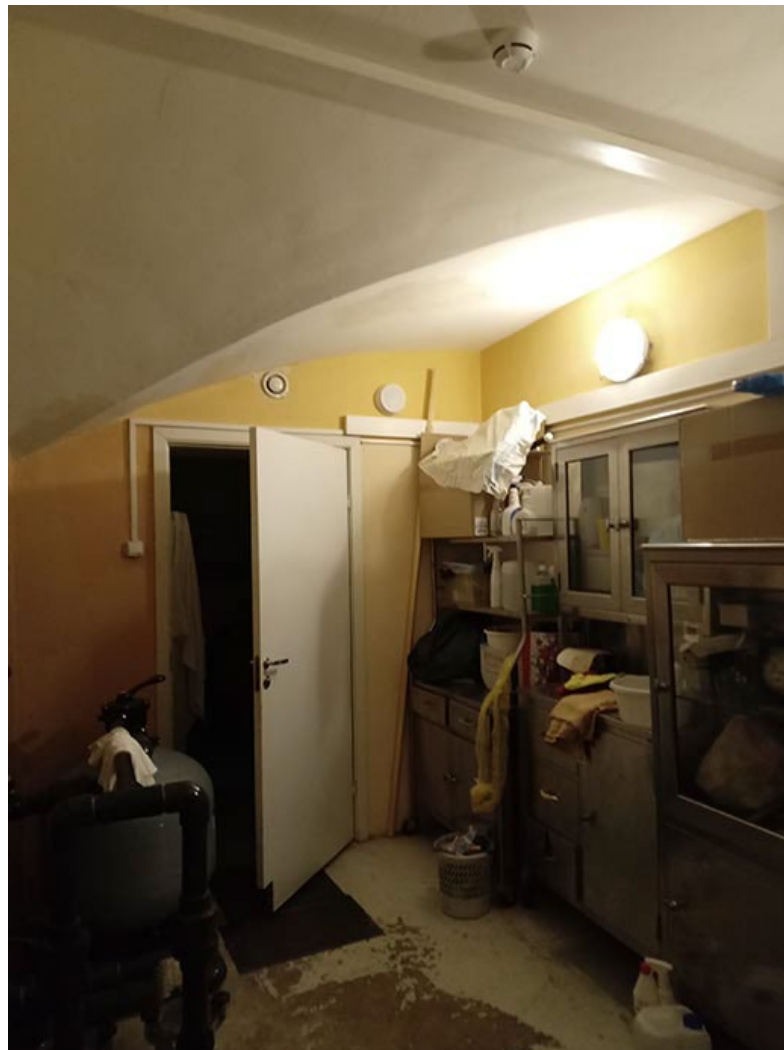
Фото 19. Объект культурного наследия федерального значения «Дом Пашковых», расположенный по адресу: г. Санкт-Петербург, наб. реки Фонтанки, д.18, лит. А.
