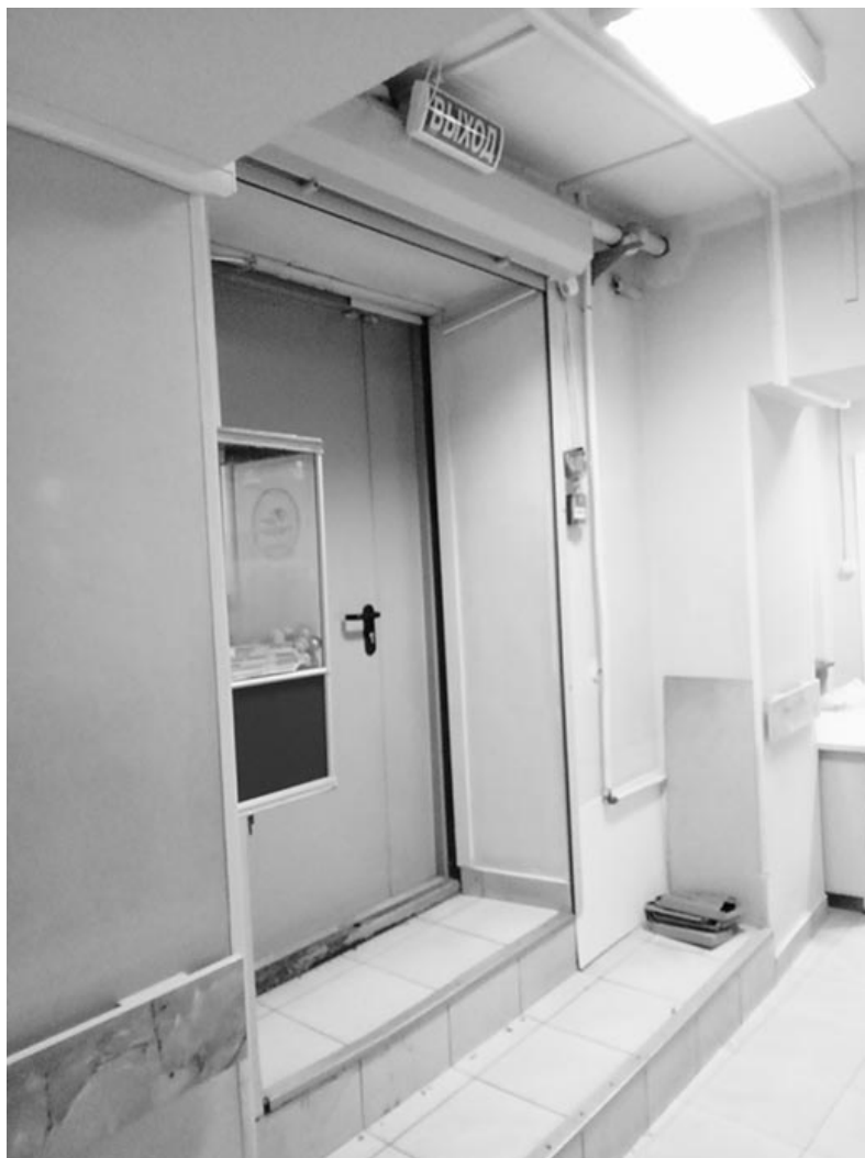
Фото 22. Объект культурного наследия федерального значения «Дом Пашковых», расположенный по адресу: г. Санкт-Петербург, наб. реки Фонтанки, д.18, лит. А.
