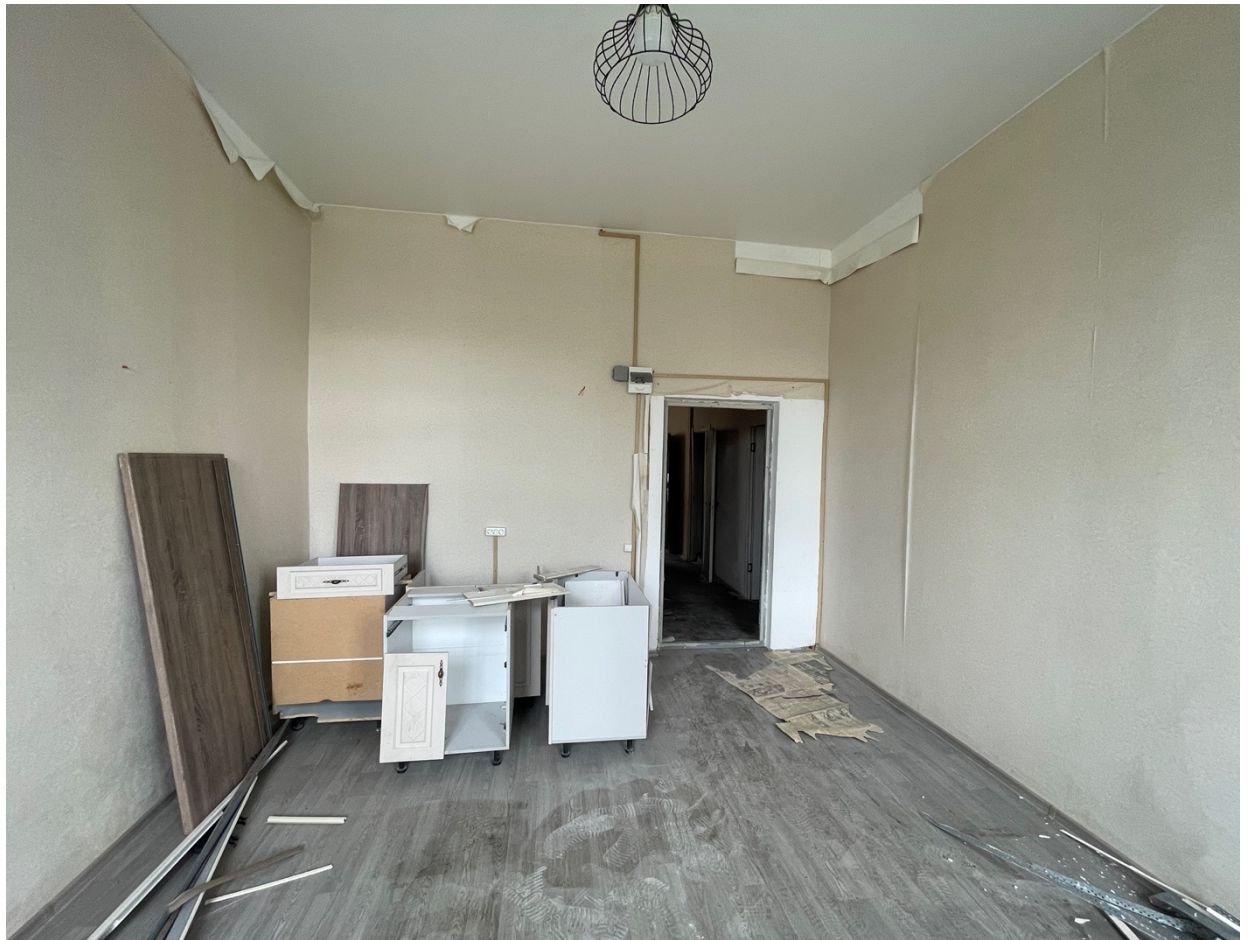
20.Фрагмент интерьера комнаты (помещение 11/18.6);
