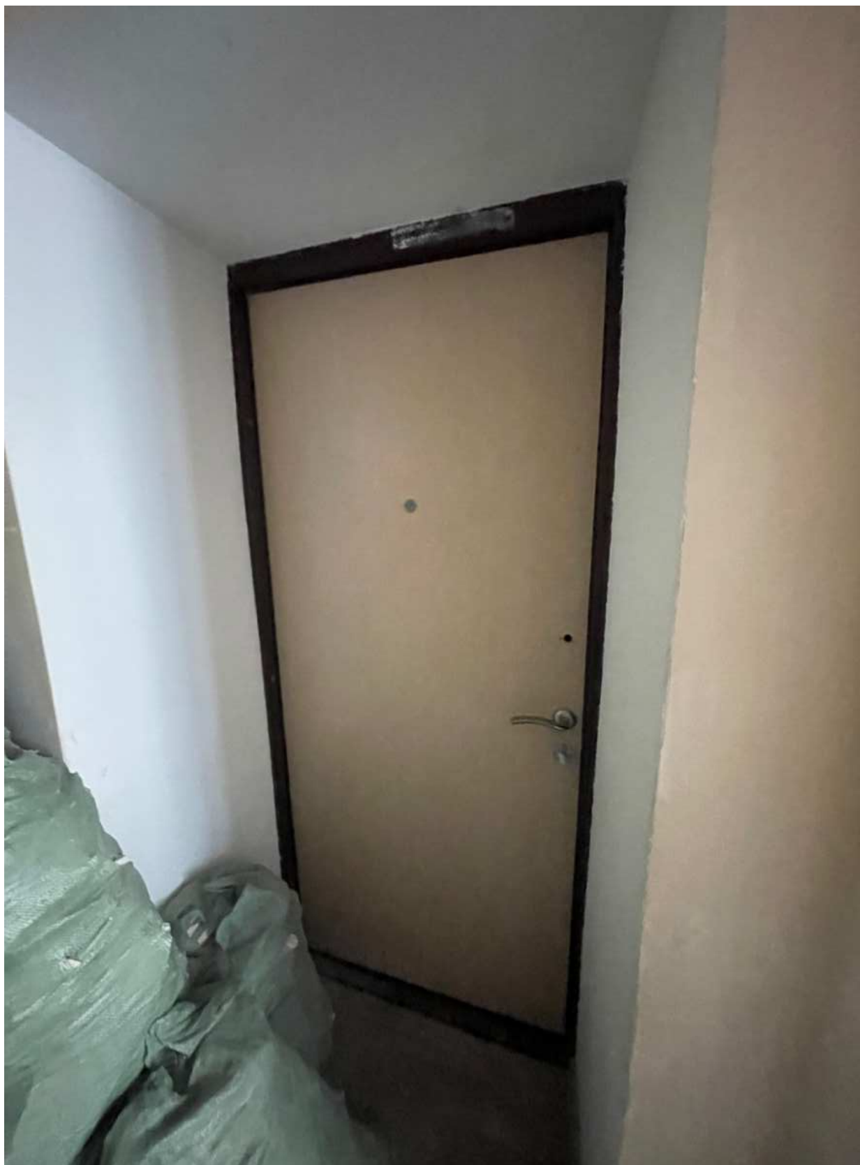
4. Вид на входную дверь в квартире;
