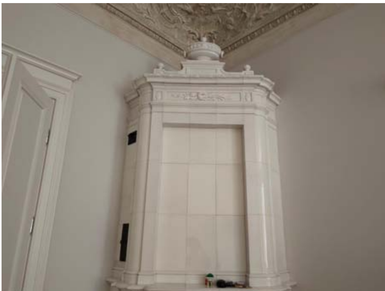
29. ОКН регионального значения «Жилой дом страхового общества “Россия” с садом и оградами» (г. Санкт-Петербург, Моховая ул., 27-29). Квартира № 37.
