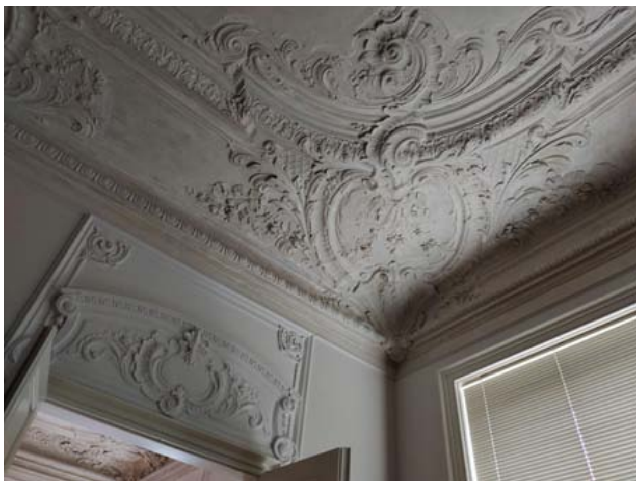
35. ОКН регионального значения «Жилой дом страхового общества “Россия” с садом и оградами» (г. Санкт-Петербург, Моховая ул., 27-29). Квартира № 37.
