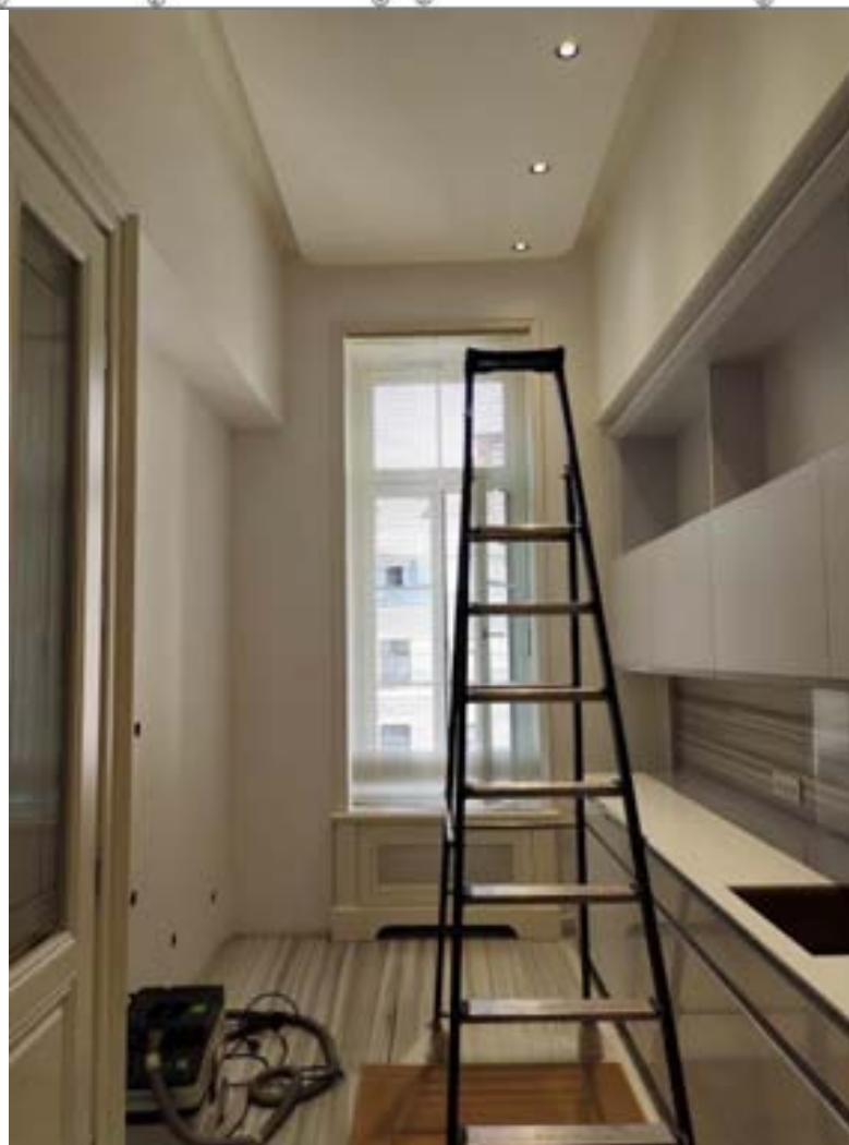
10. ОКН регионального значения «Жилой дом страхового общества «Россия» с садом и оградами» (г. Санкт-Петербург, Моховая ул., 27-29). Квартира № 37.
