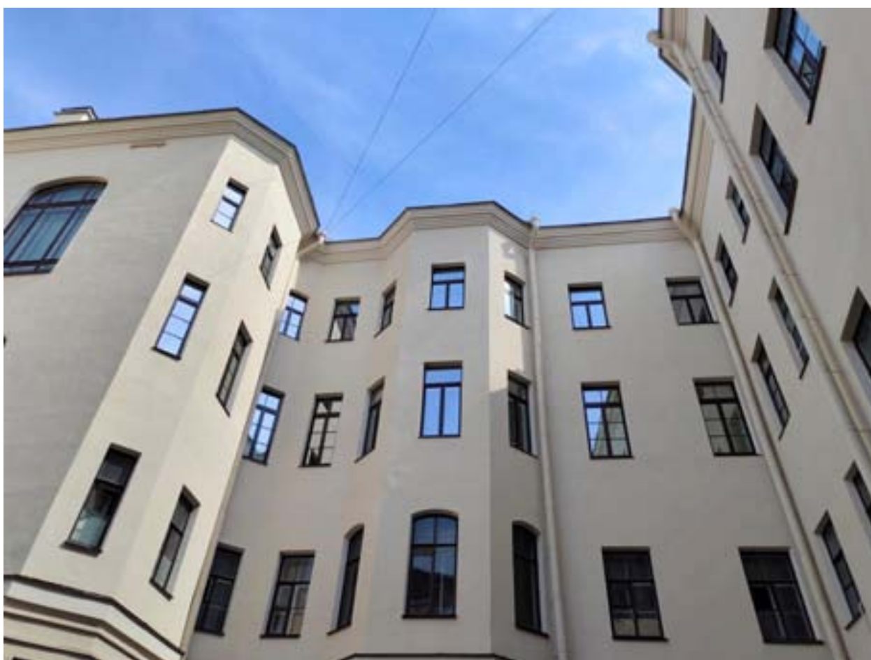
4. ОКН регионального значения «Жилой дом страхового общества “Россия” с садом и оградами» (г. Санкт-Петербург, Моховая ул., 27-29) Дворовый фасад
