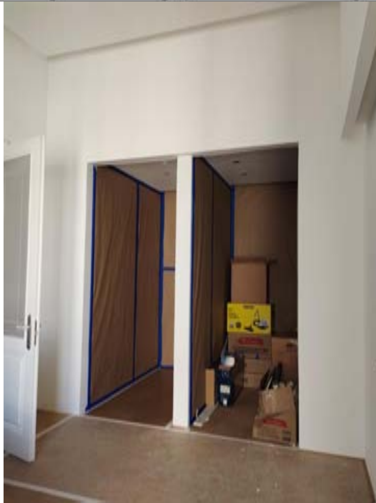
23. ОКН регионального значения «Жилой дом страхового общества «Россия» с садом и оградами» (г. Санкт-Петербург, Моховая ул., 27-29). Квартира № 37.
