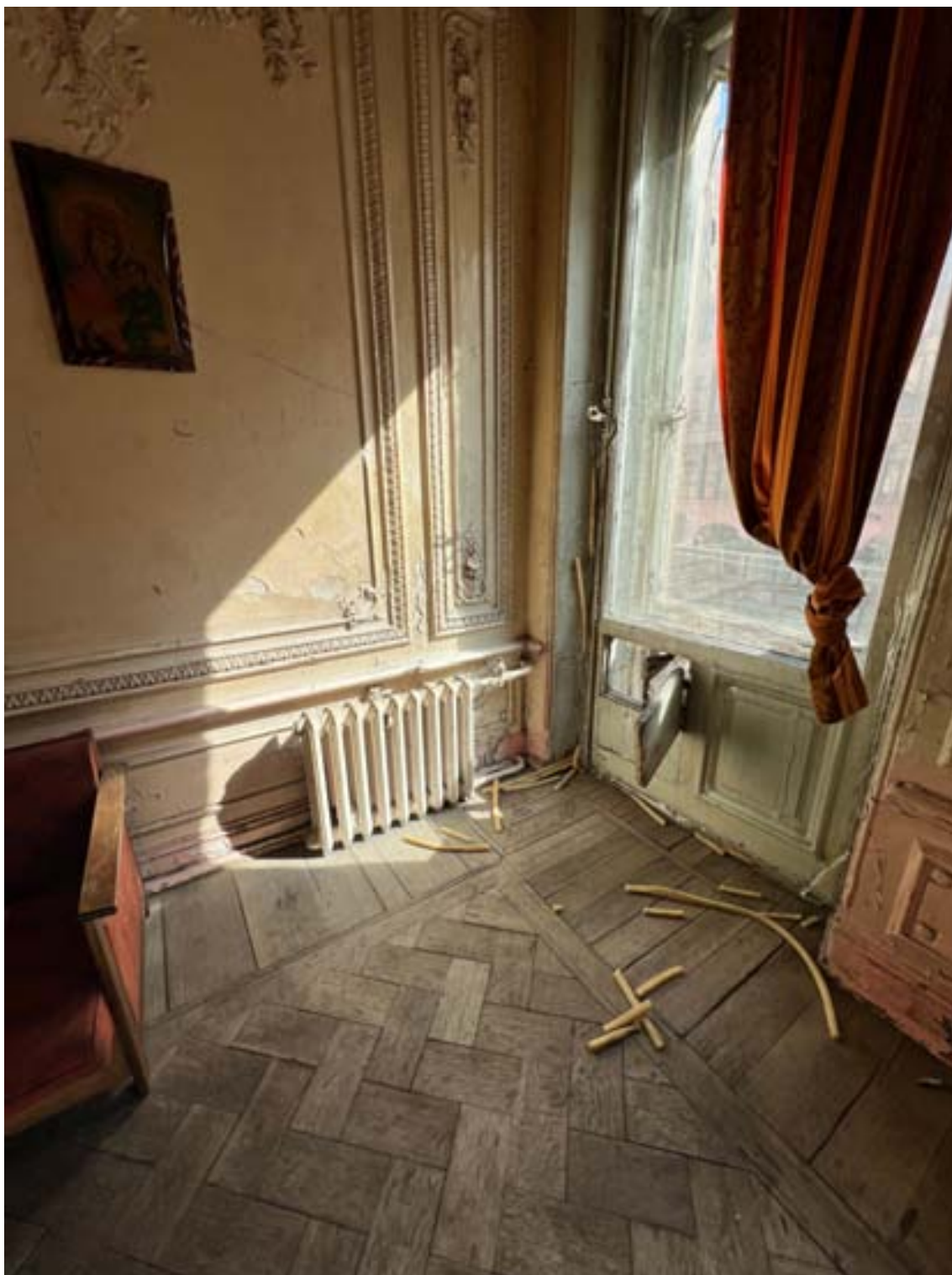
13. «Дом И.М. Екимова». Санкт-Петербург, ул.Кирочная, д.6, литера А. Фрагмент помещения кв.№3 (16-Н) Фото: 19.01.2026.
