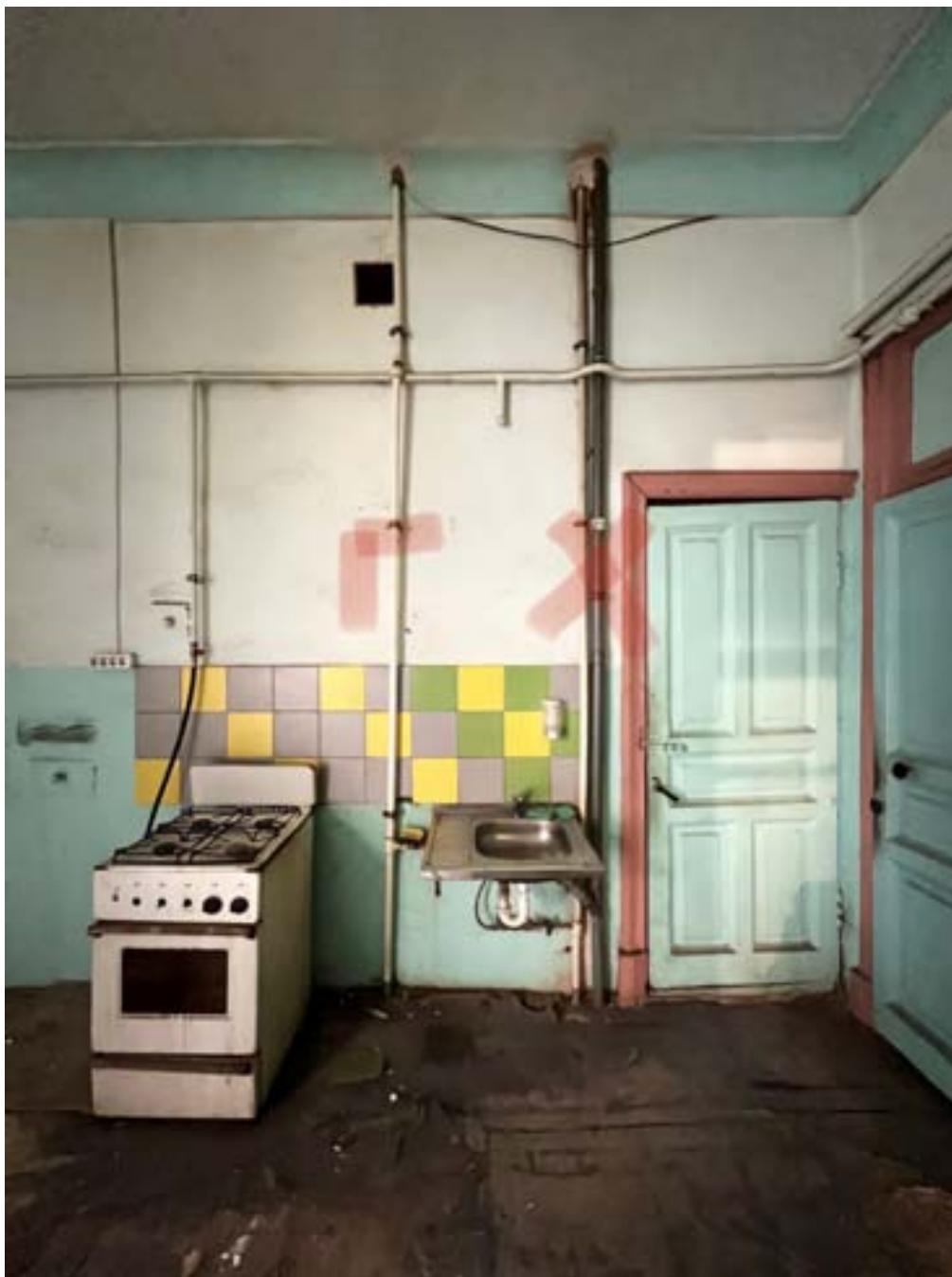
34. «Дом И.М. Екимова». Санкт-Петербург, ул.Кирочная, д.6, литера А. Фрагмент помещения кв.№3 (7-Н) Фото: 19.01.2026.
