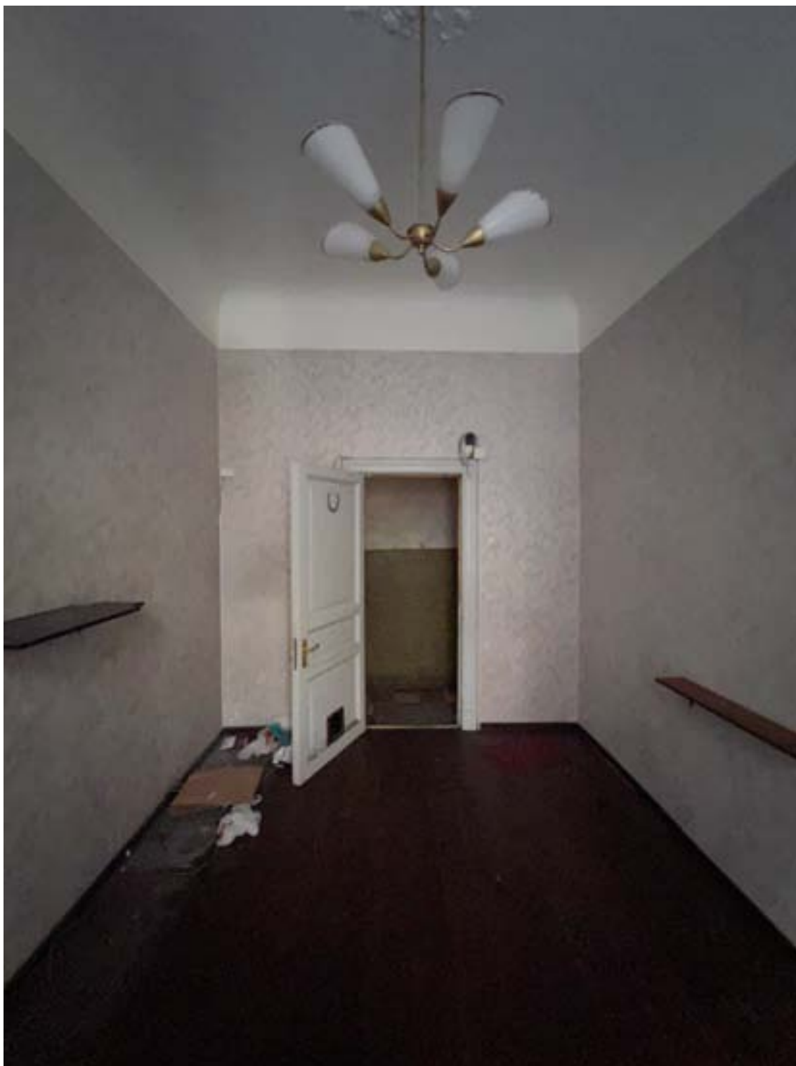
29. «Дом И.М. Екимова». Санкт-Петербург, ул.Кирочная, д.6, литера А. Фрагмент помещения кв.№3 (7-Н) Фото: 19.01.2026.
