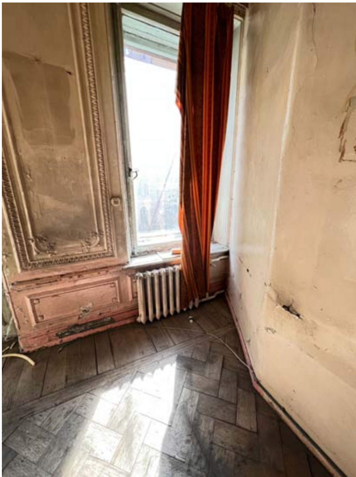
14. «Дом И.М. Екимова». Санкт-Петербург, ул.Кирочная, д.6, литера А. Фрагмент помещения кв.№3 (16-Н) Фото: 19.01.2026.
