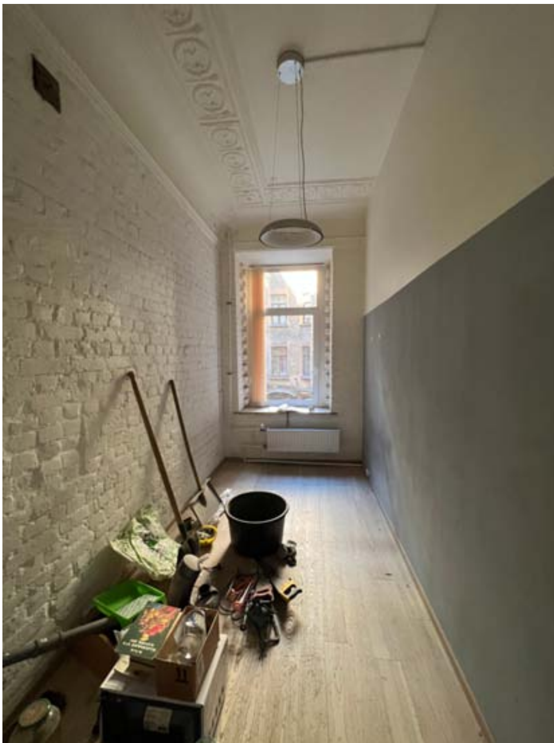
19. «Дом И.М. Екимова». Санкт-Петербург, ул.Кирочная, д.6, литера А. Фрагмент помещения кв.№3 (2-Н) Фото: 19.01.2026.
