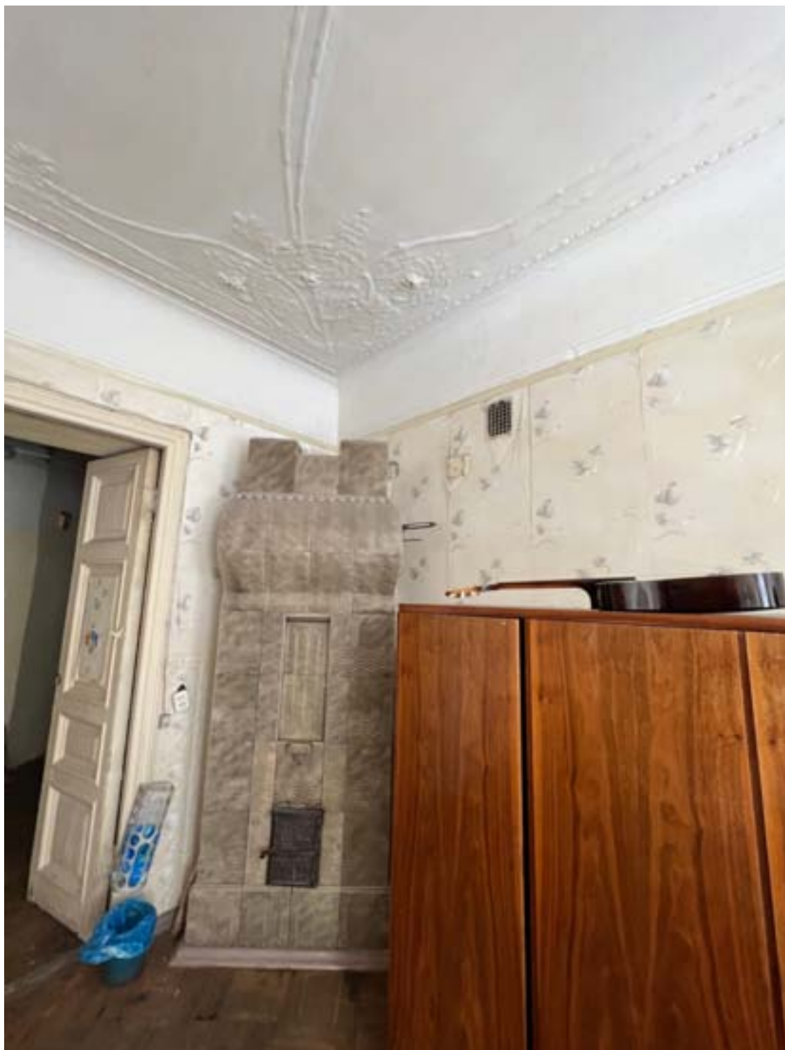
17. «Дом И.М. Екимова». Санкт-Петербург, ул.Кирочная, д.6, литера А. Фрагмент помещения кв.№3 (15-Н) Фото: 19.01.2026.
