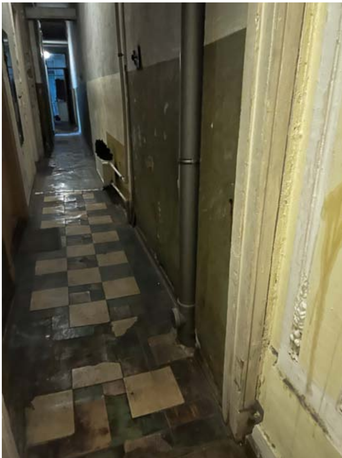
6. «Дом И.М. Екимова». Санкт-Петербург, ул.Кирочная, д.6, литера А. Фрагмент помещения кв.№3. Прихожая. Фото: 19.01.2026.
