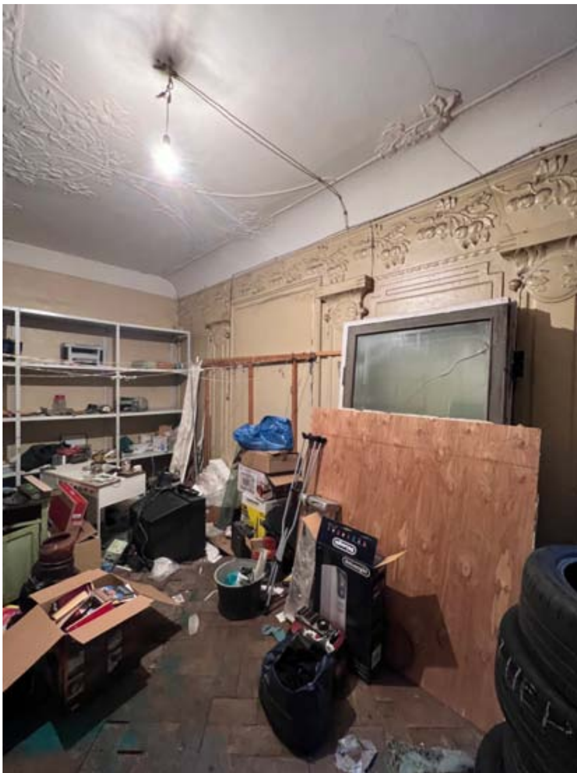
22. «Дом И.М. Екимова». Санкт-Петербург, ул.Кирочная, д.6, литера А. Фрагмент помещения кв.№3 (4-Н) Фото: 19.01.2026.
