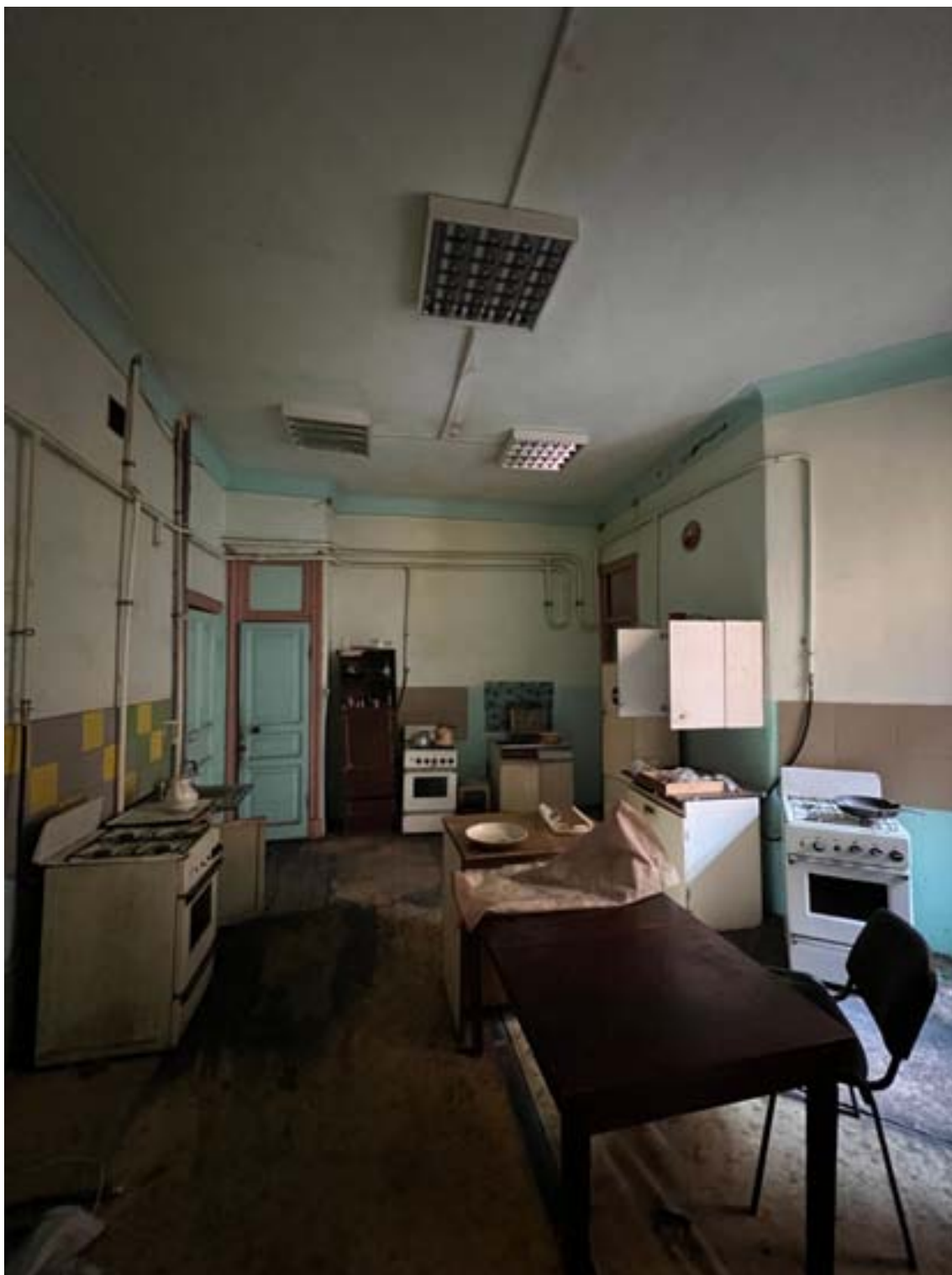
32. «Дом И.М. Екимова». Санкт-Петербург, ул.Кирочная, д.6, литера А. Фрагмент помещения кв.№3 (7-Н) Фото: 19.01.2026.
