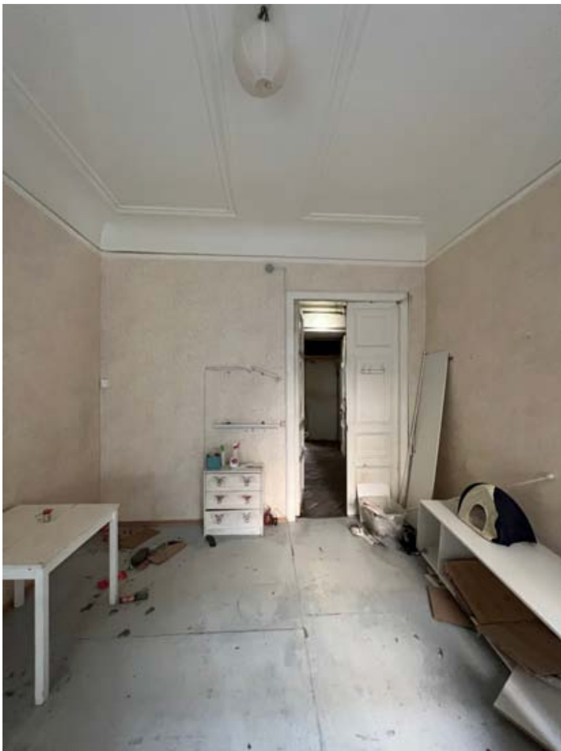
21. «Дом И.М. Екимова». Санкт-Петербург, ул.Кирочная, д.6, литера А. Фрагмент помещения кв.№3 (19-Н) Фото: 19.01.2026.
