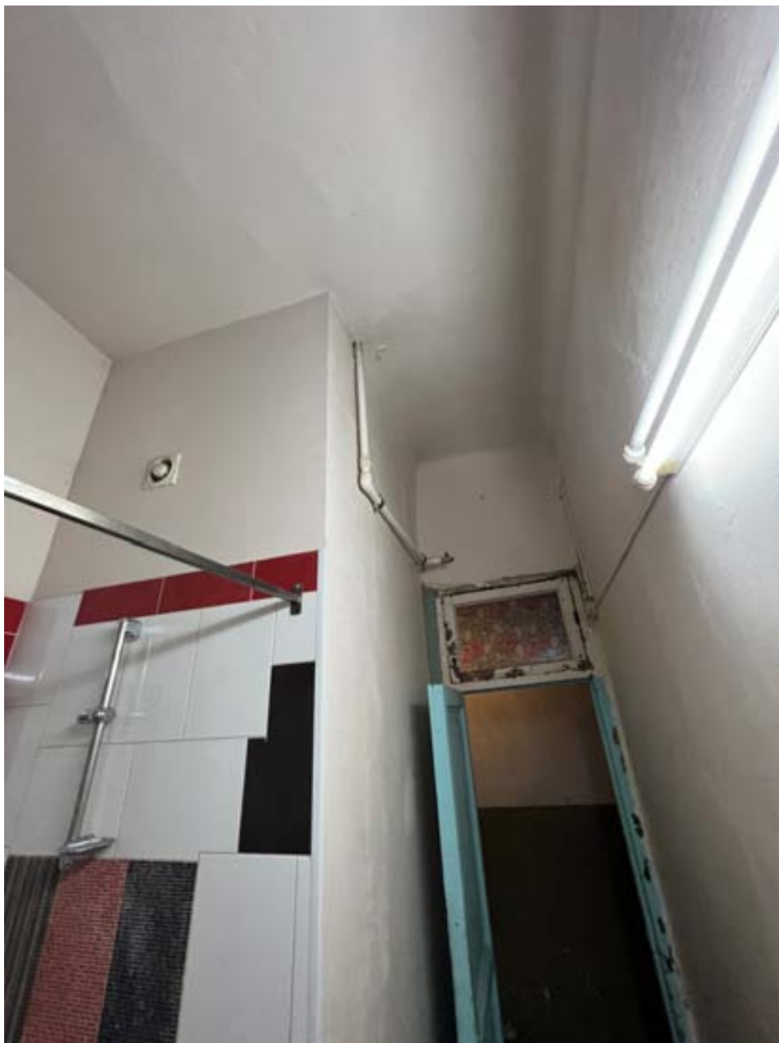
31. «Дом И.М. Екимова». Санкт-Петербург, ул.Кирочная, д.6, литера А. Фрагмент помещения кв.№3 (7-Н) Фото: 19.01.2026.
