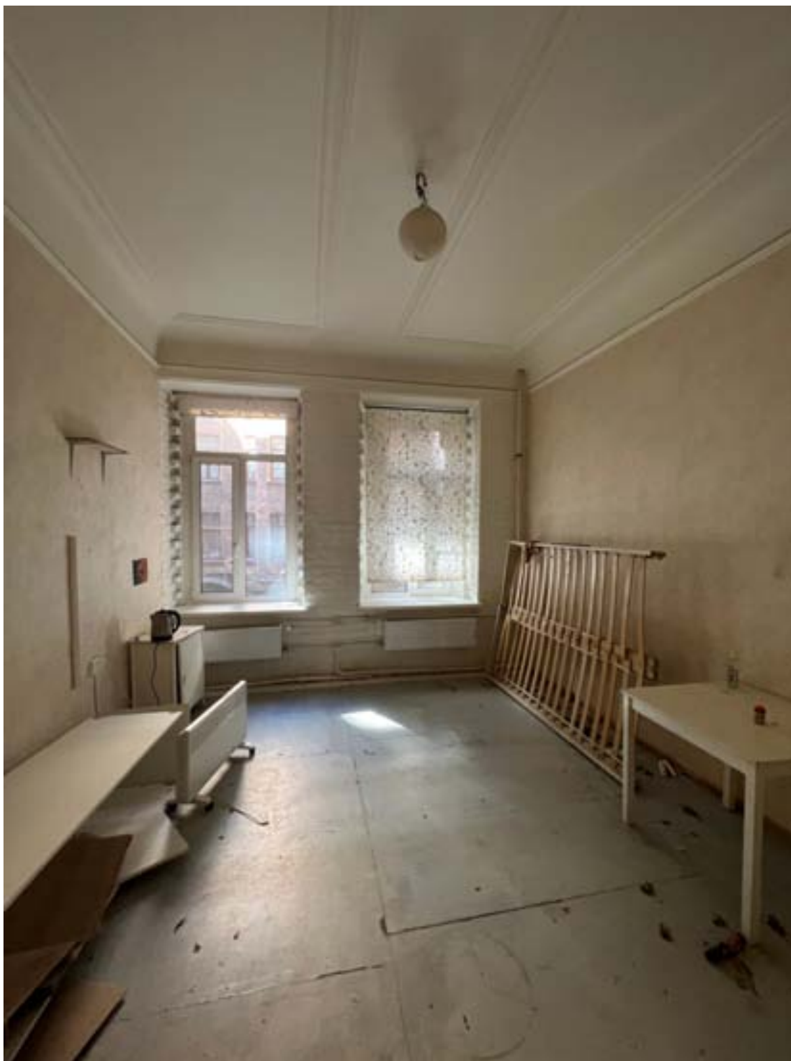
20. «Дом И.М. Екимова». Санкт-Петербург, ул.Кирочная, д.6, литера А. Фрагмент помещения кв.№3 (19-Н) Фото: 19.01.2026.
