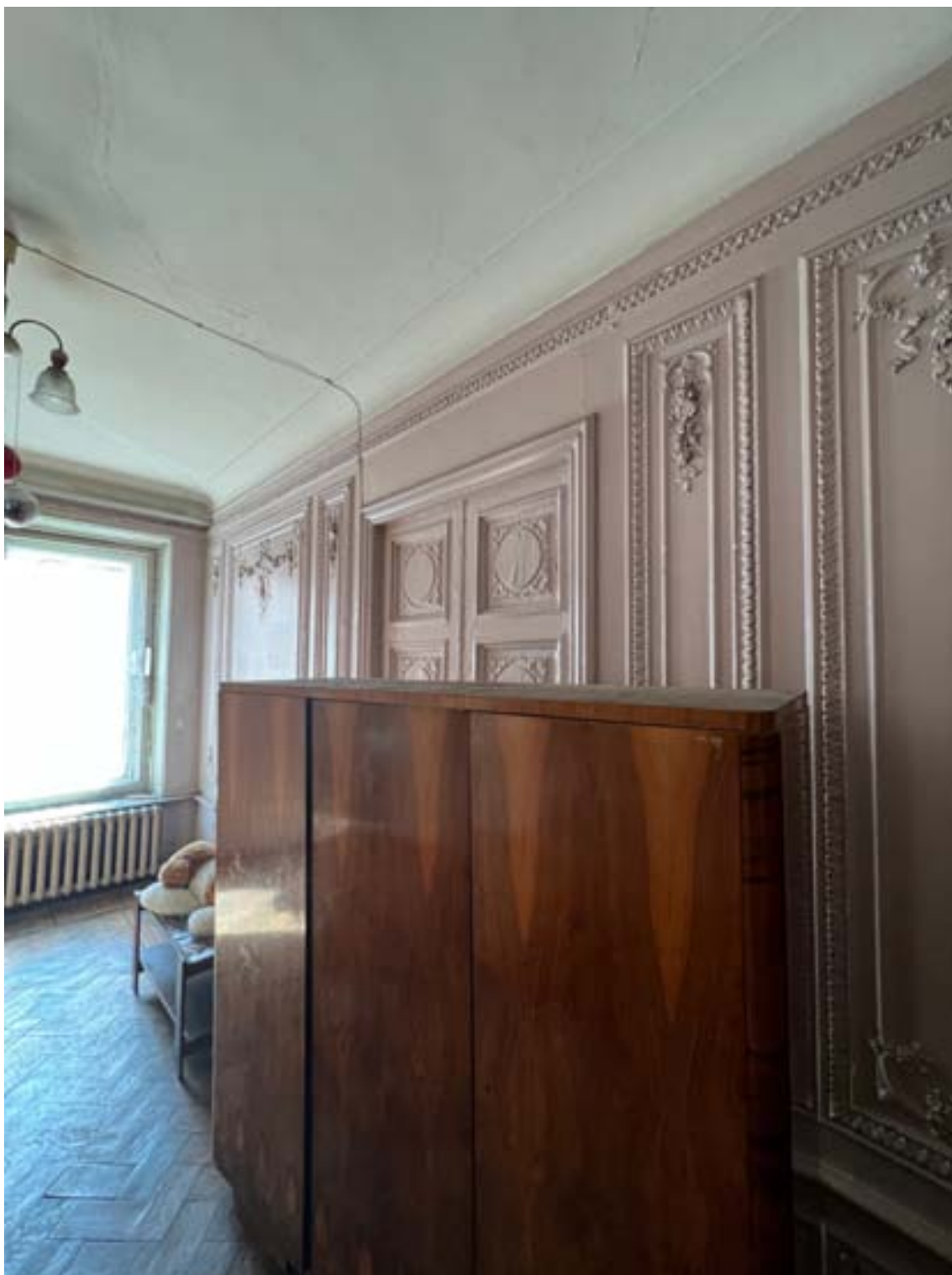
10. «Дом И.М. Екимова». Санкт-Петербург, ул.Кирочная, д.6, литера А. Фрагмент помещения кв.№3 (20-Н) Фото: 19.01.2026.
