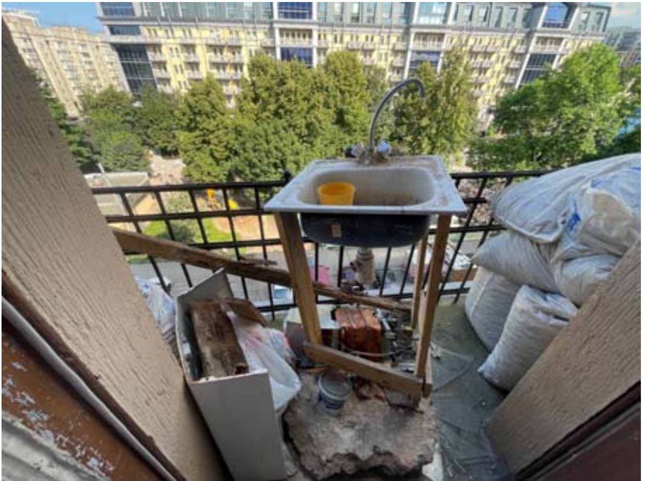
12.Общий вид балкона.
