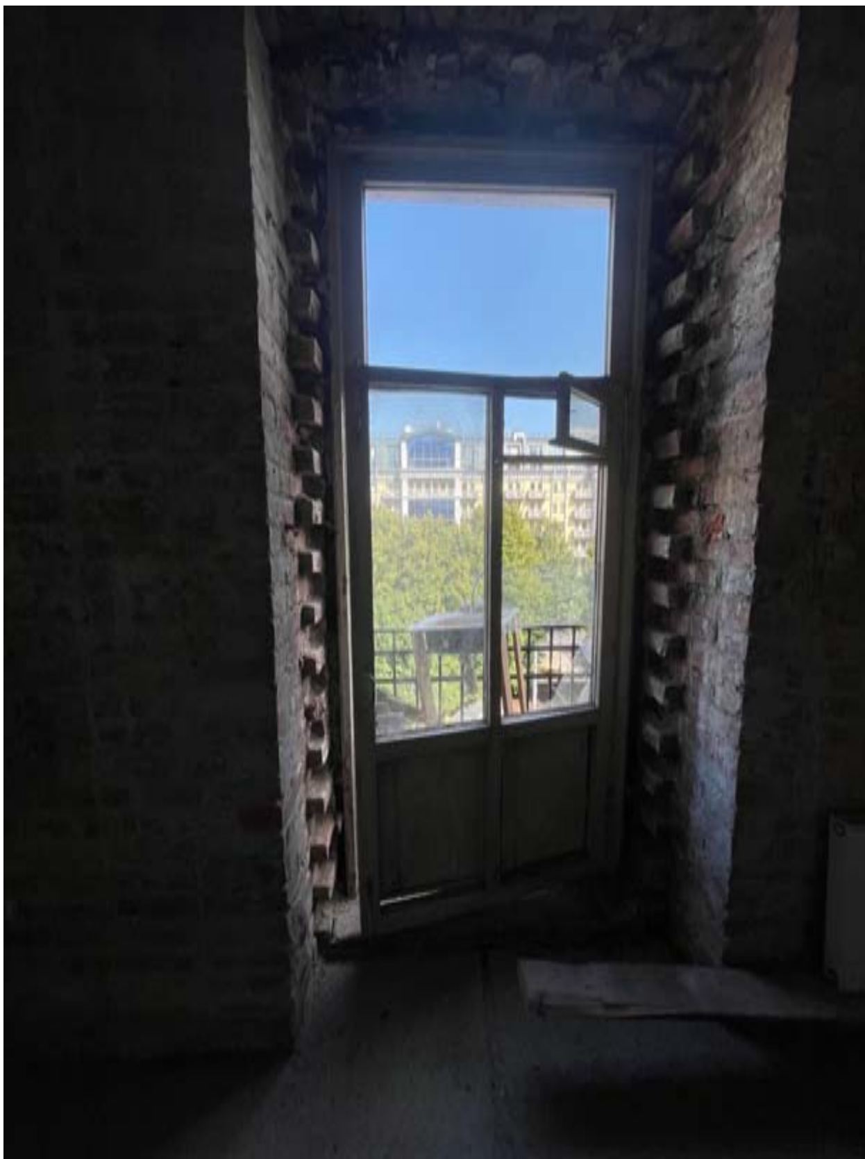
11. Балконное дверное заполнение.
