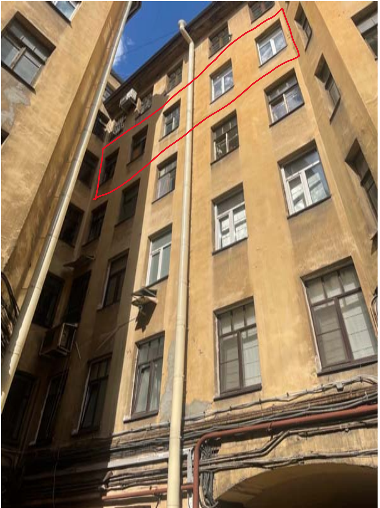
2. Фрагмент дворового фасада. Красной линией отмечены оконные проемы квартиры №18.
