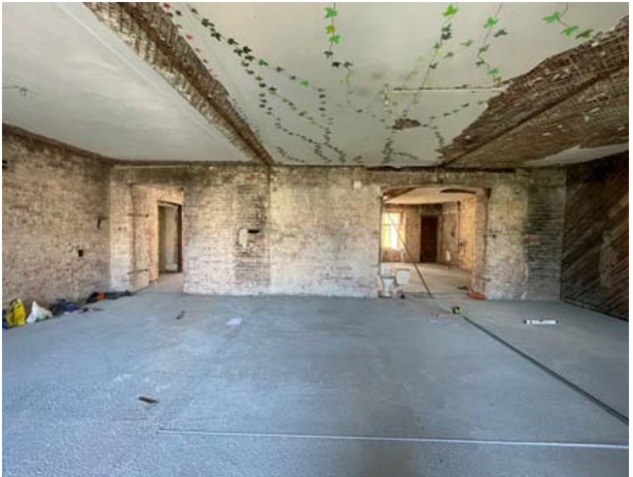
10. Помещение со стороны лицевого фасада (все перегородки демонтированы).
