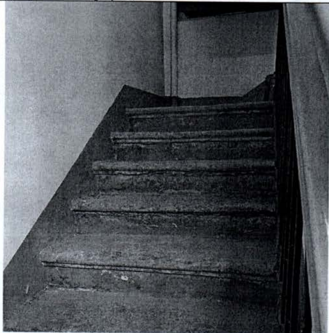
Фото 29. Лестница в юго-западной части лицевого корпуса.
