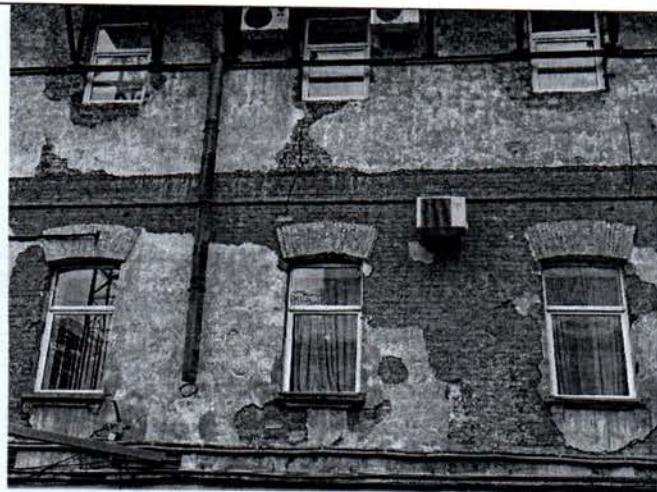
Фото 9. Фрагмент юго-западного фасада большого внутреннего двора.
