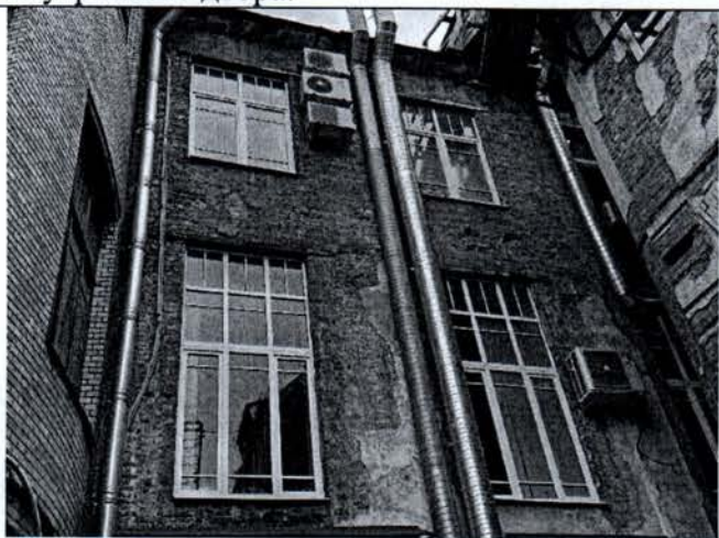
Фото 7. Фрагмент юго-восточного фасада большого внутреннего двора.
