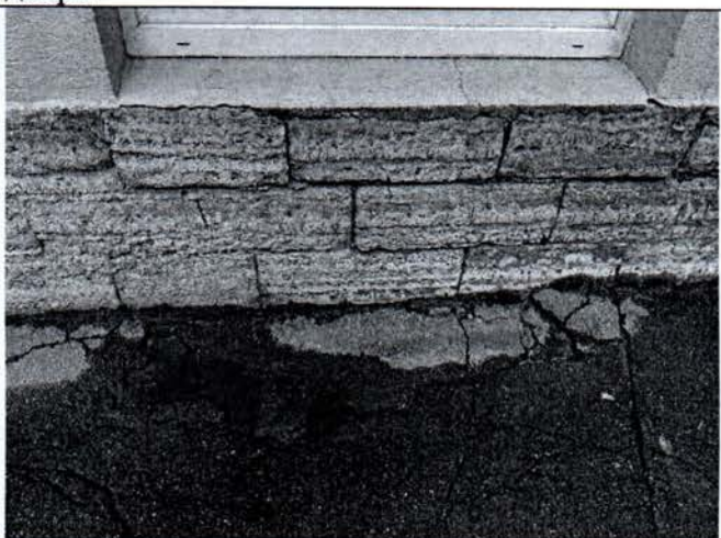
Фото 13. Цоколь юго-восточного фасада большого внутреннего двора.
