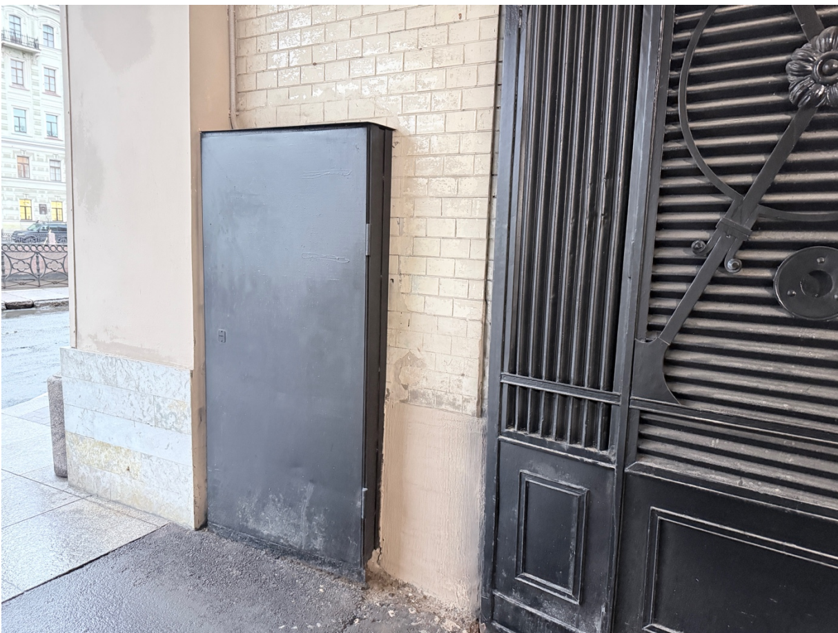
Фото 3. Общий вид на часть объекта в границах ведения работ. Дата фотофиксации: 09.12.2025г.
