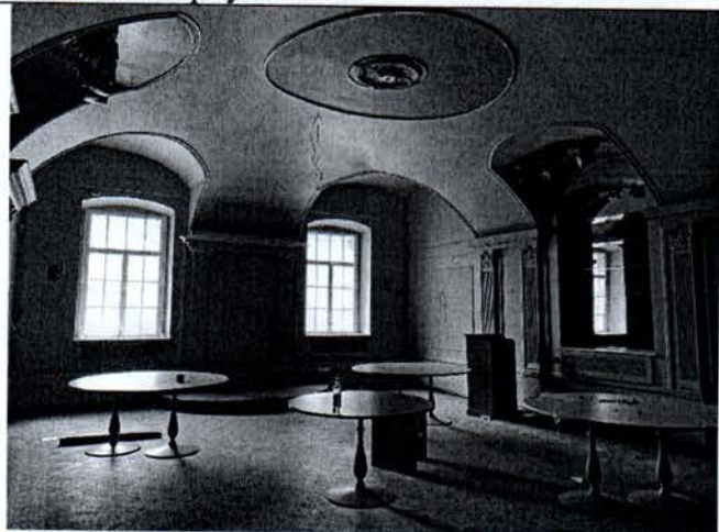
Фото 31. Помещение 1 этажа лицевого корпуса.
