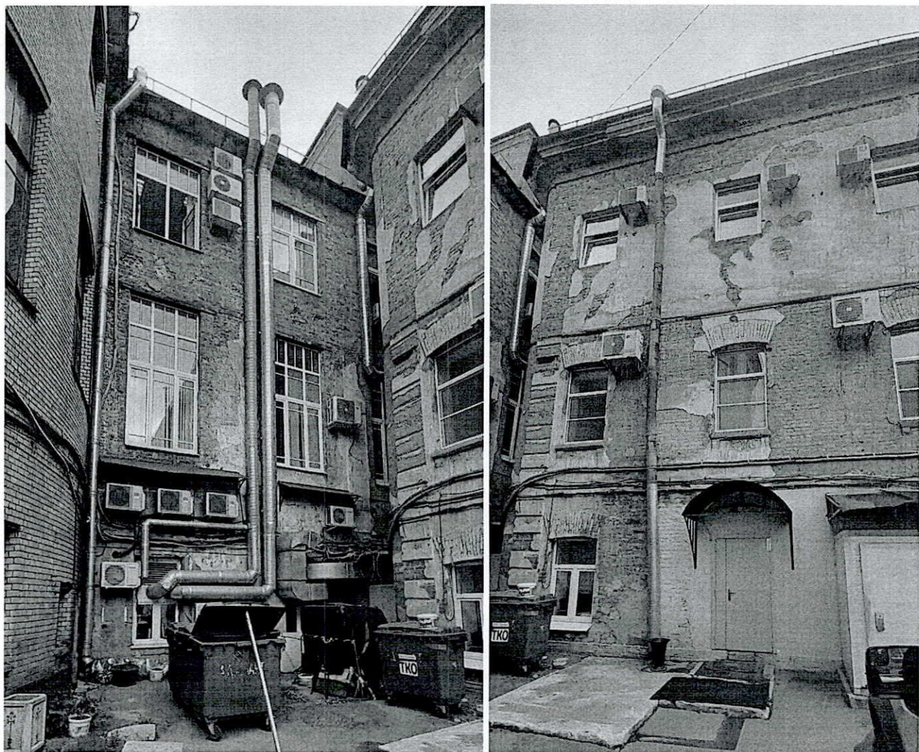
31. Фрагмент дворового фасада
