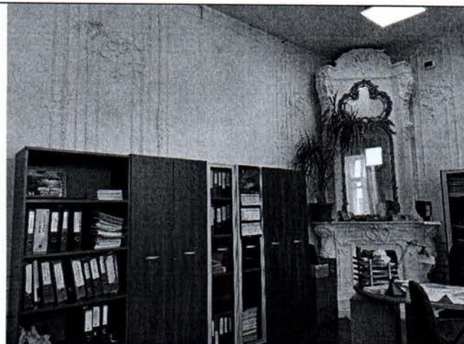
Фото 34. Помещение 2 этажа лицевого корпуса.
