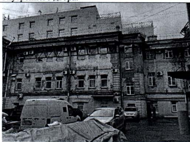
Фото 5. Северо-восточный фасад большого внутреннего двора.
