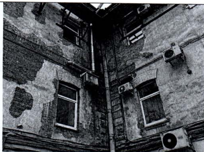
Фото 10. Фрагмент северо-восточного фасада большого внутреннего двора.
