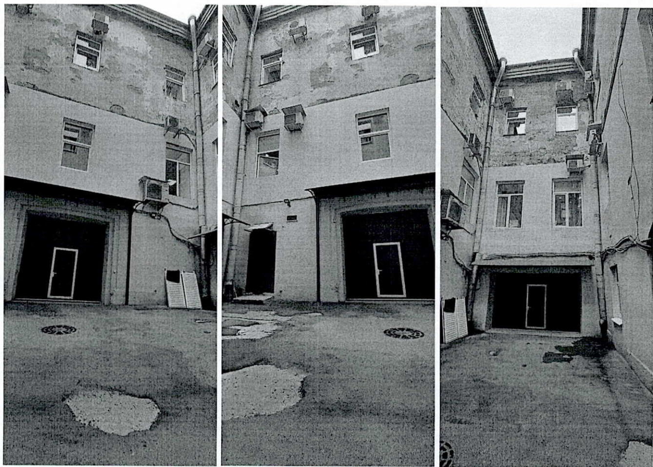
37. Фрагмент дворового фасада
