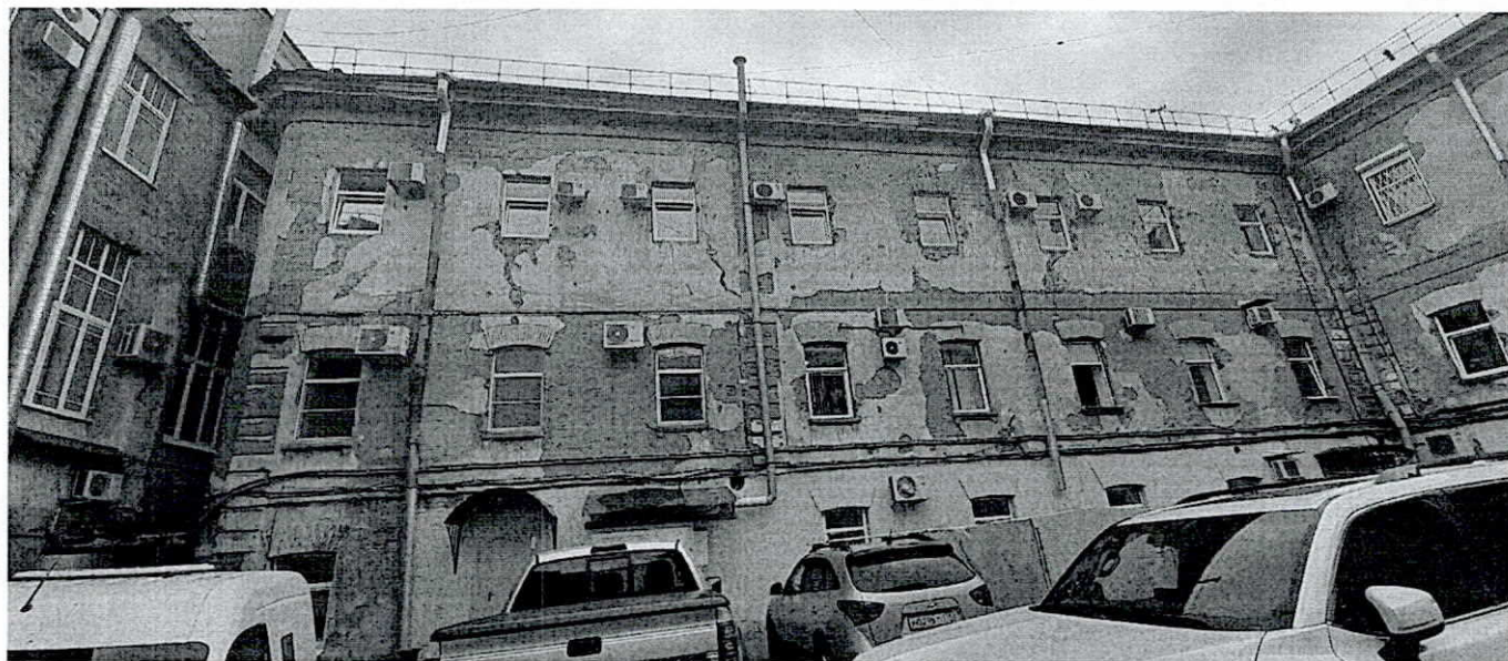
32. Фрагмент дворового фасада
