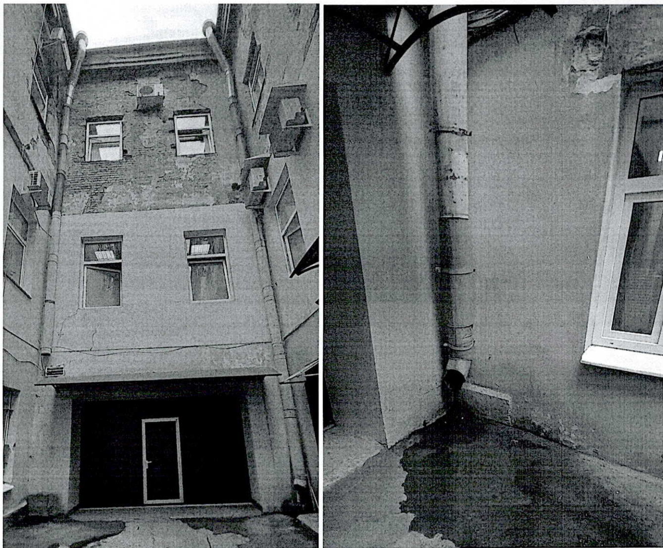
38. Фрагмент дворового фасада
