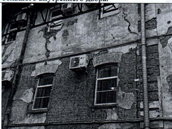
Фото 8. Фрагмент юго-западного фасада большого внутреннего двора.
