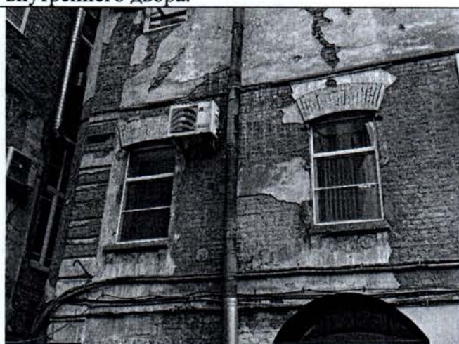
Фото 6. Фрагмент юго-западного фасада большого внутреннего двора.
