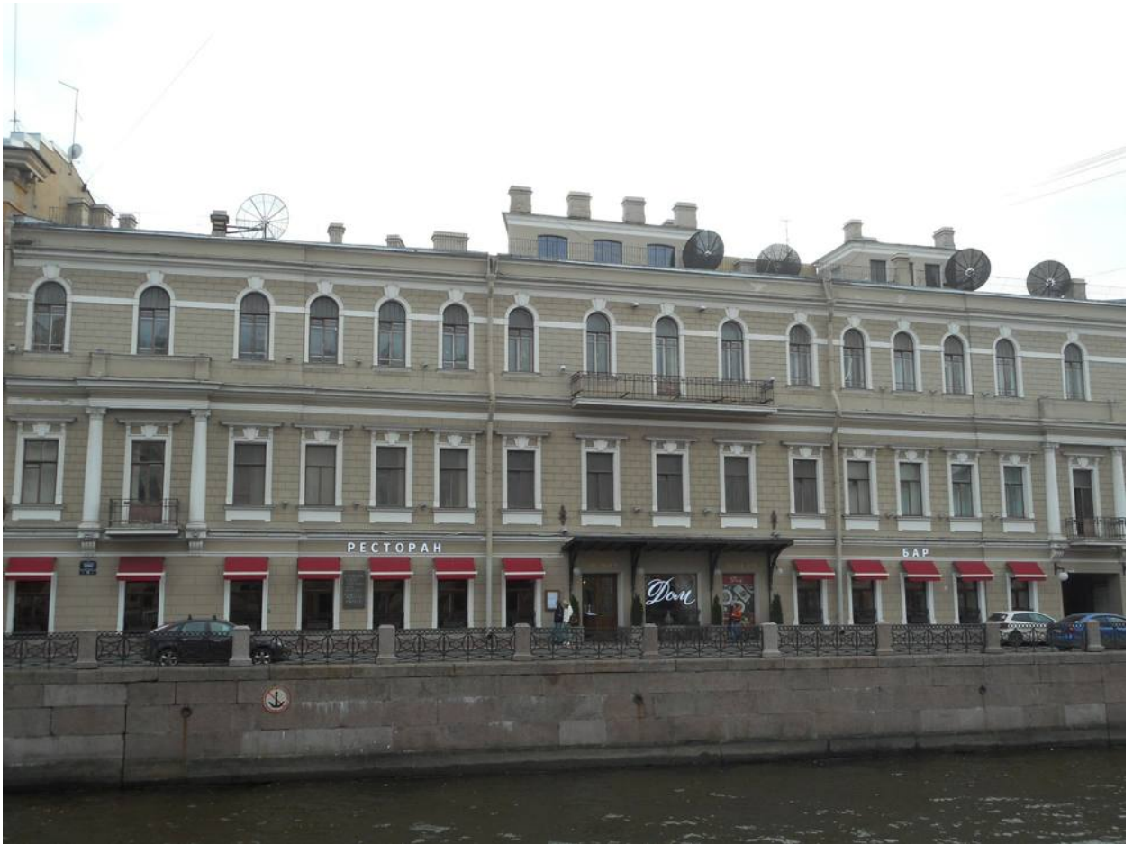
94. Лицевой фасад. 2018г.
