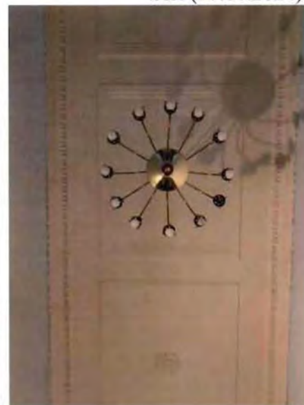
33. Промежуточная площадка 4ЛК (17.11.2021).
