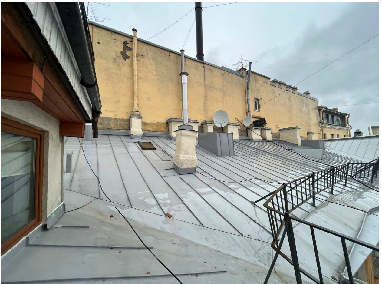
Фото №16. Общий вид кровли.
