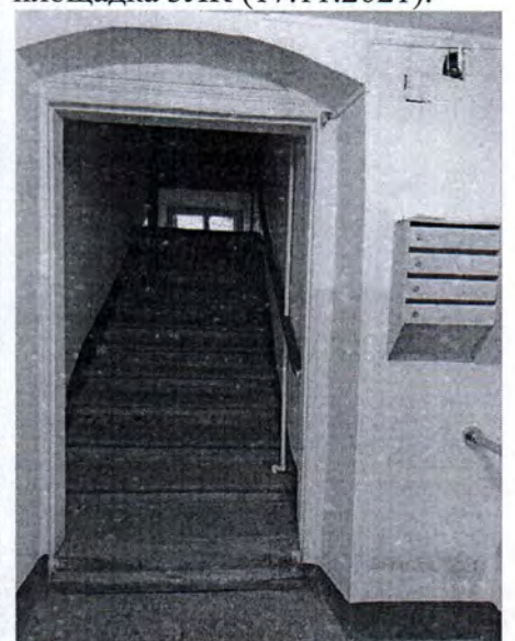
72. Промежуточная площадка 3ЛК (17.11.2021).
