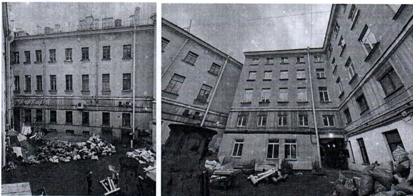
32-34. Фрагменты фасадов восточного двора (17.11.2021).
