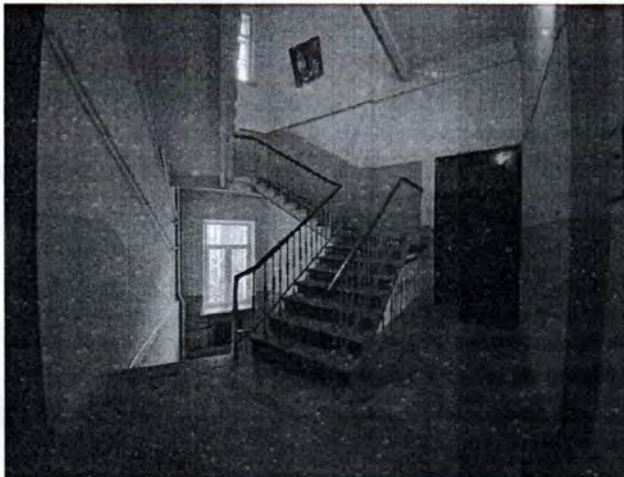
67-68. Лестничная клетка 2ЛК (17.11.2021).
