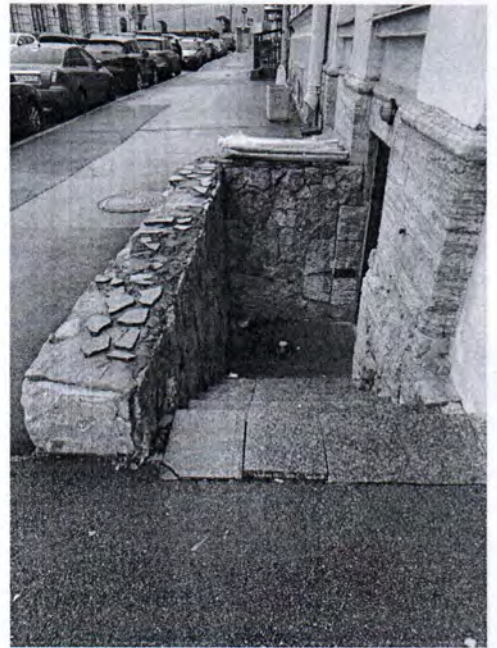
11. Прямок по западному лицевому фасаду (17.11.2021).
