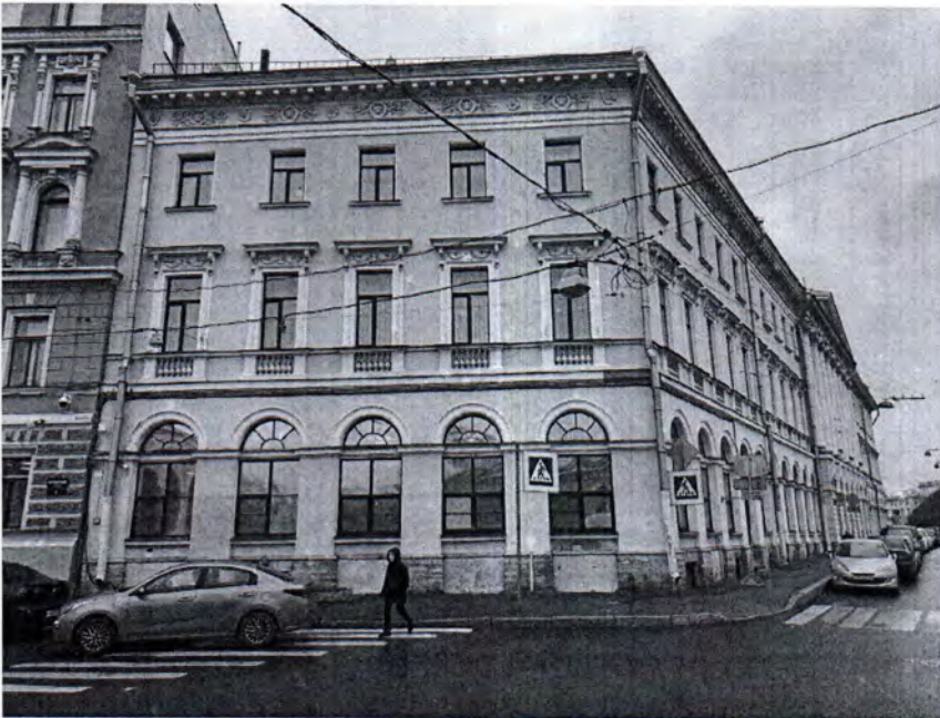
10. Западный лицевой фасад по Аптекарскому переулку (17.11.2021).
