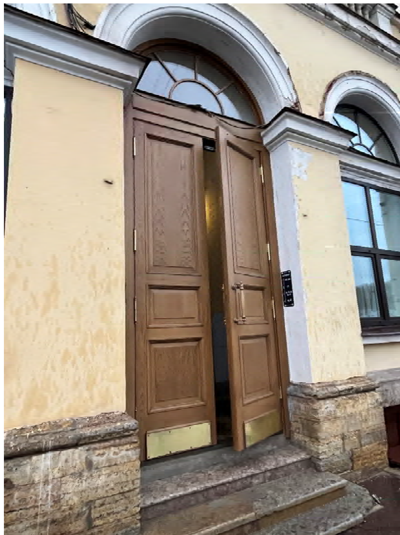
Фото №2. Южный лицевой фасад, вход в общедомовую лестничную клетку.
