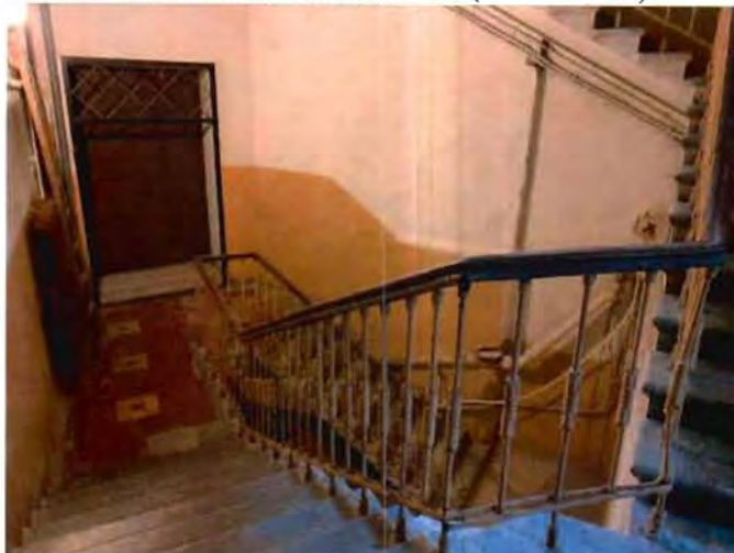
26-27. Лестничная клетка 2ЛК (17.11.2021).
