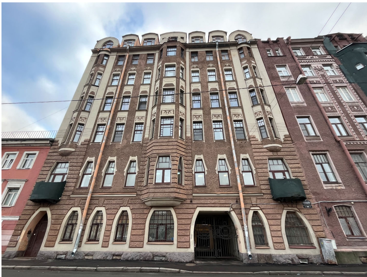
Фото №1. Северный лицевой фасад.
