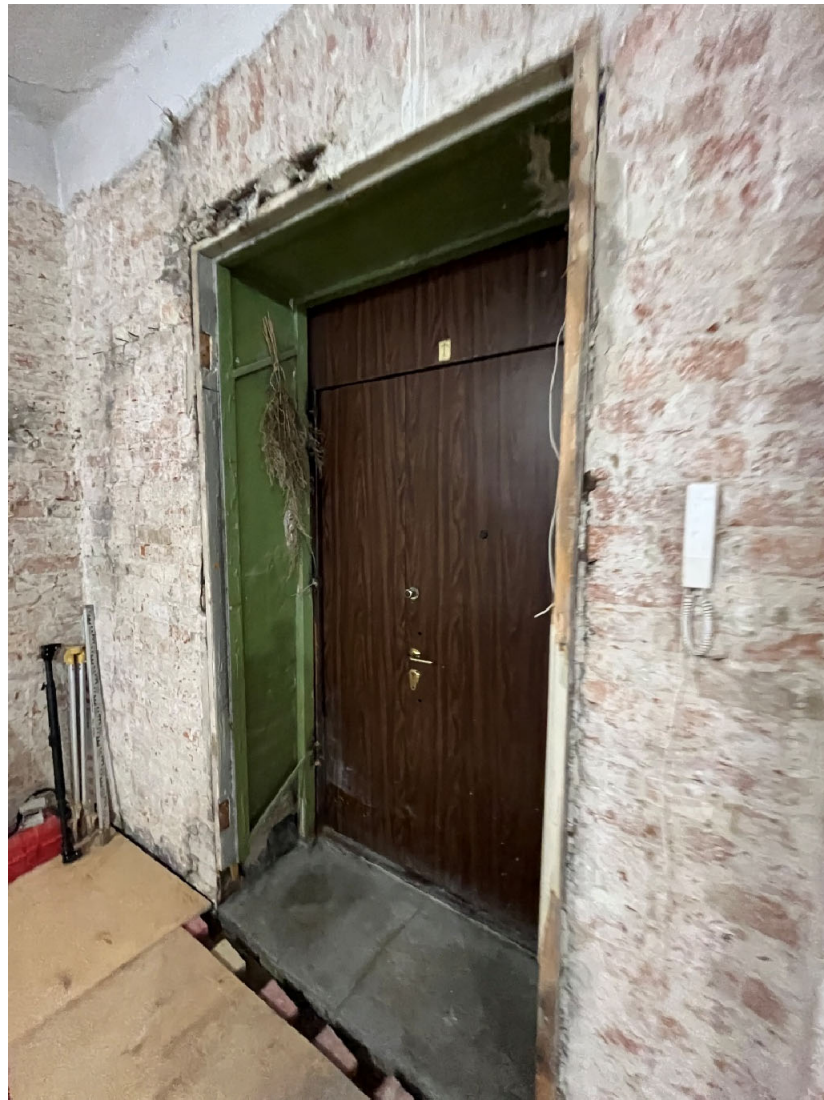
Фото №3. Квартира №14, вход в квартиру.
