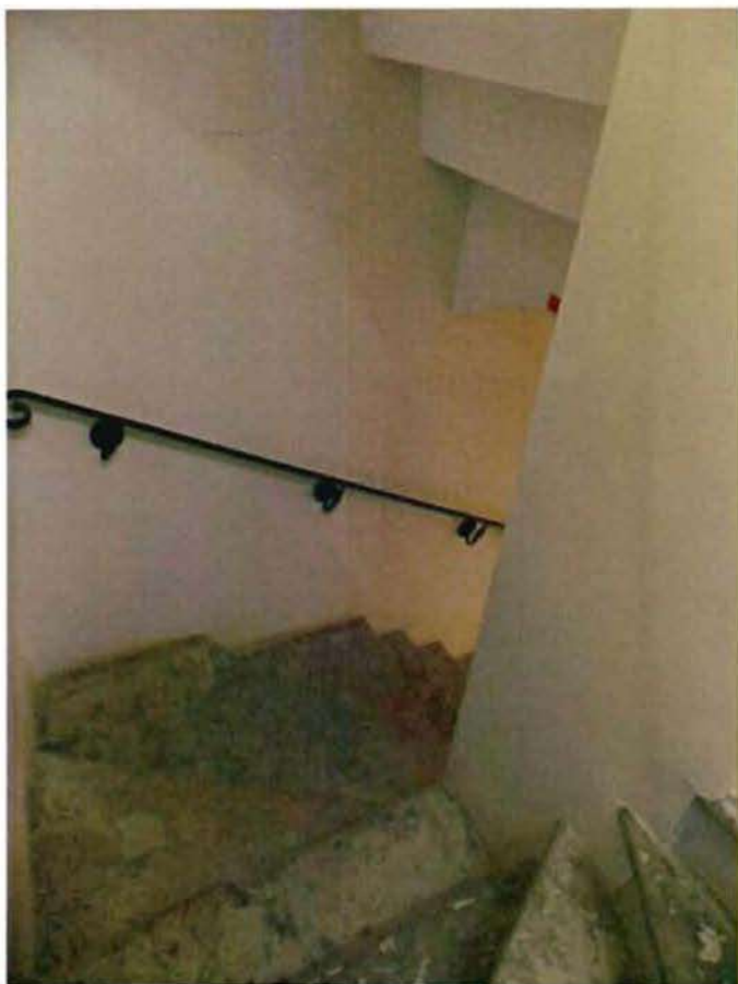
6. Лестница юго-восточного дворового флигеля (лит. А)
