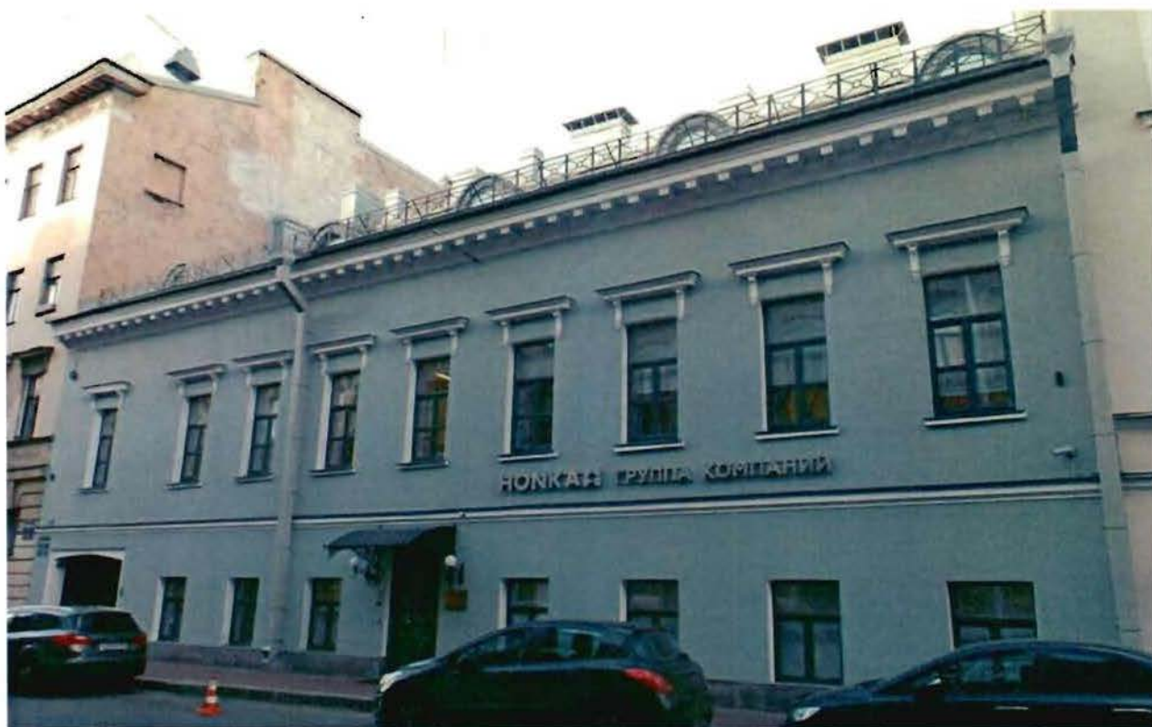
8. Фасад со стороны Шпалерной улицы
