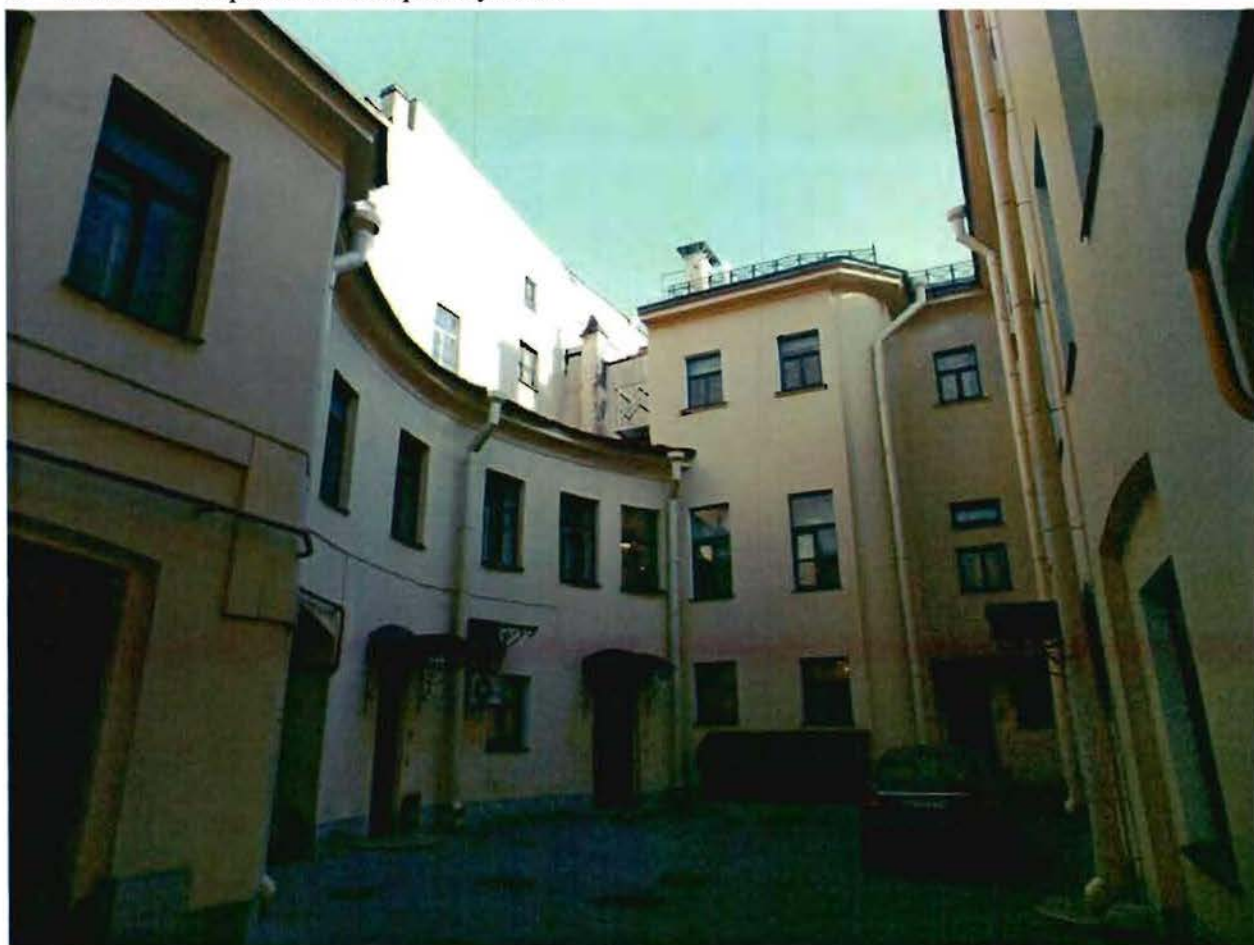
9. Дворовые фасады южного двора
