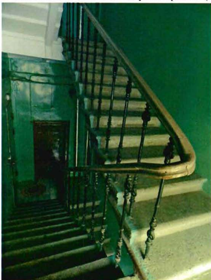
7. Лестница поперечного дворового флигеля (лит. А)
