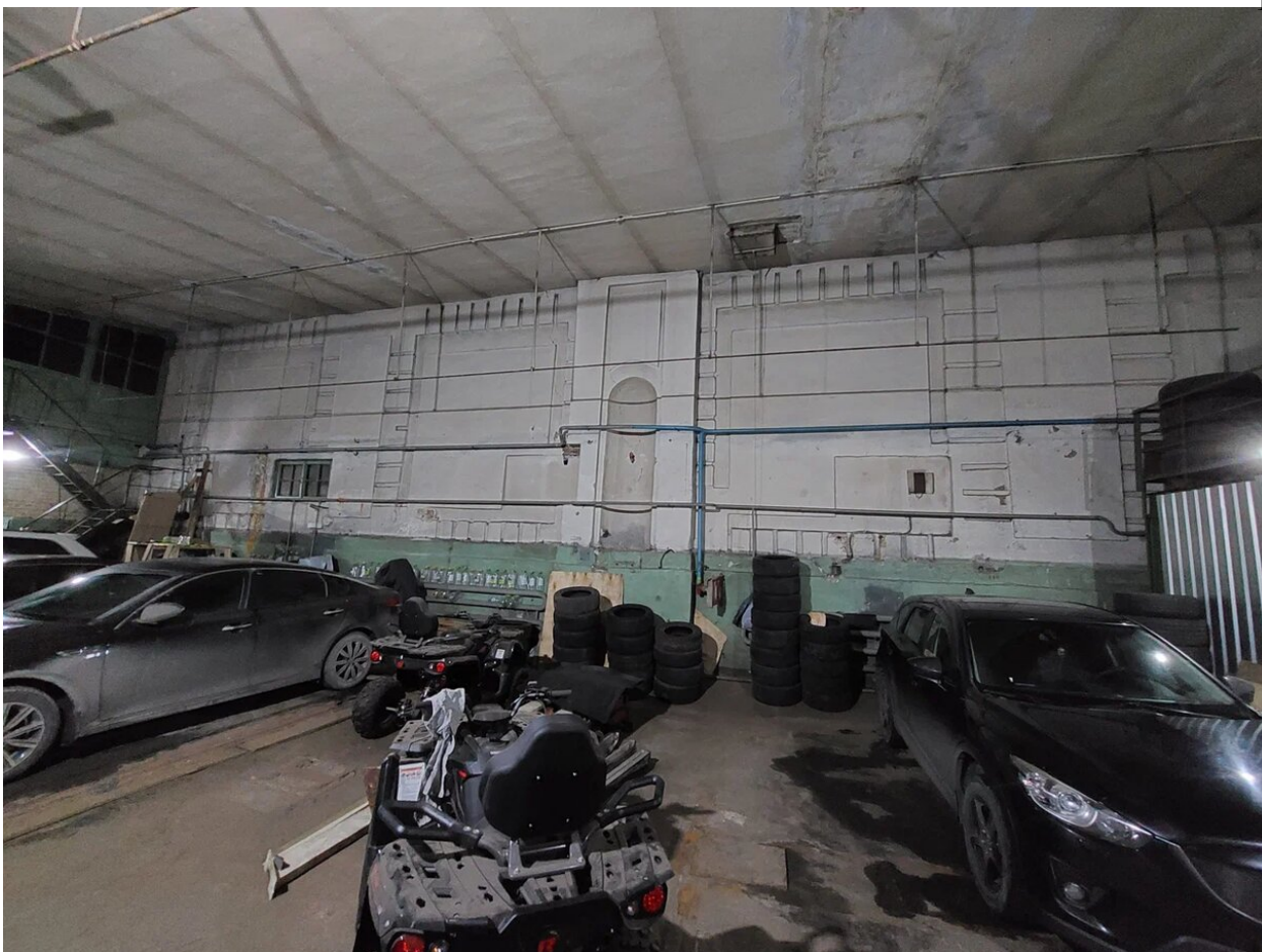
Фото 15. Общий вид на объект со стороны интерьера объекта капитального строительства, пристроенного к нему. Дата фотофиксации: 20.02.2026г.
