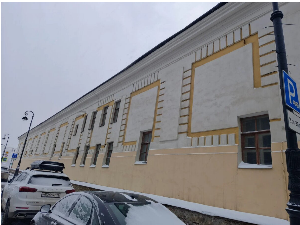
Фото 1. Общий вид на объект. Дата фотофиксации: 20.02.2026г.
