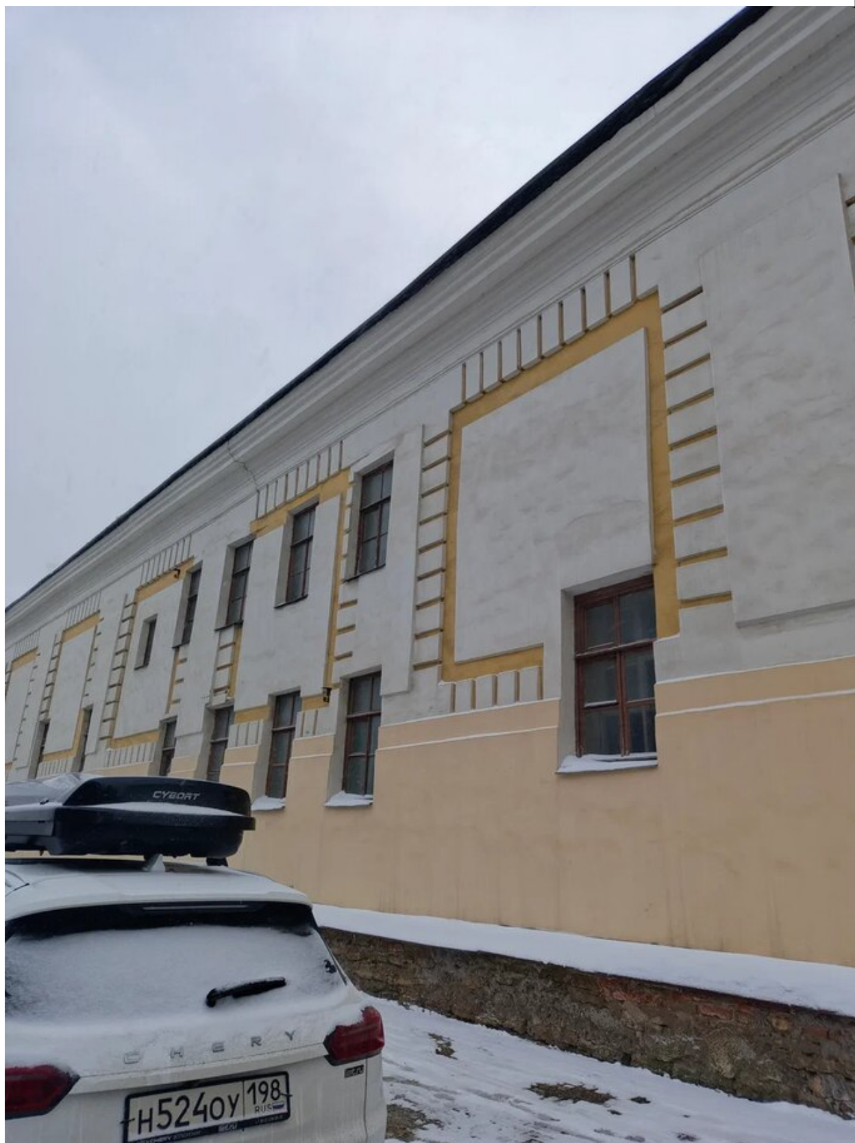
Фото 3. Общий вид на объект. Дата фотофиксации: 20.02.2026г.
