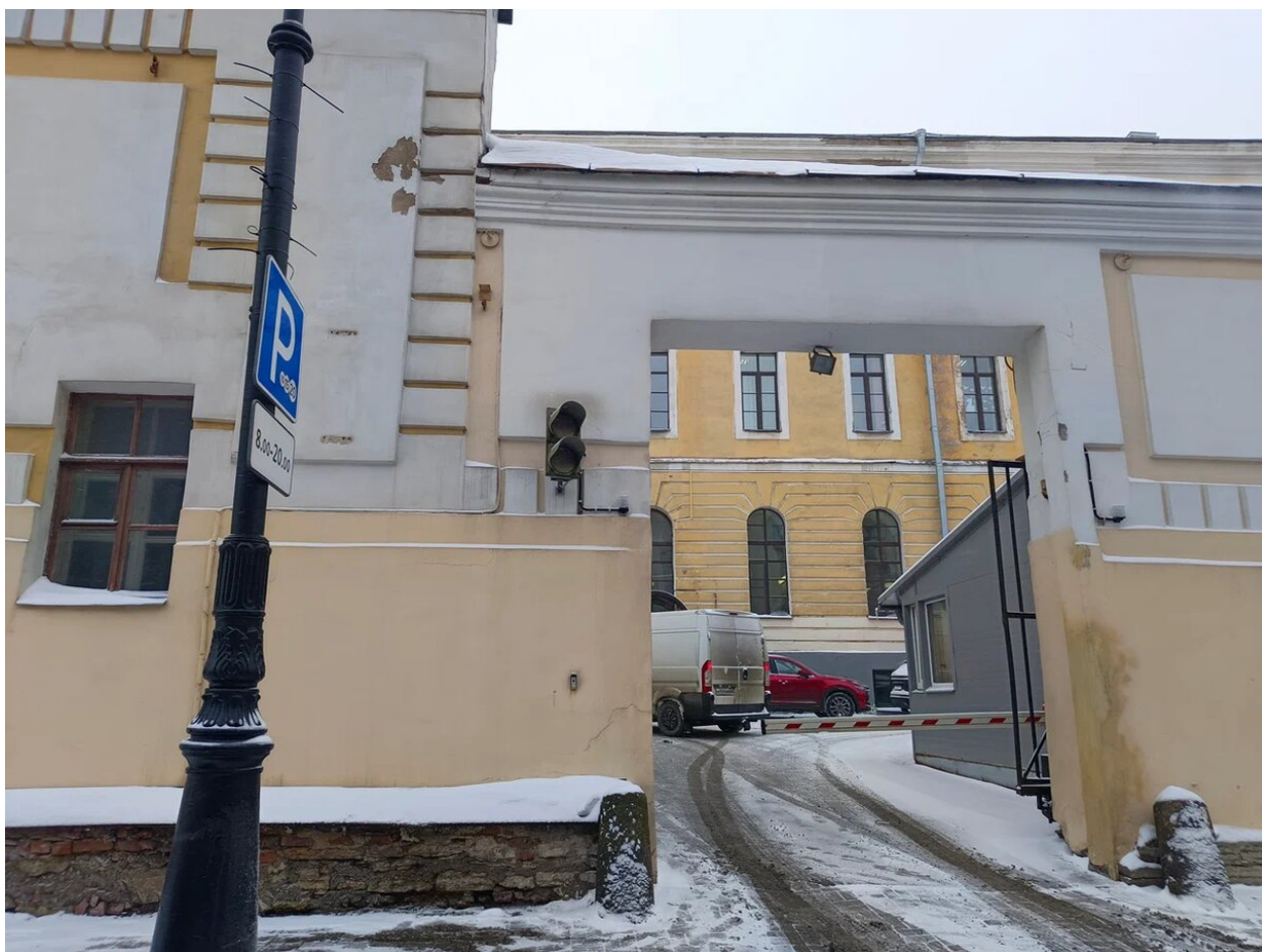
Фото 2. Общий вид на объект. Дата фотофиксации: 20.02.2026г.
