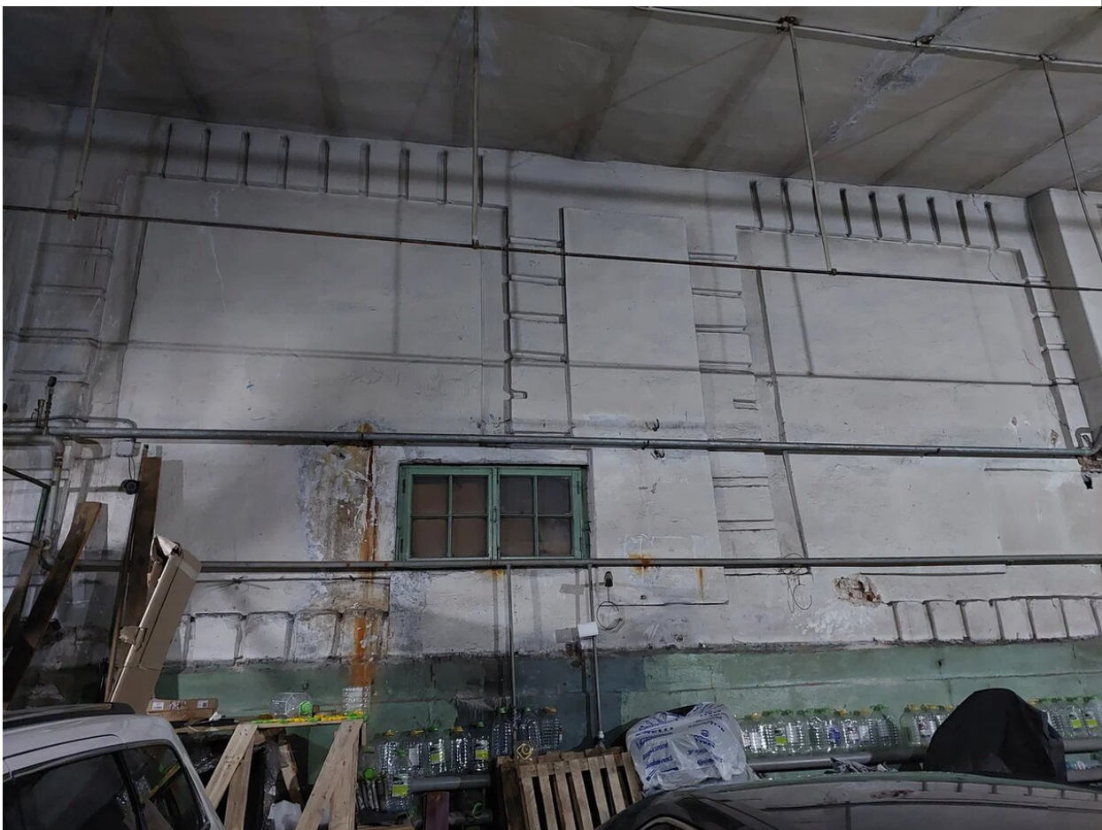
Фото 13. Общий вид на объект со стороны интерьера объекта капитального строительства, пристроенного к нему. Дата фотофиксации: 20.02.2026г.
