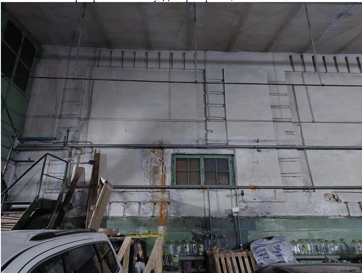
Фото 14. Общий вид на объект со стороны интерьера объекта капитального строительства, пристроенного к нему. Дата фотофиксации: 20.02.2026г.
