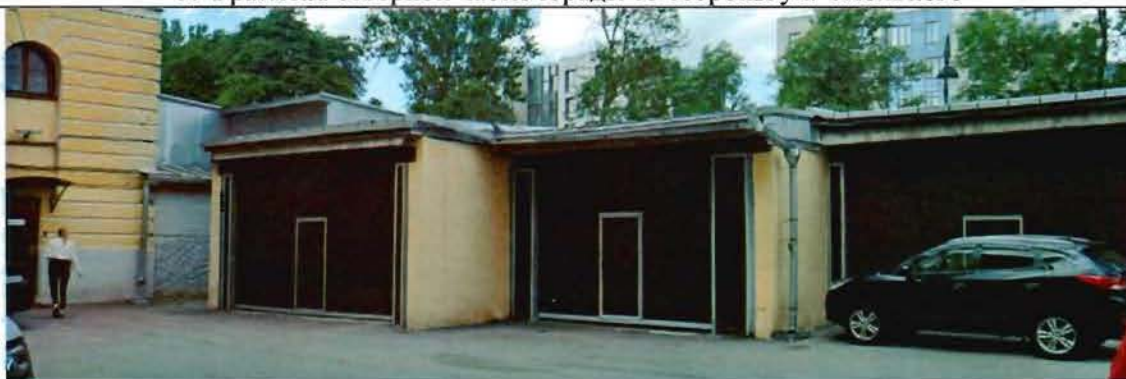
6. Фрагмент северной части ограды со стороны двора
