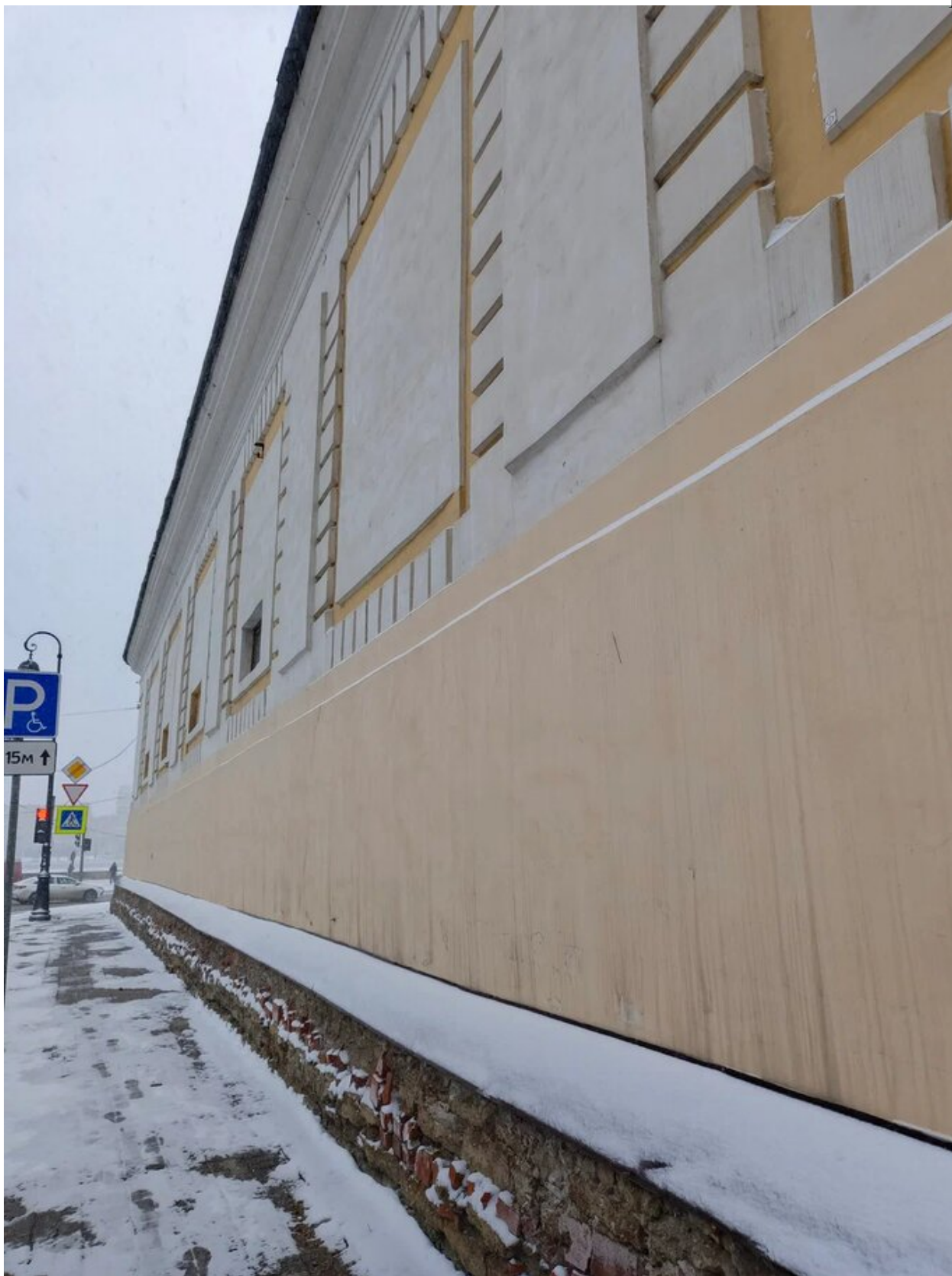
Фото 6. Общий вид на объект. Дата фотофиксации: 20.02.2026г.
