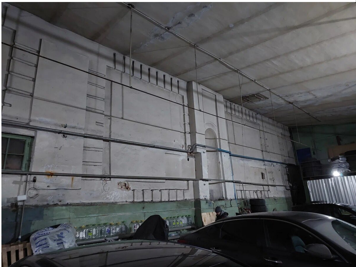
Фото 11. Общий вид на объект со стороны интерьера объекта капитального строительства, пристроенного к нему. Дата фотофиксации: 20.02.2026г.
