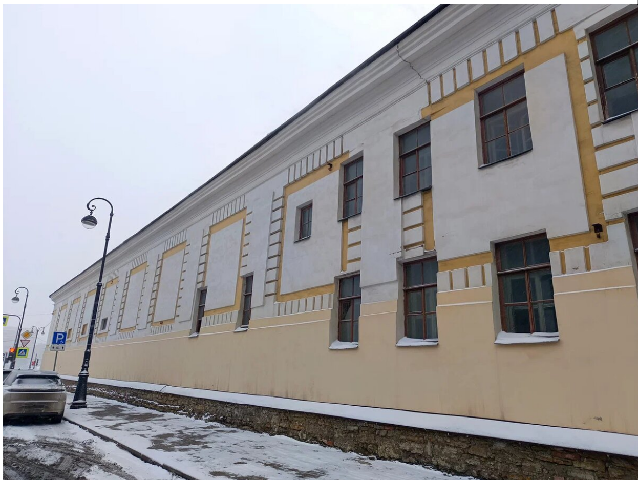
Фото 4. Общий вид на объект. Дата фотофиксации: 20.02.2026г.
