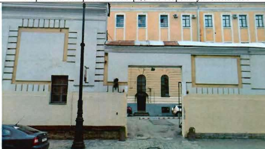
5. Фрагмент северной части ограды со стороны ул. Смольного
