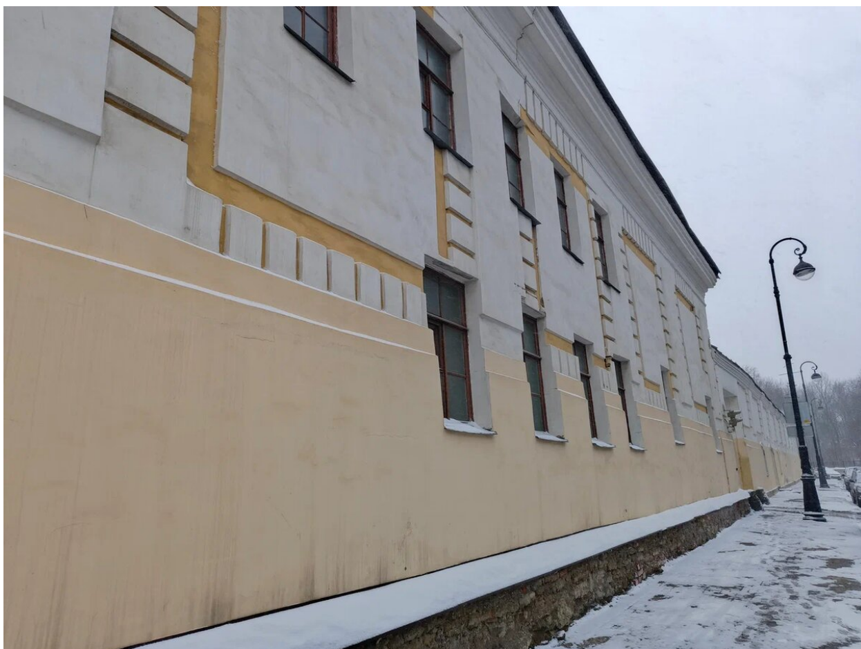
Фото 5. Общий вид на объект. Дата фотофиксации: 20.02.2026г.
