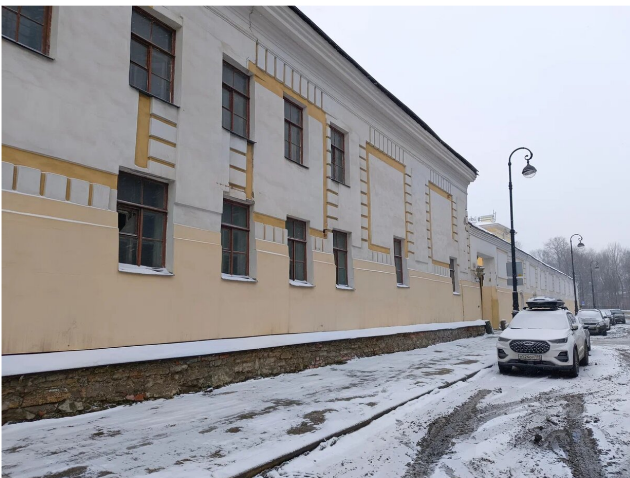
Фото 10. Общий вид на объект. Дата фотофиксации: 20.02.2026г.
