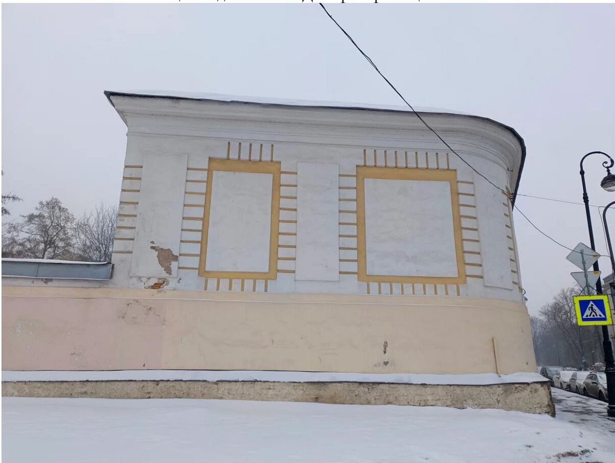
Фото 9. Общий вид на объект. Дата фотофиксации: 20.02.2026г.
