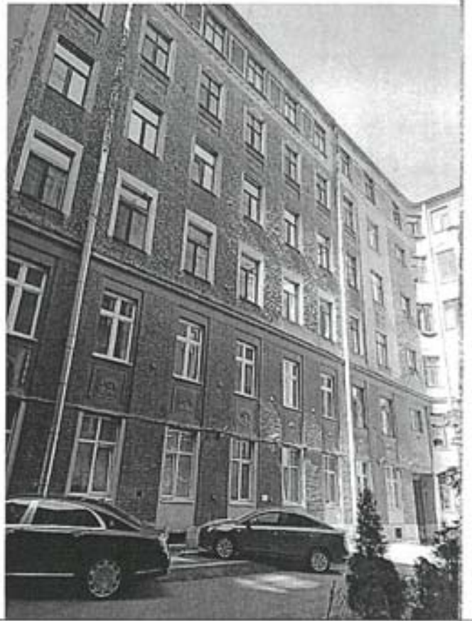
Фото 28. Дворовые фасады внутреннего двора
