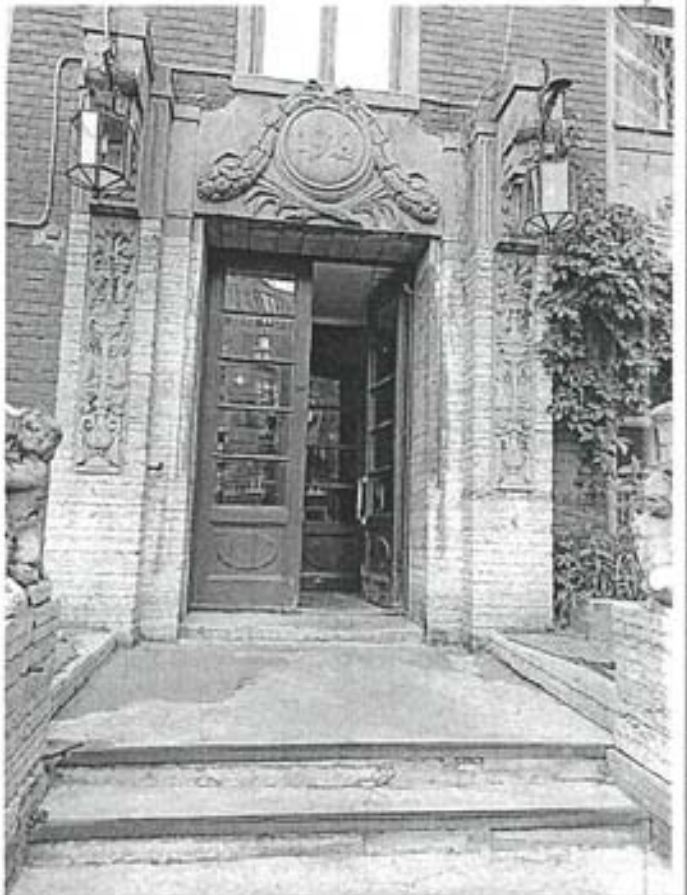
Фото 30. Дворовые фасады. Вход в парадную № 9
