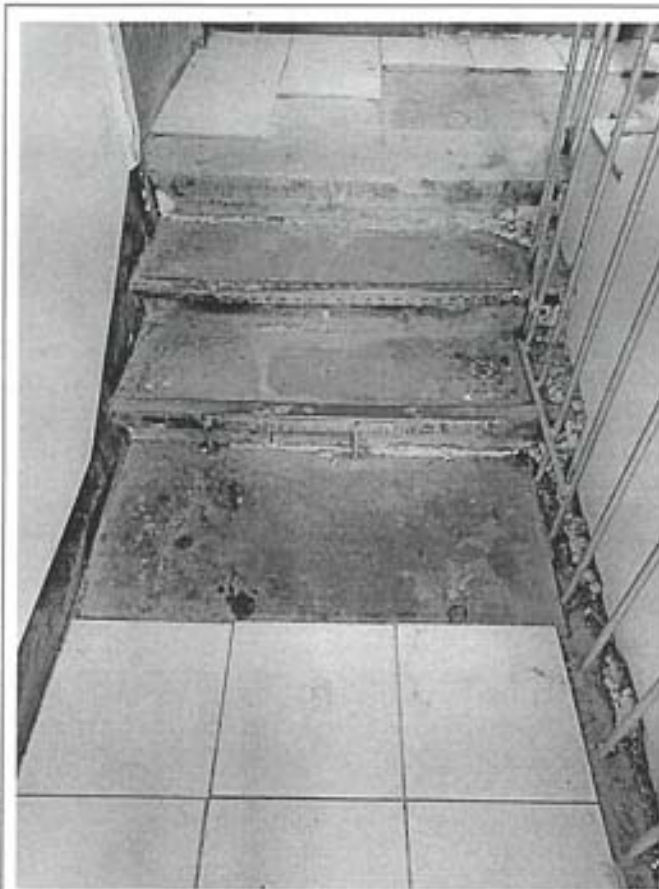
Фото 99. Ступени на первый этаж черной лестницы (где расположены квартиры №№ 109-117, 108)
