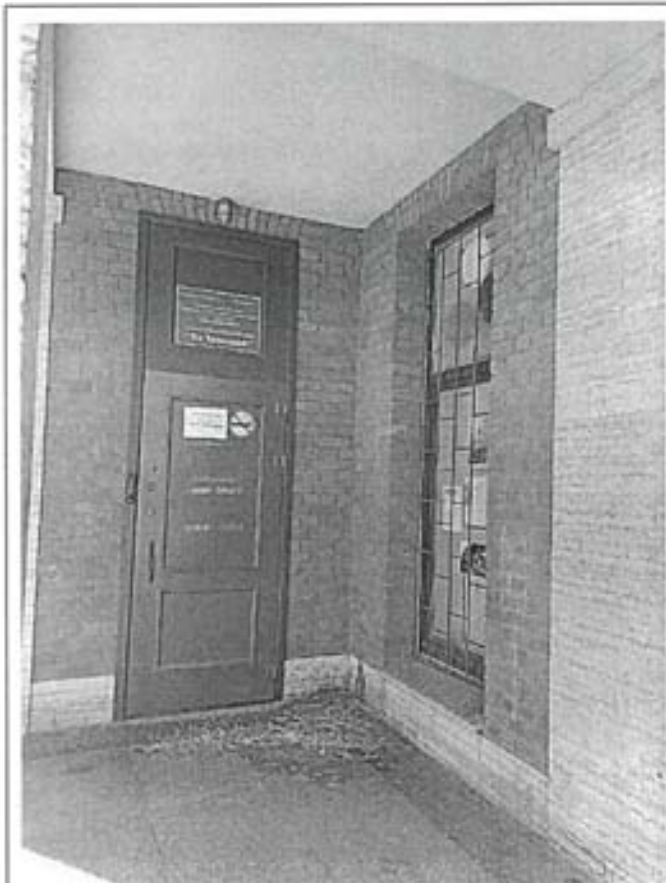
Фото 43. Фрагмент лицевого фасада со стороны Рубинштейна. Оконный и дверной проемы помещения 4-Н.
