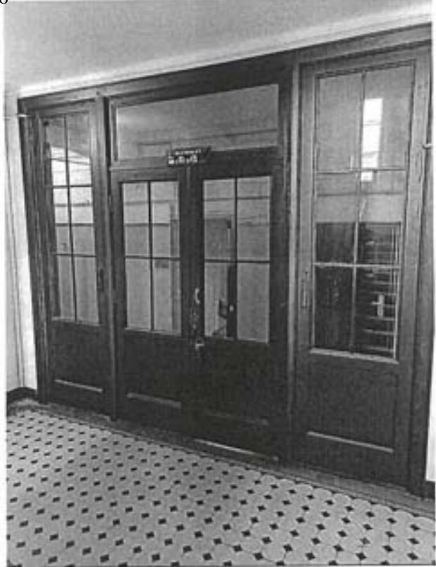
Фото 88. Дверное заполнение квартиры № 409-428
