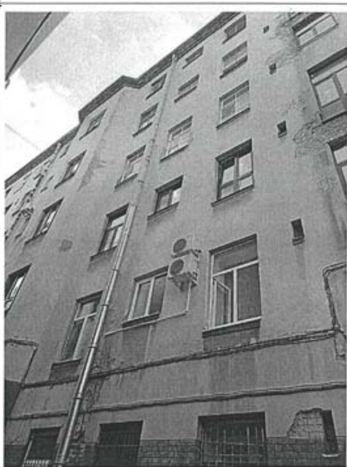
Фото 120. Фрагмент дворового фасада внешнего контура здания. Выполнено увеличение габаритов оконного проема квартиры № 404
