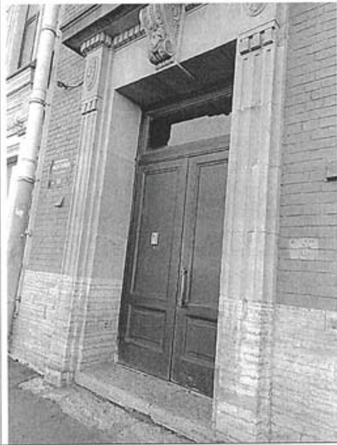
Фото 4. Фрагмент лицевого фасада по наб. реки Фонтанки. Первая световая ось.
