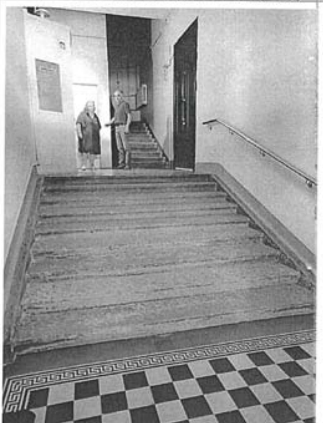
Фото 8. Парадная лестница (вход с фасада по наб. реки Фонтанки по первой световой оси)
