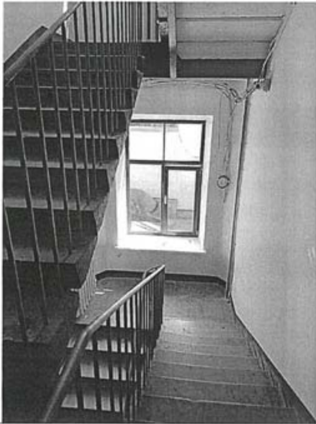
Фото 83. Фрагмент черной лестницы (где расположены квартиры №№ 109-117, 108).
