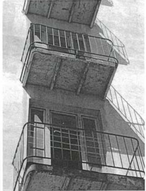
Фото 116. Фрагмент дворового фасада внешнего контура здания. Балконы
