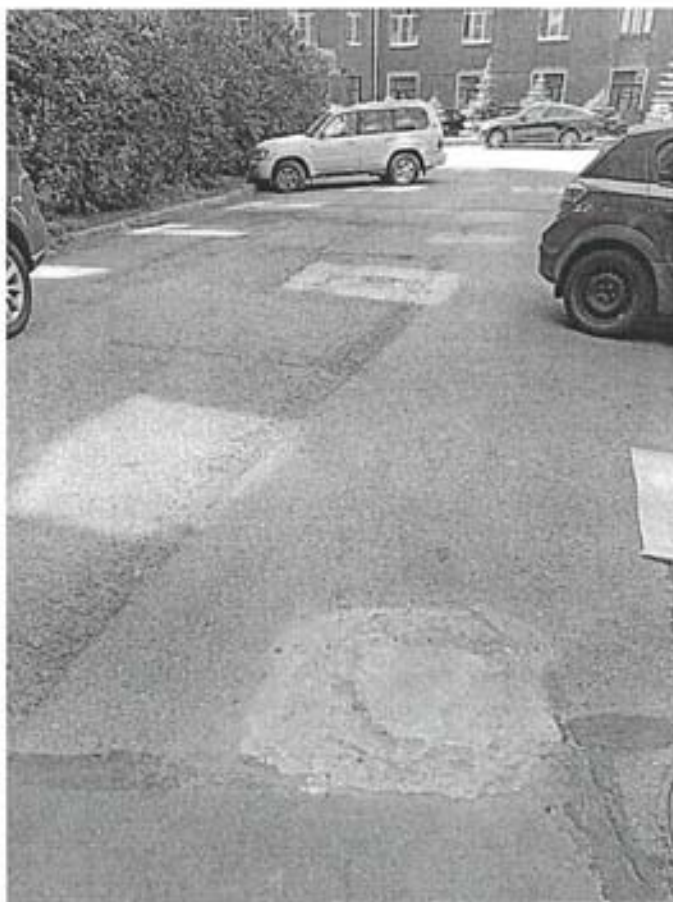
Фото 34. Территория внутреннего двора около парадной № 9
