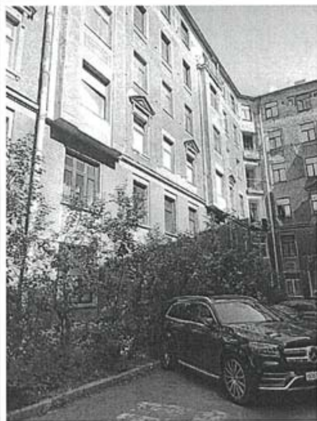
Фото 23. Дворовые фасады внутреннего двора
