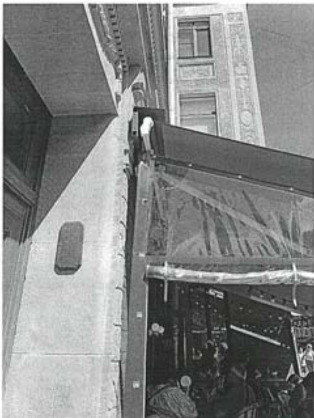
Фото 53. Выполнено устройство маркизы со стороны лицевого фасада помещения № 73-Н
