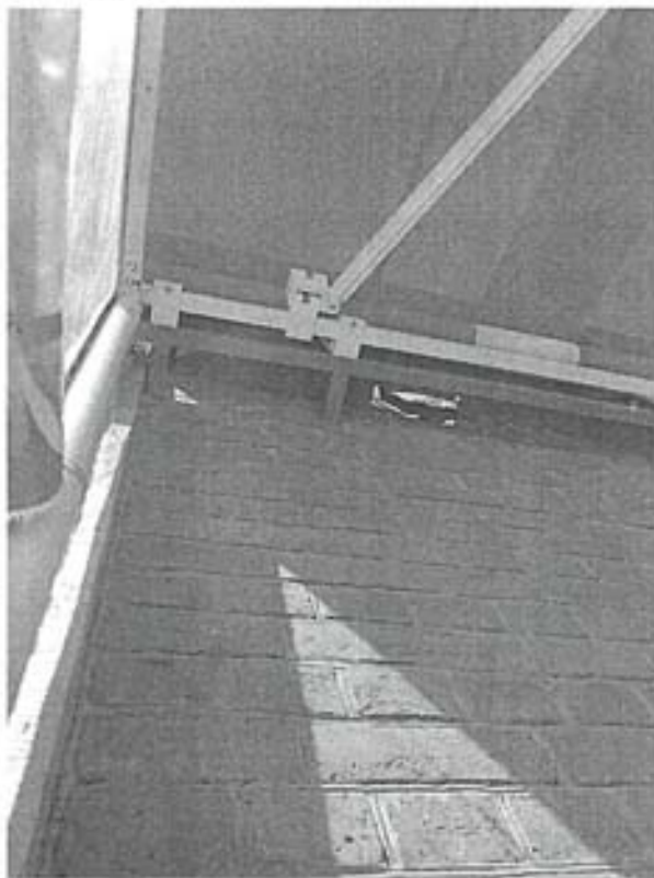
Фото 54. Выполнено устройство маркизы со стороны лицевого фасада помещения № 73-Н
