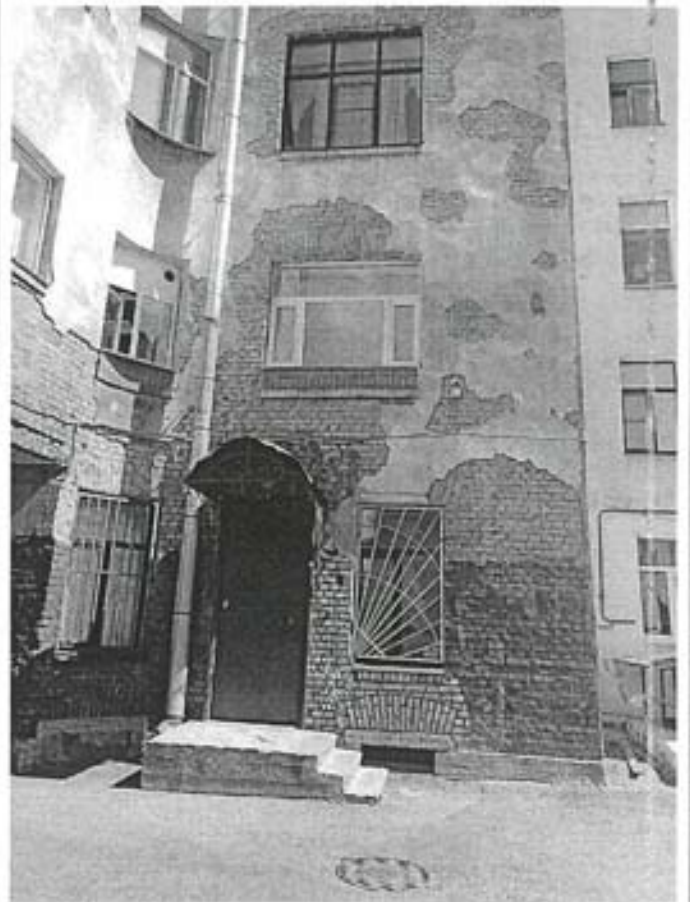
Фото 108. Фрагмент дворового фасада внешнего контура здания. В квартире № 252 выполнена закладка кирпичом нижней части двух оконных проемов
