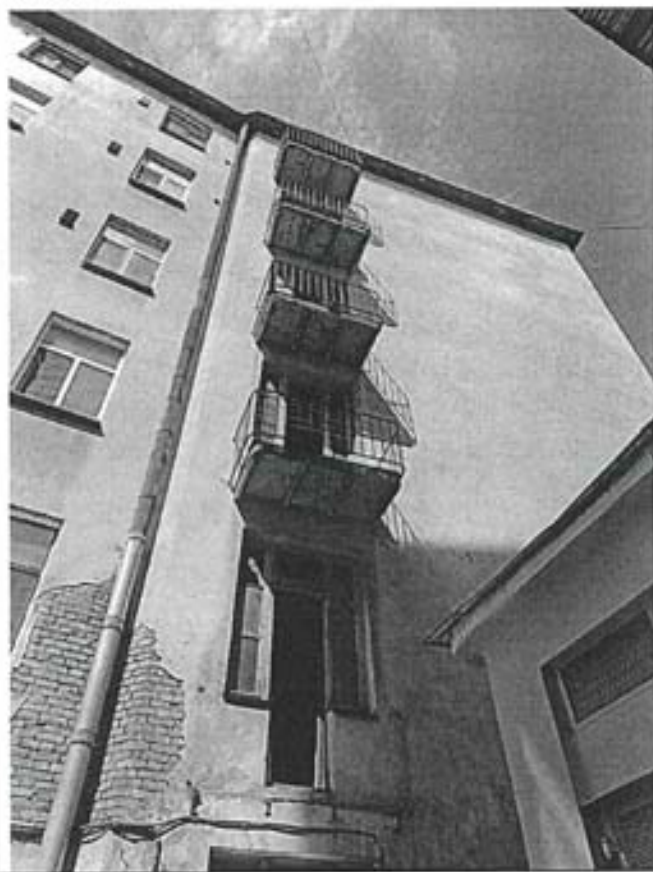
Фото 82. Фрагмент дворового фасада внешнего контура.
