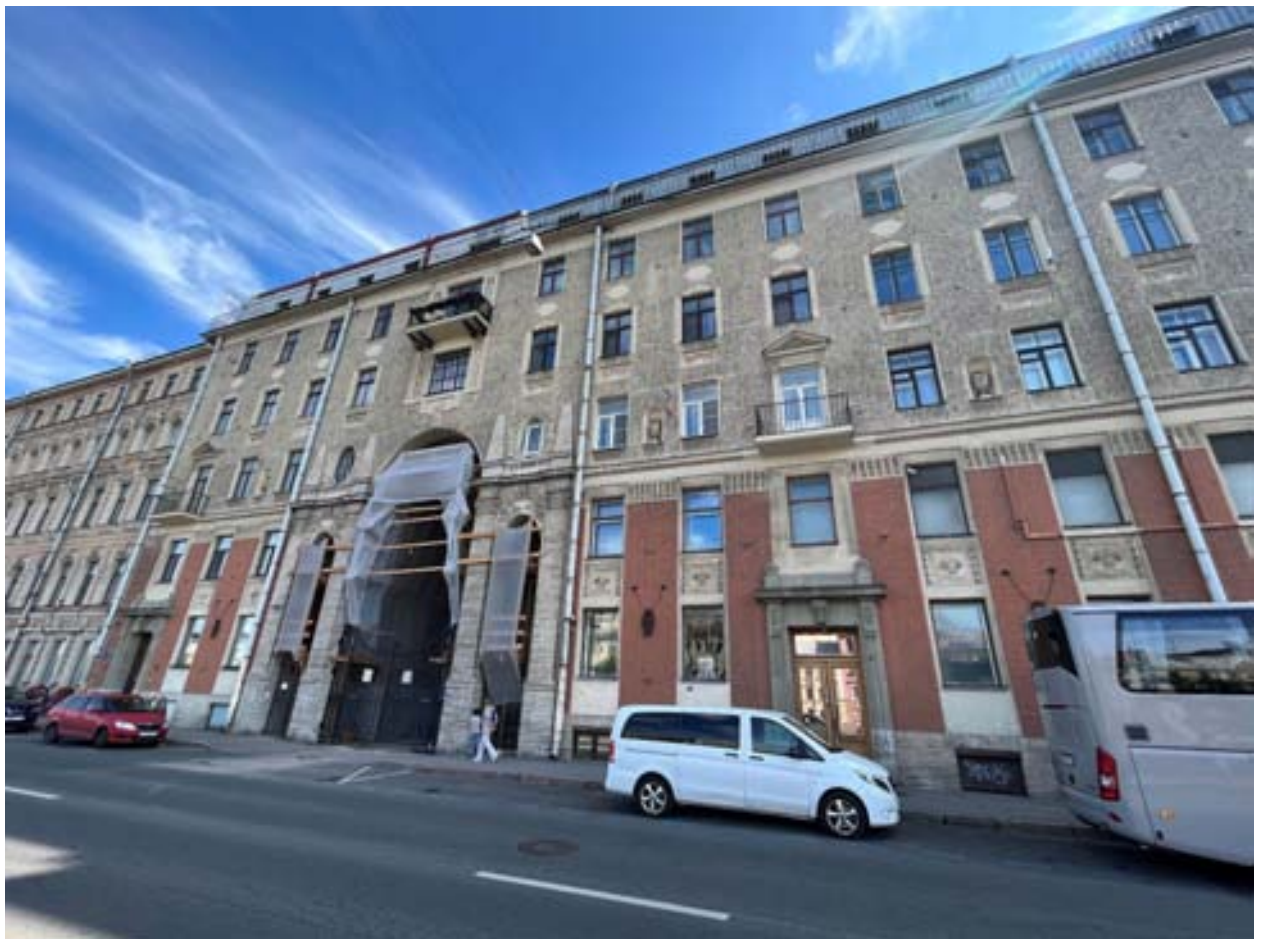
Фото №1. Лицевой фасад по наб. р. Фонтанки.
