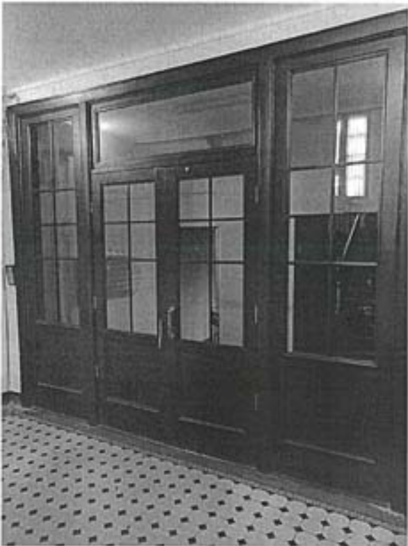
Фото 85. Дверное заполнение квартиры № 209-228
