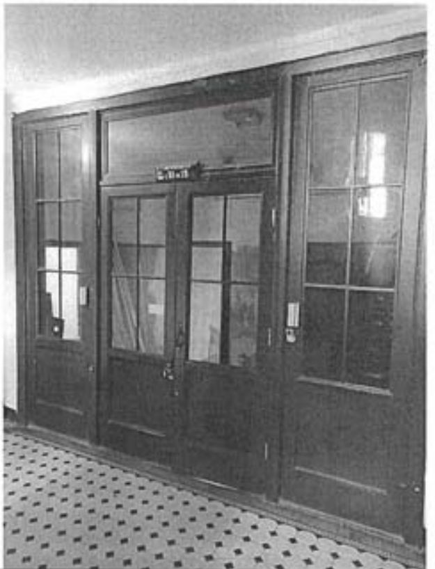
Фото 86. Дверное заполнение квартиры № 309-328
