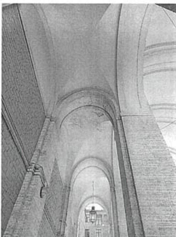
Фото 16. Арка проезда во двор со стороны наб. рек. Фонтанки
