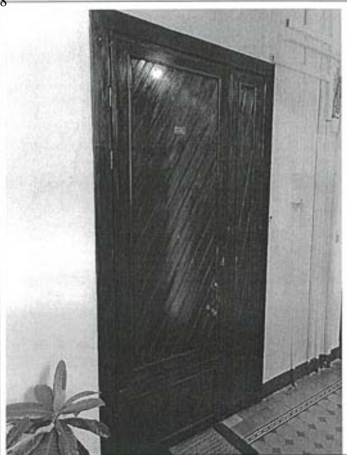
Фото 96. Дверное заполнение квартиры № 556
