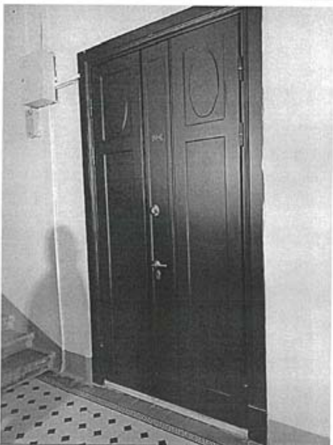
Фото 7. Парадная лестница (вход с фасада по наб. реки Фонтанки по первой световой оси)
