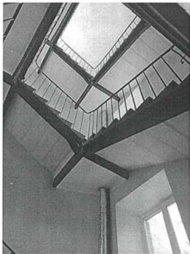
Фото 121. Литера Ц. Фрагмент внутренней лестницы.
