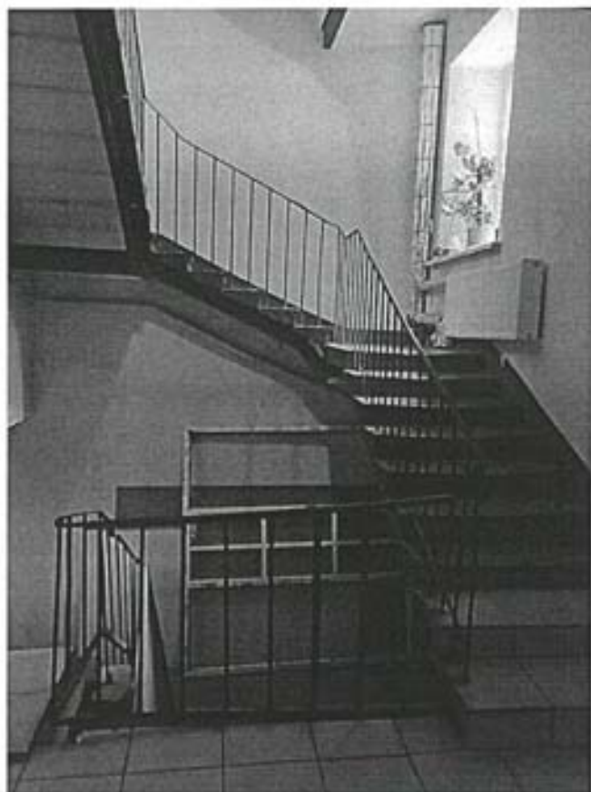
Фото 123. Литера Ц. Фрагмент внутренней лестницы.
