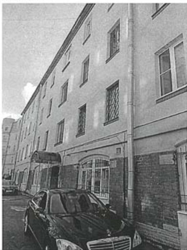
Фото 125. Фрагмент фасада Литера Ц.
