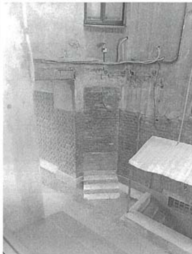
Фото 112. Выполнена закладка проема кирпичом помещения 1-Н
