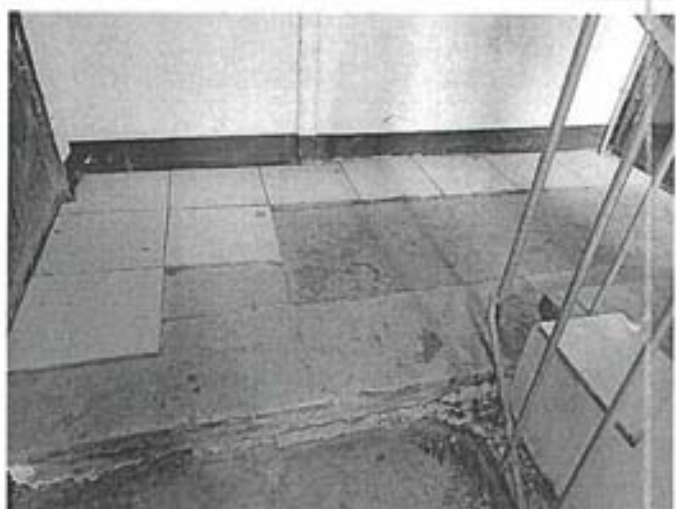
Фото 102. Площадка первого этажа черной лестницы (где расположены квартиры №№ 109-117, 108)
