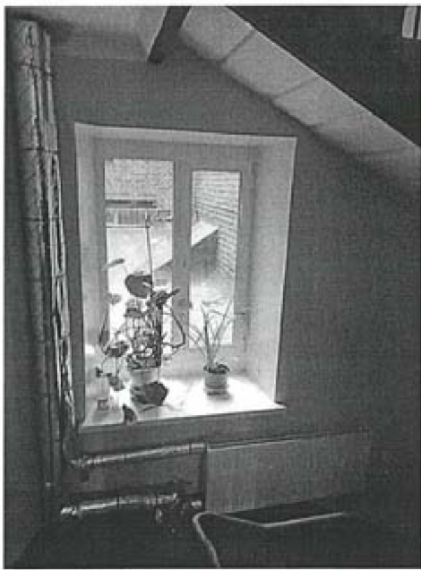
Фото 122. Литера Ц. Фрагмент внутренней лестницы.
