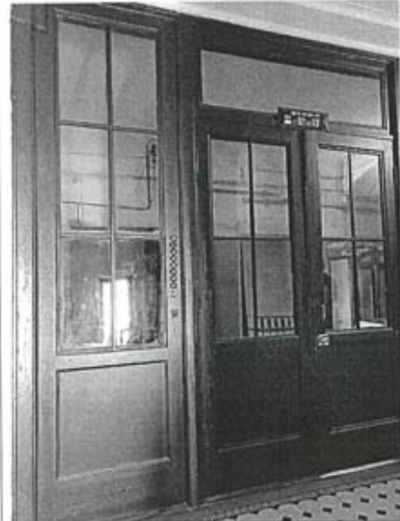
Фото 90. Дверное заполнение квартиры № 609-628
