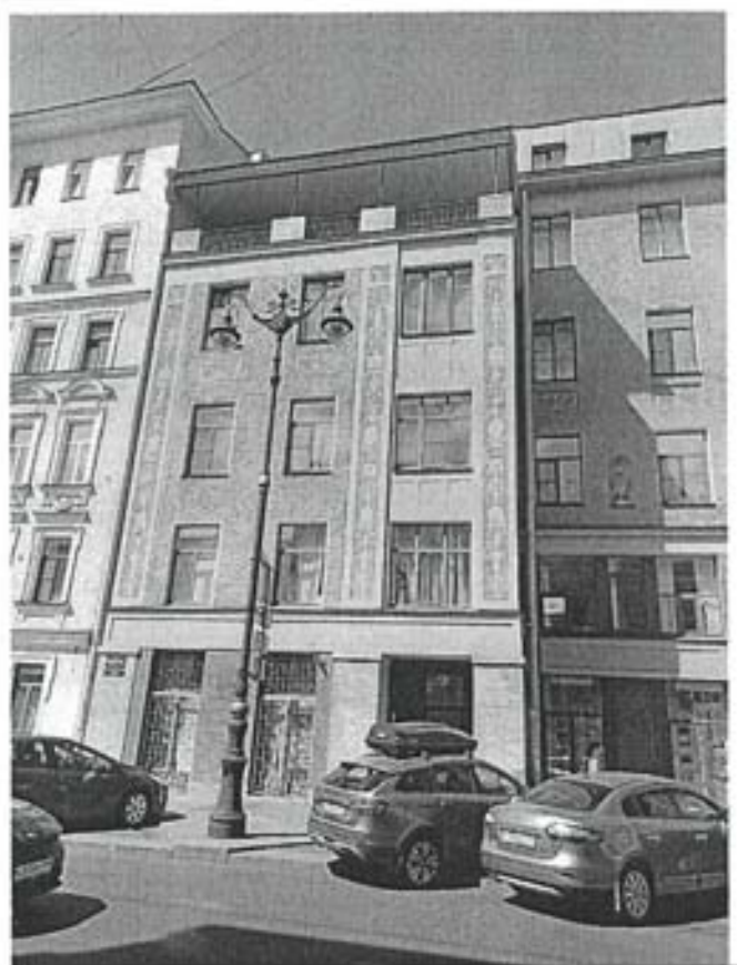
Фото 48. Фрагмент лицевого фасада со стороны Рубинштейна. Левая сторона. Над ризалитом лицевого фасада в границах квартиры № 552 устроен навес на опорах.
