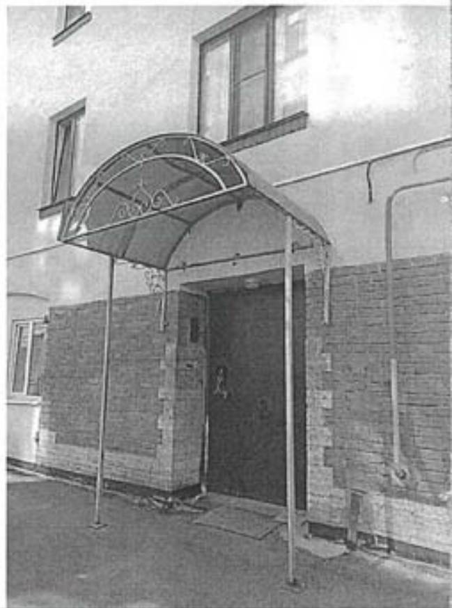
Фото 124. Фрагмент фасада Литера Ц. Вход на лестницу.
