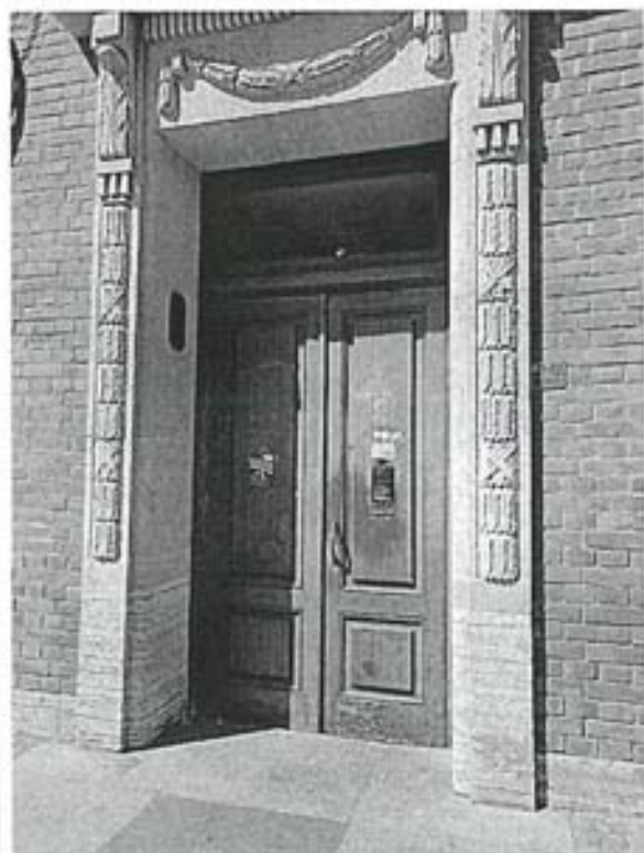
Фото 45. Фрагмент лицевого фасада со стороны Рубинштейна
