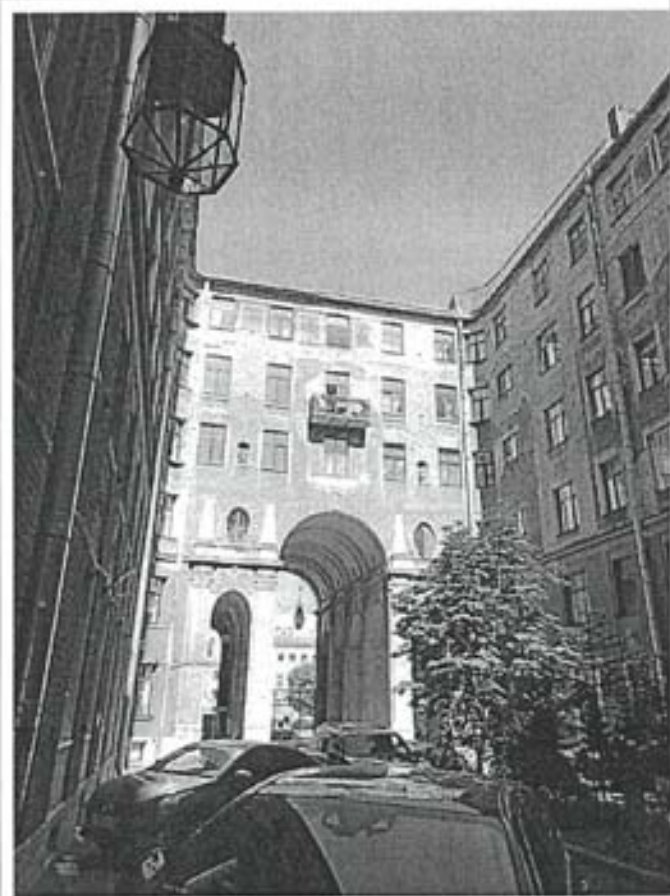
Фото 25. Дворовые фасады внутреннего двора. Арка проезда со стороны двора на наб.
