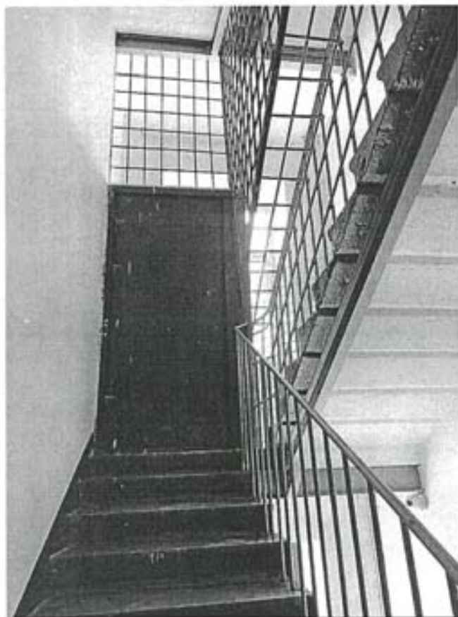
Фото 97. Устройство металлической решетки ограждения черной лестницы (где расположены квартиры №№ 109-117, 108)
