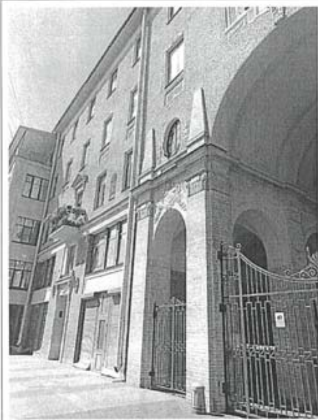
Фото 47. Фрагмент лицевого фасада со стороны Рубинштейна. Левая сторона. над ризалитом лицевого фасада со стороны улицы Рубинштейна в границах квартиры № 552 устроен навес на опорах.
