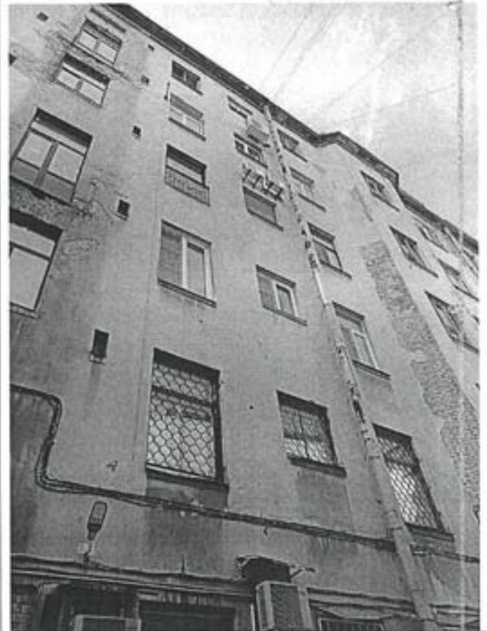
Фото 118. Фрагмент дворового фасада внешнего контура здания. Закладка нижней части оконного проема квартиры № 405
