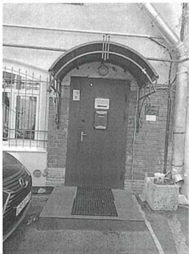
Фото 126. Фрагмент фасада Литера Ц.
