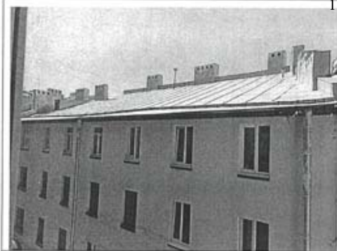
Фото 127. Фасад и кровля литера Ц.
