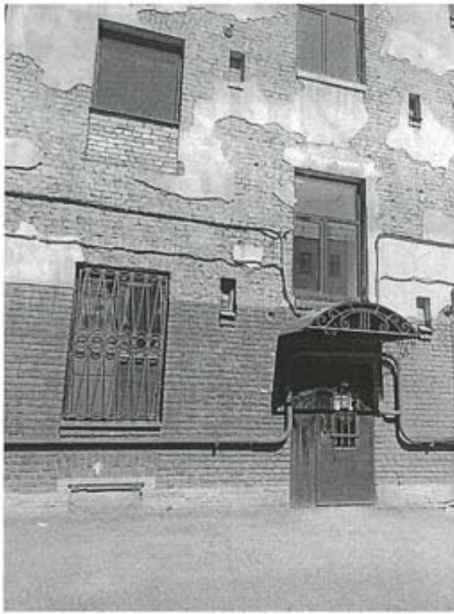
Фото 107. Фрагмент дворового фасада внешнего контура здания. В квартире № 255 выполнена закладка кирпичом нижней части оконного проема
