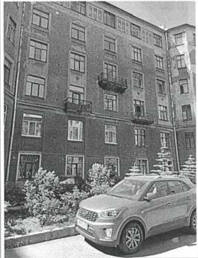
Фото 20. Дворовые фасады внутреннего двора.
