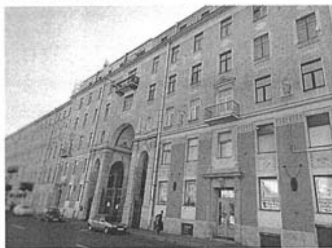
Фото 1. Лицевой фасад по наб. реки Фонтанки
