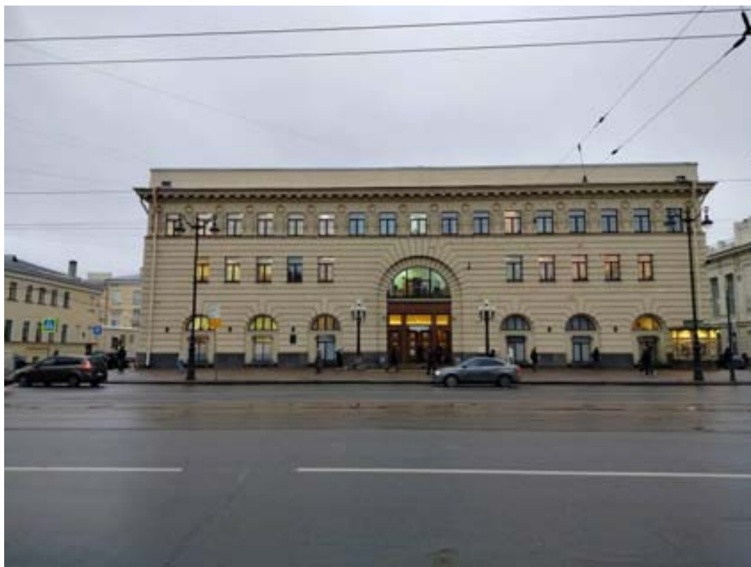
Фото 2. Фрагмент лицевого фасада объекта культурного наследия регионального значения «Станция метро «Пушкинская» (с перронным залом)»
