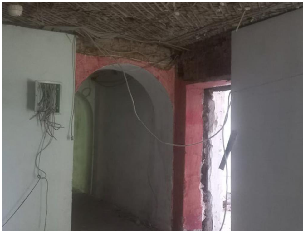
20. Объект культурного наследия федерального значения «Дом, где в 1814-1815 гг. и 1817-1822 гг. жил декабрист Лунин М.С.» по адресу: Санкт-Петербург, улица Степана Разина, дом 6/76, литера А (Рижский просп., 76, Степана Разина ул., 6). Помещение первого этажа. Общий вид.
