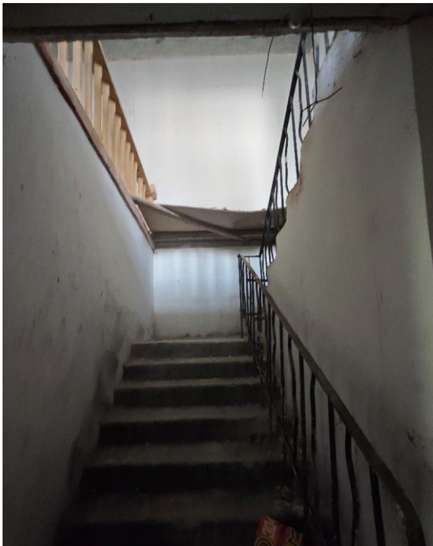
33. Объект культурного наследия федерального значения «Дом, где в 1814-1815 гг. и 1817-1822 гг. жил декабрист Лунин М.С.» по адресу: Санкт-Петербург, улица Степана Разина, дом 6/76, литера А (Рижский просп., 76, Степана Разина ул., 6). Лестница северной части здания (для прохода с первого на второй этаж)
