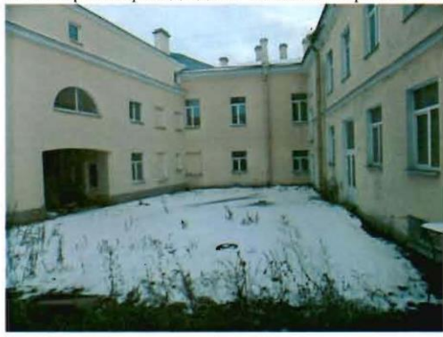
4. Внутренний двор здания с воротным проездом. Общий вид.
