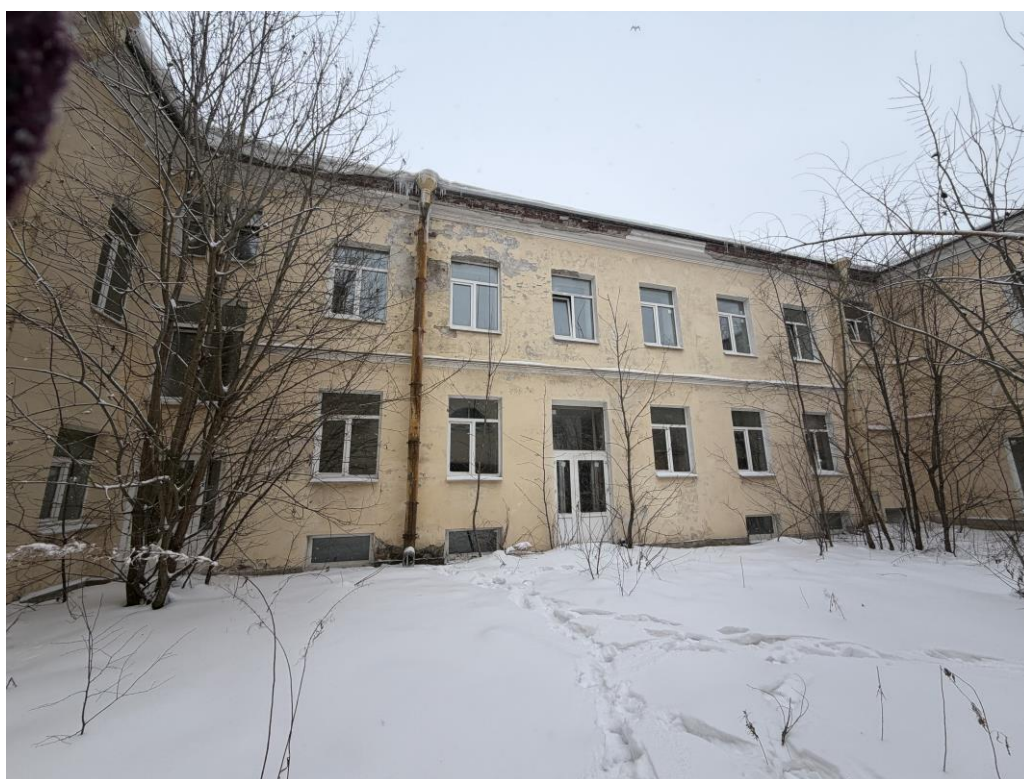
16. Объект культурного наследия федерального значения «Дом, где в 1814-1815 гг. и 1817-1822 гг. жил декабрист Лунин М.С.» по адресу: Санкт-Петербург, улица Степана Разина, дом 6/76, литера А (Рижский просп., 76, Степана Разина ул., 6). Дворовые фасады. Общий вид.
