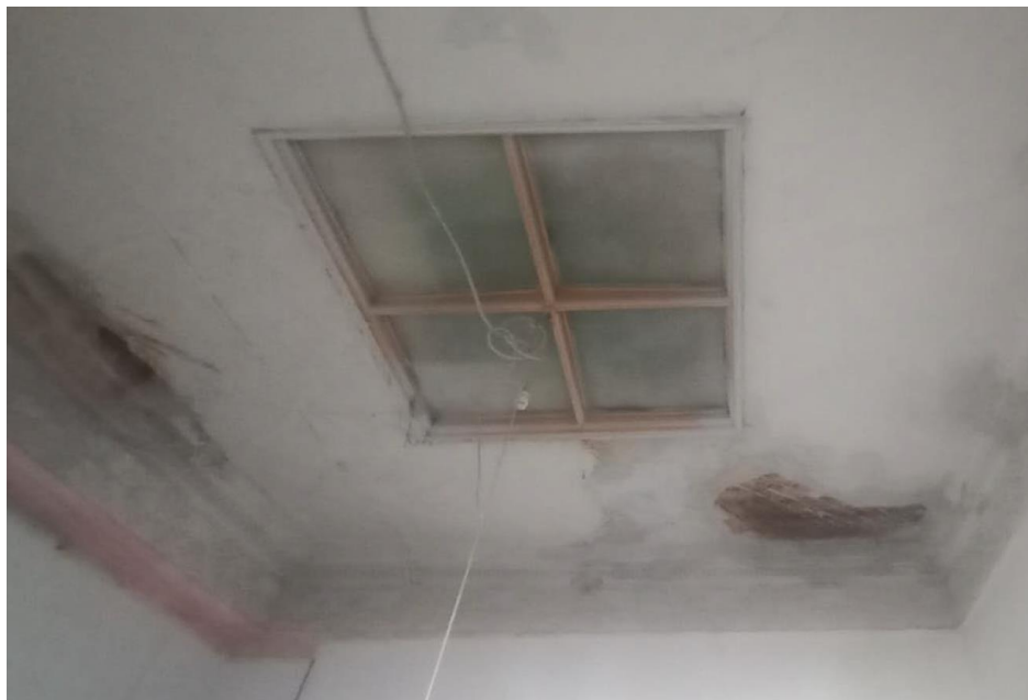
31. Объект культурного наследия федерального значения «Дом, где в 1814-1815 гг. и 1817-1822 гг. жил декабрист Лунин М.С.» по адресу: Санкт-Петербург, улица Степана Разина, дом 6/76, литера А (Рижский просп., 76, Степана Разина ул., 6). Световой фонарь над лестницей.
