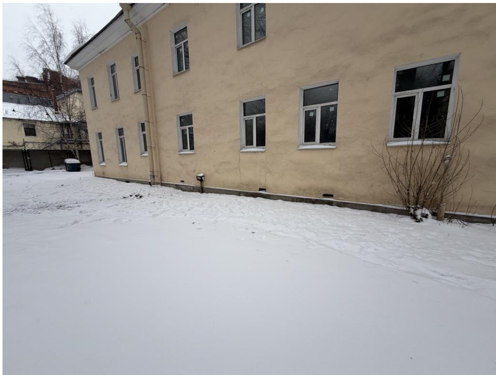
13. Объект культурного наследия федерального значения «Дом, где в 1814-1815 гг. и 1817-1822 гг. жил декабрист Лунин М.С.» по адресу: Санкт-Петербург, улица Степана Разина, дом 6/76, литера А (Рижский просп., 76, Степана Разина ул., 6). Восточный фасад. Фрагмент.
