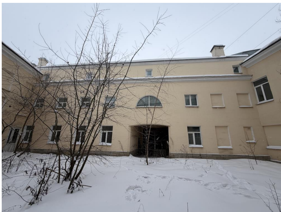
14. Объект культурного наследия федерального значения «Дом, где в 1814-1815 гг. и 1817-1822 гг. жил декабрист Лунин М.С.» по адресу: Санкт-Петербург, улица Степана Разина, дом 6/76, литера А (Рижский просп., 76, Степана Разина ул., 6). Дворовые фасады. Общий вид.
