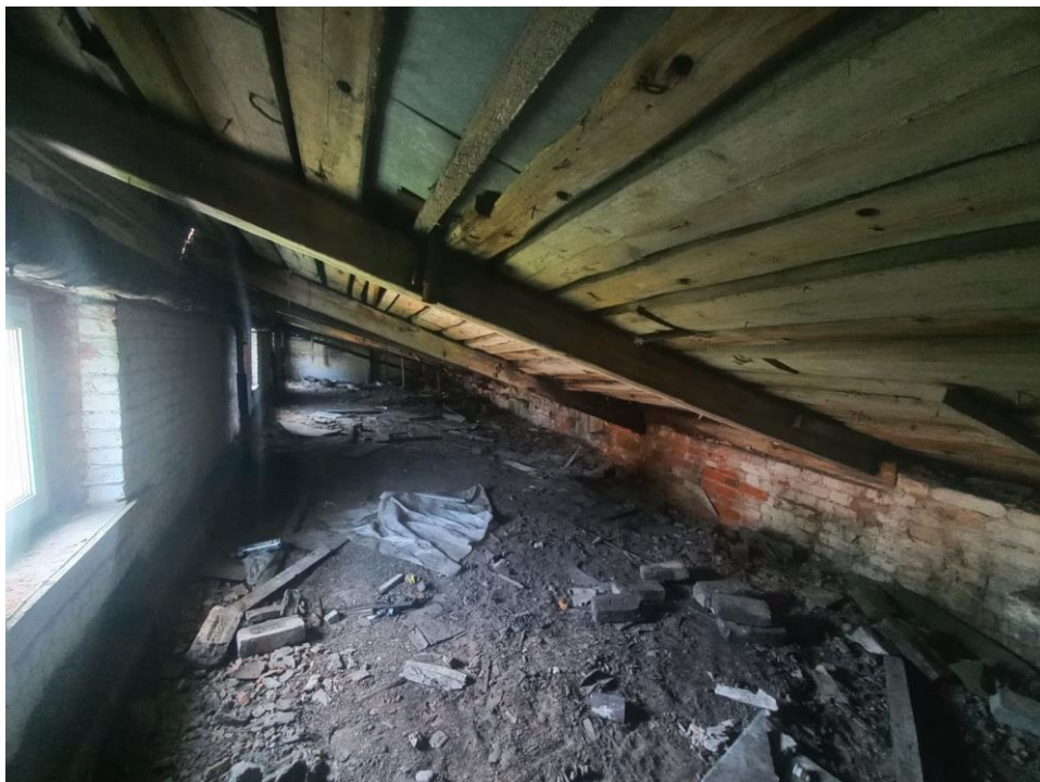
39. Объект культурного наследия федерального значения «Дом, где в 1814-1815 гг. и 1817-1822 гг. жил декабрист Лунин М.С.» по адресу: Санкт-Петербург, улица Степана Разина, дом 6/76, литера А (Рижский просп., 76, Степана Разина ул., 6). Помещение чердака. Общий вид.
