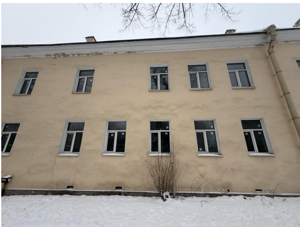
12. Объект культурного наследия федерального значения «Дом, где в 1814-1815 гг. и 1817-1822 гг. жил декабрист Лунин М.С.» по адресу: Санкт-Петербург, улица Степана Разина, дом 6/76, литера А (Рижский просп., 76, Степана Разина ул., 6). Восточный фасад. Фрагмент.
