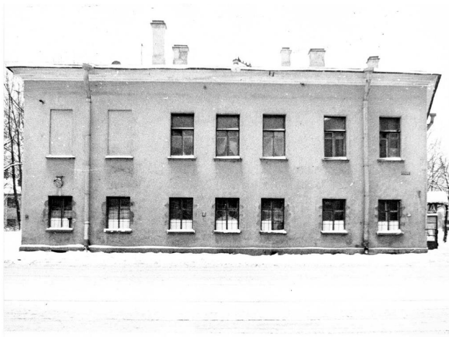
27. Дом, в котором жил декабрист М.С. Лунин («Дом Луниных»). Общий вид фасада со стороны Рижского проспекта. Паспорт памятника. Л., 1977. Приложение № 12.
