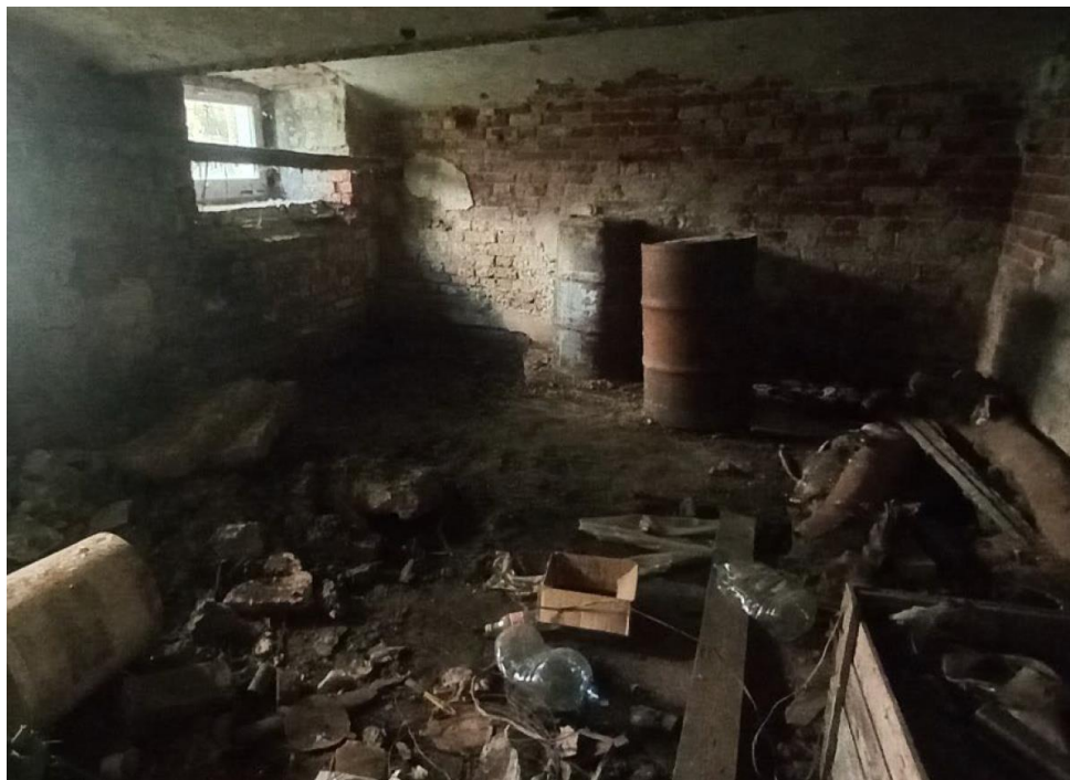
17. Объект культурного наследия федерального значения «Дом, где в 1814-1815 гг. и 1817-1822 гг. жил декабрист Лунин М.С.» по адресу: Санкт-Петербург, улица Степана Разина, дом 6/76, литера А (Рижский просп., 76, Степана Разина ул., 6). Помещение подвала. Общий вид.
