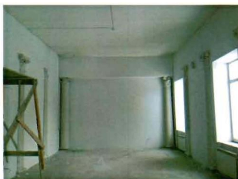
7. Внутренняя планировочная структура. Помещение второго этажа. Лицевой корпус.
