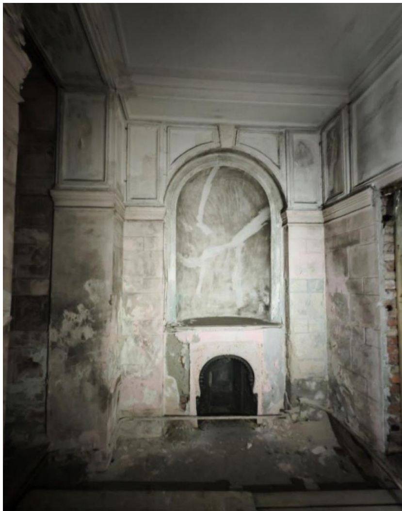
18. Объект культурного наследия федерального значения «Дом, где в 1814-1815 гг. и 1817-1822 гг. жил декабрист Лунин М.С.» по адресу: Санкт-Петербург, улица Степана Разина, дом 6/76, литера А (Рижский просп., 76, Степана Разина ул., 6). Помещение первого этажа. Входная зона.
