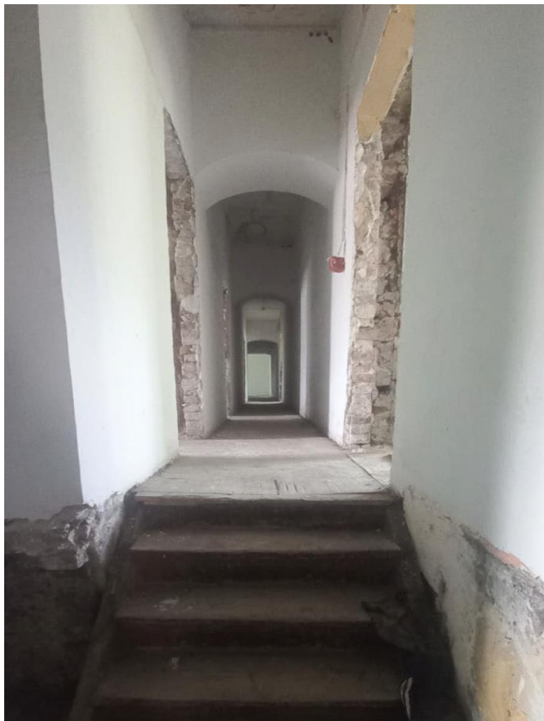
25. Объект культурного наследия федерального значения «Дом, где в 1814-1815 гг. и 1817-1822 гг. жил декабрист Лунин М.С.» по адресу: Санкт-Петербург, улица Степана Разина, дом 6/76, литера А (Рижский просп., 76, Степана Разина ул., 6). Коридор второго этажа. Общий вид.
