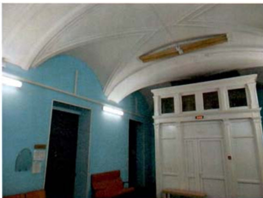
2. Фрагмент вестибюля и тамбура парадного входа в здание.
