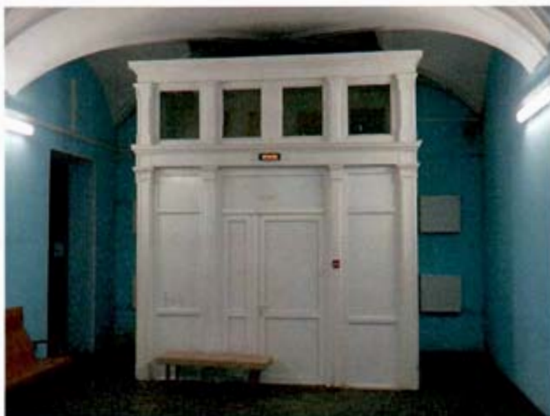
3. Тамбур парадного входа в здание.
