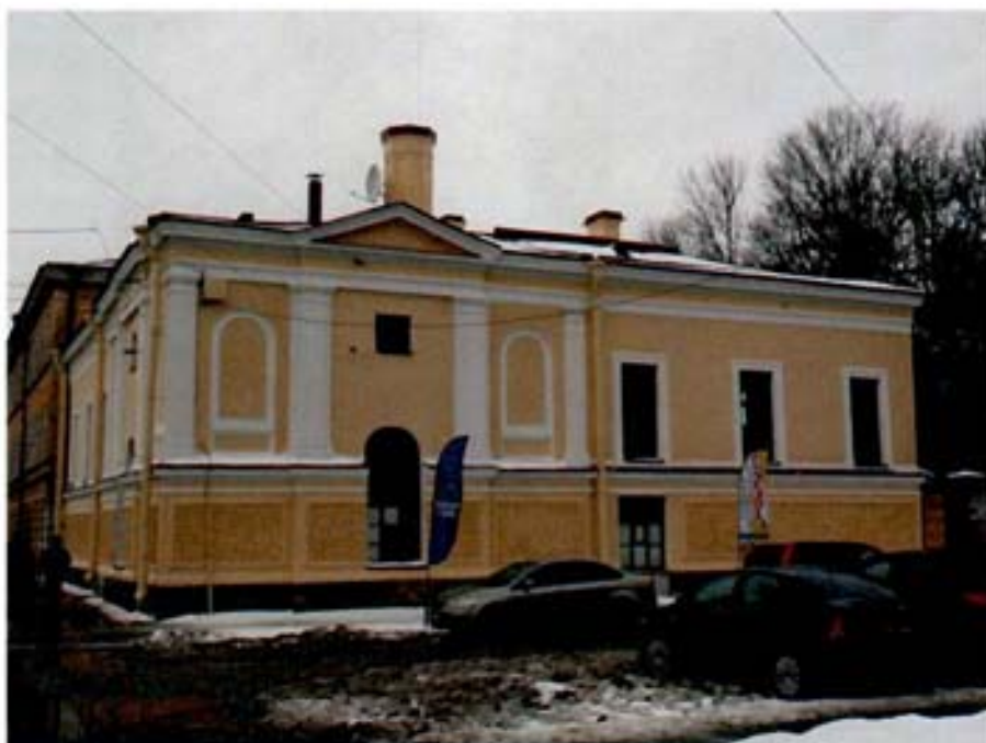
14. Восточный лицевой фасад здания.
