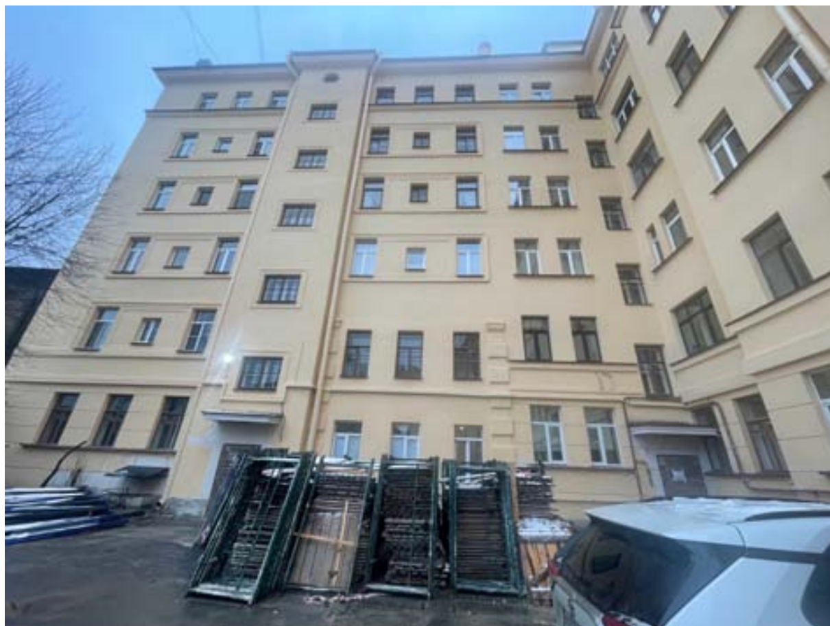
2. Вид на дворовой фасад здания
