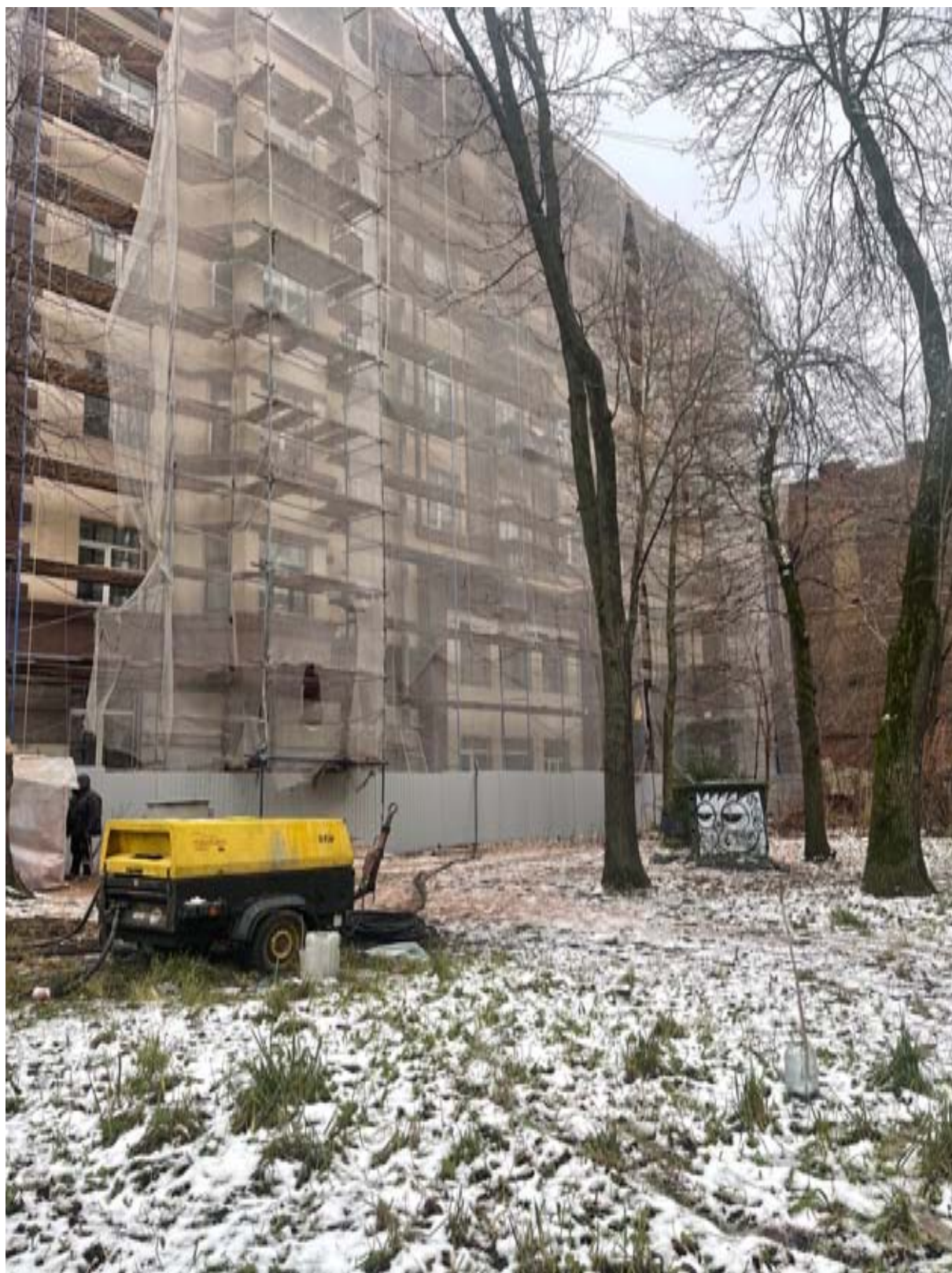
1. Вид на западный лицевой фасад
