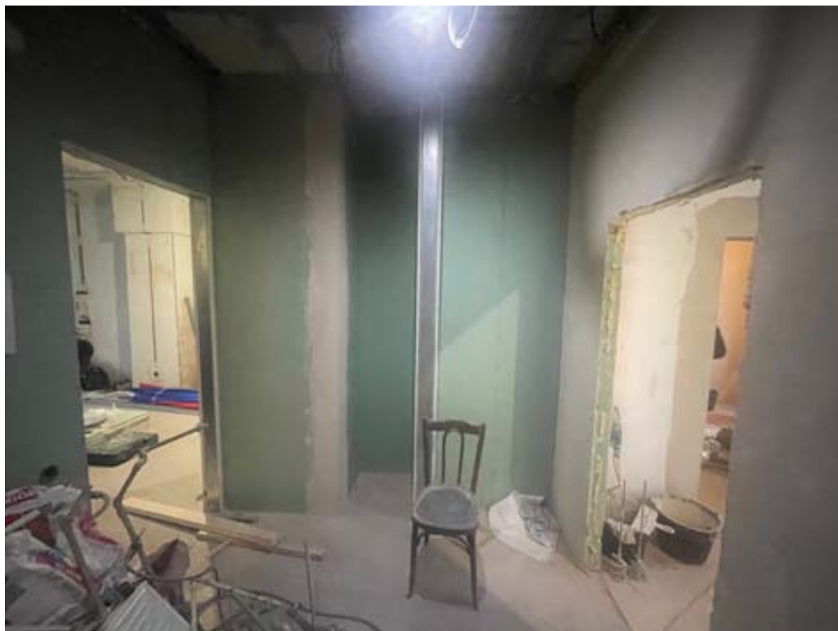
6. Вид на пом. 1
