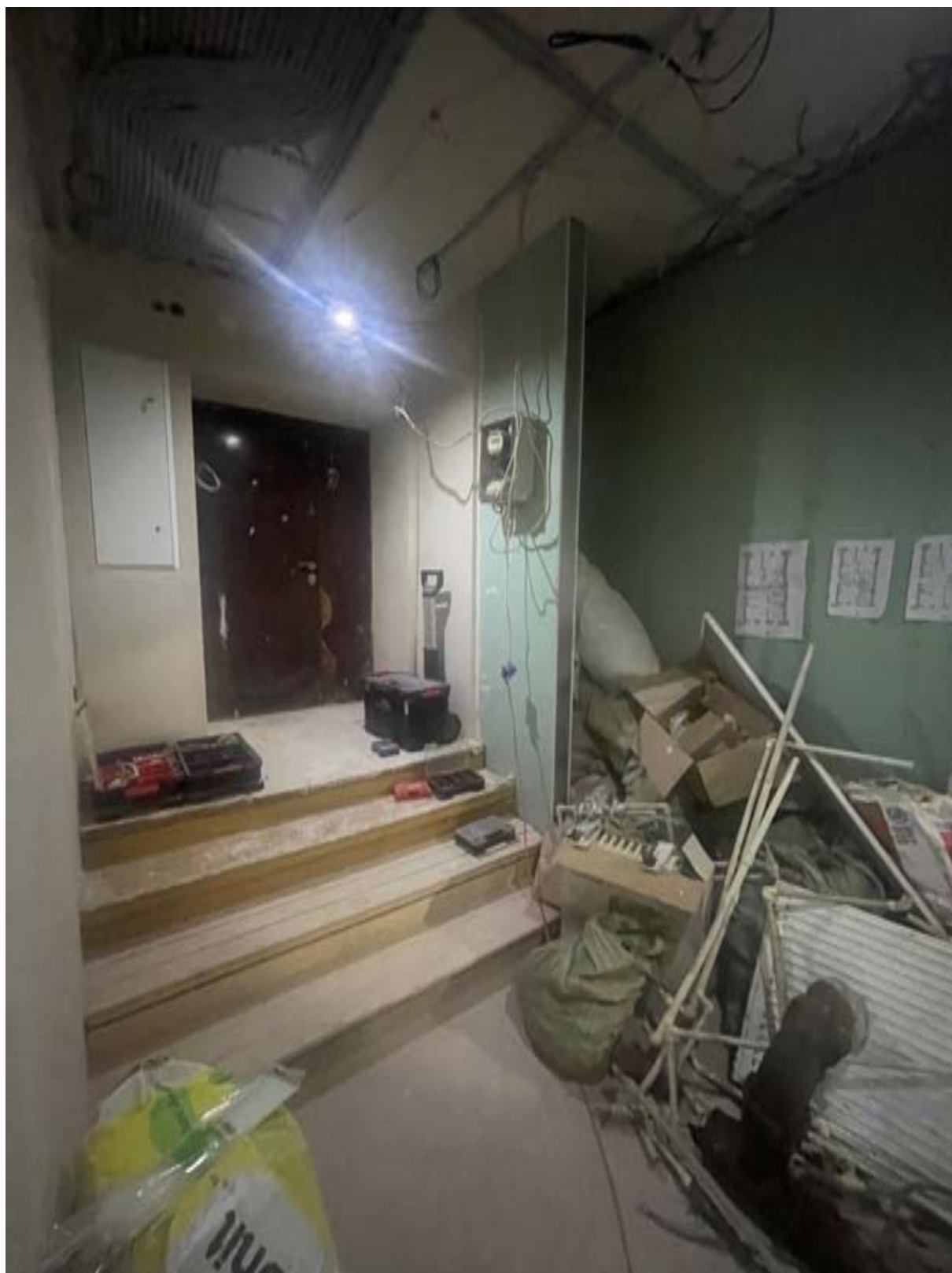
5. Вид на пом. 1 1
