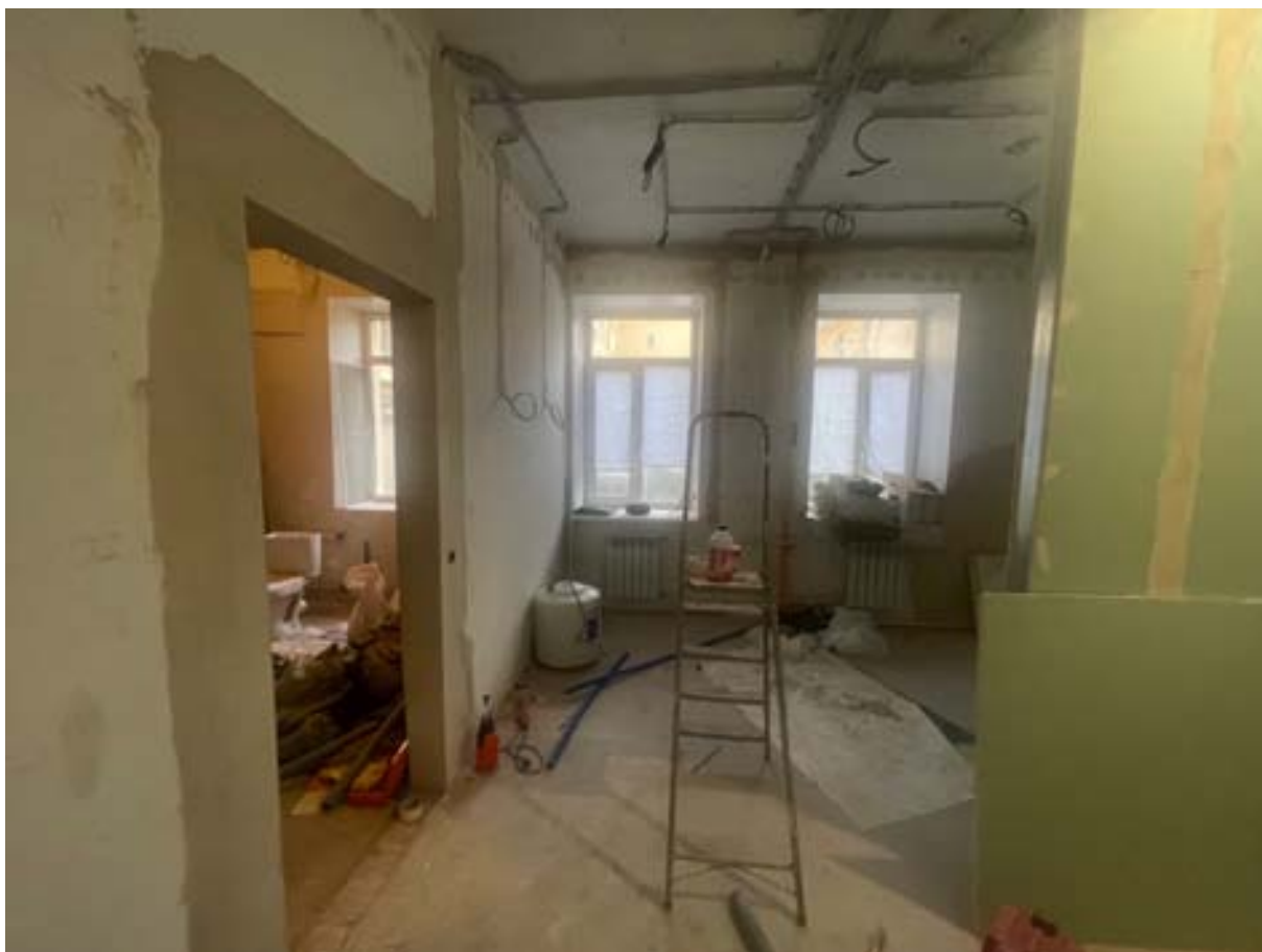
14. Вид на пом. 3
