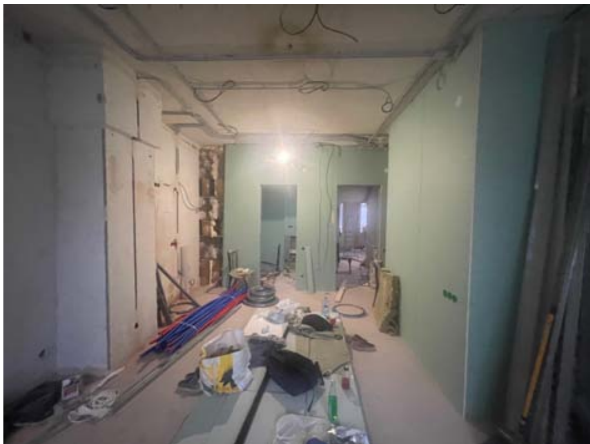
12. Вид на пом. 8
