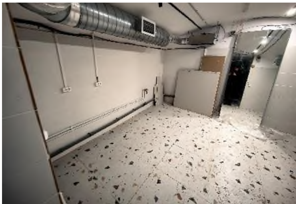
Точка фотофиксации № 18. Вид на помещение подвала (№7) (09.02.2026)
