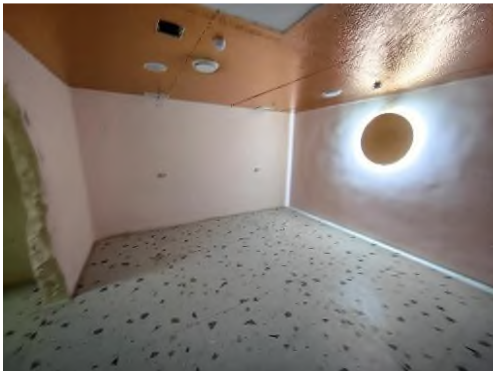
Точка фотофиксации № 15. Вид на помещение подвала (№5) (09.02.2026)
