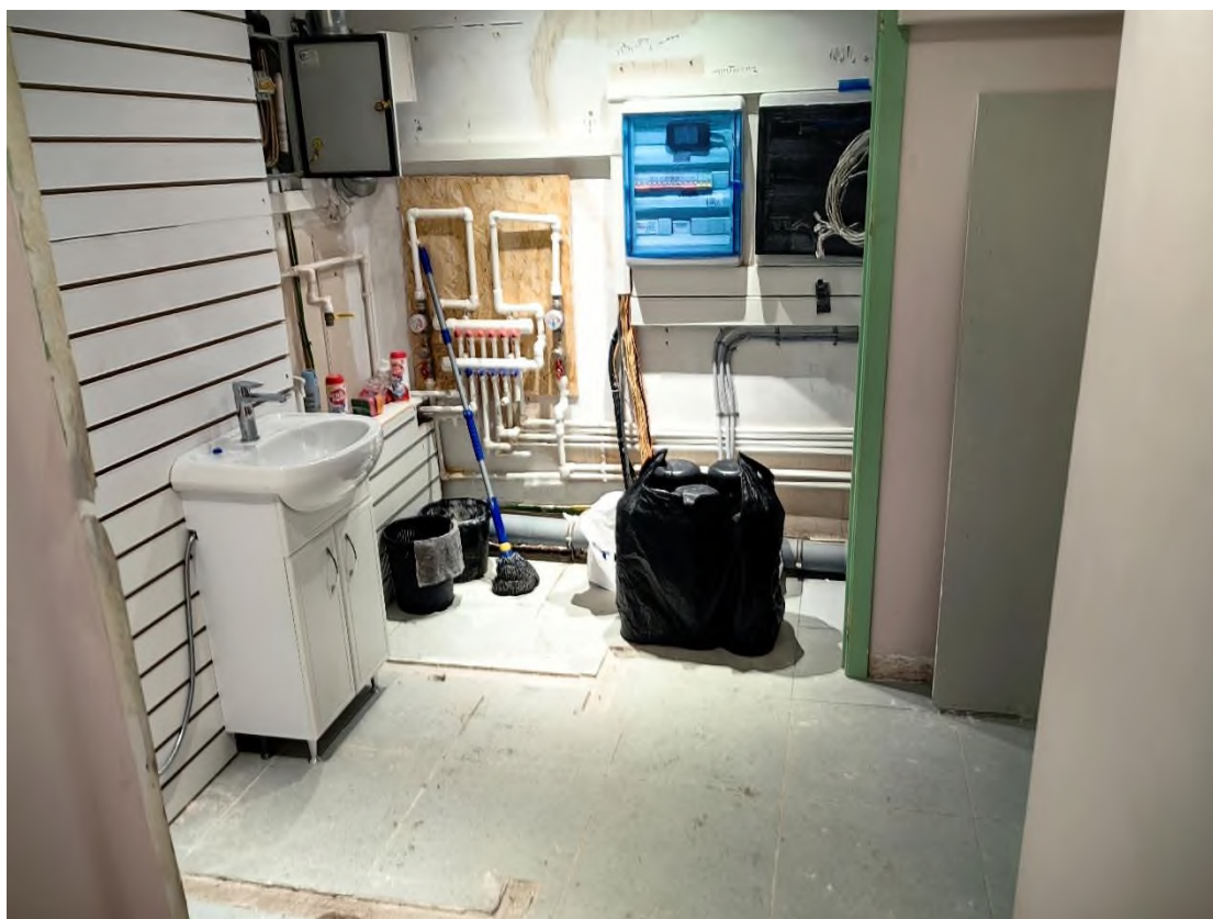
Точка фотофиксации № 8. Вид на помещение санузла (№3) первого этажа (09.02.2026)
