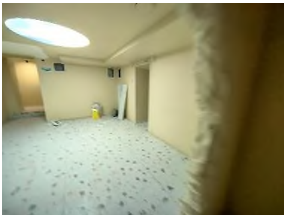
Точка фотофиксации № 14. Вид на помещение подвала (№5) (09.02.2026)
