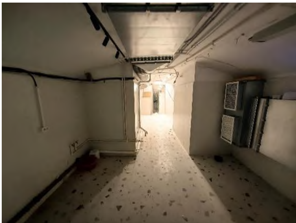
Точка фотофиксации № 17. Вид на помещение подвала (№6) (09.02.2026)
