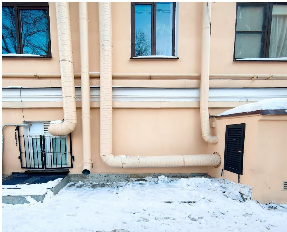
Точка фотофиксации №3. Вид на приямок входа в помещение 17-Н с дворового фасада (09.02.2026)
