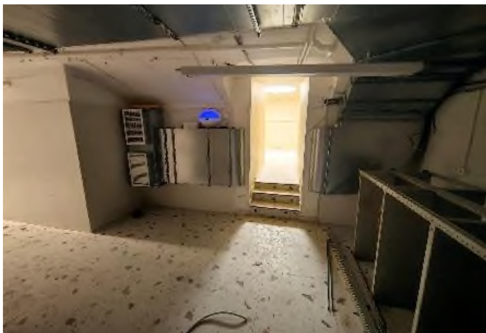
Точка фотофиксации № 16. Вид на помещение подвала (№7) (09.02.2026)
