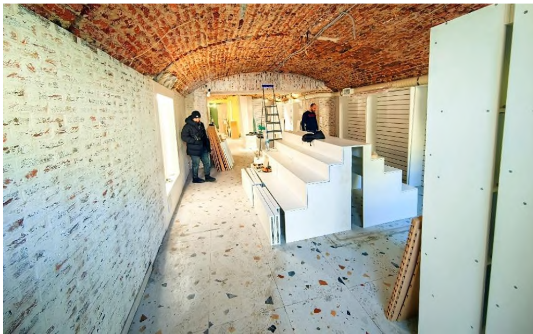
Точка фотофиксации № 5. Вид на помещение (№1) от входа с Невского проспекта (09.02.2026)
