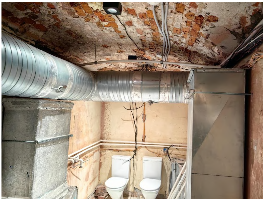
Точка фотофиксации № 11. Вид на помещение подвала (№4) (09.02.2026)
