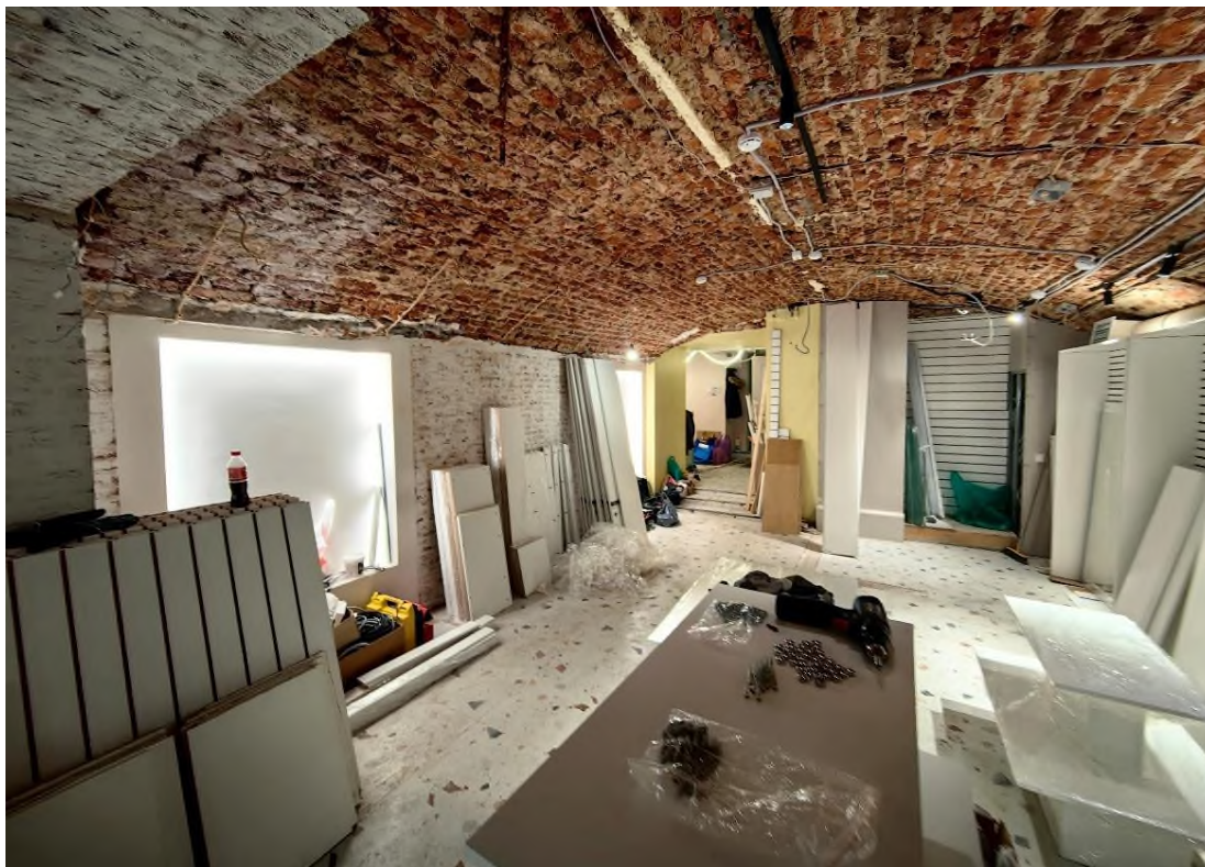
Точка фотофиксации № 7. Вид на помещение (№1) первого этажа (09.02.2026)
