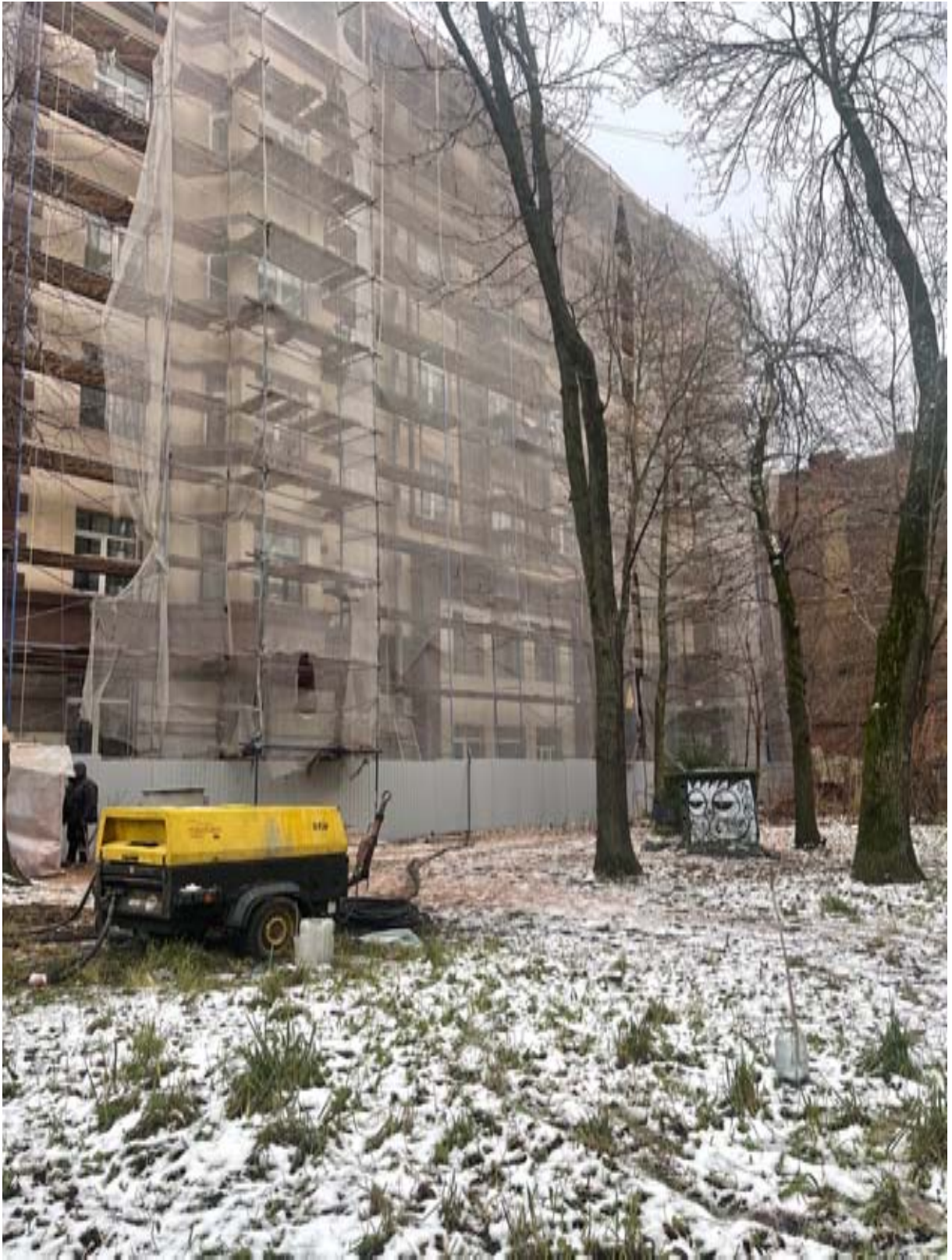
1. Вид на западный лицевой фасад
