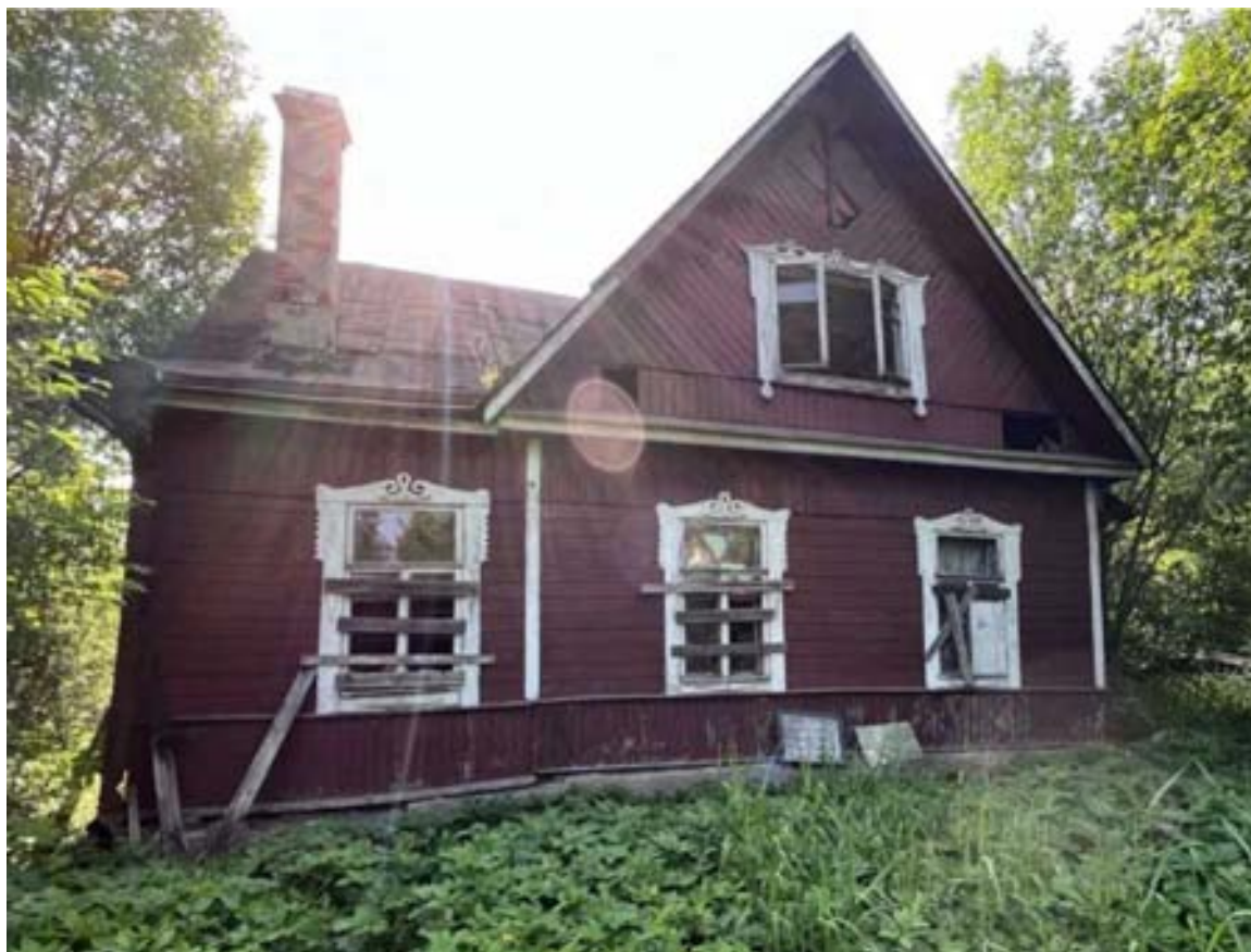
Илл. 18. Общий вид жилого дома по адресу: Пушкинская ул., 25 А. Июнь 2023 г. Из материалов обследования технического состояния «Санкт-Петербургской научно-технической организации «Наука – Производству».
