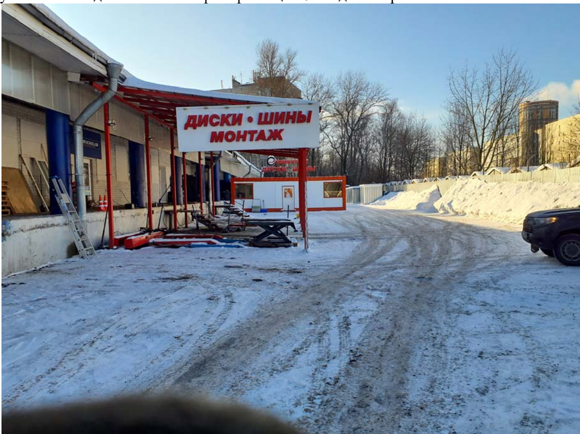
Рис. 30. Санкт-Петербург, ул. Матроса Железняка – 2026. Северо-западная часть участка обследования. Точка фотофиксации 4. Вид с северо-востока
