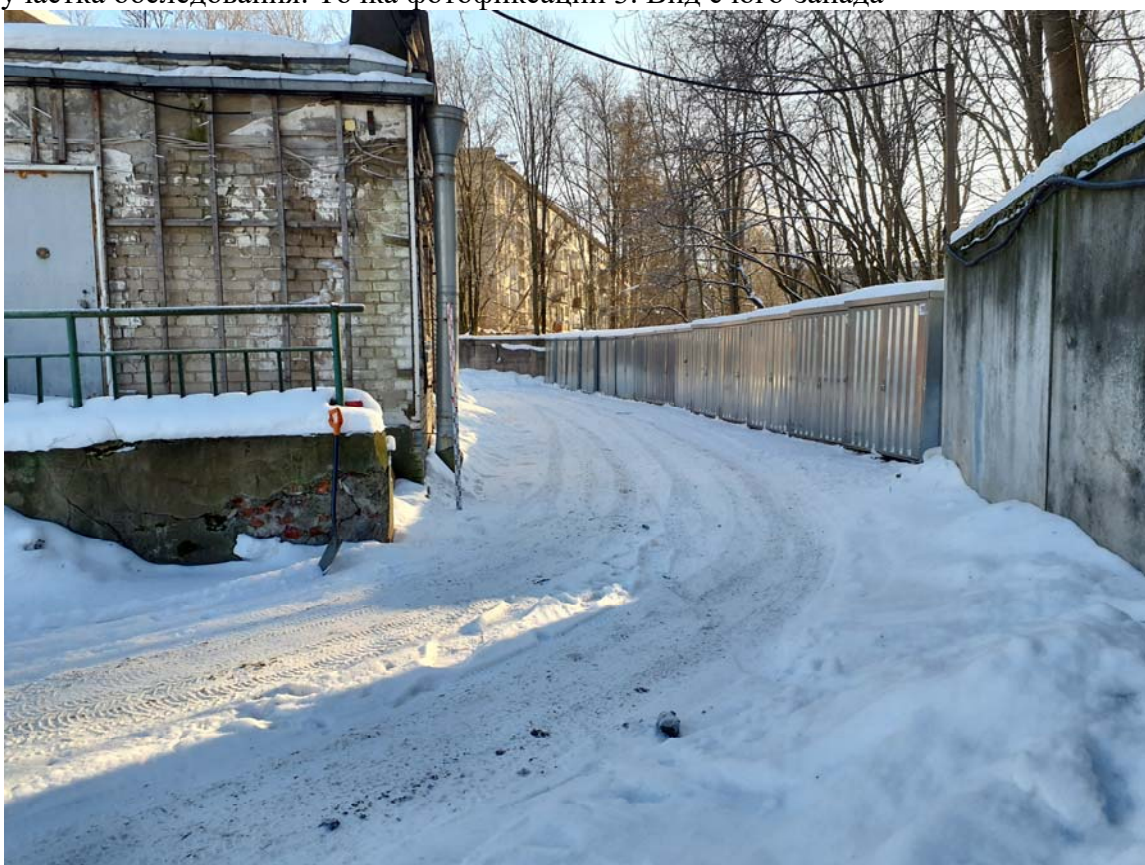
Рис. 32. Санкт-Петербург, ул. Матроса Железняка – 2026. Юго-западная часть участка обследования. Точка фотофиксации 3. Вид с северо-запада
