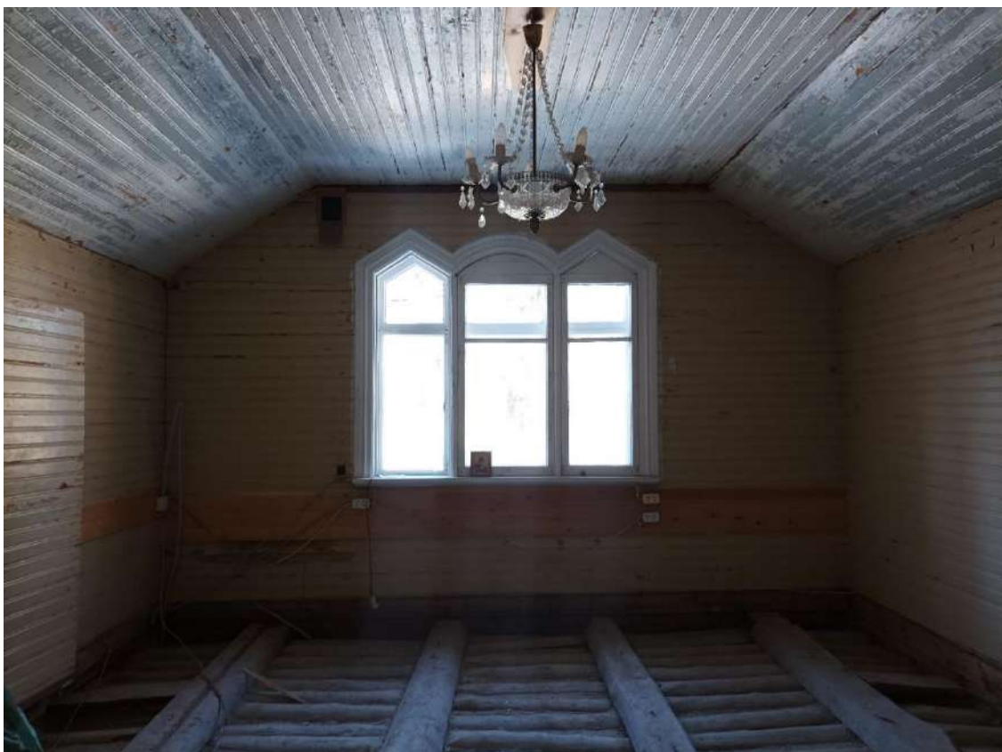
Фото 47. Объект культурного наследия регионального значения «Дача Е. Н. Макаровой (семьи академика А. Е. Фаворского)». Внутренние помещения мансарды.
