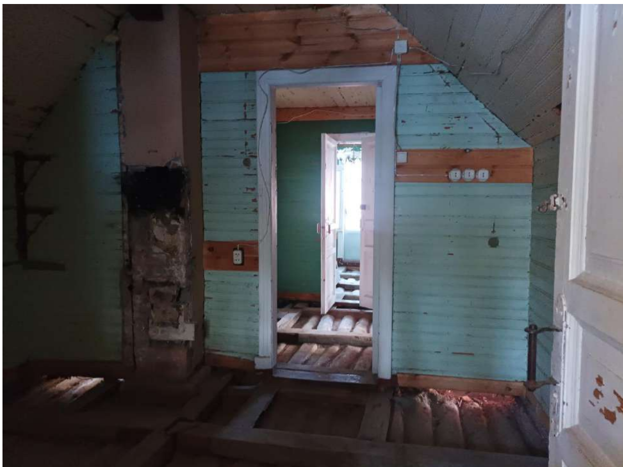
Фото 42. Объект культурного наследия регионального значения «Дача Е. Н. Макаровой (семьи академика А. Е. Фаворского)». Внутренние помещения мансарды.
