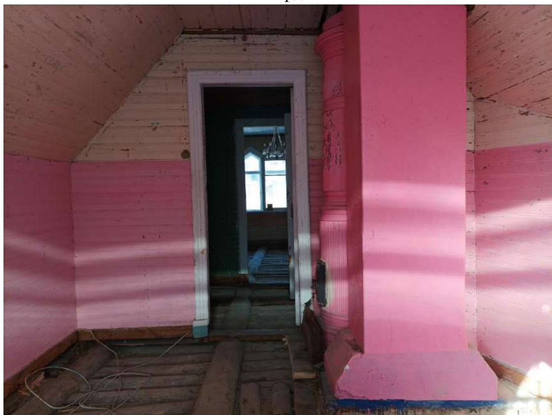
Фото 45. Объект культурного наследия регионального значения «Дача Е. Н. Макаровой (семьи академика А. Е. Фаворского)». Внутренние помещения мансарды.
