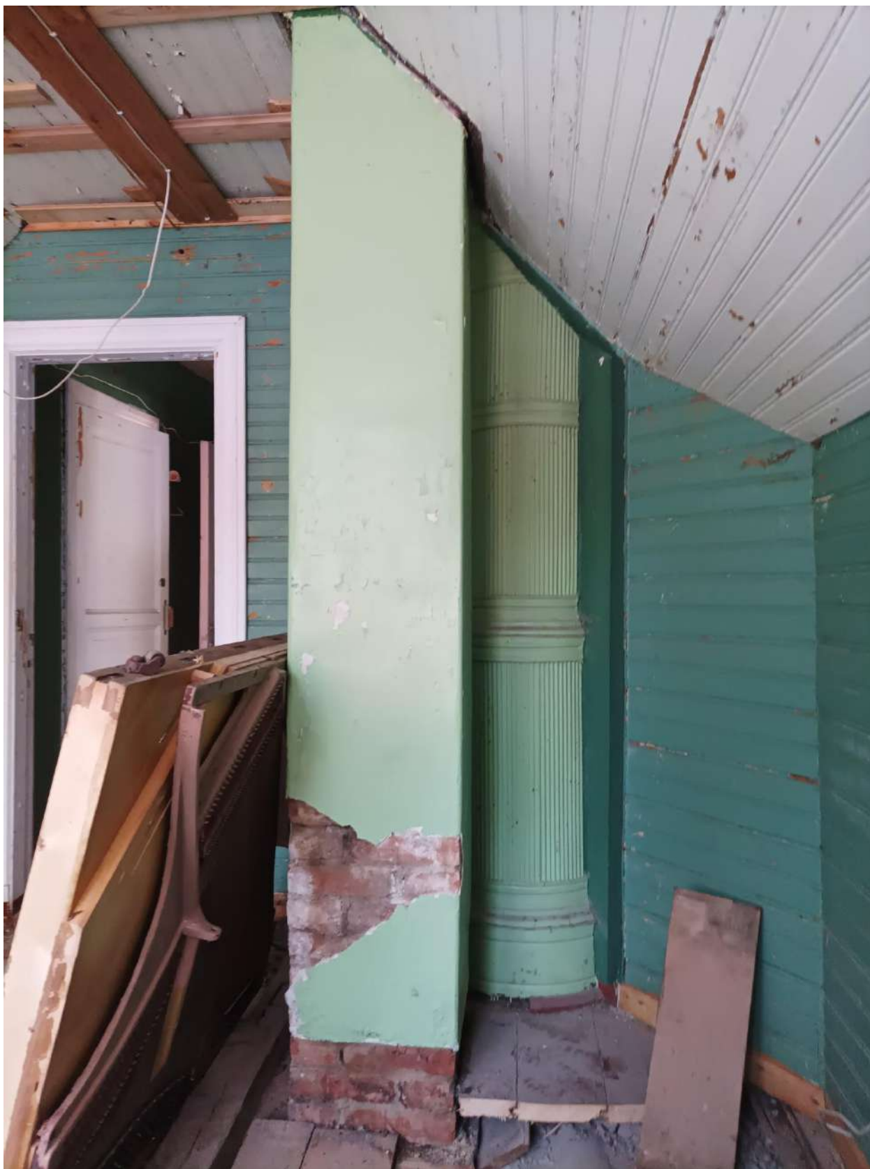
Фото 53. Объект культурного наследия регионального значения «Дача Е. Н. Макаровой (семьи академика А. Е. Фаворского)». Внутренние помещения мансарды.
