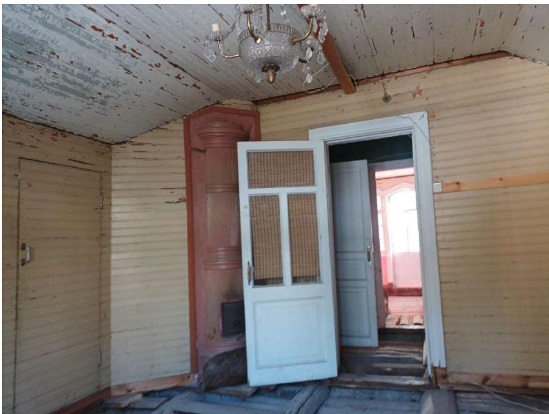
Фото 49. Объект культурного наследия регионального значения «Дача Е. Н. Макаровой (семьи академика А. Е. Фаворского)». Внутренние помещения мансарды.
