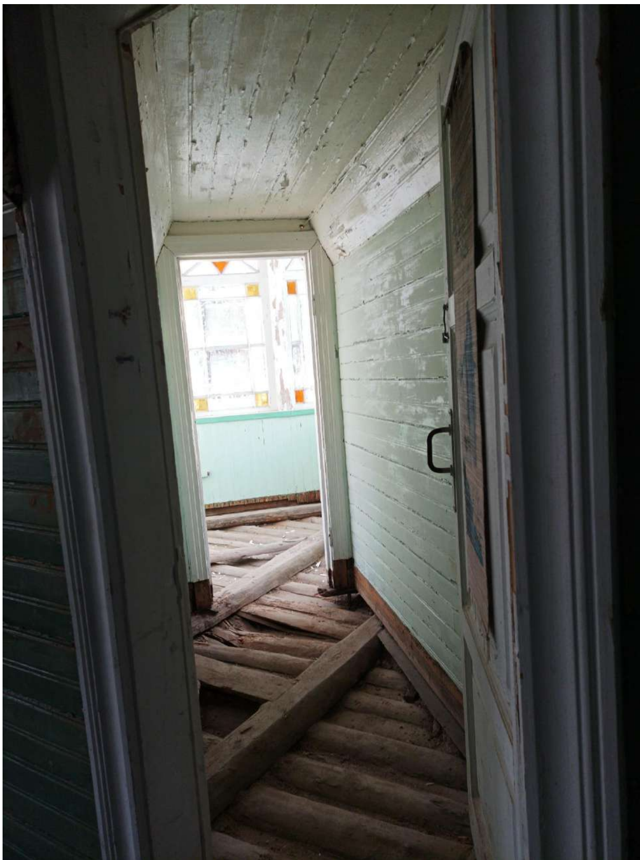
Фото 54. Объект культурного наследия регионального значения «Дача Е. Н. Макаровой (семьи академика А. Е. Фаворского)». Внутренние помещения мансарды.
