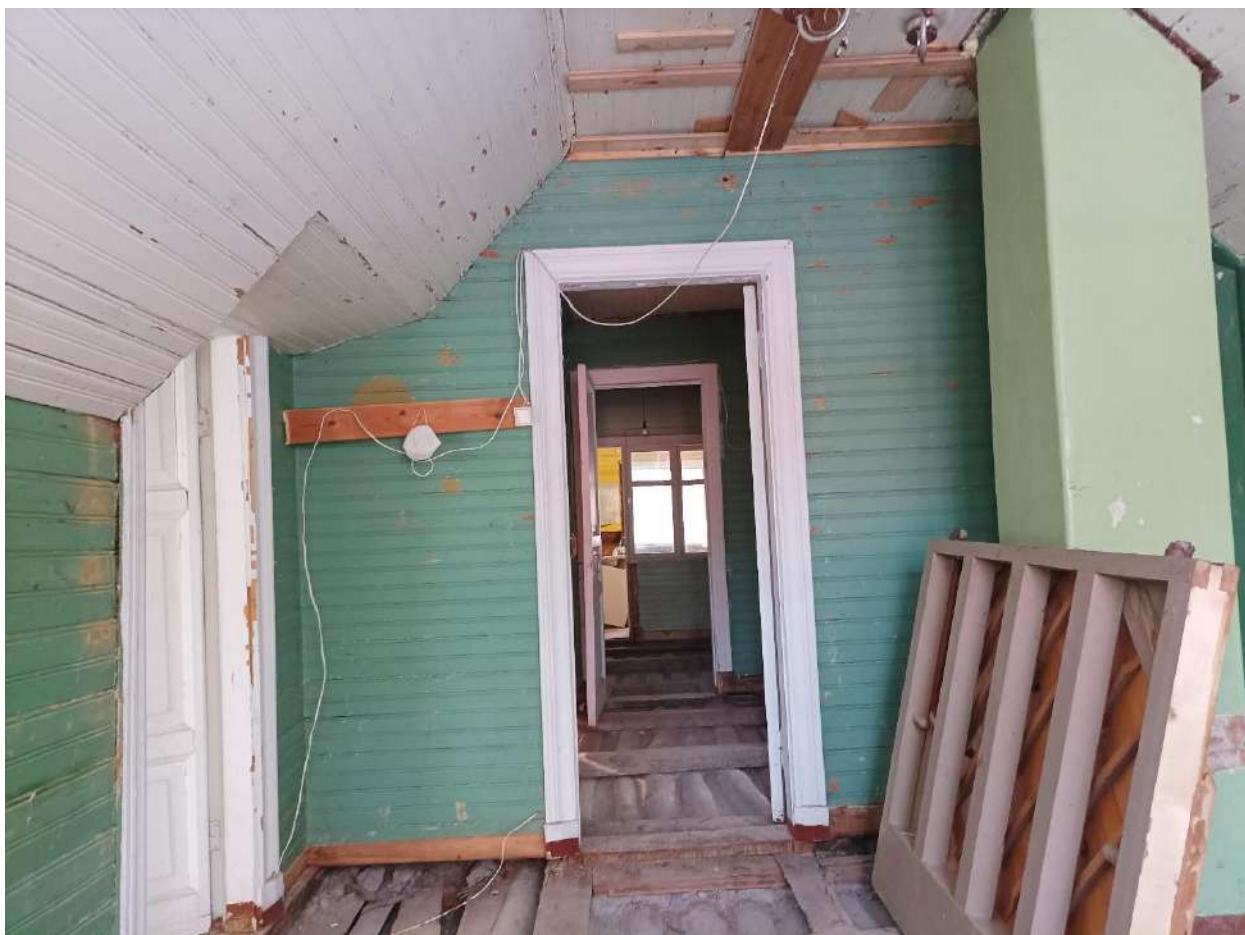
Фото 52. Объект культурного наследия регионального значения «Дача Е. Н. Макаровой (семьи академика А. Е. Фаворского)». Внутренние помещения мансарды.
