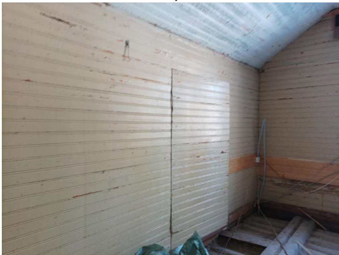
Фото 48. Объект культурного наследия регионального значения «Дача Е. Н. Макаровой (семьи академика А. Е. Фаворского)». Внутренние помещения мансарды.
