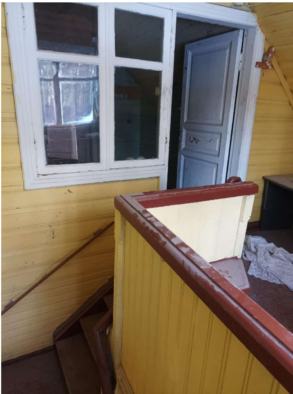
Фото 41. Объект культурного наследия регионального значения «Дача Е. Н. Макаровой (семьи академика А. Е. Фаворского)». Внутренние помещения мансарды.
