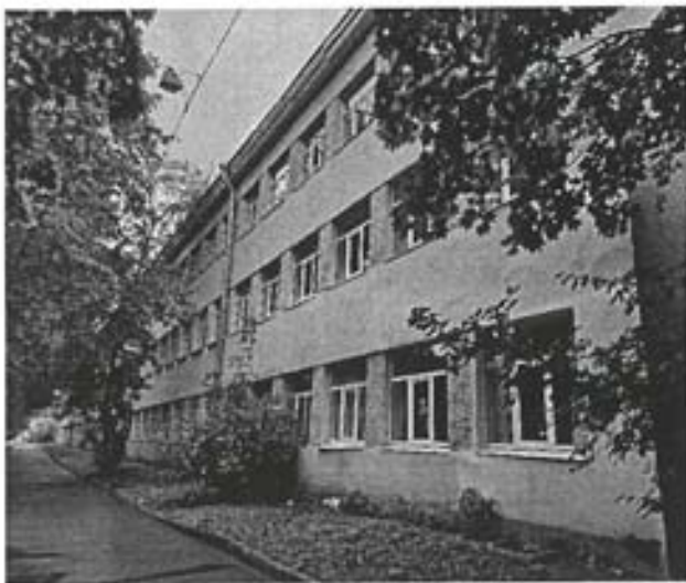
7. Фрагмент юго-западного фасада.
