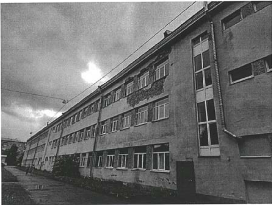
3. Общий вид северо-восточного фасада.
