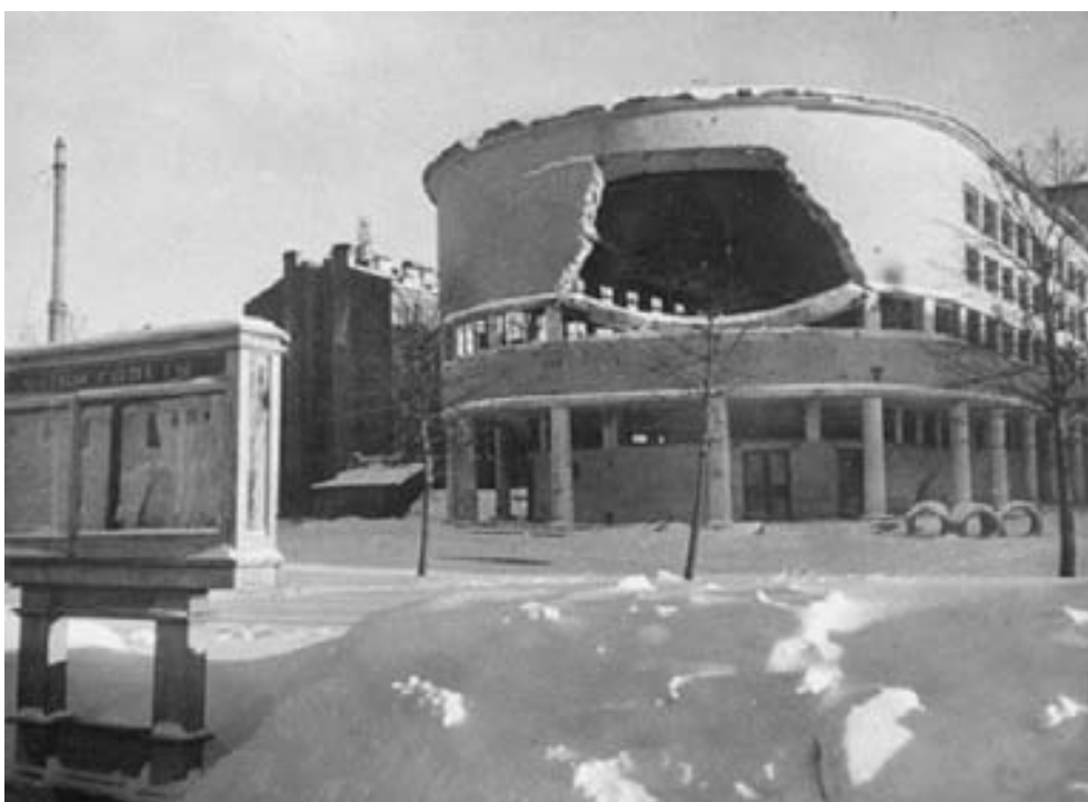
Илл. 24. ОКН «Здание Технической школы». Здание школы, 1942
