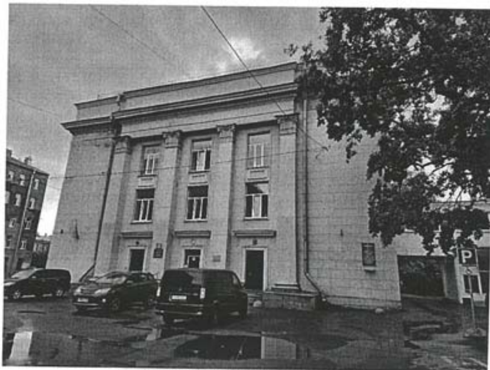
1. Общий вид на северо-западный фасад.
