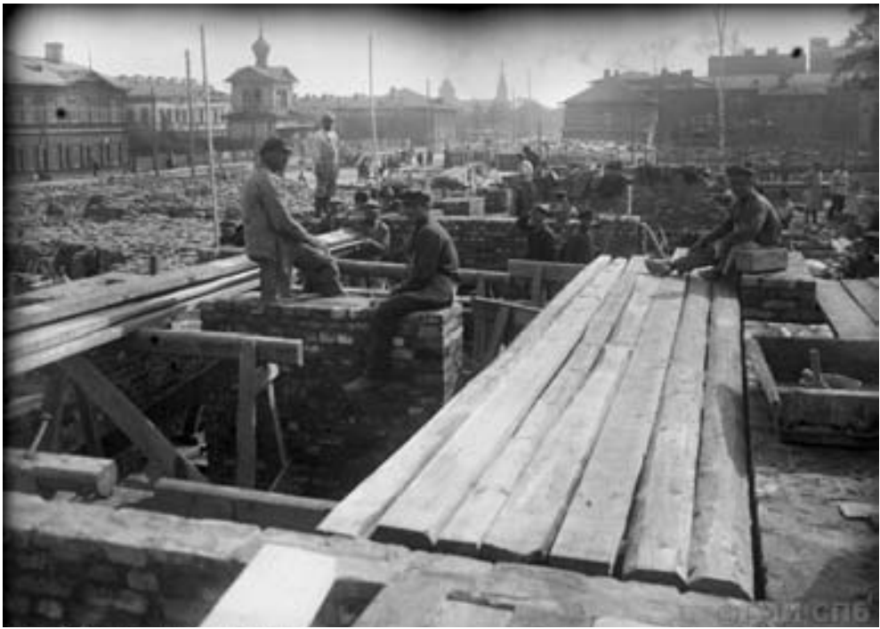
Илл. 1. ОКН «Серафимовский городок». Строительство Серафимовского участка, 1925.
