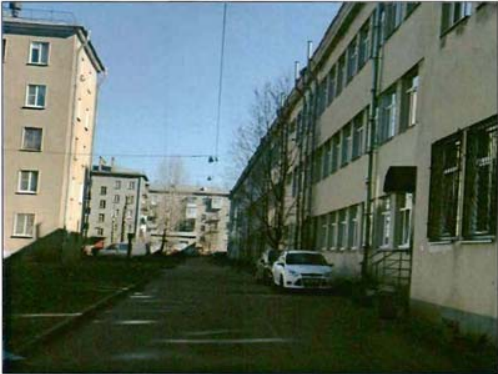
9. Фрагмент северного фасада основного объема здания.
