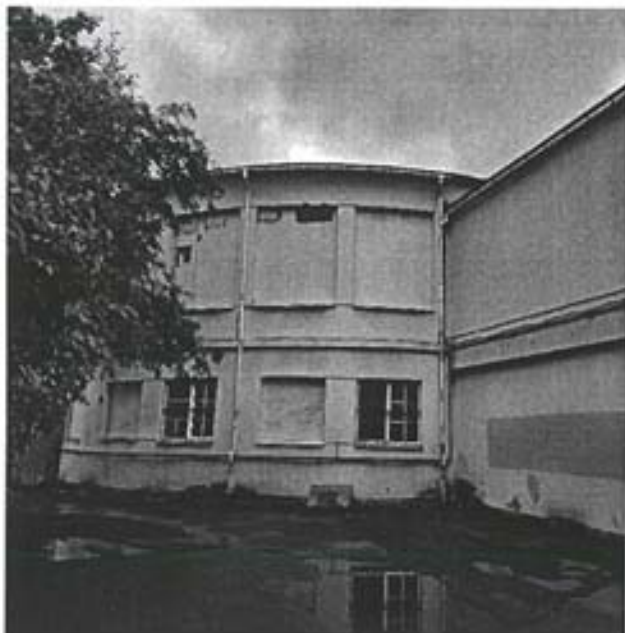
9. Фрагмент северо-западного фасада.
