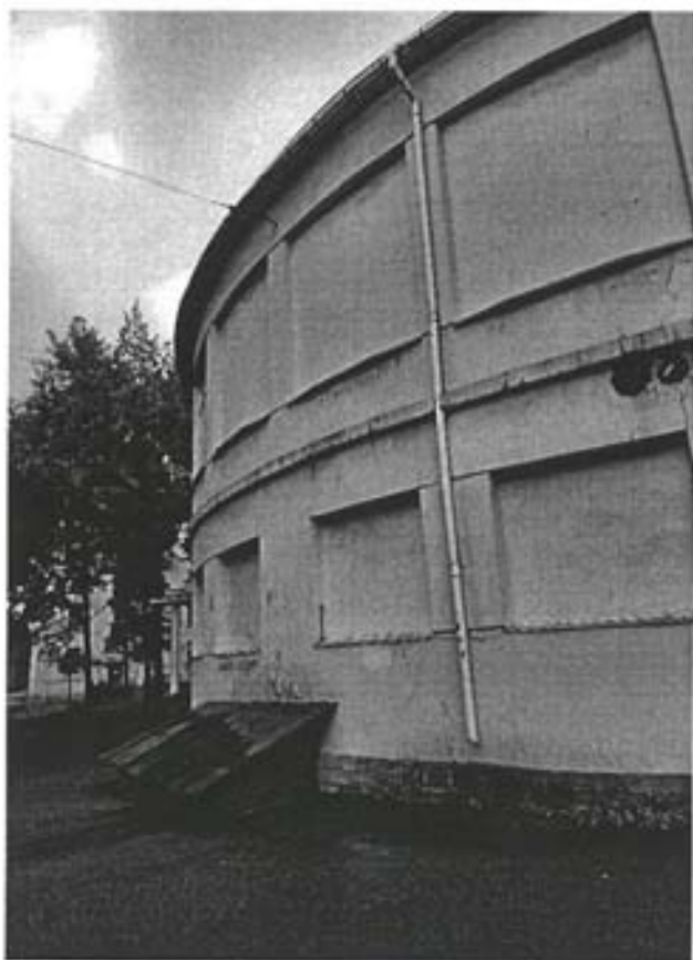
11. Фрагмент северо-западного фасада.
