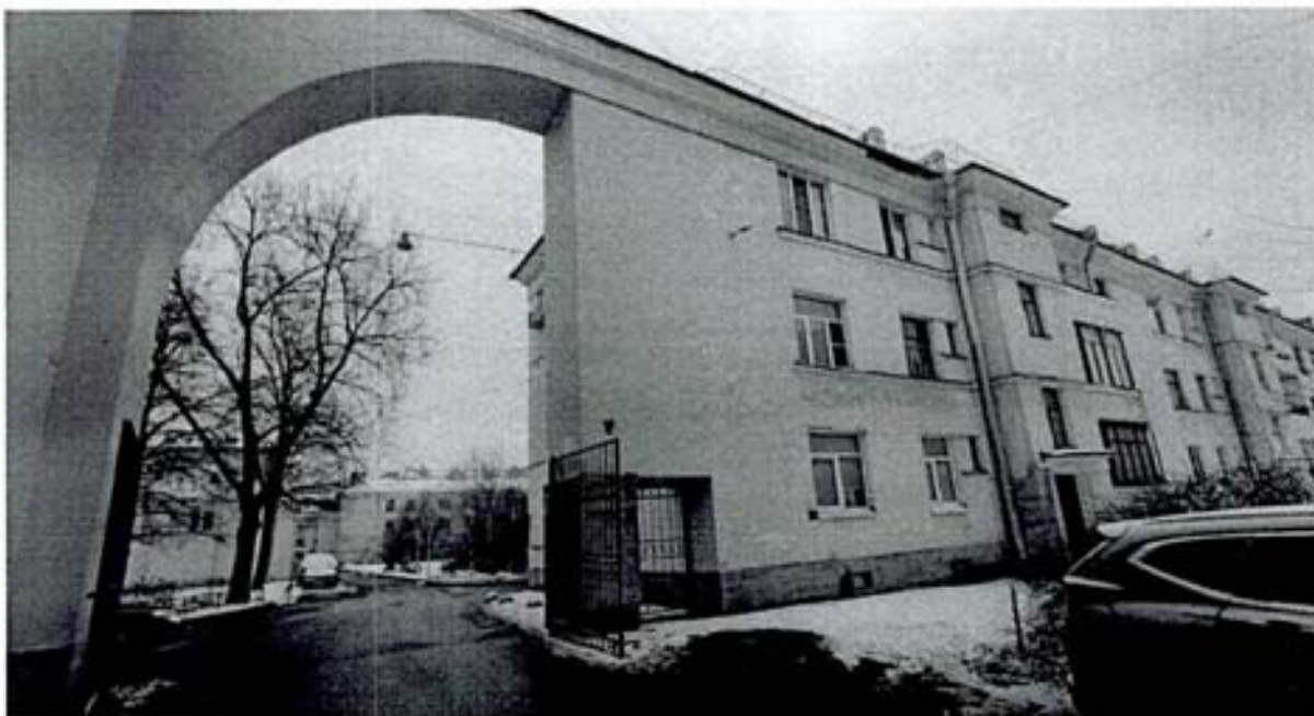
1. Общий вид главного фасада.
