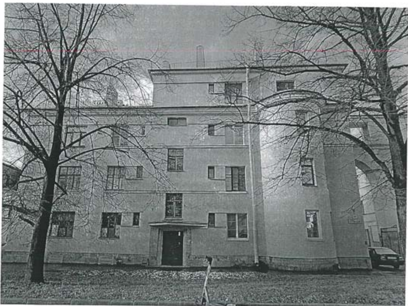
1. Общий вид лицевого юго-восточного фасада
