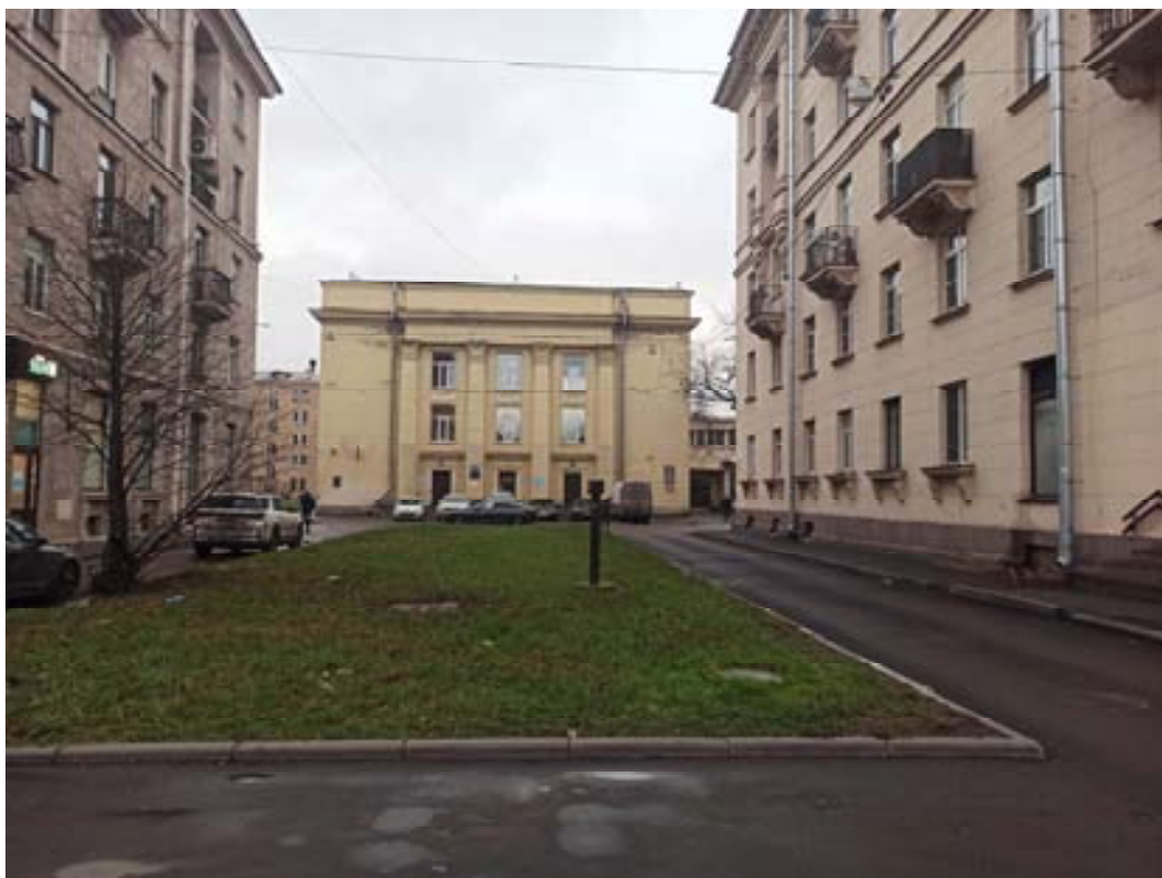
Фото 5. ОКН «Здание Технической школы» (Санкт-Петербург, Стачек пр., 30, лит. А). Вид на северо-западный фасад объекта культурного наследия.
