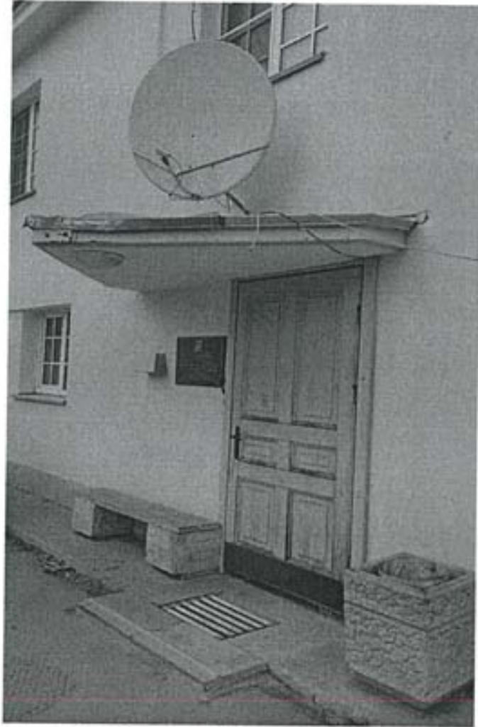
3. Фрагмент фасада. Входная зона.
