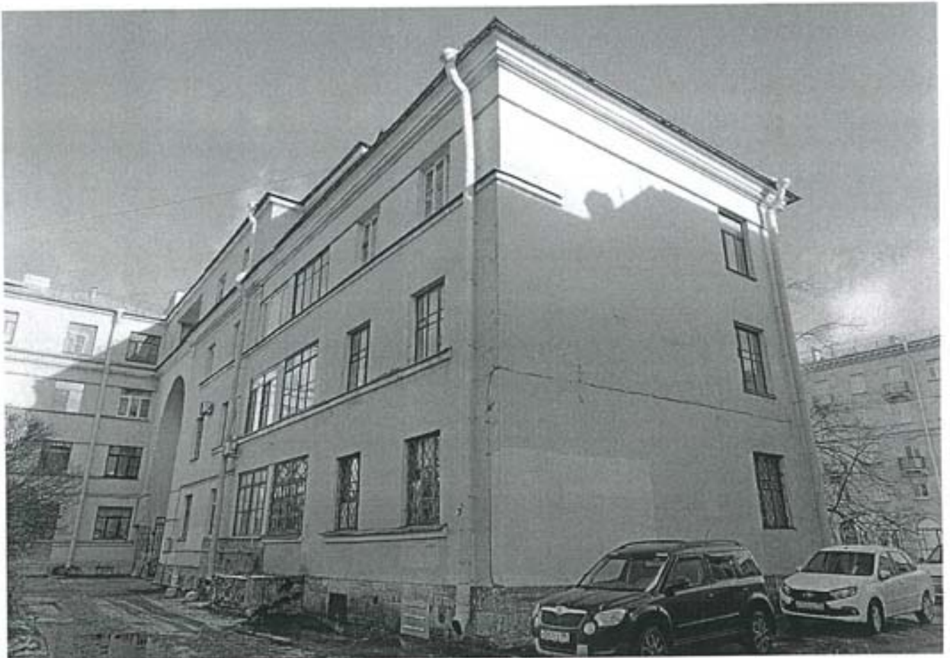
2. Общий вид северо-западного и юго-западного фасадов
