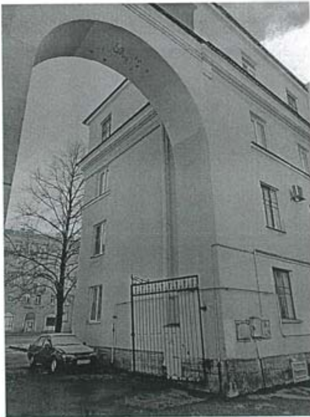
3. Арка, вид с западного фасада
