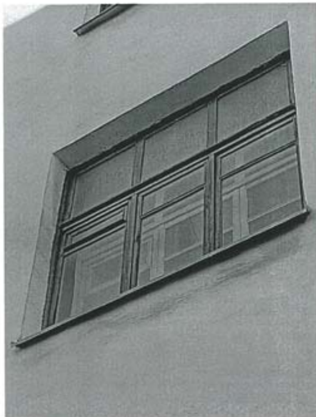
7. Деревянное оконное заполнение юго-западного фасада
