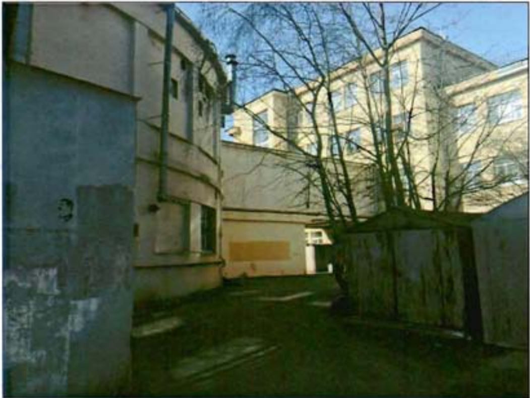
6. Вид на южный фасад.
