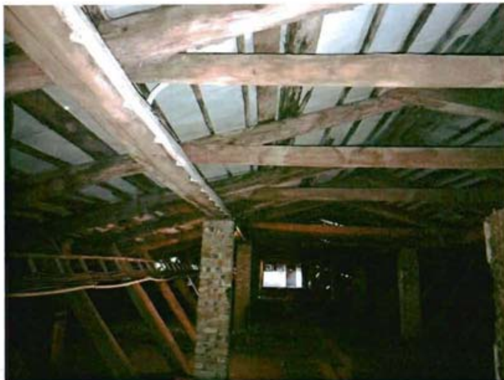
11. Стропильная система основного корпуса.
