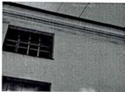
9. Фрагмент фасада, вид на карниз.
