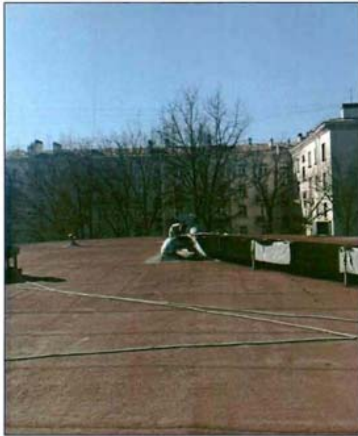
17. Фрагмент наплавляемой кровли цилиндрического объема здания.
