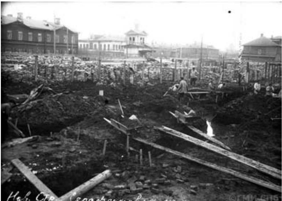
Илл. 2. ОКН «Серафимовский городок». Строительство Серафимовского участка, 1925.
