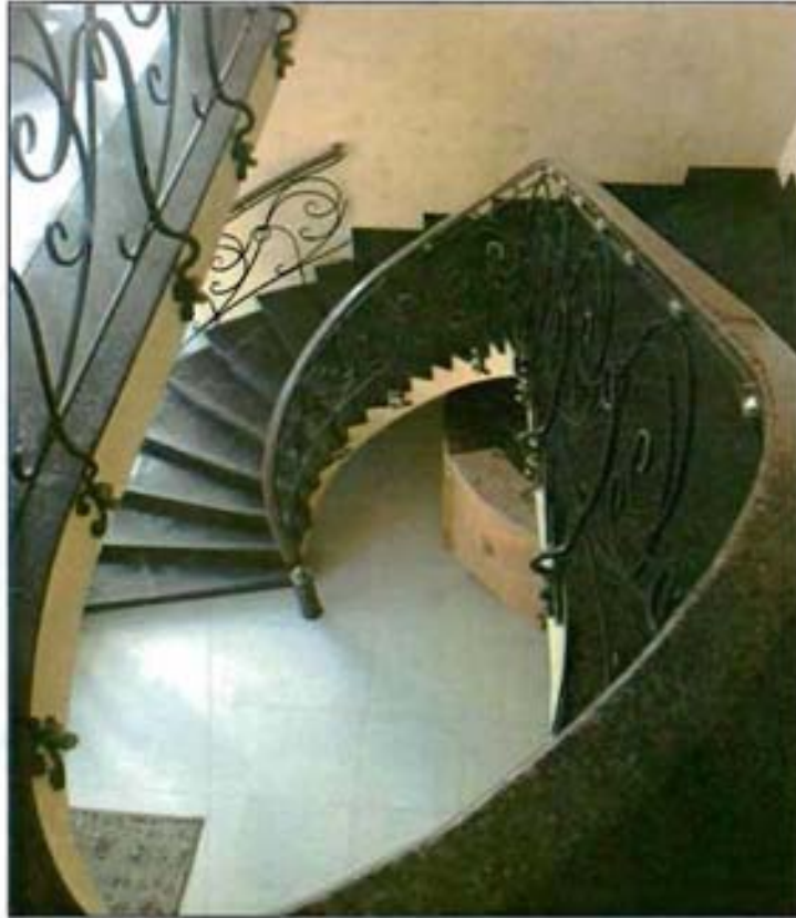
19. Северная лестница с забежными ступенями в цилиндрическом объеме здания.
