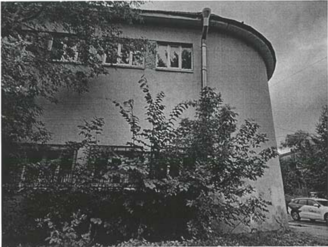
6. Фрагмент юго-западного фасада.
