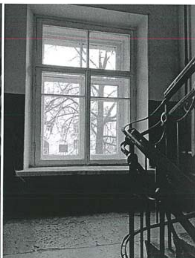
14. Оконное заполнение лестничного помещения
