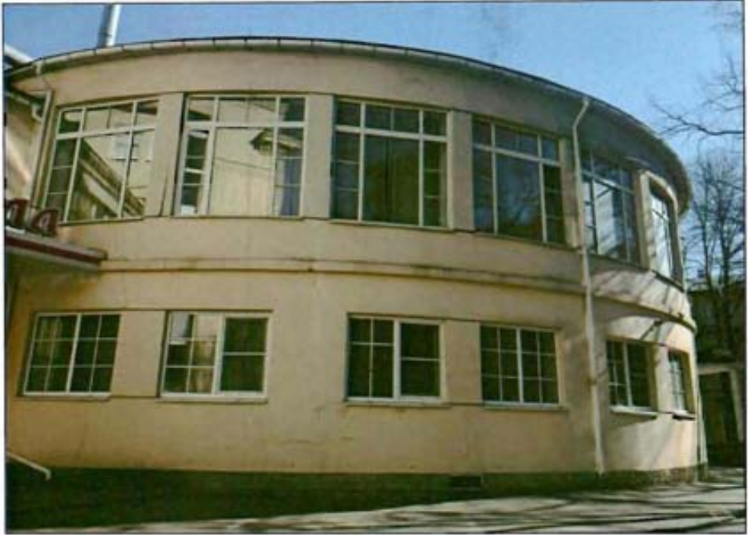
5. Вид на цилиндрический объем со стороны проспекта Стачек.
