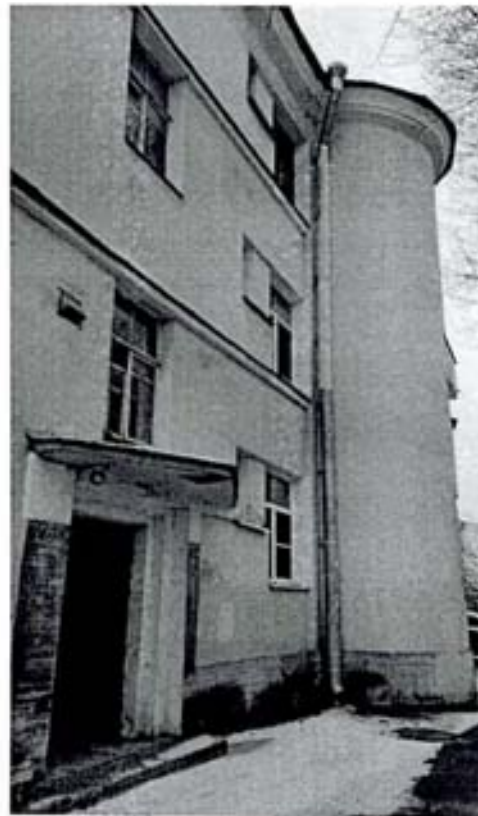
7. Фрагмент лицевого фасада с полуциркульным эркером.
