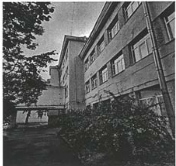
8. Фрагмент юго-западного фасада.
