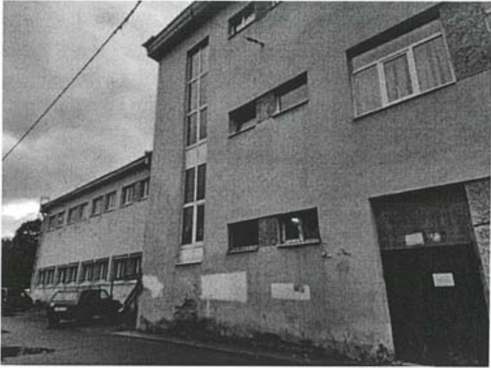
4. Фрагмент северо - восточного фасада.
