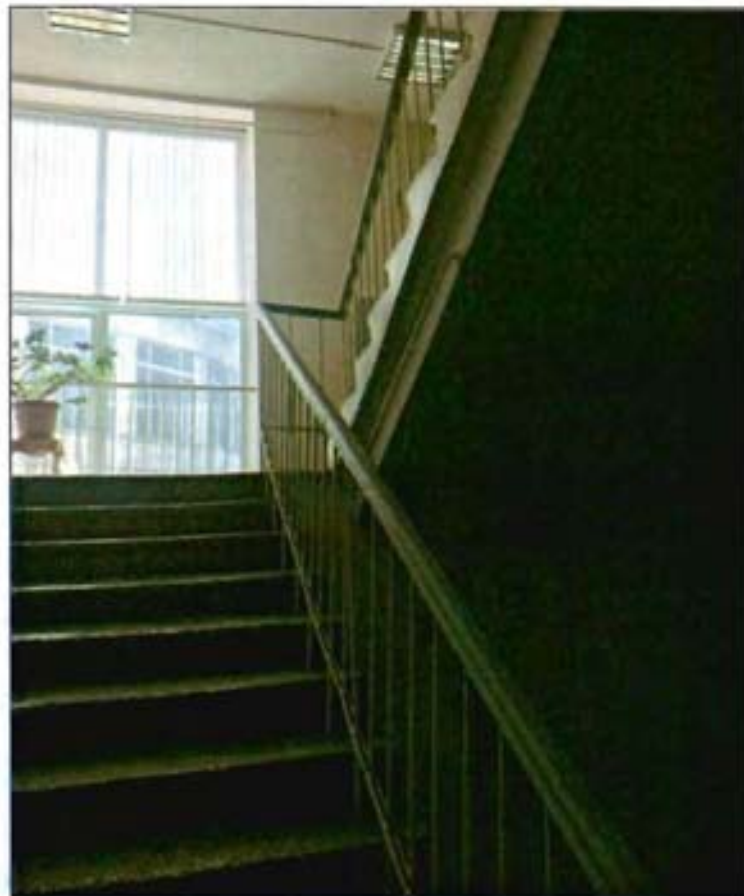
14. Парадная лестница ЗЛК в восточной части центрального объема основного корпуса.
