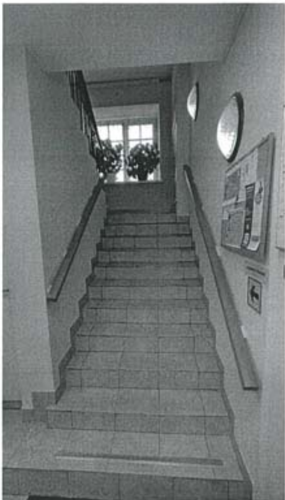
7. Фрагмент интерьера. Лестничная клетка.
