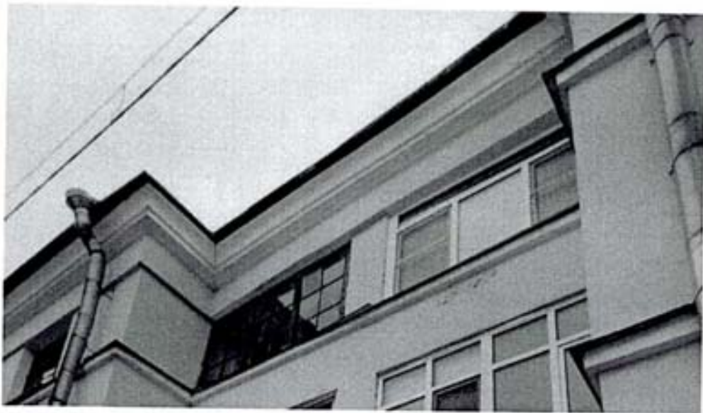
9. Фрагмент фасада, вид на карниз.
