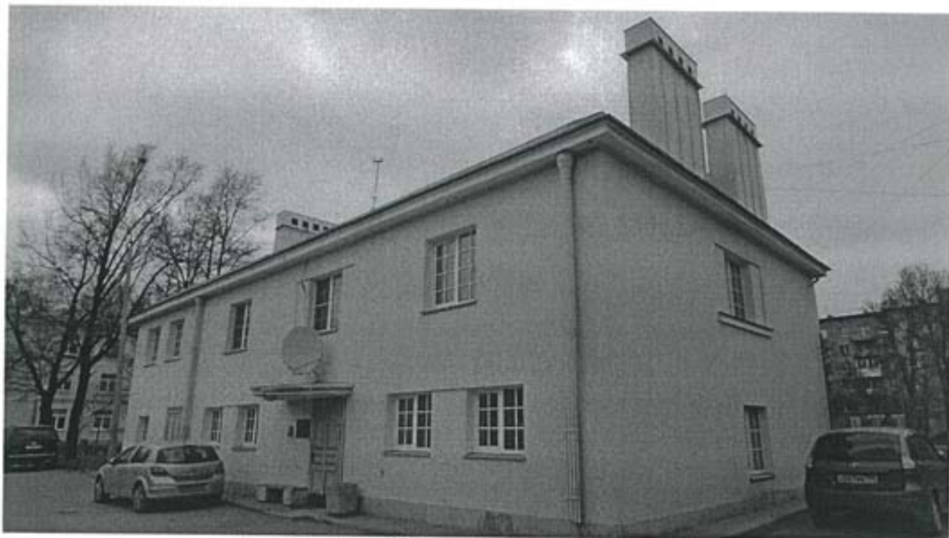
1. Общий вид Объекта (южный и западный фасады).
