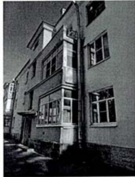
4, 5 Фрагменты фасада с остекленными балконами.
