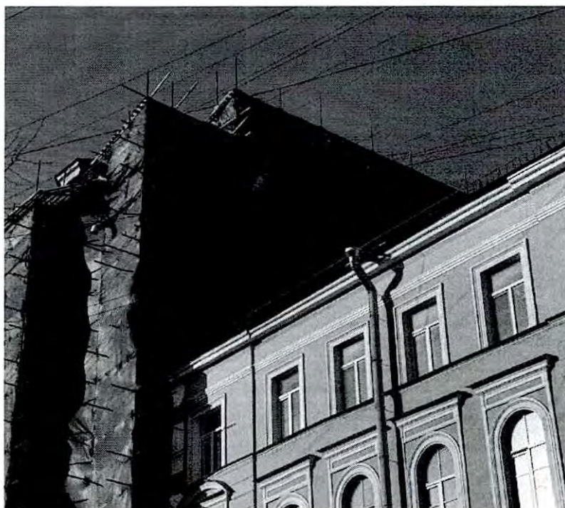
Общий вид фасада.
