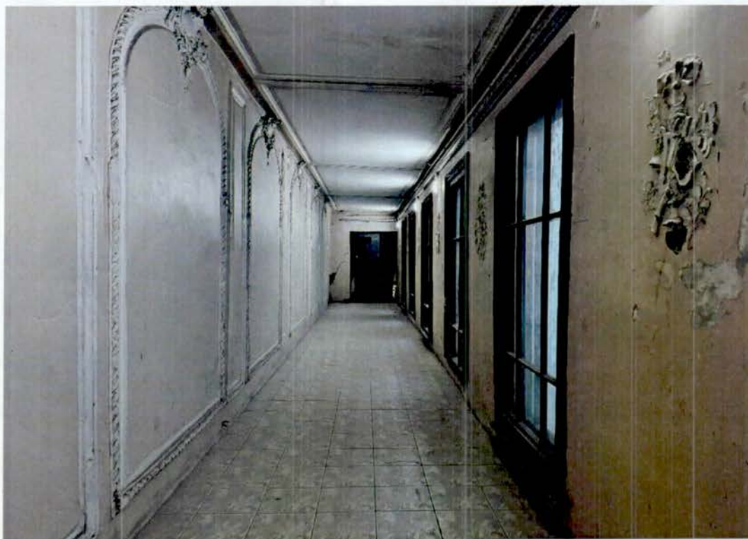
7. Помещение 2ЛК. Крытая галерея в уровне 2 этажа.
