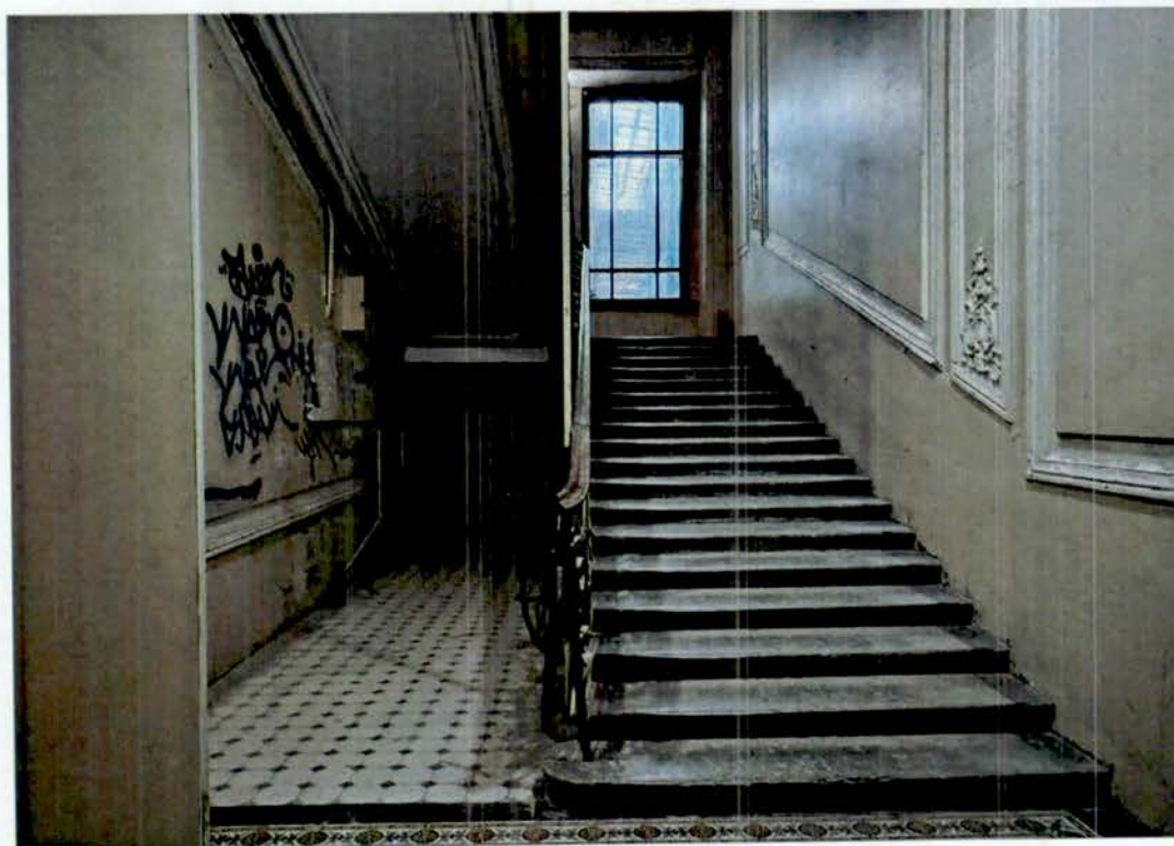
6. Межэтажная лестница 2ЛК.
