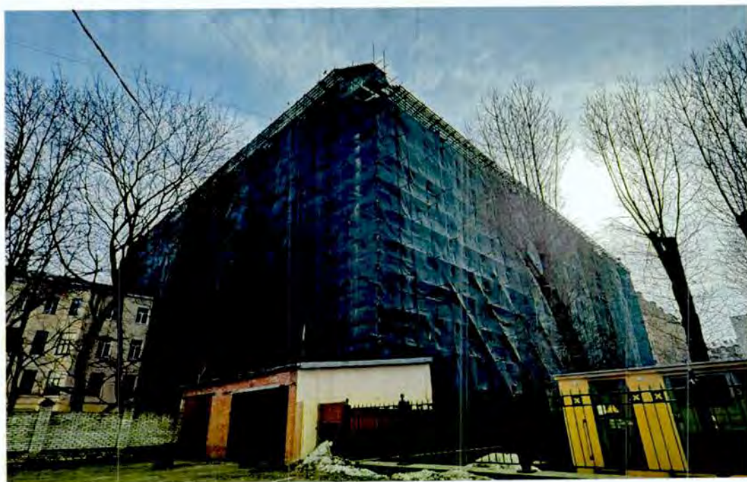
2. Общий вид на объект культурного наследия.
