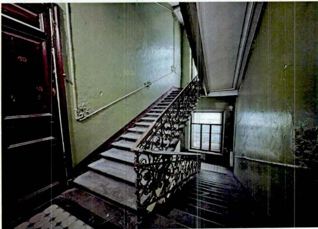
8. Межэтажная лестница 6ЛК.
