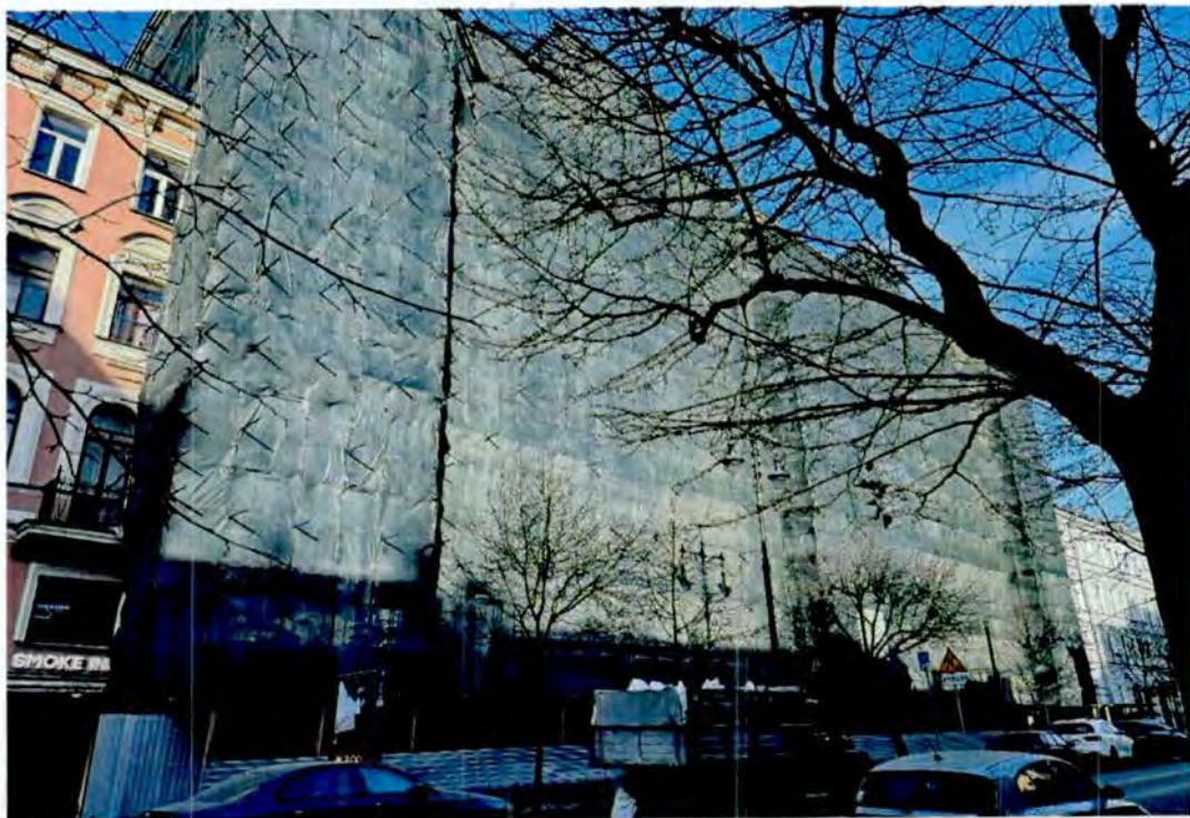
1. Общий вид на объект культурного наследия.
