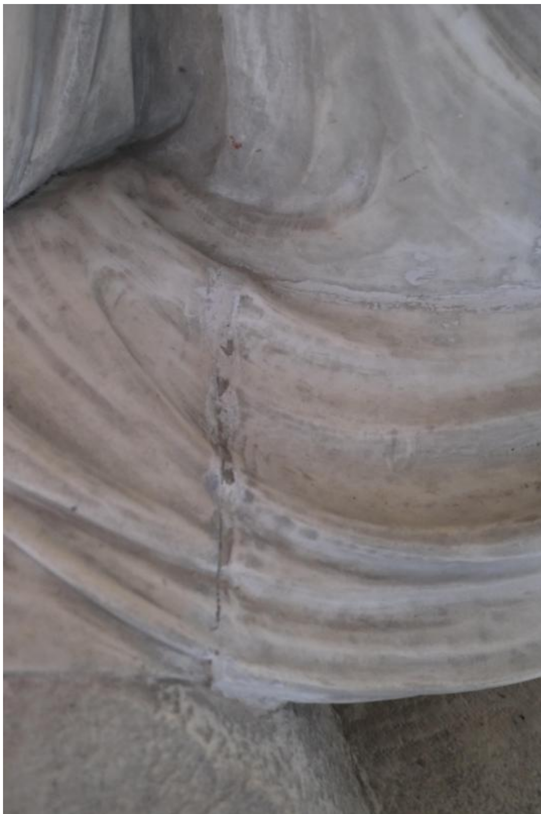
10. Объект культурного наследия федерального значения «Девушка с кувшином (постамент)». Фрагмент. 15.02.2026 г. Деталь: трещина постамента.
