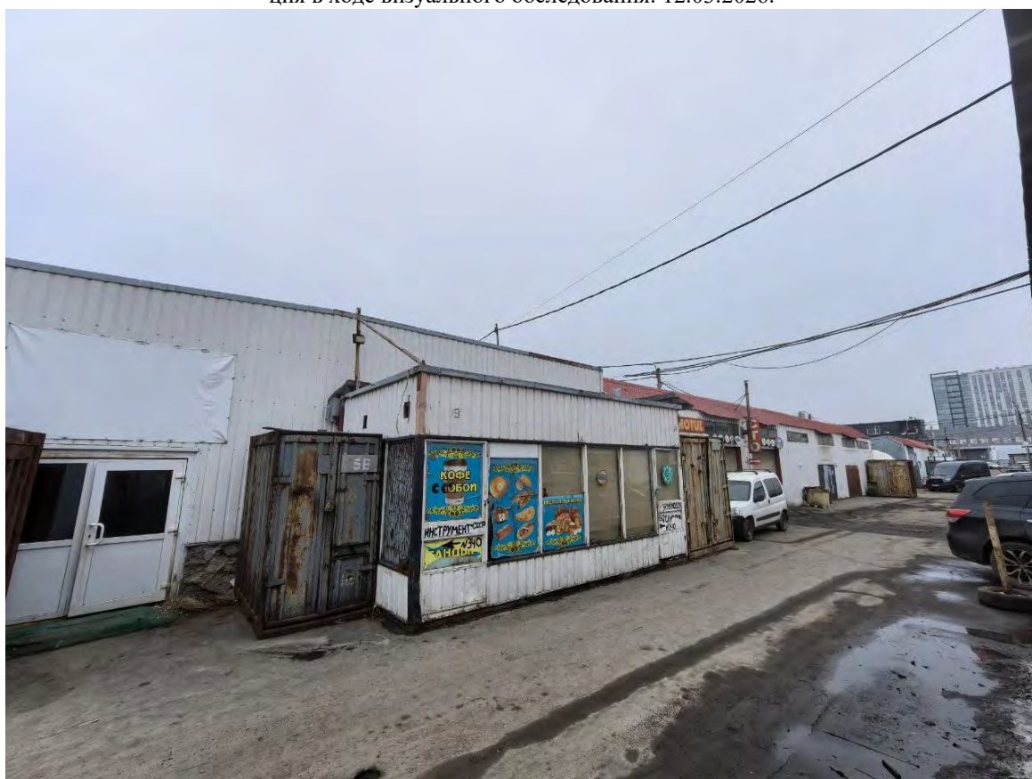
Рис. 30. Участок к/н 78:13:0007405:6155 по адресу г. Санкт-Петербург, улица Фучика, дом 21. Фотофиксация в ходе визуального обследования. 12.03.2026.
