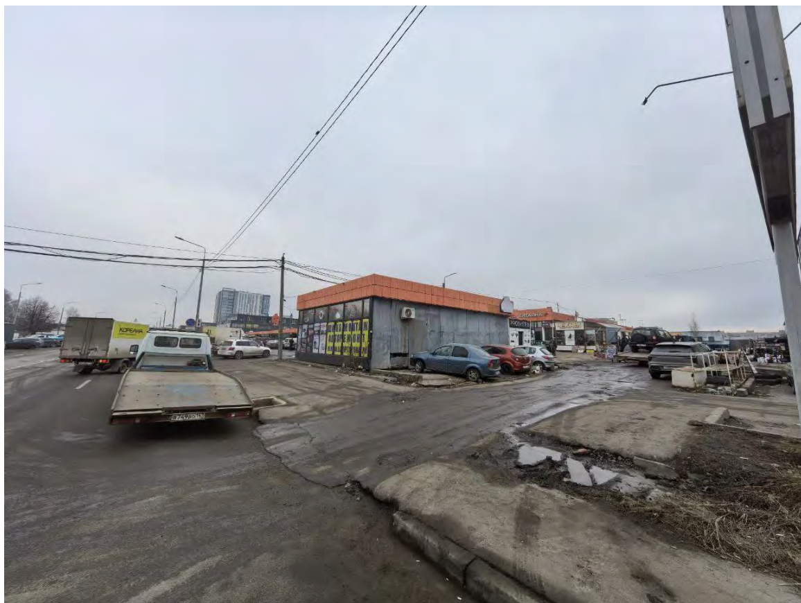
Рис. 29. Участок к/н 78:13:0007405:6155 по адресу г. Санкт-Петербург, улица Фучика, дом 21. Фотофиксация в ходе визуального обследования. 12.03.2026.
