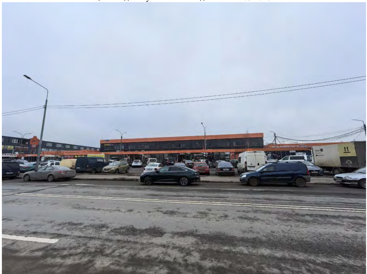
Рис. 36. Участок к/н 78:13:0007405:6155 по адресу г. Санкт-Петербург, улица Фучика, дом 21. Фотофиксация в ходе визуального обследования. 12.03.2026.
