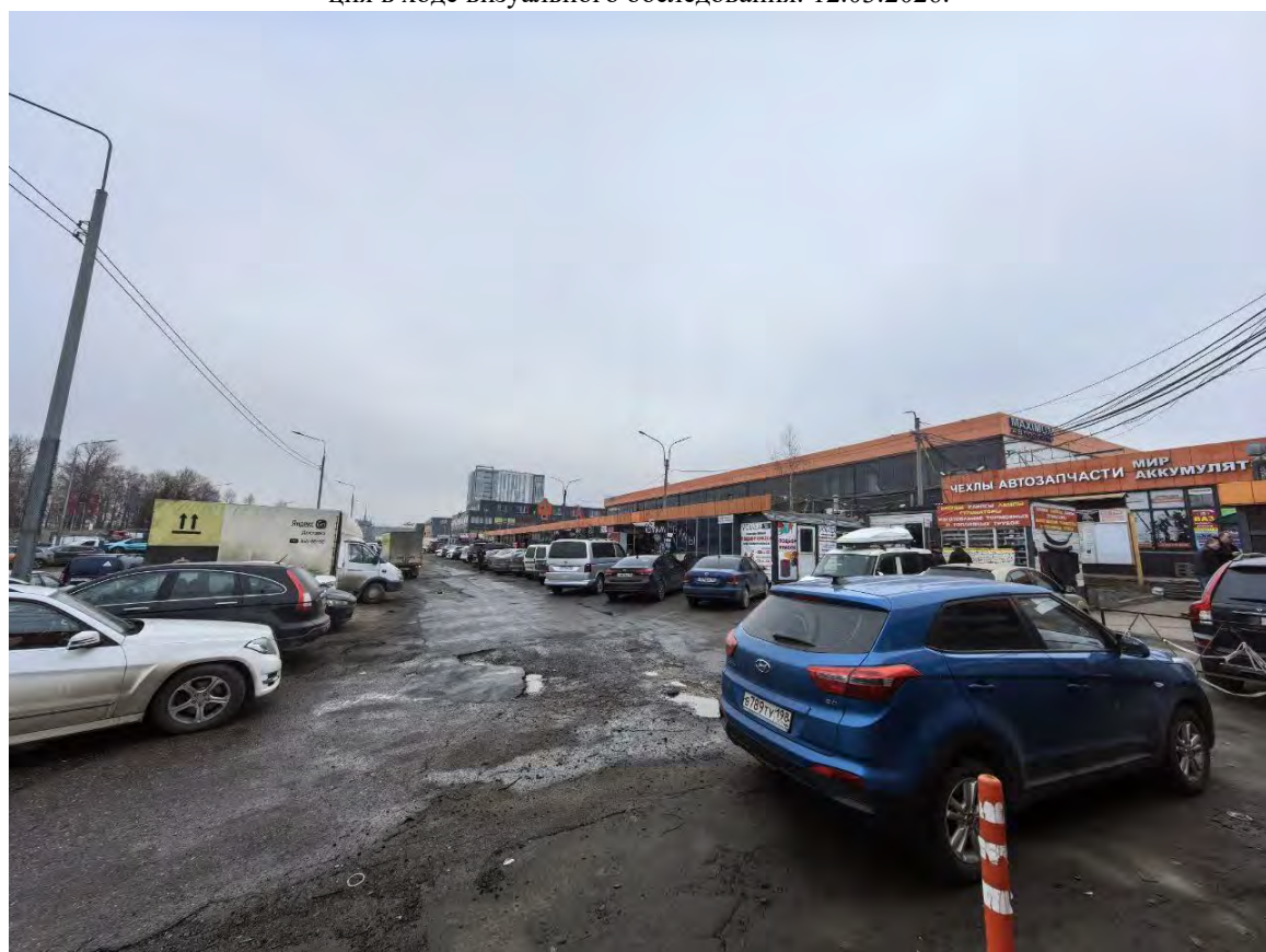
Рис. 34. Участок к/н 78:13:0007405:6155 по адресу г. Санкт-Петербург, улица Фучика, дом 21. Фотофиксация в ходе визуального обследования. 12.03.2026.
