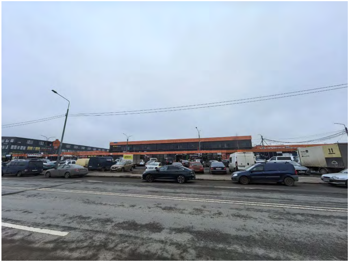
Рис. 37. Участок к/н 78:13:0007405:6155 по адресу г. Санкт-Петербург, улица Фучика, дом 21. Фотофиксация в ходе визуального обследования. 12.03.2026.
