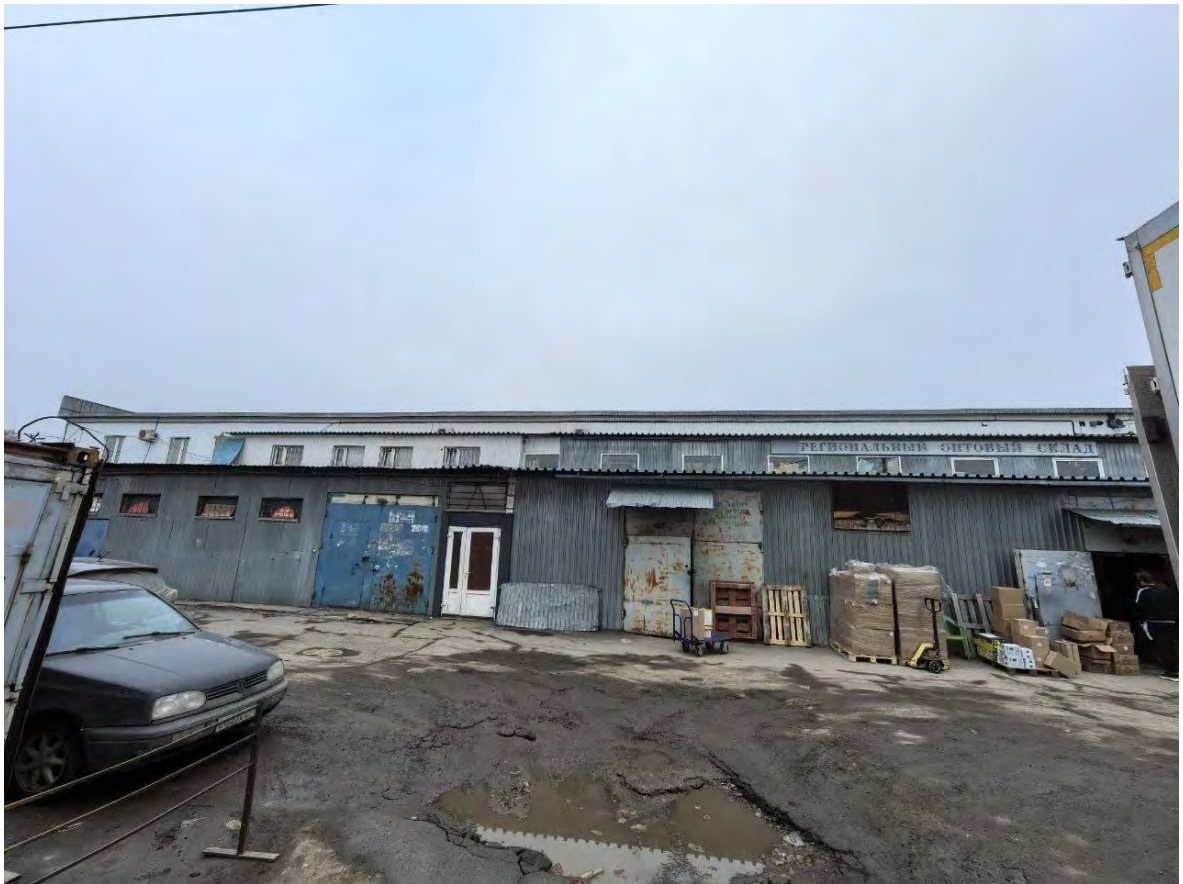
Рис. 35. Участок к/н 78:13:0007405:6155 по адресу г. Санкт-Петербург, улица Фучика, дом 21. Фотофиксация в ходе визуального обследования. 12.03.2026.
