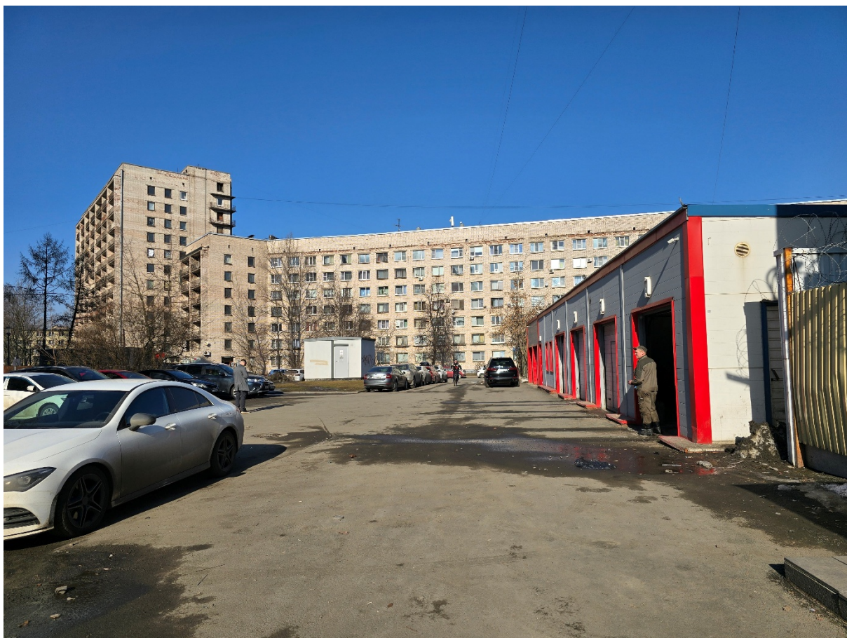
Фотофиксация 4. Вид с юга.
