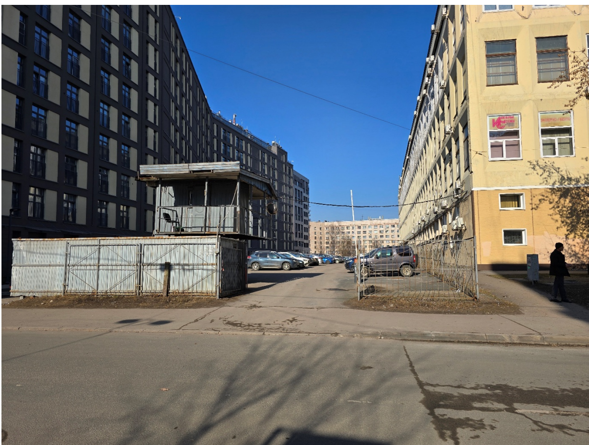
Фотофиксация 6. Вид с юга.
