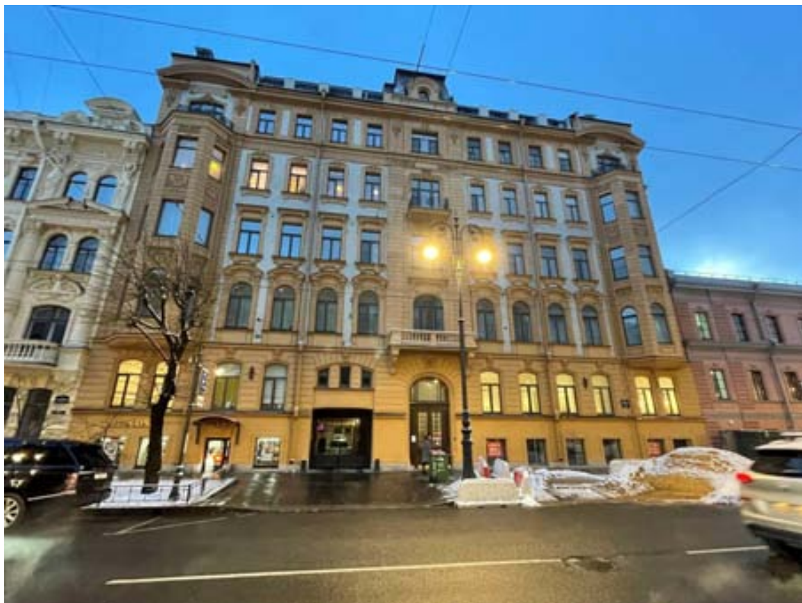
Фото 1. Лицевой фасад объекта культурного наследия регионального значения «Дом П.Г. Гулина»
