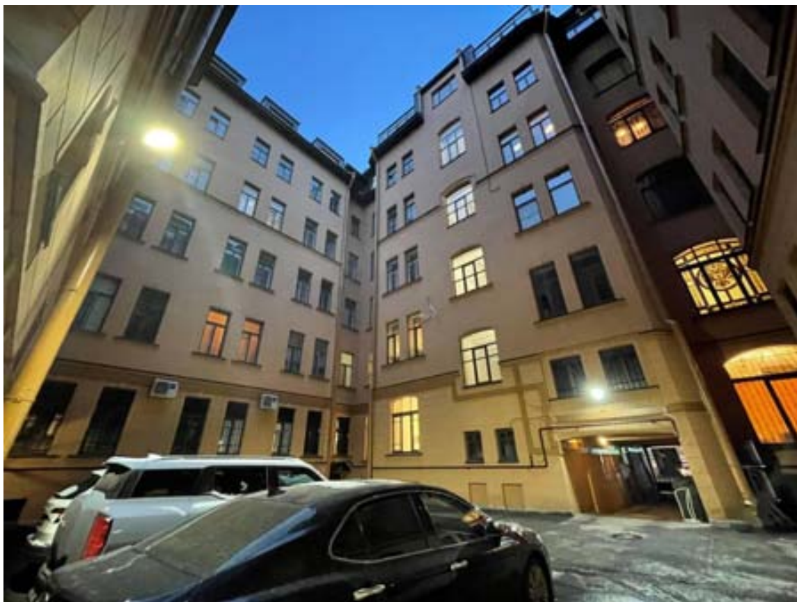
Фото 3. Фрагмент дворового фасада объекта культурного наследия регионального значения «Дом П.Г. Гулина»
