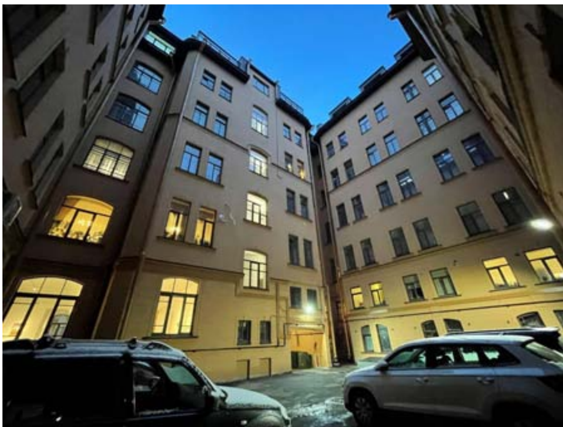
Фото 4. Фрагмент дворового фасада объекта культурного наследия регионального значения «Дом П.Г. Гулина»
