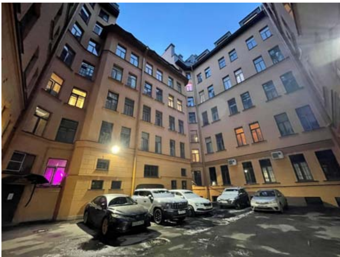
Фото 2. Фрагмент дворового фасада объекта культурного наследия регионального значения «Дом П.Г. Гулина»
