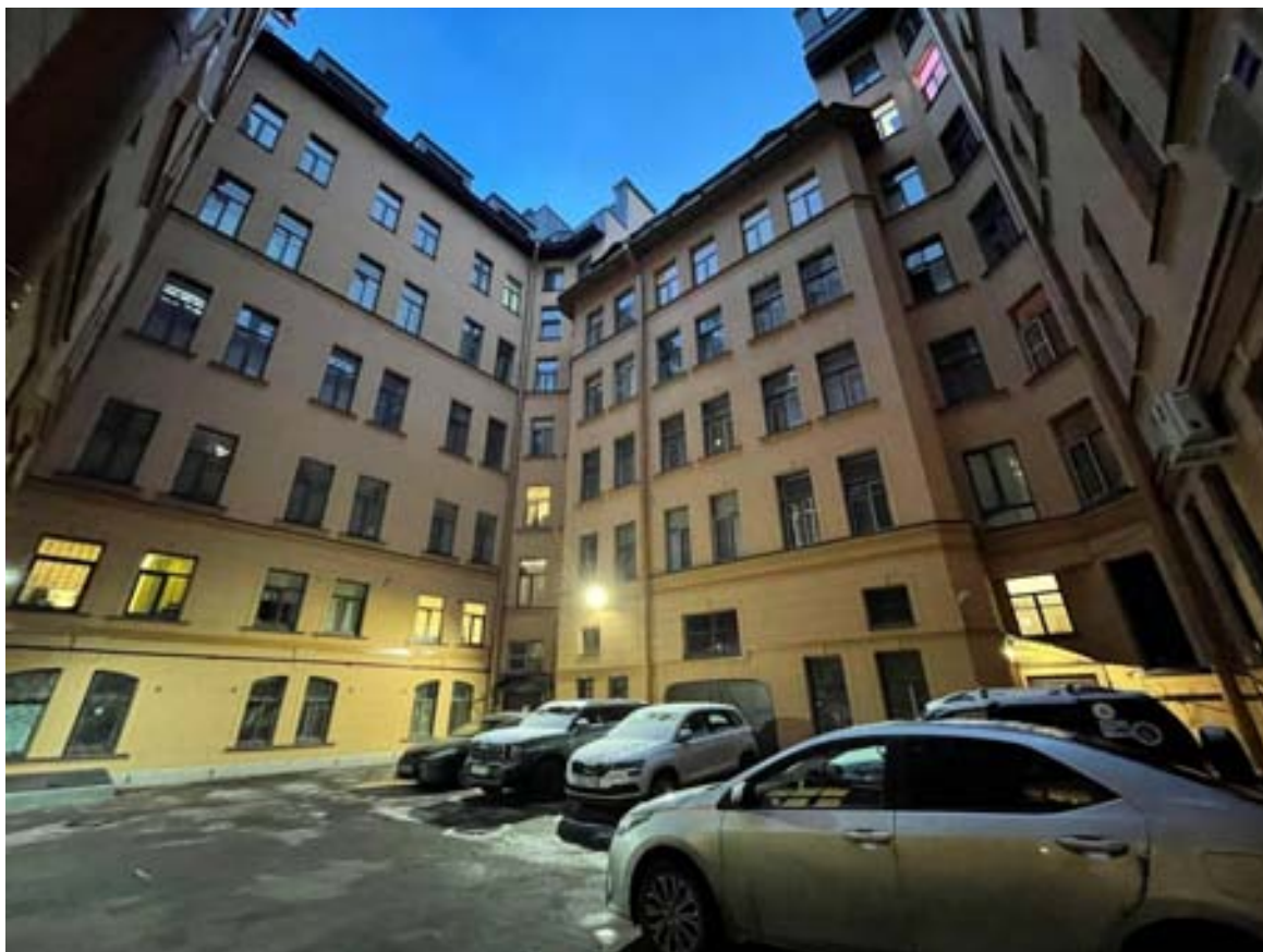
Фото 5. Фрагмент дворового фасада объекта культурного наследия регионального значения «Дом П.Г. Гулина»
