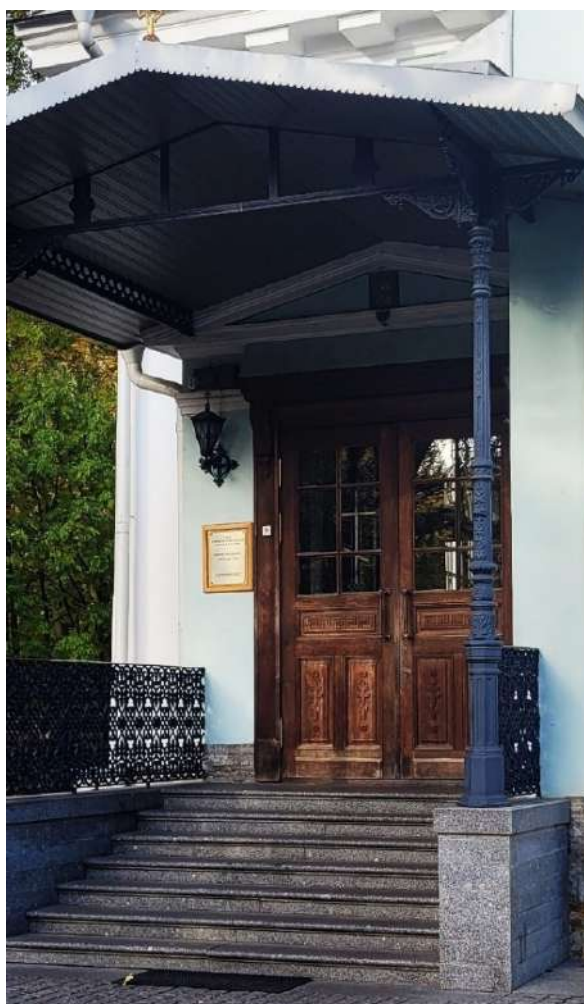
16. ОКНФЗ «Церковь Смоленская». Крыльцо входа в левой части южного фасада: историческая конфигурация дверного проема, двери входные дубовые филленчатые полусветные (исторический рисунок, материал). Дата съемки 19.10.2025г.
