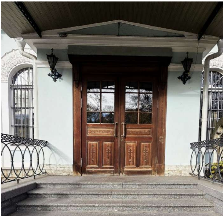
9. ОКНФЗ «Церковь Смоленская». Крыльцо в правой части южного фасада церкви: историческая конфигурация дверного проема, двери дубовые филенчатые полусветные (исторический рисунок, материал). Дата съемки 19.10.2025г.
