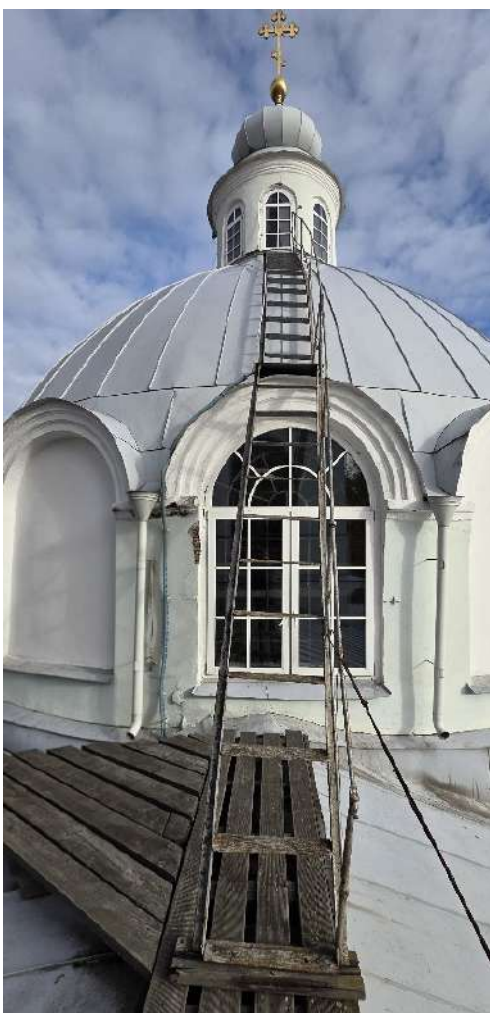
41. ОКНФЗ «Церковь Смоленская». Фрагмент купола церкви. Дата съемки 19.10.2025г.
