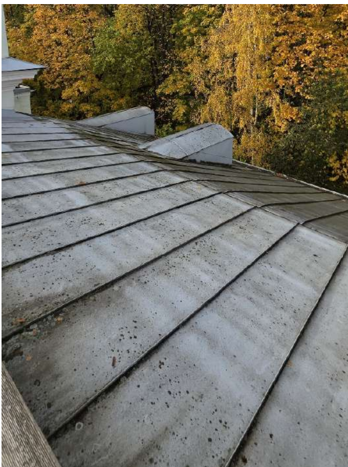
43. ОКНФЗ «Церковь Смоленская». Фрагмент скатной крыши церкви, материал покрытия – листовый металл. Дата съемки 19.10.2025г.
