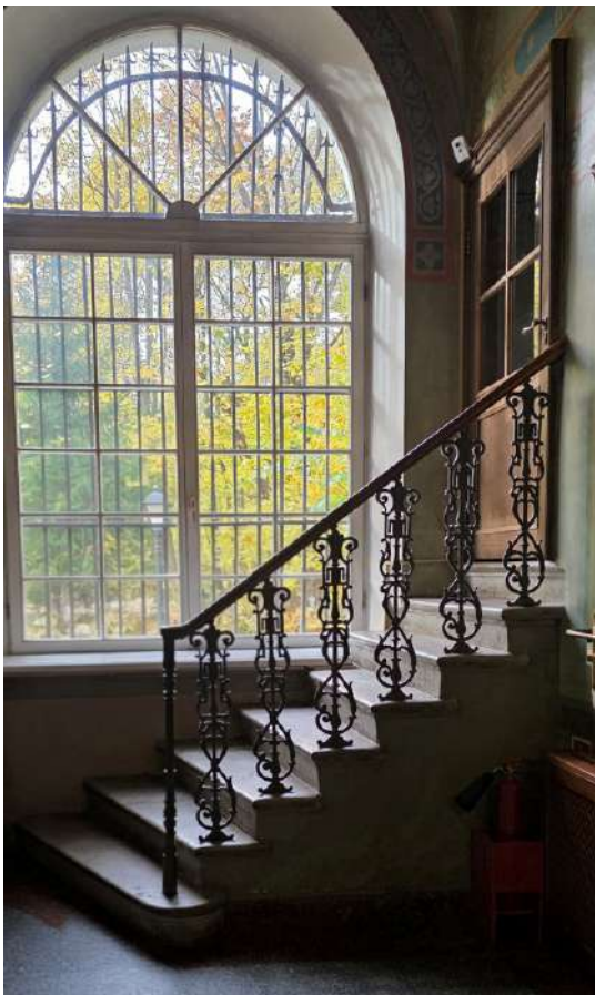
1. ОКНФЗ «Церковь Смоленская». Фрагмент конструктивной системы – ведущая в колокольню лестница с ограждением из литых орнаментированных стоек чугунного литья. Дата съемки 19.10.2025г.
