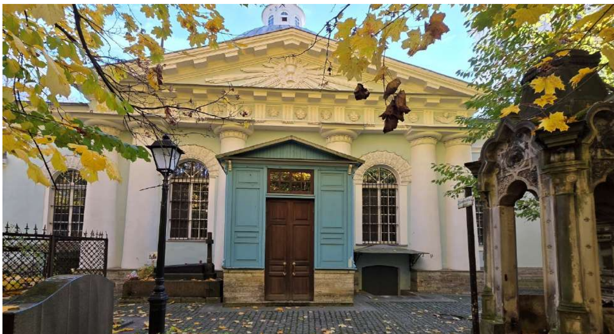
31. ОКНФЗ «Церковь Смоленская». Портик северного фасада церкви: колонны в \frac{3}{4} , завершенные треугольным фронтоном; лепной декор в тимпане фронтона портика; антаблемент с триглифами и розетками в метопах. Дата съемки 19.10.2025г.
