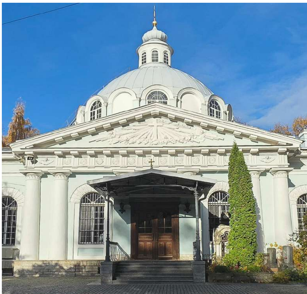
2. ОКНФЗ «Церковь Смоленская». Портик южного фасада церкви – колонны в \frac{3}{4} , завершенные треугольным фронтоном. Дата съемки 19.10.2025г.
