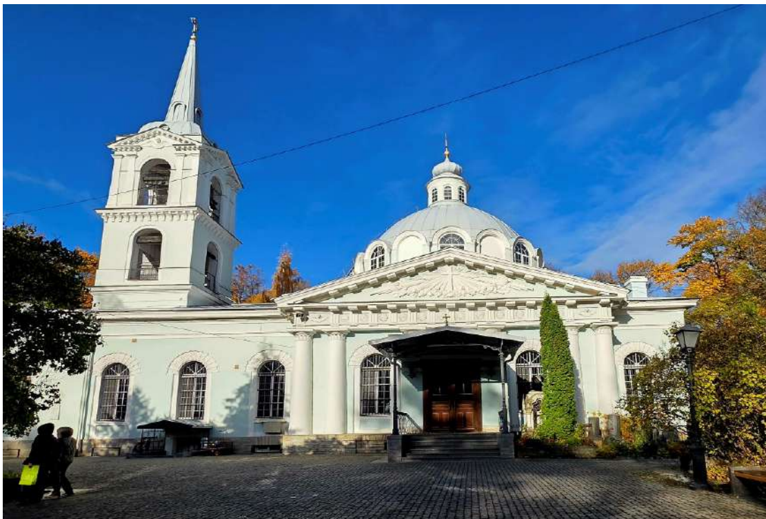
1. ОКНФЗ «Церковь Смоленская». Общий вид южного фасада церкви. Материал и характер отделки фасадов – окрашенная штукатурка. Дата съемки 19.10.2025г.
