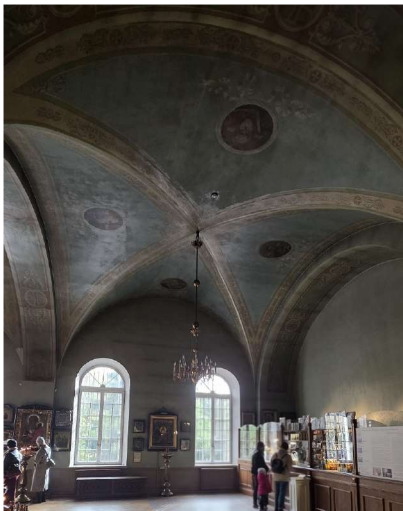
4. ОКНФЗ «Церковь Смоленская». Интерьеры церкви. Фрагмент конструктивной системы – сомкнутый кирпичный свод западного придела. Дата съемки 19.10.2025г.
