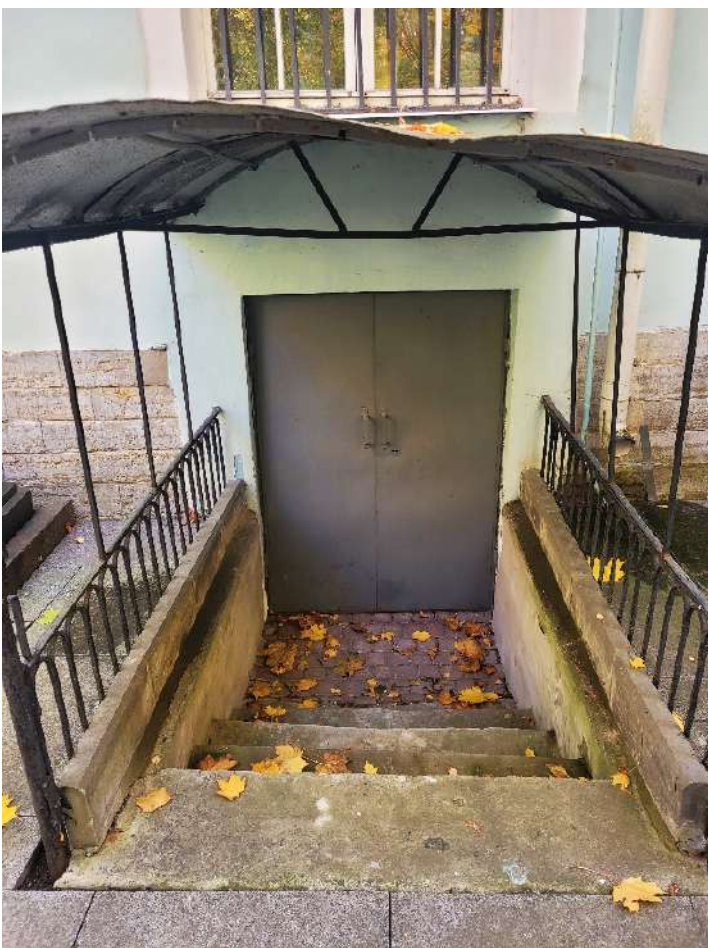
34. ОКНФЗ «Церковь Смоленская». Вход в подвал с восточной стороны северного фасада. Дата съемки 19.10.2025г.
