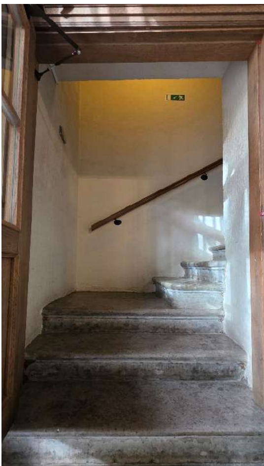
2. ОКНФЗ «Церковь Смоленская». Фрагмент лестницы, ведущей в колокольню, материал ступеней – известняк. Дата съемки 19.10.2025г.
