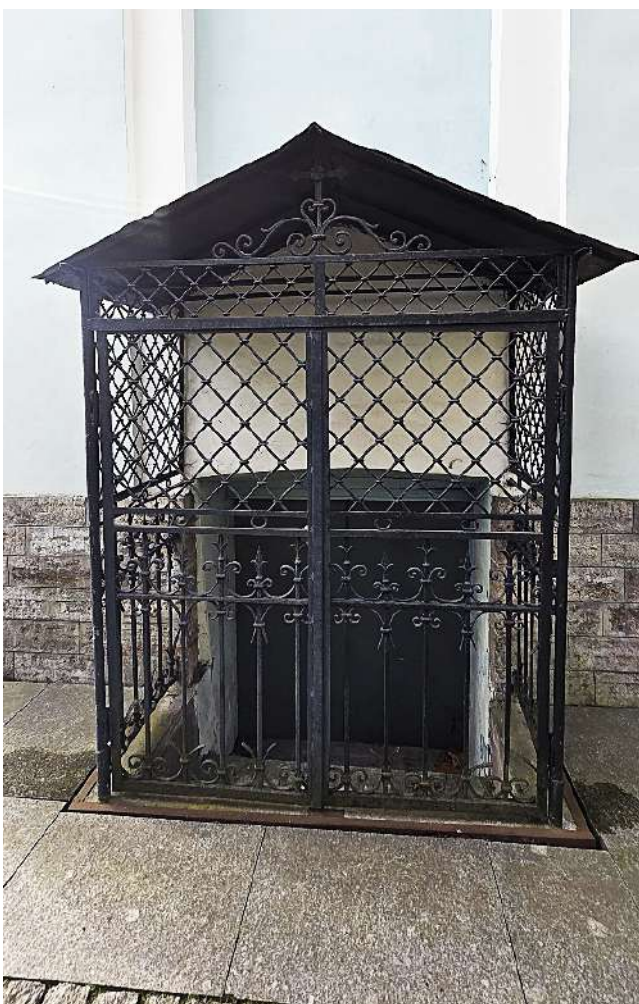
38. ОКНФЗ «Церковь Смоленская». Вход в подвал со стороны восточного фасада. Дата съемки 19.10.2025г.
