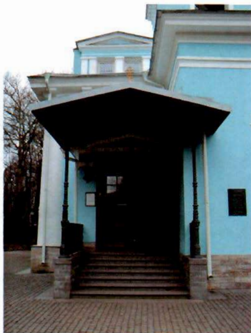
Фото 8. Крыльцо со стороны юго-восточного фасада.
