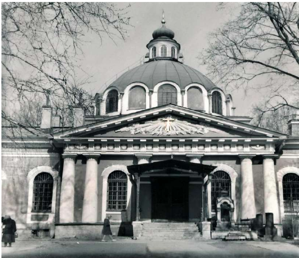
32. Вид южного фасада с главным входом церкви Смоленской иконы Божией Матери (архитектор А.А. Иванов, 1786–1790гг.). 1971г. ЦГАКФФД СПб. Оп. 1БР-57. Ед.хр. 73648.
