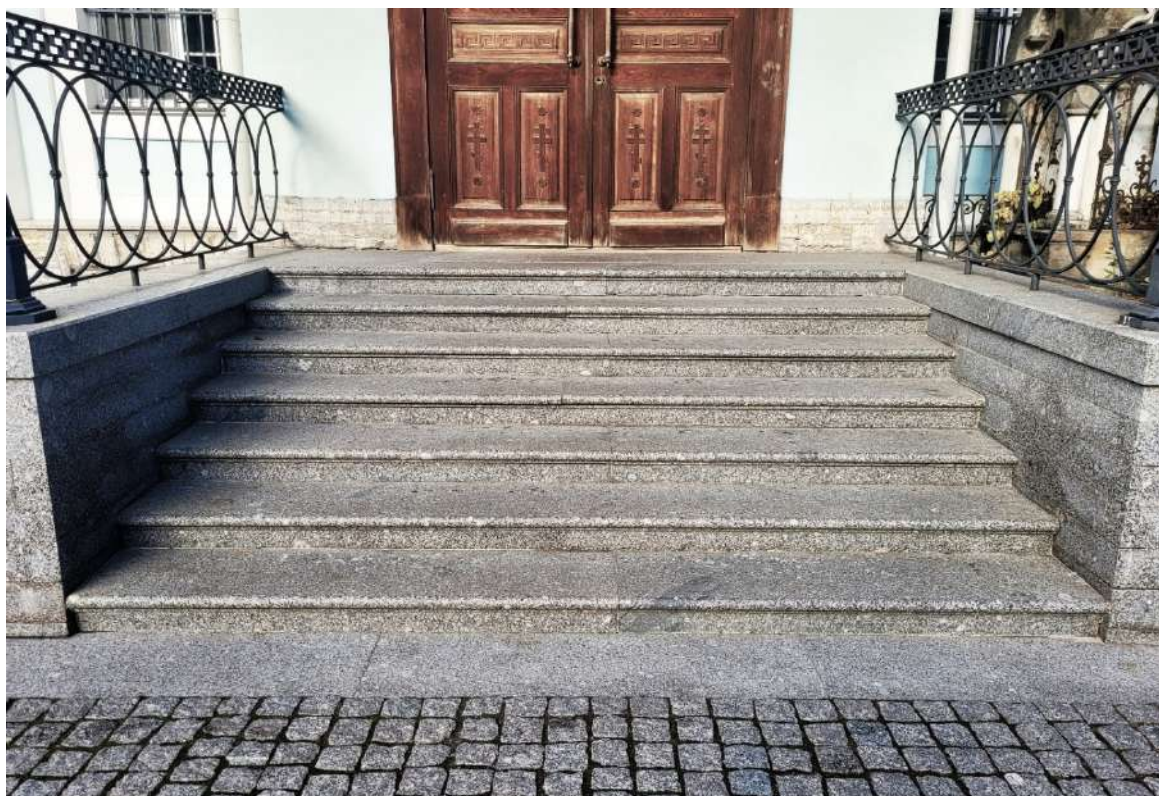
10. ОКНФЗ «Церковь Смоленская». Крыльцо входа в правой части южного фасада церкви. Дата съемки 19.10.2025г.
