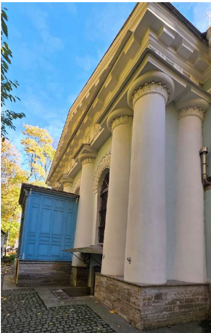
29. ОКНФЗ «Церковь Смоленская». Вид на портик северного фасада с северо-запада. Дата съемки 19.10.2025г.
