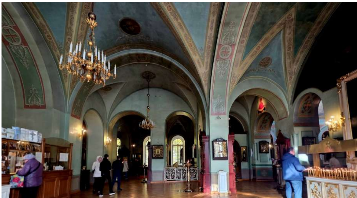
3. ОКНФЗ «Церковь Смоленская». Интерьеры церкви. Фрагмент конструктивной системы – пилоны, поддерживающие арочные перекрытия в подкупольном пространстве. Дата съемки 19.10.2025г.
