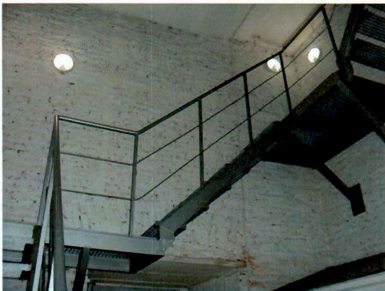
Фото 10. Лестница, ведущая на колокольню.
