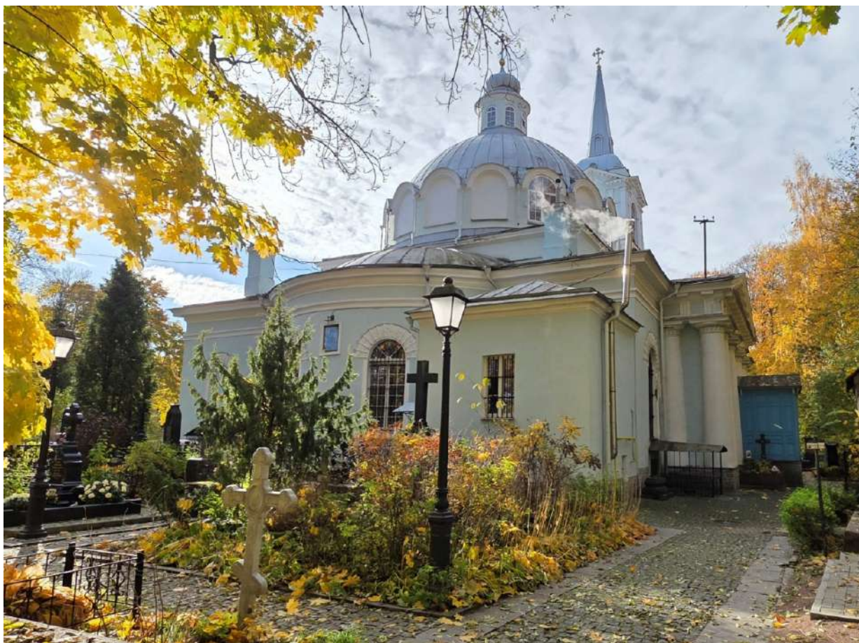
35. ОКНФЗ «Церковь Смоленская». Общий вид церкви с северо-востока: материал и характер отделки фасадов – окрашенная штукатурка. Дата съемки 19.10.2025г.
