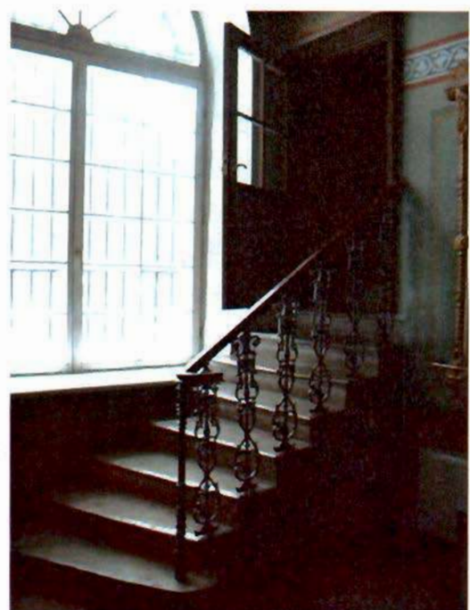
Фото 9. Лестница, ведущая на колокольню.
