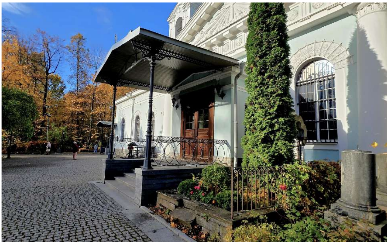
7. ОКНФЗ «Церковь Смоленская». Крыльцо в правой части южного фасада здания: металлический орнаментированный козырек чугунного литья на двух литых столбах, орнаментированное литое ограждение. Дата съемки 19.10.2025г.
