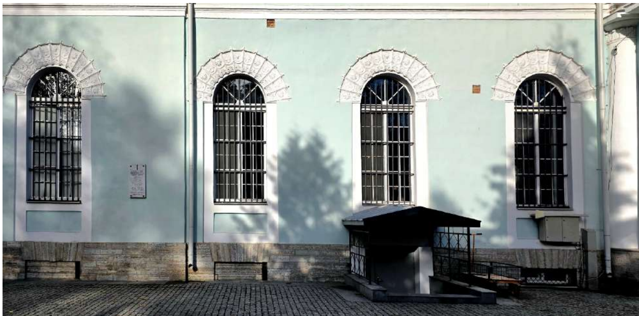
11. ОКНФЗ «Церковь Смоленская». Центральная часть южного фасада: цоколь, облицованный известняковой скобой; историческая конфигурация и габариты оконных проемов; кованные металлические решетки на окнах 1-го этажа. Дата съемки 19.10.2025г.
