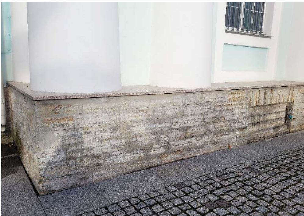
13. ОКНФЗ «Церковь Смоленская». Фрагмент цоколя южного фасада: облицовка цоколя известняковой скобой. Дата съемки 19.10.2025г.
