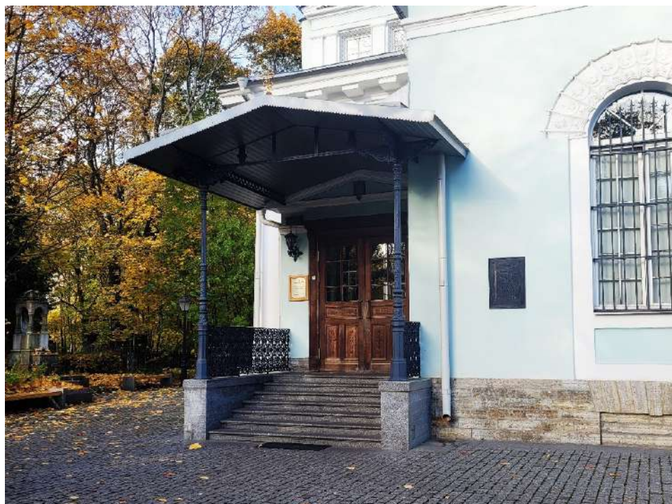
15. ОКНФЗ «Церковь Смоленская». Крыльцо входа в левой части южного фасада: металлический орнаментированный козырек чугунного литья на двух литых столбах. Дата съемки 19.10.2025г.
