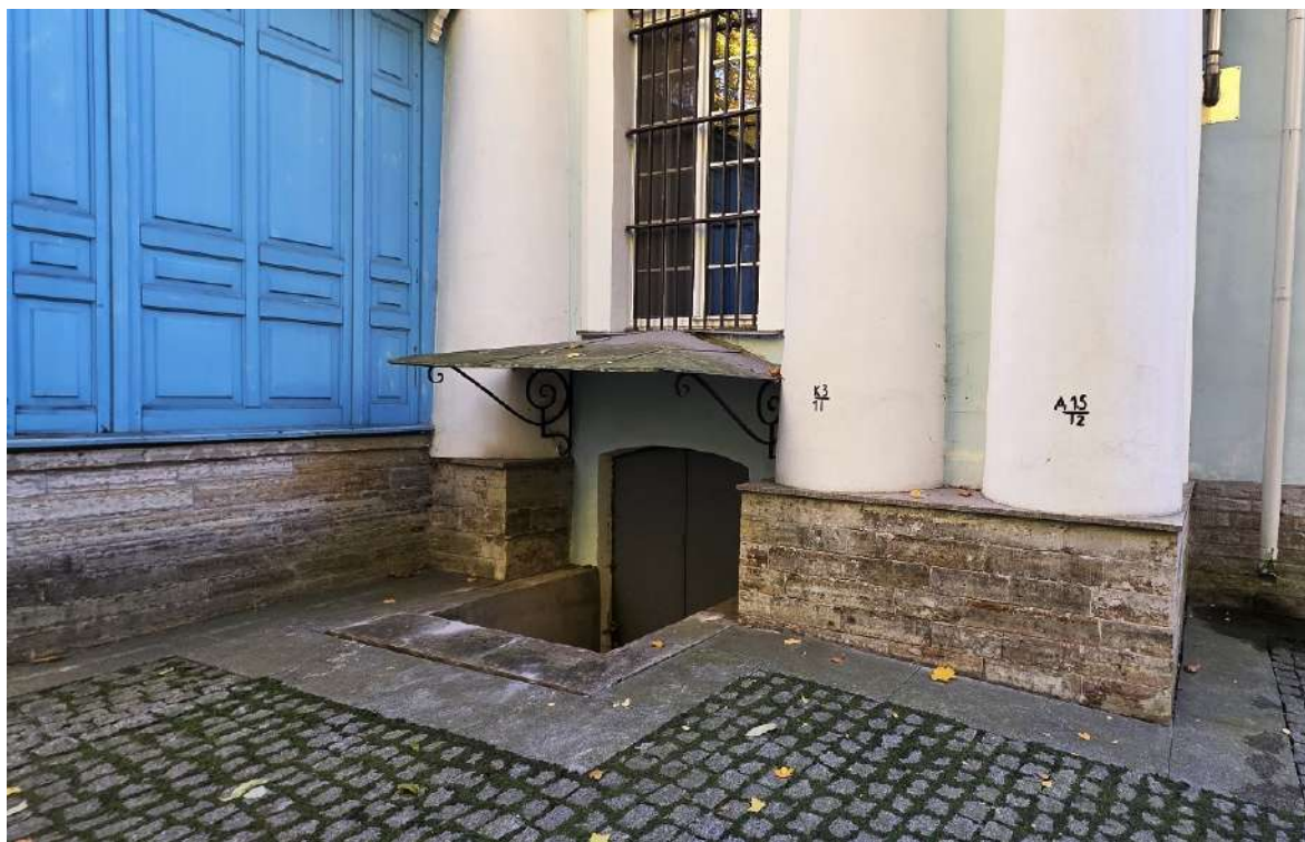
30. ОКНФЗ «Церковь Смоленская». Фрагмент портика северного фасада с северо-запада. Вход в подвал. Дата съемки 19.10.2025г.
