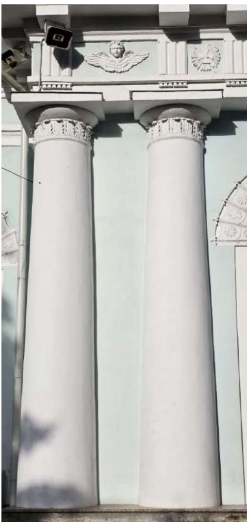
6. ОКНФЗ «Церковь Смоленская». Фрагмент портика южного фасада церкви: колонны в \frac{3}{4} . Дата съемки 19.10.2025г.
