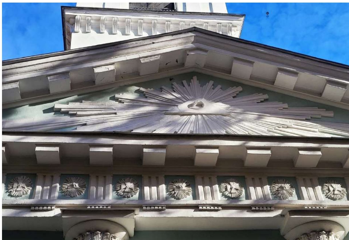
22. ОКНФЗ «Церковь Смоленская». Фрагмент портика западного фасада церкви: лепной декор в тимпане фронтона портика – композиция с изображением сияния с всевидящим оком в центре, антаблемент с триглифами и розетками в метопах. Дата съемки 19.10.2025г.
