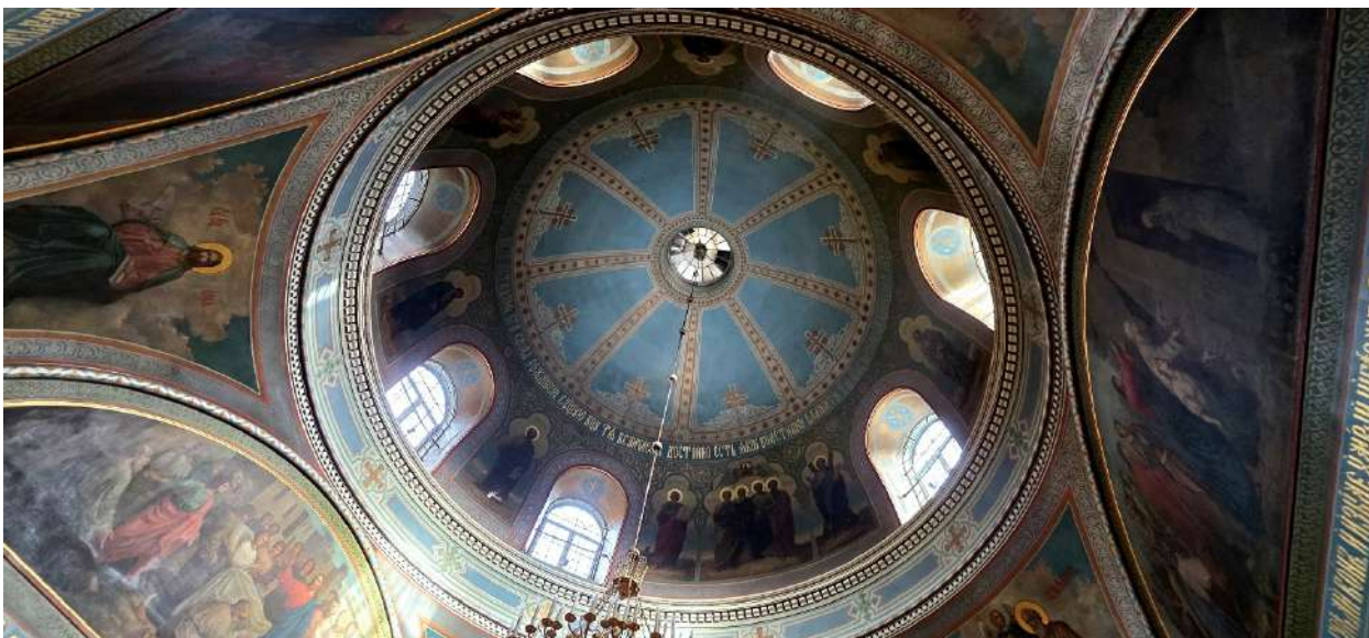
5. ОКНФЗ «Церковь Смоленская». Интерьеры церкви. Фрагмент конструктивной системы – купольное перекрытие над центральной частью храма в виде кирпичного свода на парусах. Дата съемки 19.10.2025г.
