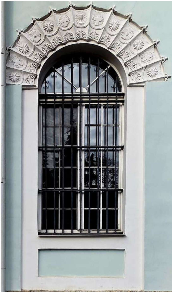
25. ОКНФЗ «Церковь Смоленская». Окно 1-го этажа северного фасада церкви: веерообразный орнаментальный наличник, исторический рисунок переплетов (с мелкой расстекловкой), материал (дерево), исторический колер оконного заполнения. Дата съемки 19.10.2025г.
