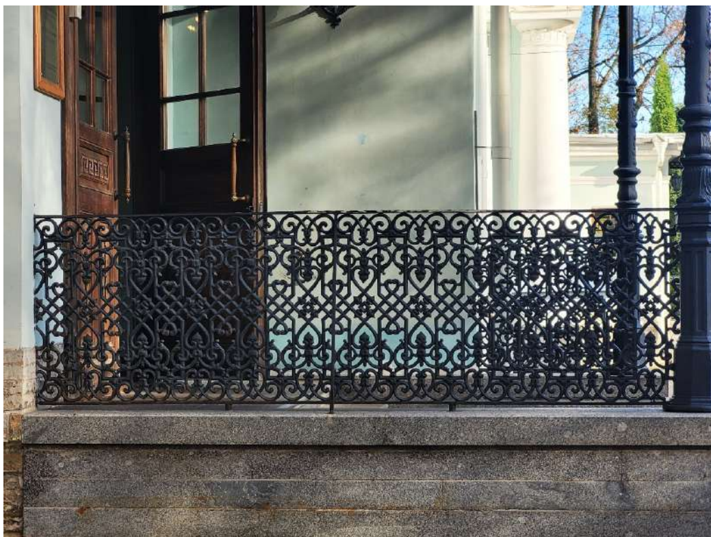
17. ОКНФЗ «Церковь Смоленская». Крыльцо входа в левой части южного фасада: орнаментированное литое ограждение. Дата съемки 19.10.2025г.
