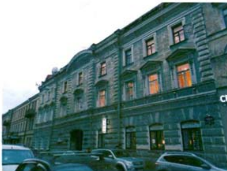
4, 5. Южный двор. Южный и северный фасады
