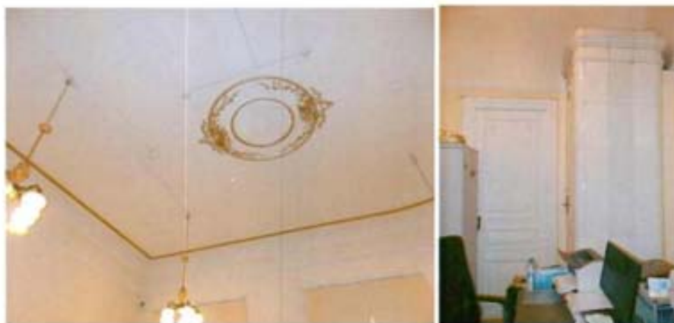
69, 70. Помещения продольного дворового флигеля, 2 этаж, северный двор
