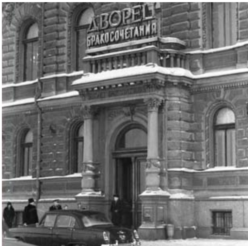
27. Дом фон Дервиза П.П. (Великого князя Андрея Владимировича) – Дворец бракосочетания (Английская наб., д.28). Главный вход. Фотография. 1970-е гг. http://www.pastvu.com .
