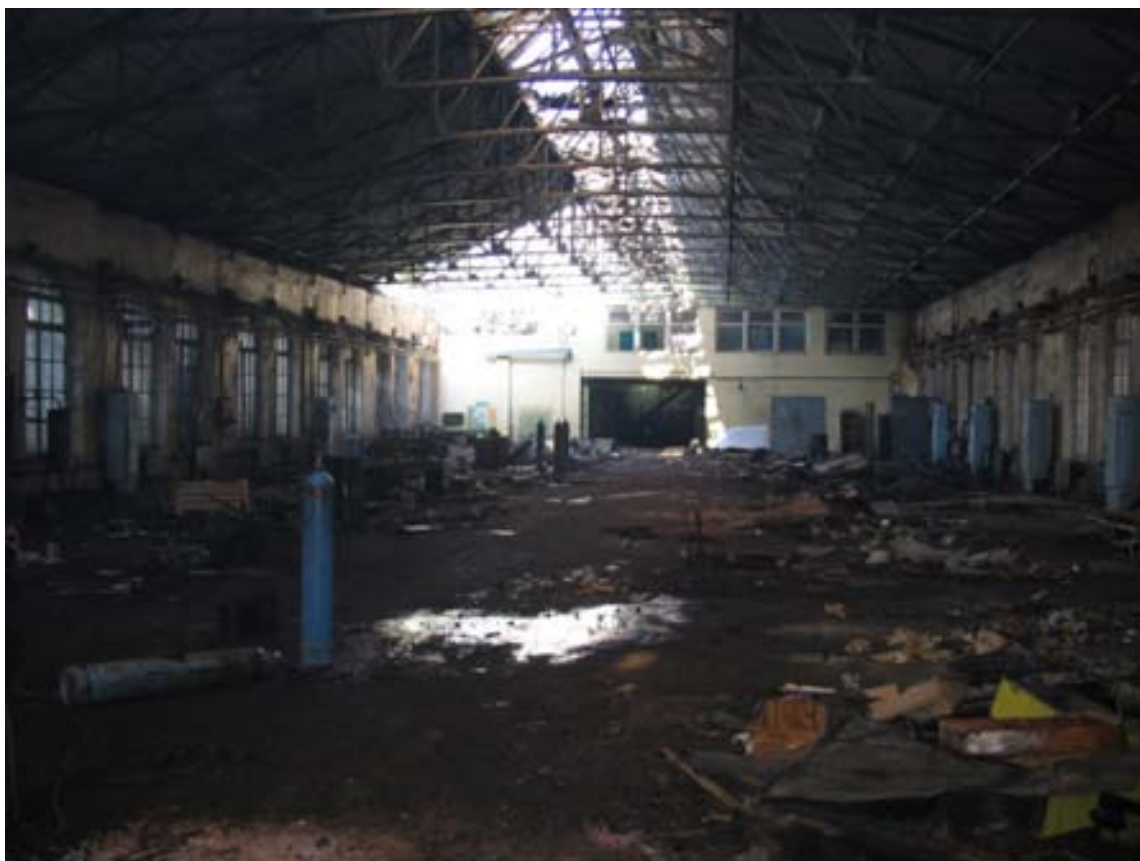
28. ОКН РЗ «Здание инструментального цеха». Интерьер основного здания литер Н. Фотография начала 2000-х гг.
