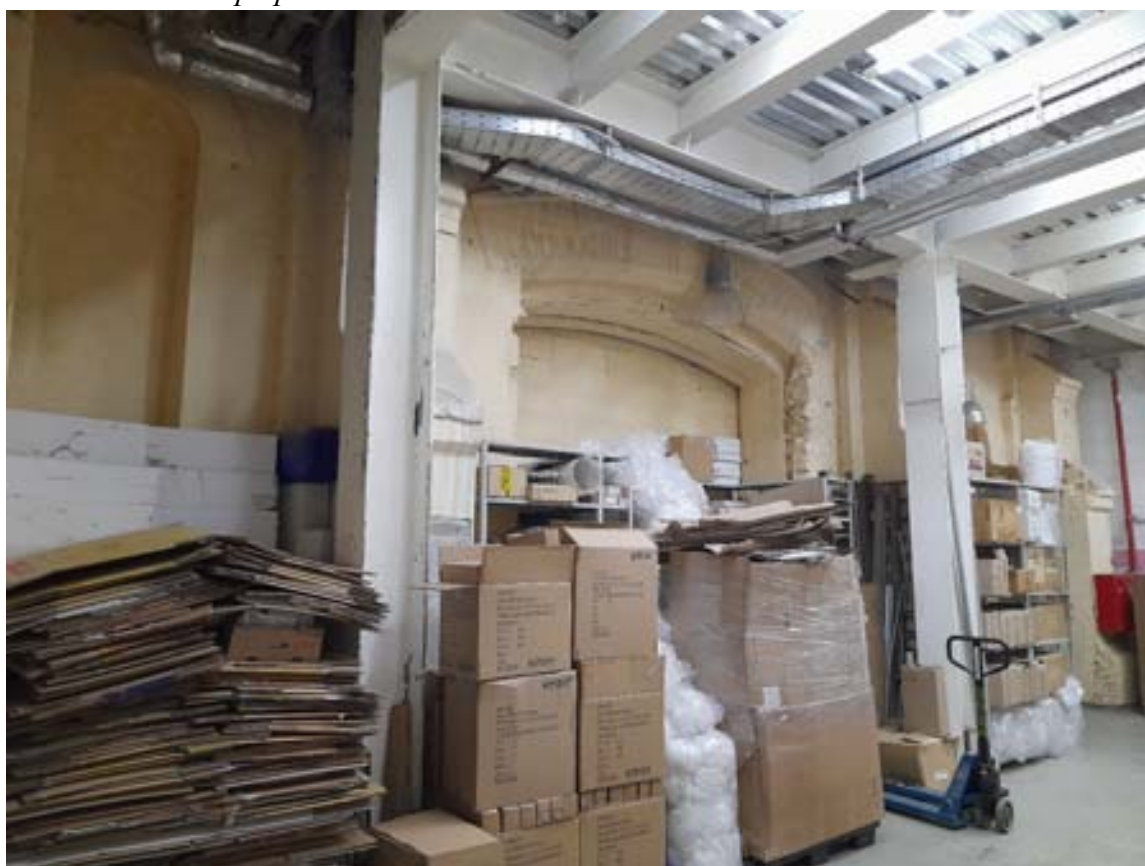
51. ОКН РЗ «Здание инструментального цеха». Литера Н. Общий вид западной стены в уровне первого этажа. Вид из литеры Н 4. Фотография 2024 г.
