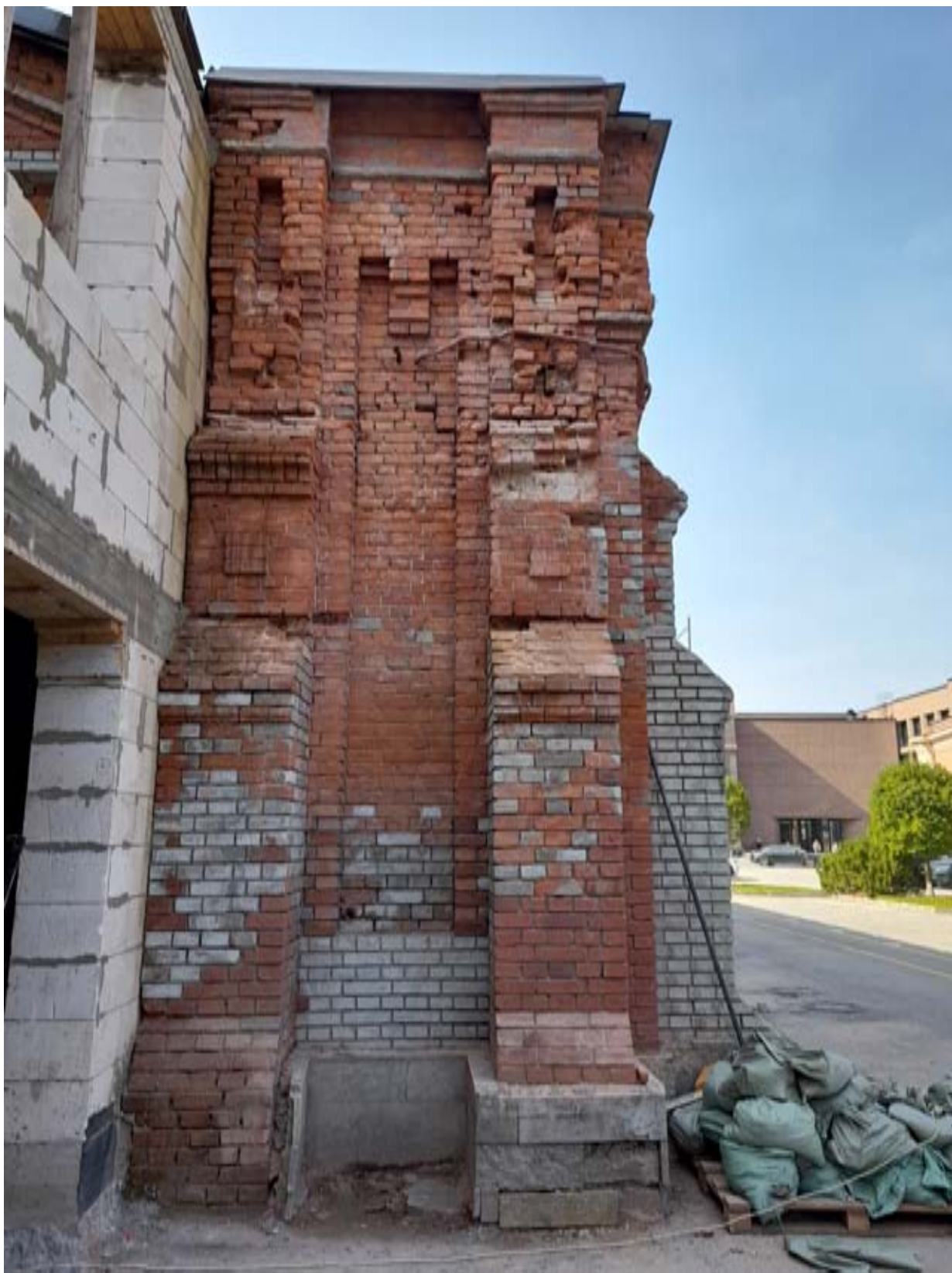
46. ОКН РЗ «Здание инструментального цеха». Литера Н. Северная часть восточной стены с двумя контрфорсами. Фотография 2024 г.
