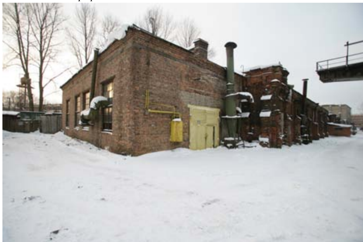
25. ОКН РЗ «Здание инструментального цеха». Восточная пристройка н-1 и основное здание Н. Вид с северо-востока. Фотография начала 2000-х гг.
