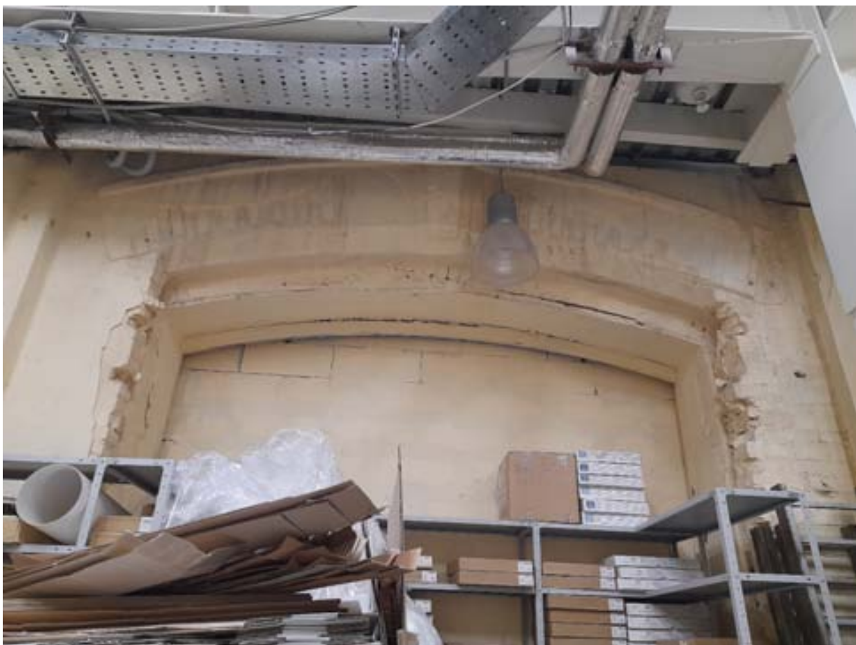
52. ОКН РЗ «Здание инструментального цеха». Литера Н. Ниша на месте северного воротного проема в западной стене. Вид из литеры Н 4. Фотография 2024 г.
