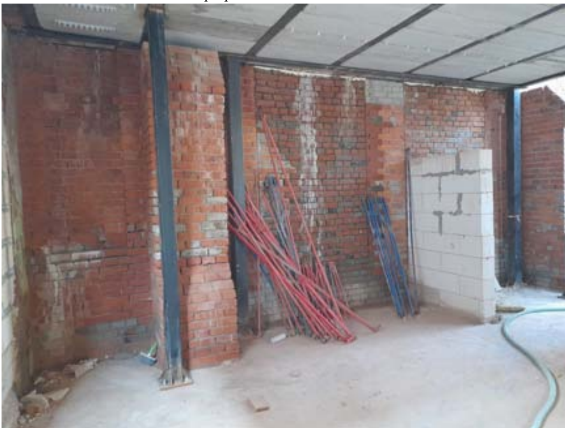
49. ОКН РЗ «Здание инструментального цеха». Литера Н. Южная часть восточной стены с заложеными оконными проемами и контрфорсом. Вид с востока. Фотография 2024 г.
