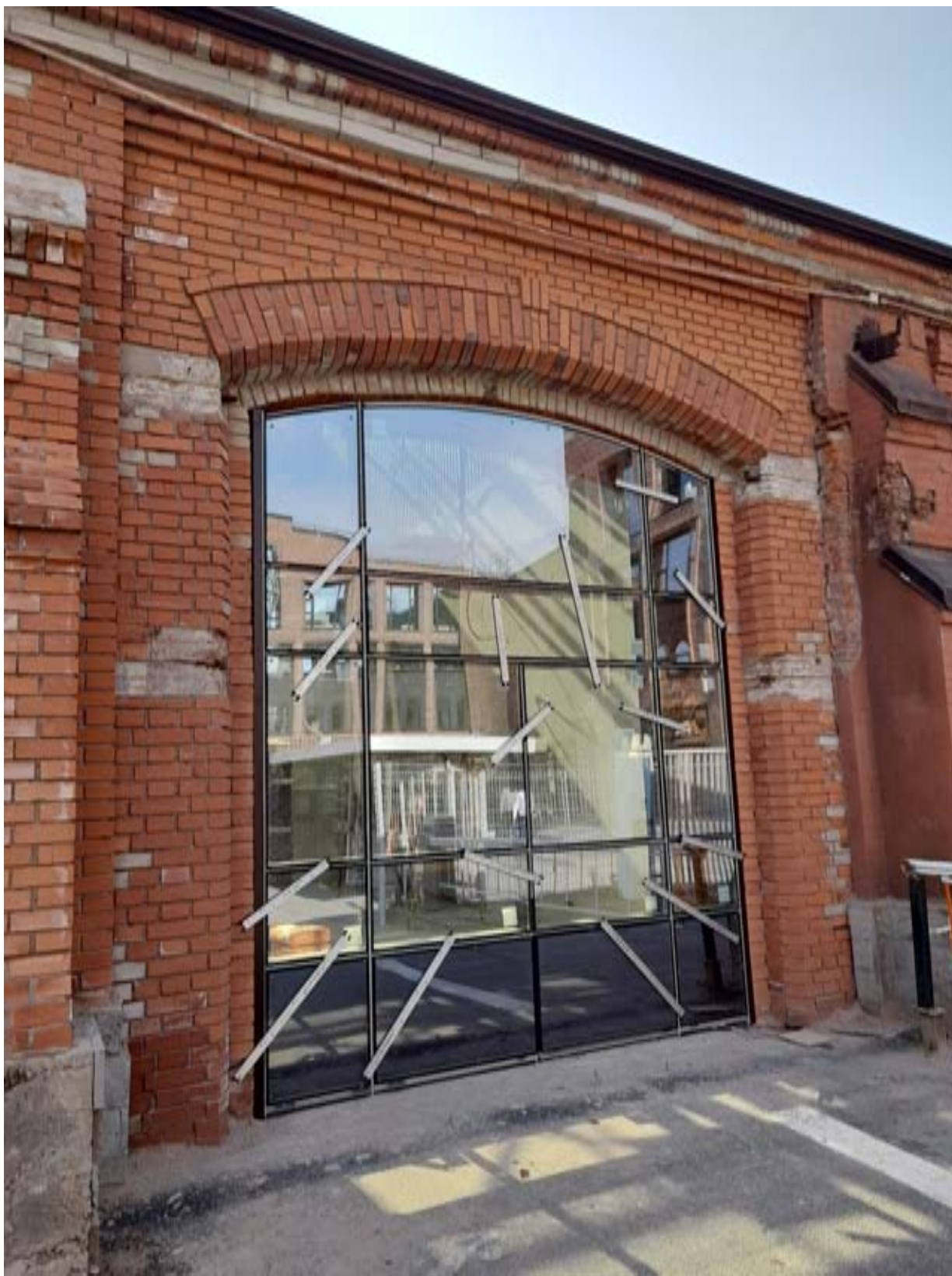
44. ОКН РЗ «Здание инструментального цеха». Литера Н. Западный воротный проем северного фасада, переделанный в окно. Фотография 2024 г.
