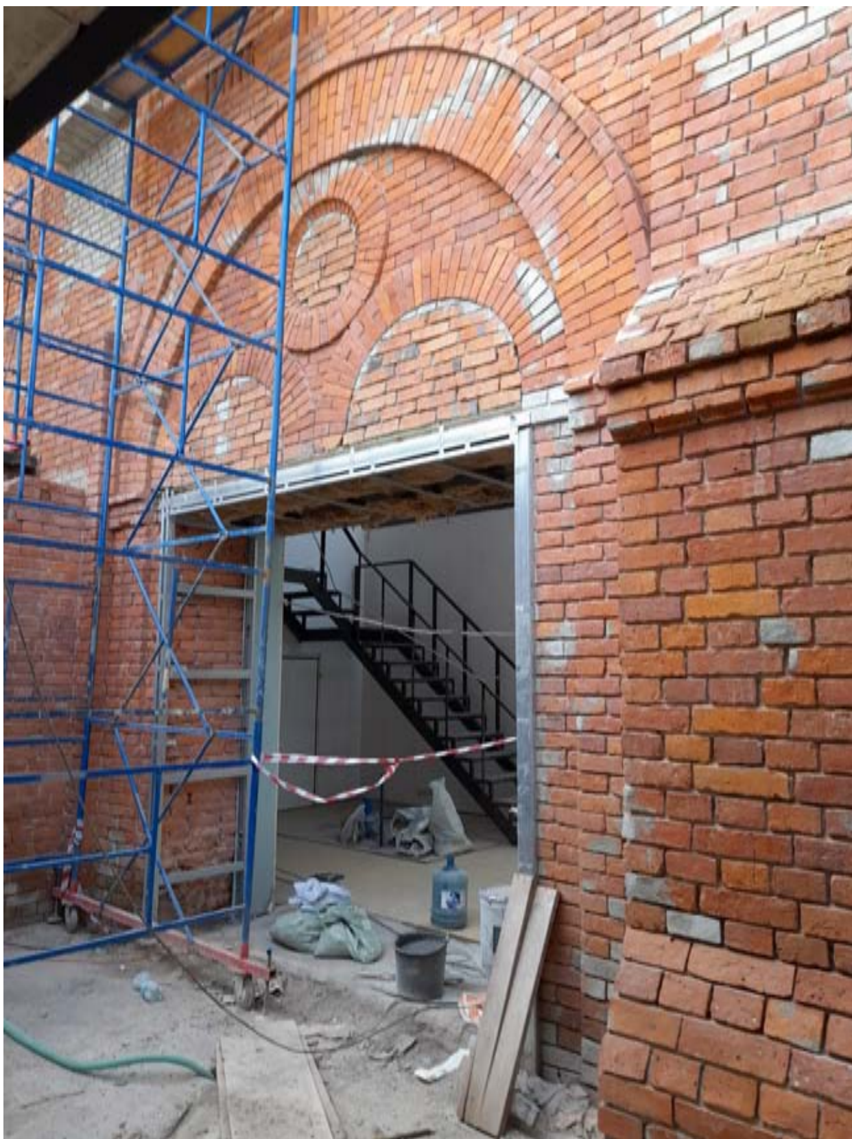
45. ОКН РЗ «Здание инструментального цеха». Литера Н. Центральная прясло восточной стены с кладкой в виде композиции «бифорий» (частично утрачена). Вид с северо-востока. Фотография 2024 г.
