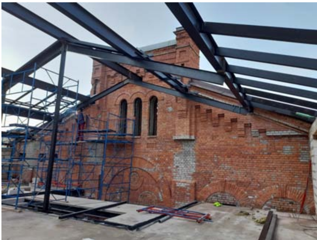
48. ОКН РЗ «Здание инструментального цеха». Литера Н. Верхняя часть восточной стены. Вид с востока. Фотография 2024 г.
