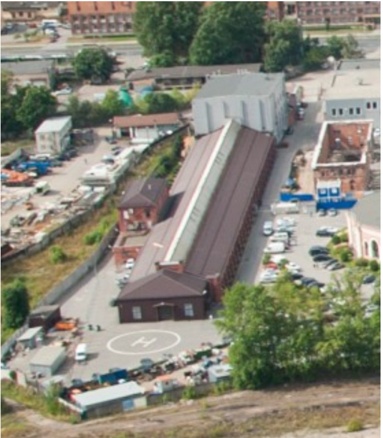
33. «Здание инструментального цеха». Вид с востока. Фото 2014 года. // URL: https://panevin.ru/uploads/photo/2014/muzey_zheleznodorozhnoy_tehniki_na_varshavskom_1024.jpg .
