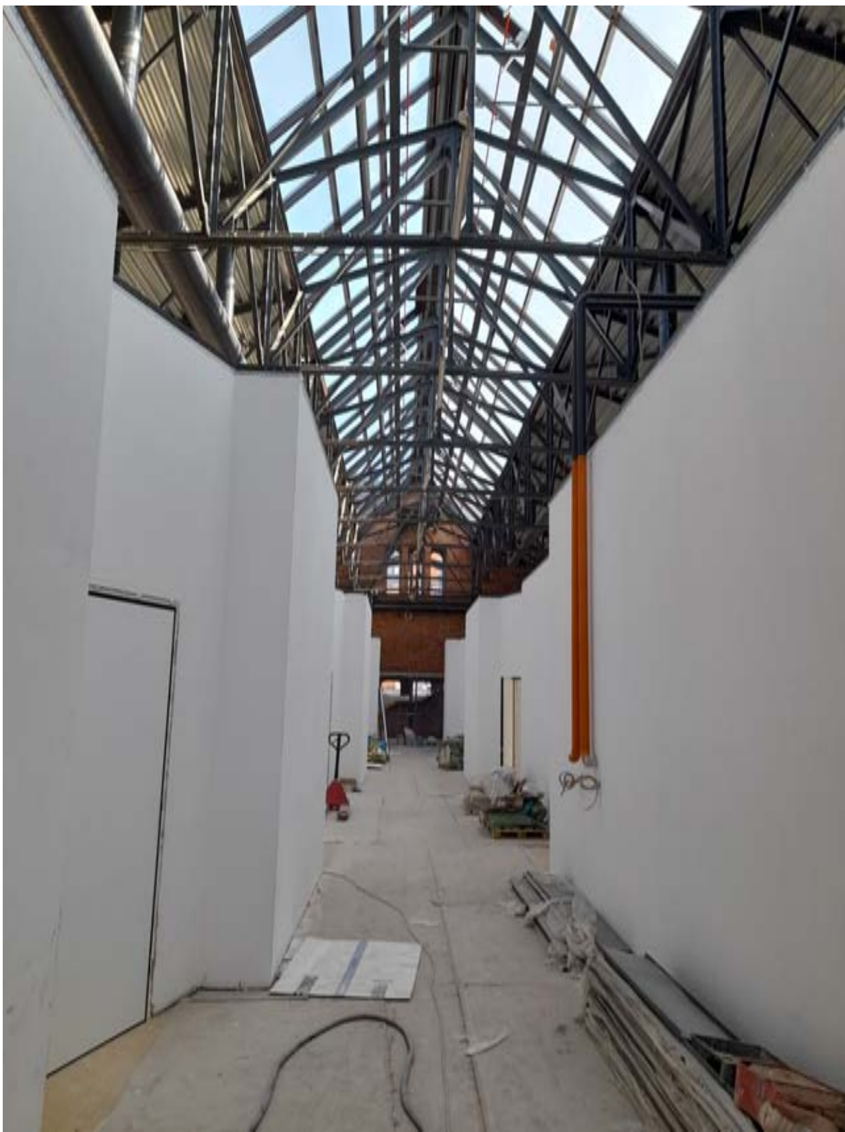
56. ОКН РЗ «Здание инструментального цеха». Литера Н. Восточная часть интерьера Фотография 2024 г.
