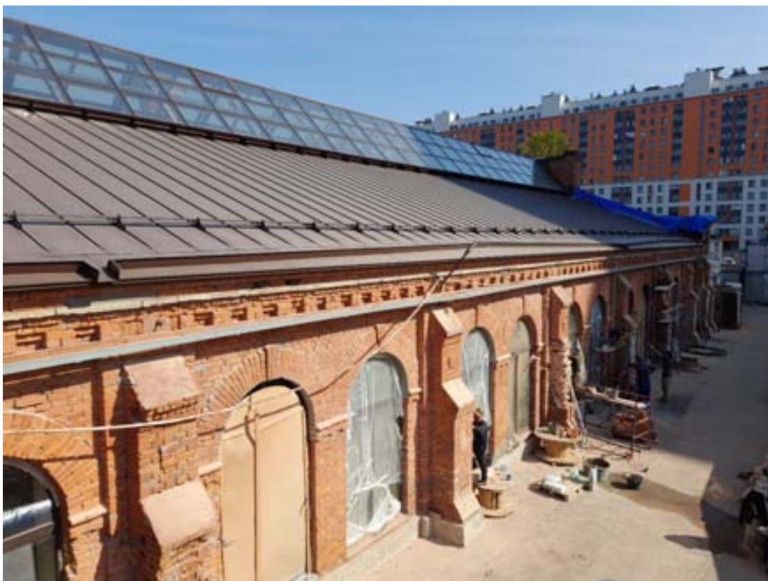
41. ОКН РЗ «Здание инструментального цеха». Литера Н. Восточная часть южного фасада. Ведутся ремонтно-восстановительные работы. Фотография 2024 г.
