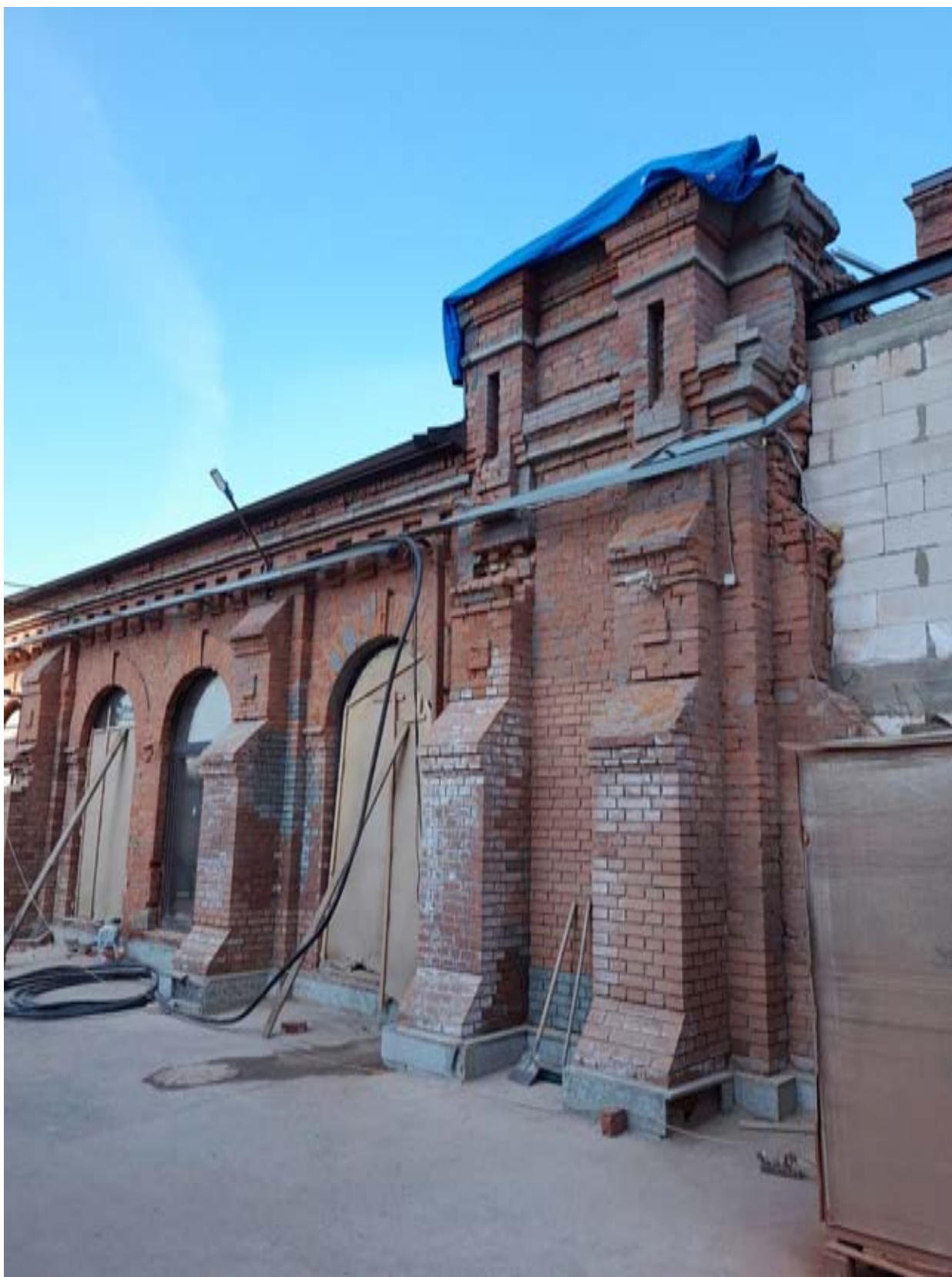
40. ОКН РЗ «Здание инструментального цеха». Литера Н. Восточная часть южного фасада. Вид с юго-востока. Фотография 2024 г.
