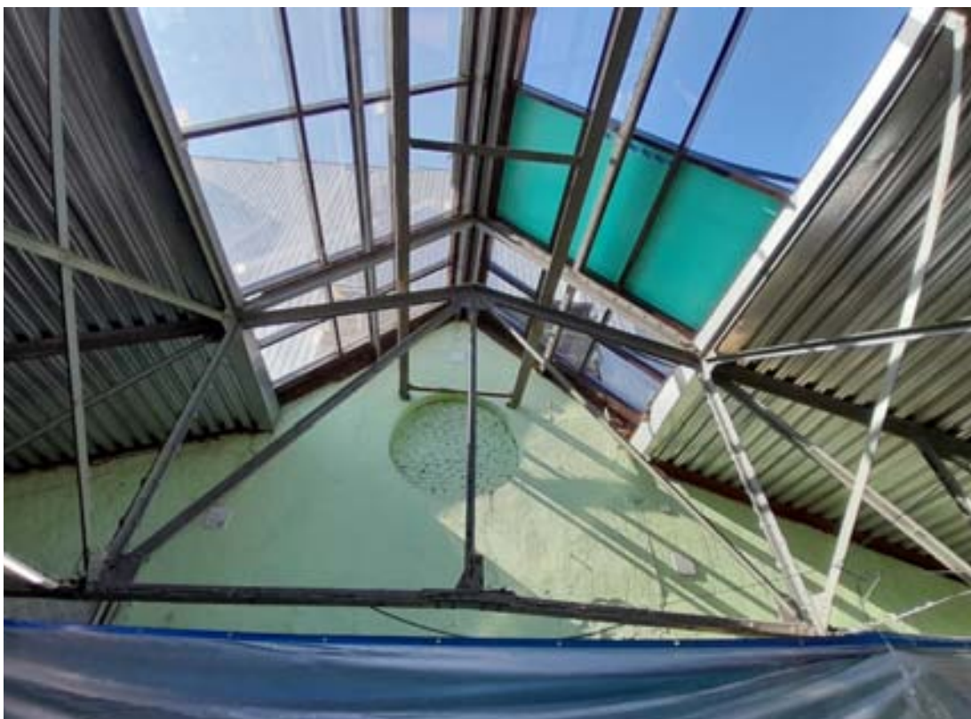
50. ОКН РЗ «Здание инструментального цеха». Литера Н. Фрагмент металлической фермы со световым фонарем. Круглое окно в верхней части западной стены. Вид с востока. Фотография 2024 г.
