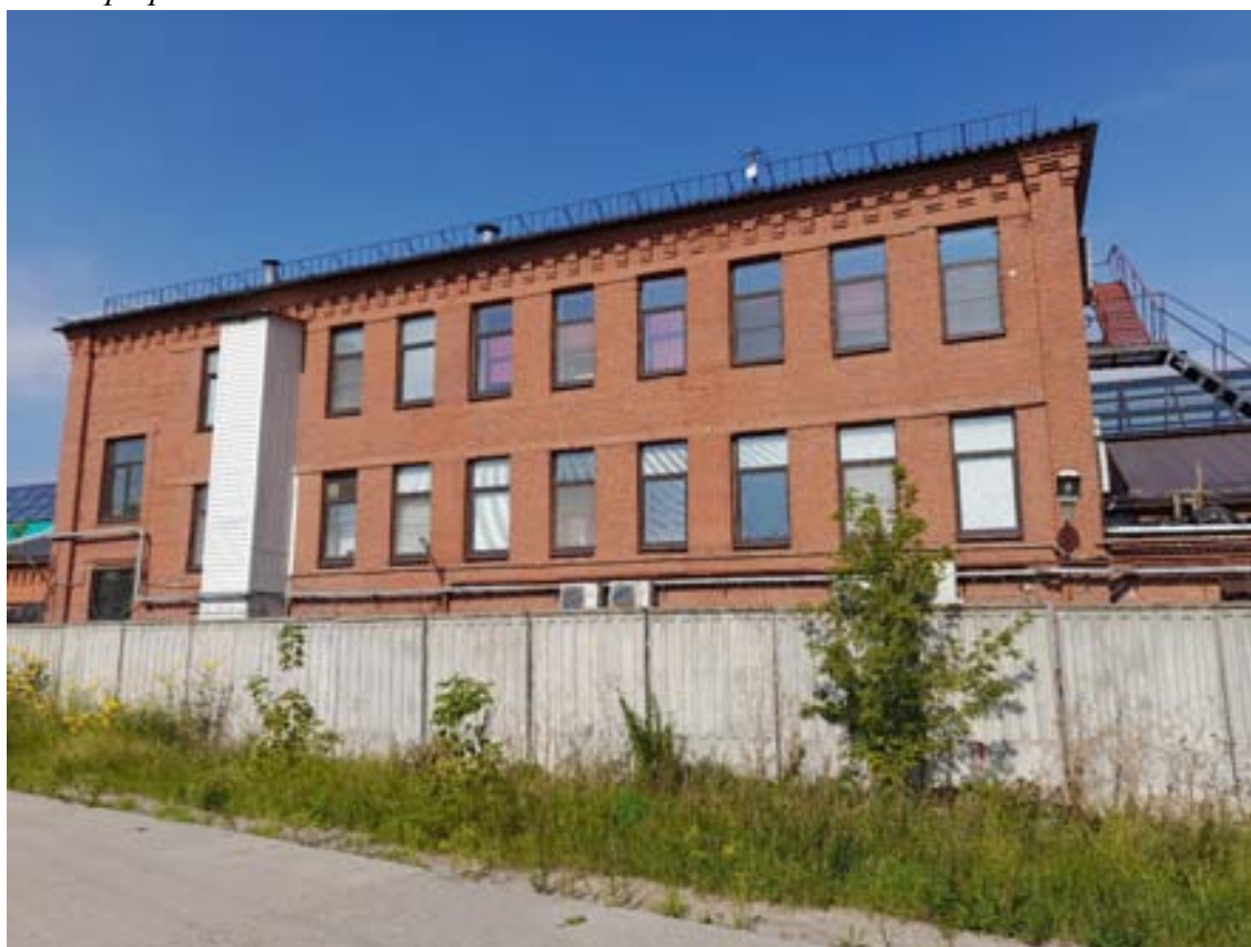
58. ОКН РЗ «Здание инструментального цеха». Литера НЗ. Южный фасад. Фотография 2024 г.
