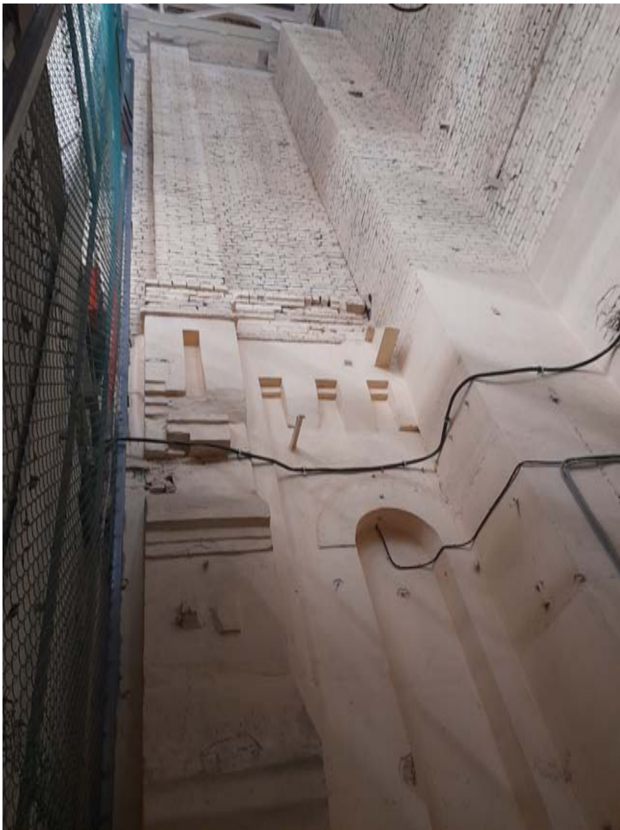
55. ОКН РЗ «Здание инструментального цеха». Литера Н. Южная часть западной стены с контрфорсом, фрагментом пояса кирпичных кронштейнов и переложенной верхней частью стены. Вид из литеры Н 4. Фотография 2024 г.
