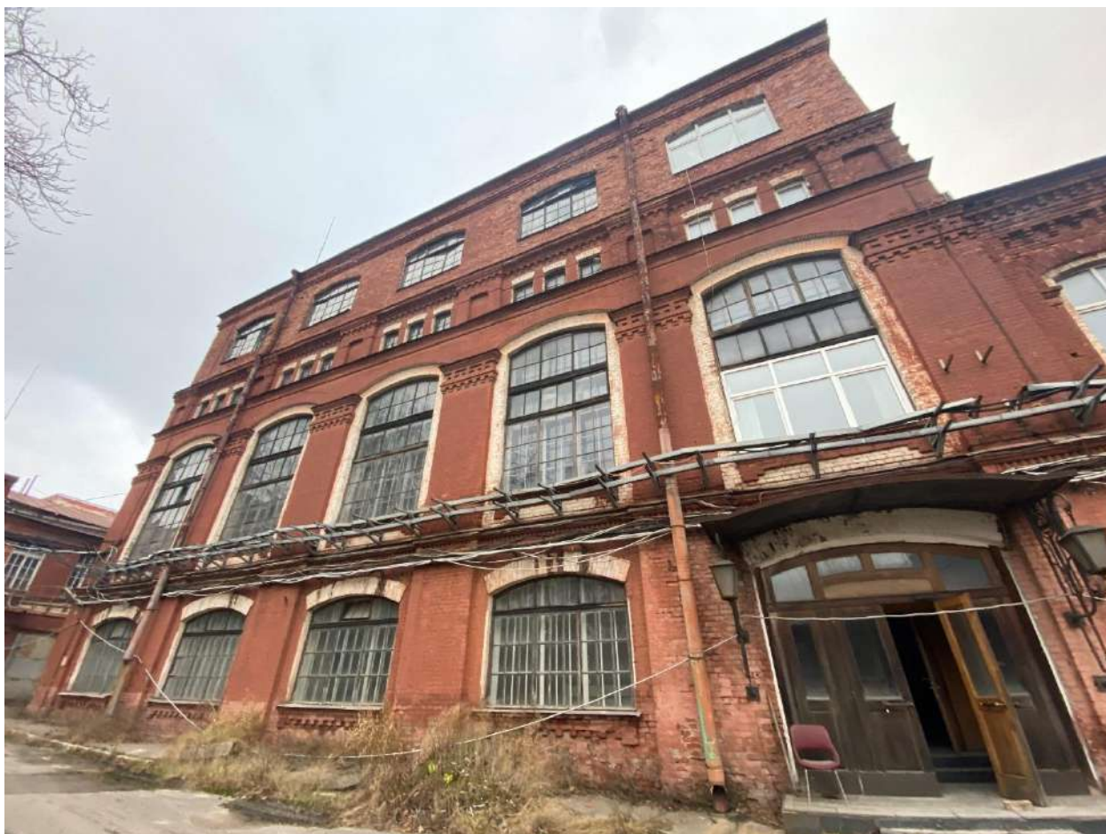
Фото 5. Вид на северо-западную часть исследуемого объекта.
