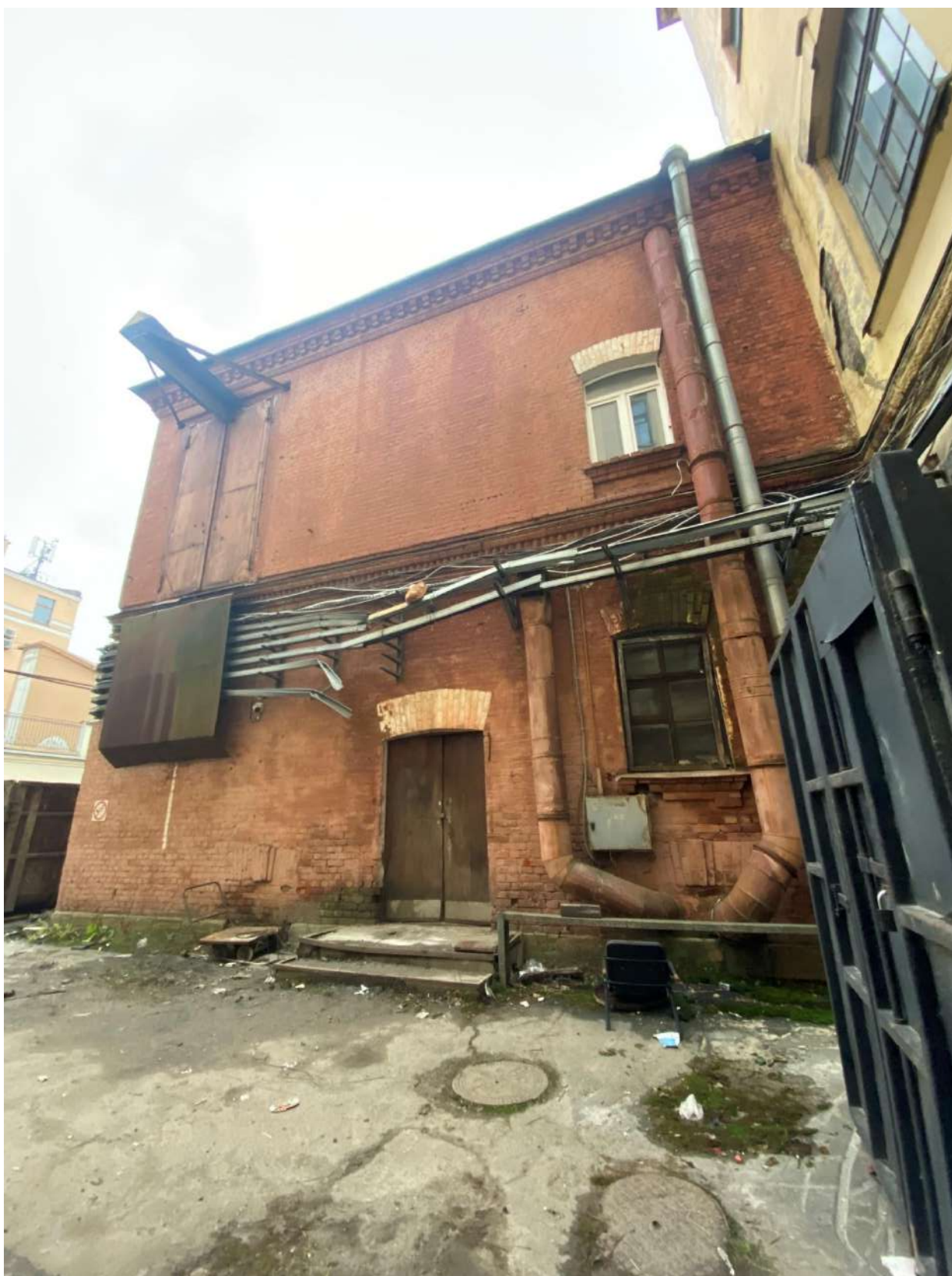
Фото 1. Вид на исследуемый объект с юго-востока.
