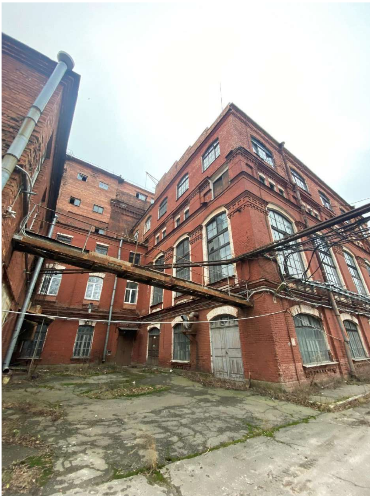
Фото 4. Вид на исследуемый объект с северо-запада.
