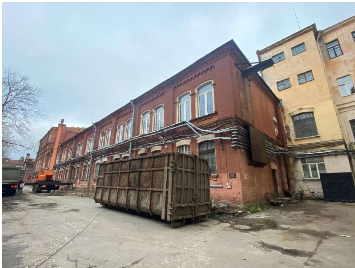
Фото 2. Вид на исследуемый объект с юго-востока.
