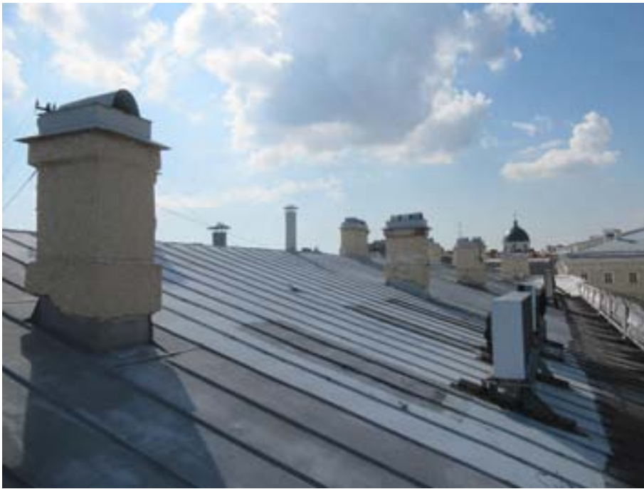
5. «Флигель служебный западный Михайловского дворца» (в составе «Дворец Великого князя Михаила Павловича (Русский музей Императора Александра III)»), г. Санкт-Петербург, Инженерная улица, дом 2-4, литера Г. Крыша. Общий вид. Фото 03.02.2026г.
