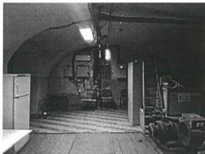
Фото 12. Фрагмент интерьера. Подвал
