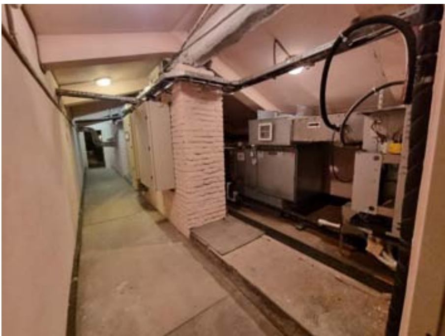
10. «Флигель служебный западный Михайловского дворца» (в составе «Дворец Великого князя Михаила Павловича (Русский музей Императора Александра III)»), г. Санкт-Петербург, Инженерная улица, дом 2-4, литера Г. Чердак. Общий вид. Фото 03.02.2026г.
