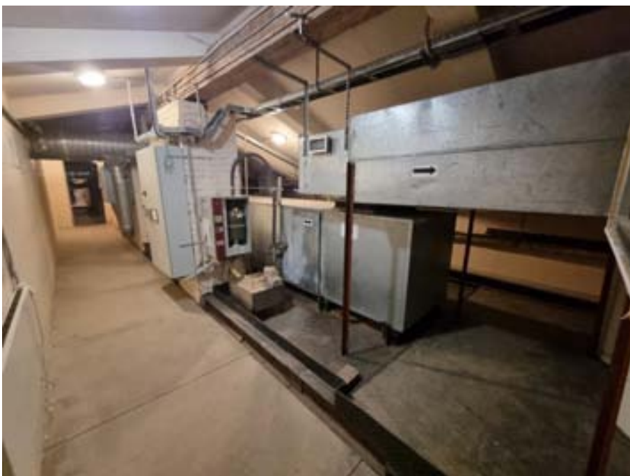
8. «Флигель служебный западный Михайловского дворца» (в составе «Дворец Великого князя Михаила Павловича (Русский музей Императора Александра III)»), г. Санкт-Петербург, Инженерная улица, дом 2-4, литера Г. Чердак. Общий вид. Фото 03.02.2026г.
