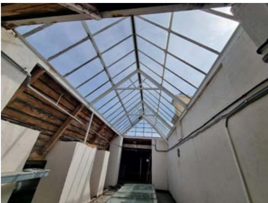
20. «Флигель служебный западный Михайловского дворца» (в составе «Дворец Великого князя Михаила Павловича (Русский музей Императора Александра III)»), г. Санкт-Петербург, Инженерная улица, дом 2-4, литера Г. Кровля. Общий вид. Фото 03.02.2026г.
