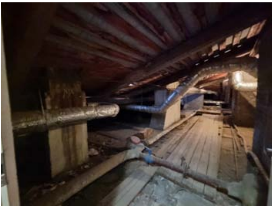
11. «Флигель служебный западный Михайловского дворца» (в составе «Дворец Великого князя Михаила Павловича (Русский музей Императора Александра III)»), г. Санкт-Петербург, Инженерная улица, дом 2-4, литера Г. Чердак. Общий вид. Фото 03.02.2026г.
