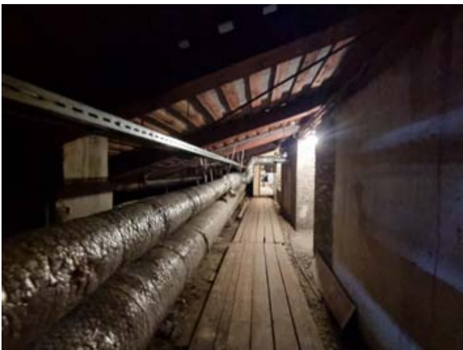
7. «Флигель служебный западный Михайловского дворца» (в составе «Дворец Великого князя Михаила Павловича (Русский музей Императора Александра III)»), г. Санкт-Петербург, Инженерная улица, дом 2-4, литера Г. Чердак. Общий вид. Фото 03.02.2026г.
