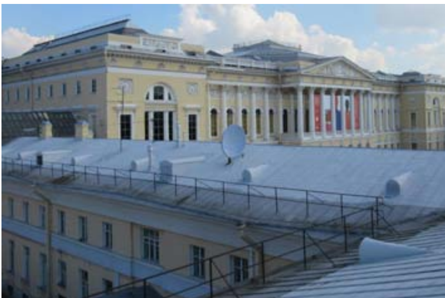
4. «Флигель служебный западный Михайловского дворца» (в составе «Дворец Великого князя Михаила Павловича (Русский музей Императора Александра III)»), г. Санкт-Петербург, Инженерная улица, дом 2-4, литера Г. Крыша. Общий вид. Фото 03.02.2026г.
