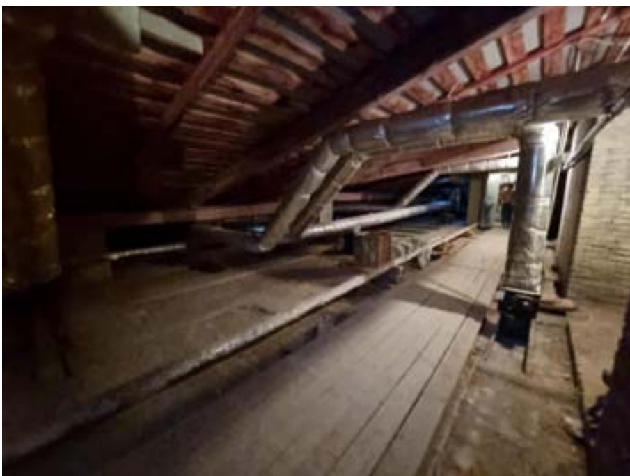
12. «Флигель служебный западный Михайловского дворца» (в составе «Дворец Великого князя Михаила Павловича (Русский музей Императора Александра III)»), г. Санкт-Петербург, Инженерная улица, дом 2-4, литера Г. Чердак. Общий вид. Фото 03.02.2026г.
