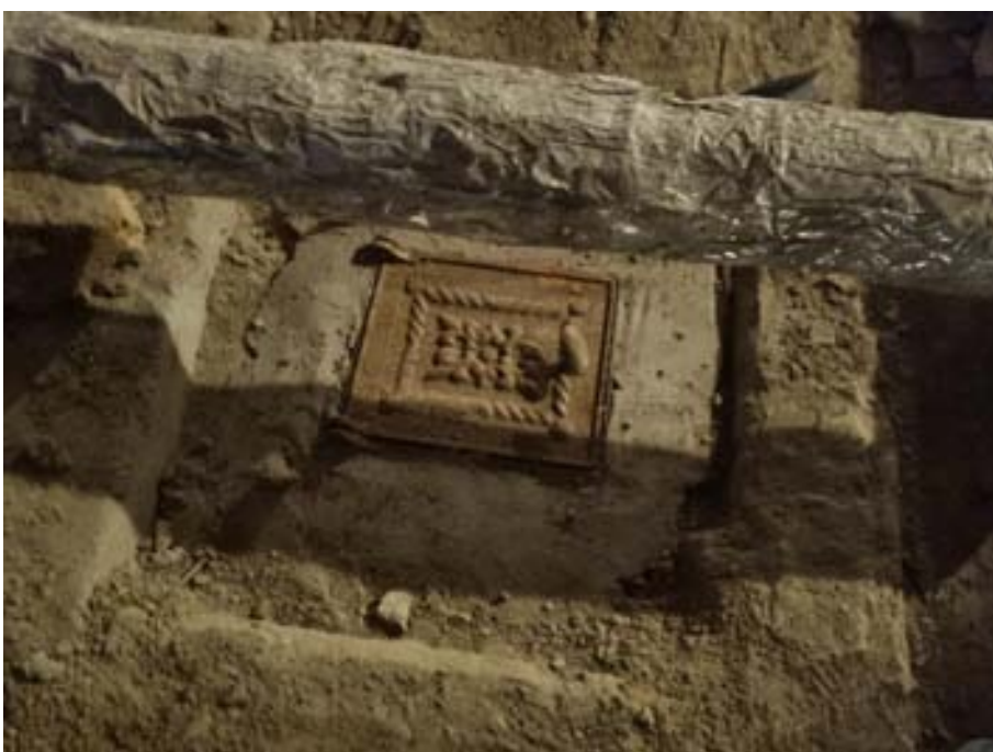
16. «Флигель служебный западный Михайловского дворца» (в составе «Дворец Великого князя Михаила Павловича (Русский музей Императора Александра III)»), г. Санкт-Петербург, Инженерная улица, дом 2-4, литера Г. Чердак. Фрагмент. Фото 03.02.2026г.
