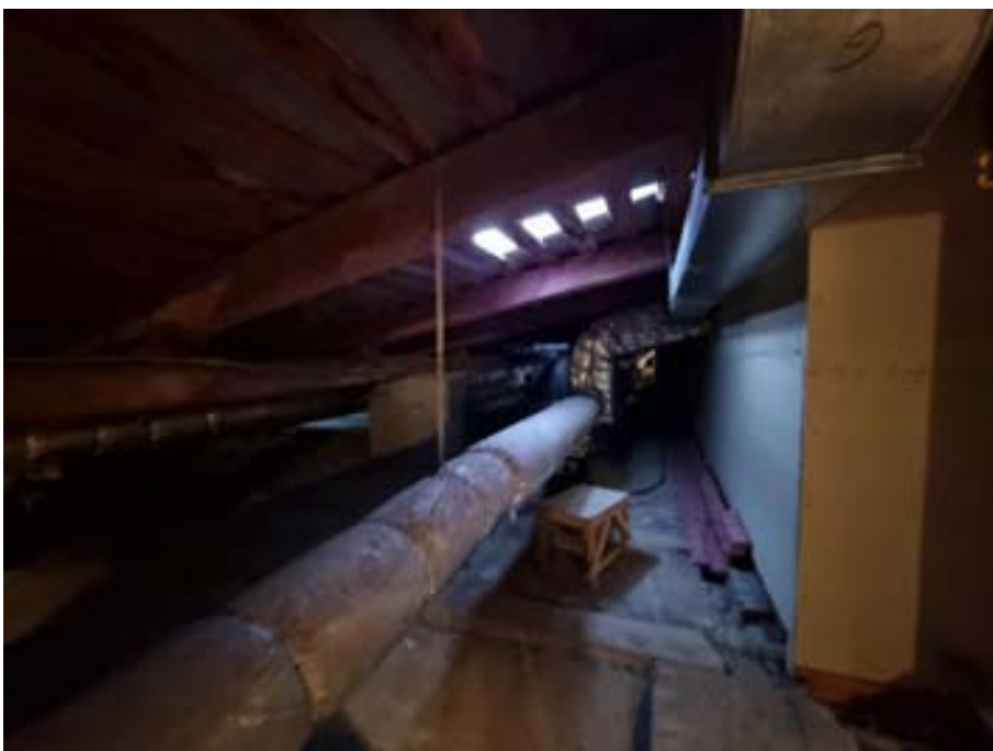
13. «Флигель служебный западный Михайловского дворца» (в составе «Дворец Великого князя Михаила Павловича (Русский музей Императора Александра III)»), г. Санкт-Петербург, Инженерная улица, дом 2-4, литера Г. Чердак. Общий вид. Фото 03.02.2026г.
