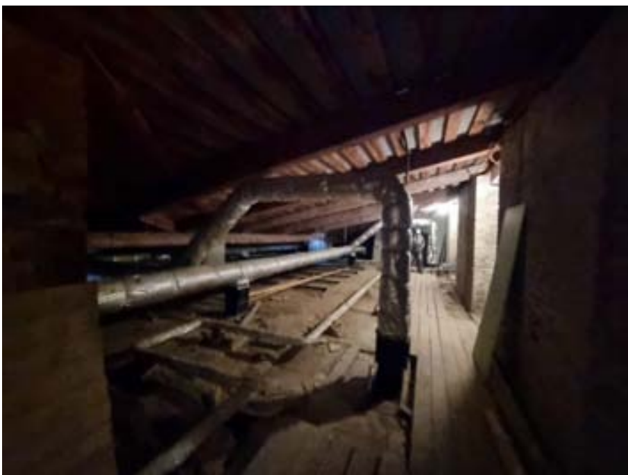
15. «Флигель служебный западный Михайловского дворца» (в составе «Дворец Великого князя Михаила Павловича (Русский музей Императора Александра III)»), г. Санкт-Петербург, Инженерная улица, дом 2-4, литера Г. Чердак. Общий вид. Фото 03.02.2026г.
