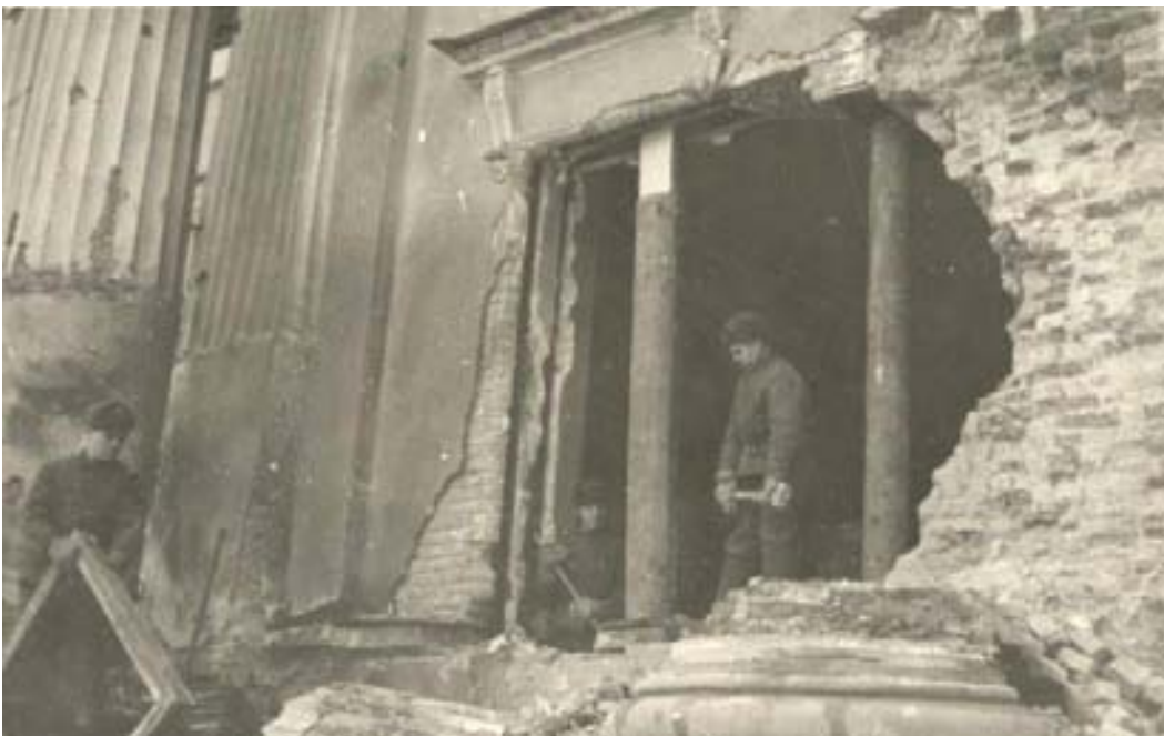
38. Государственный Русский музей. Корпус Росси. Ликвидация разрушений фасадной стены в годы Великой Отечественной войны. Фотография. 1944 г. ГМИ СПб (инв. № №-П-Б-12280 ф).
