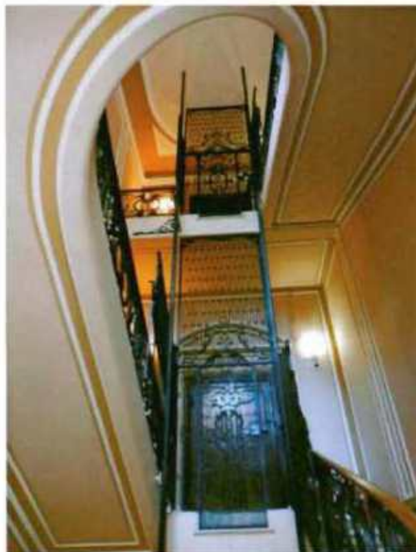
13. Кованое ограждение шахты лифта
