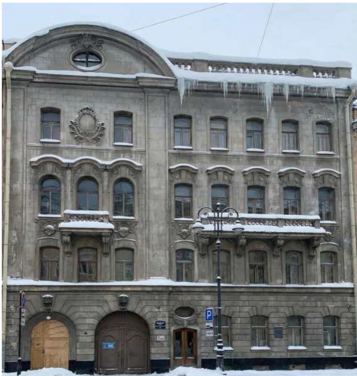
1. Вид на лицевой фасад здания №15
