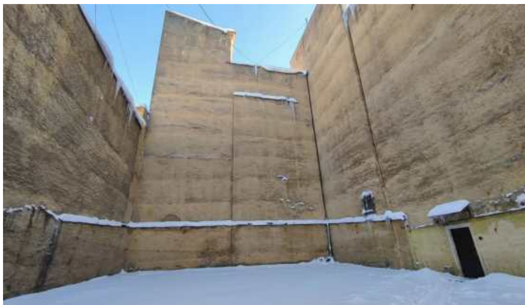
2. Вид на брандмауэрные стены здания
