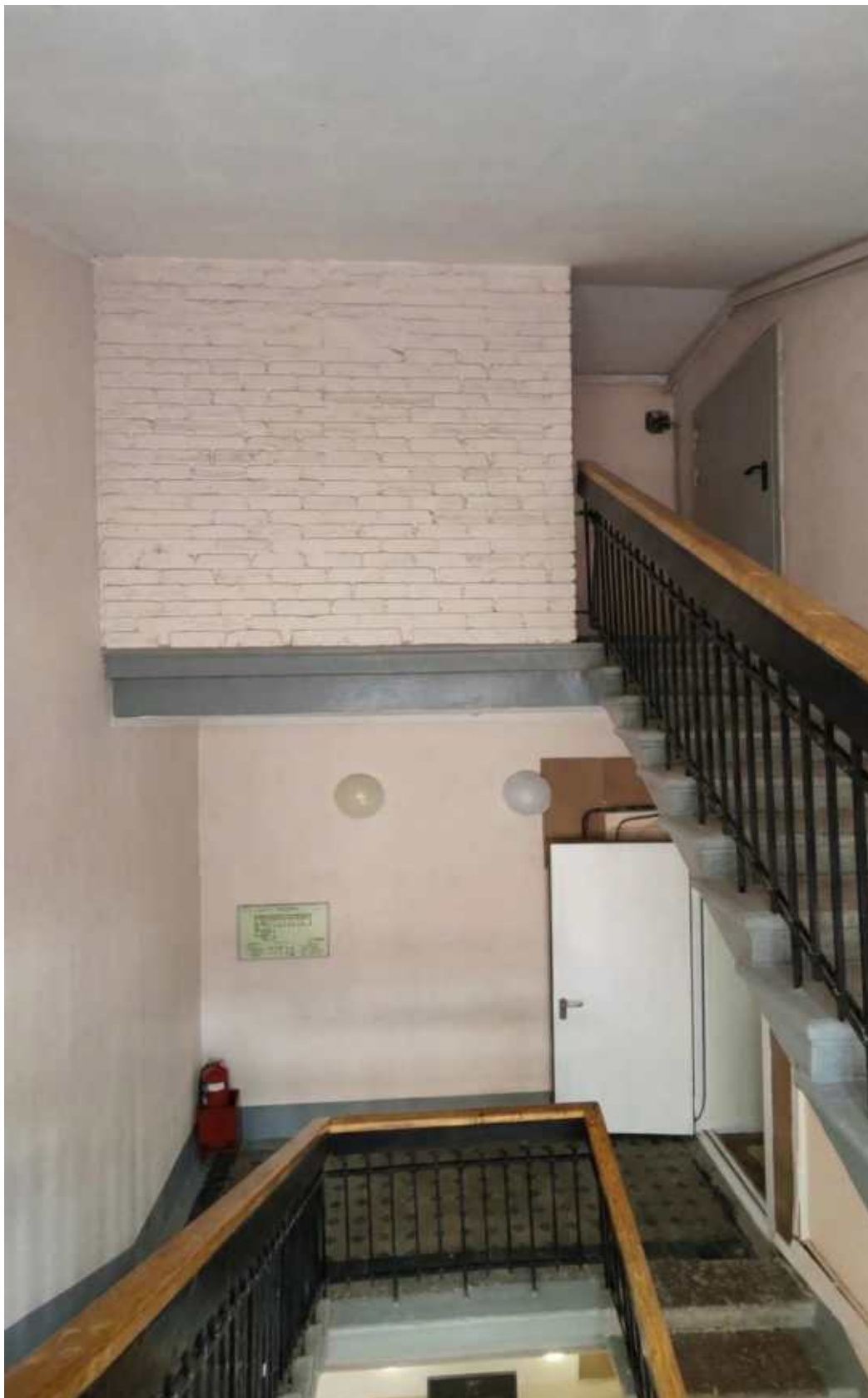
5. Вид на лестничную клетку
