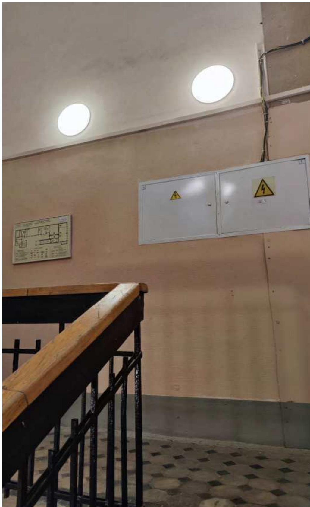
3. Вид на лестничную клетку
