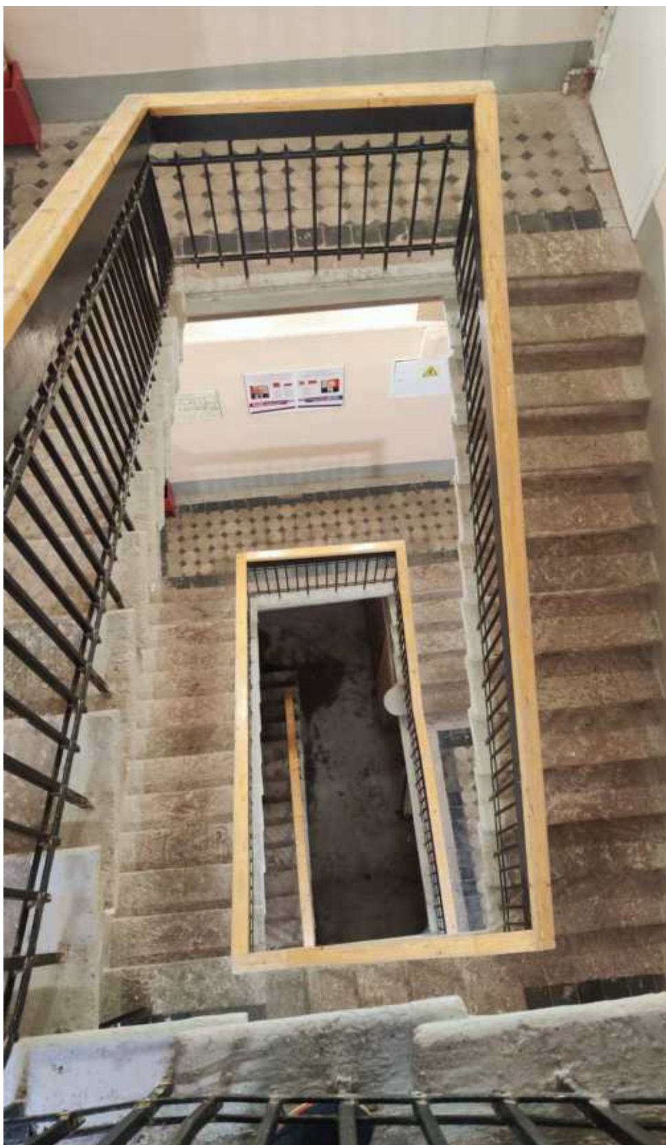
4. Вид на лестничную клетку
