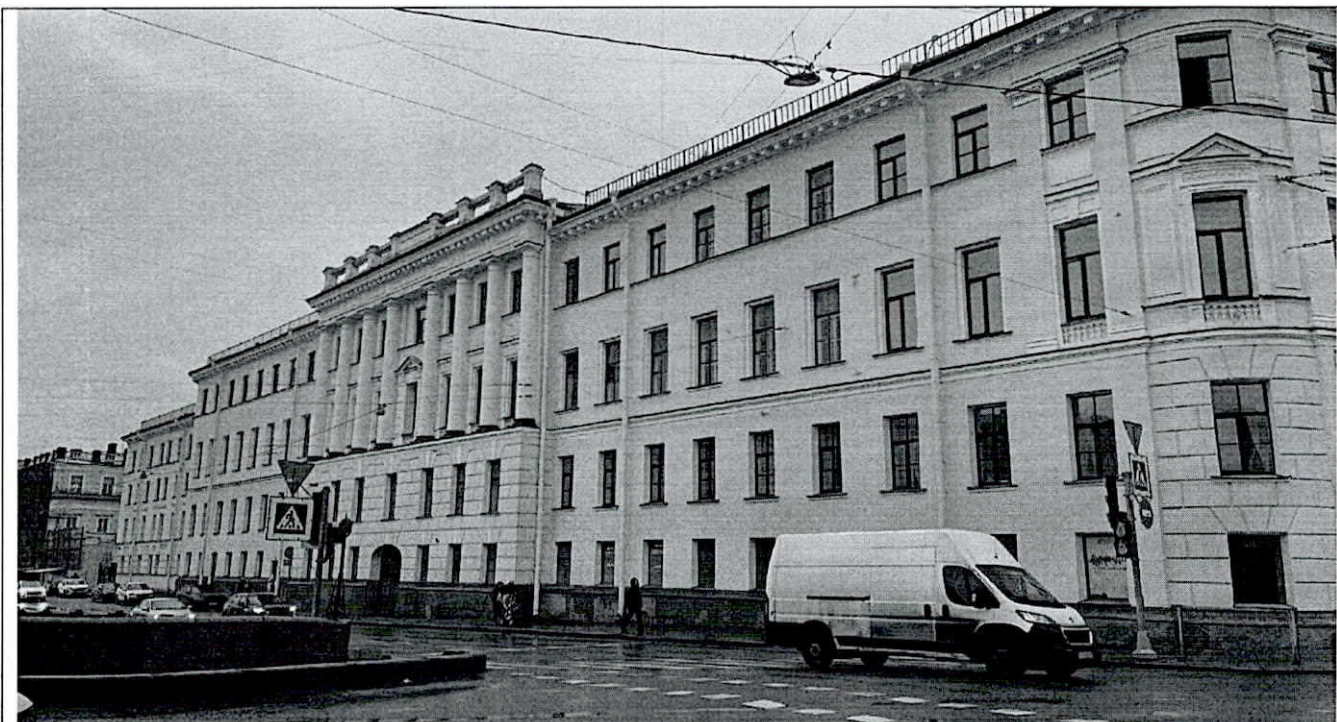
1. Общий вид. Лицевой фасад по набережной реки Фонтанки.
