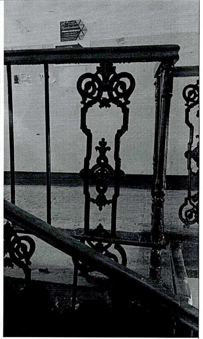
14. Фрагмент лестничной клетки 3 (ЛК 3). Часть фигурного ограждения заменена на вертикальные прутья, ступени облицованы керамической плиткой, стены защищены современными панелями.
