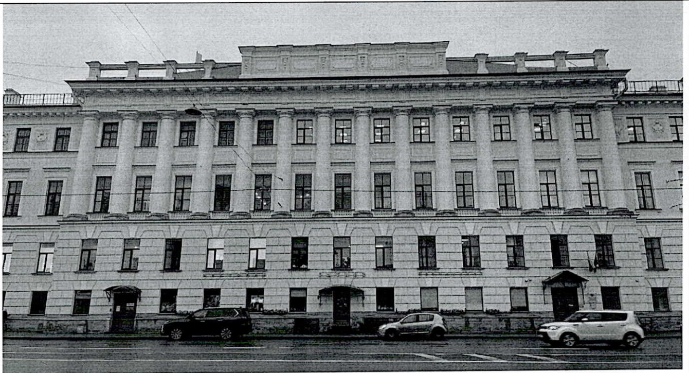
3. Фрагмент лицевого фасада со стороны Измайловского проспекта
