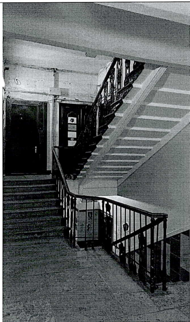
12. Фрагмент лестничной клетки 3 (ЛК 3). Часть фигурного ограждения заменена на вертикальные прутья, ступени облицованы керамической плиткой, стены защищены современными панелями.
