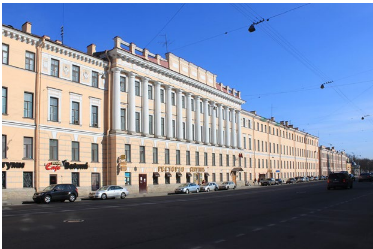
Илл. 15. 2011 г. Измайловский пр., д. 2. Лицевой фасад
