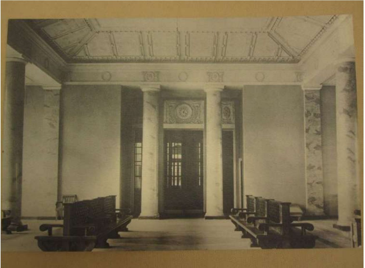
Илл. 8. Вокзал в г. Пушкин. Ленинградская обл. Интерьер. Архитектор: Левинсон Е.А.; Архитектор: Грушке А.А. Период создания: 1949 г., номер в Госкаталоге: 64089522, номер по КП (ГИК): ГНИМА НФ-ОФ-64/28 инвентарный номер: ХР-39
