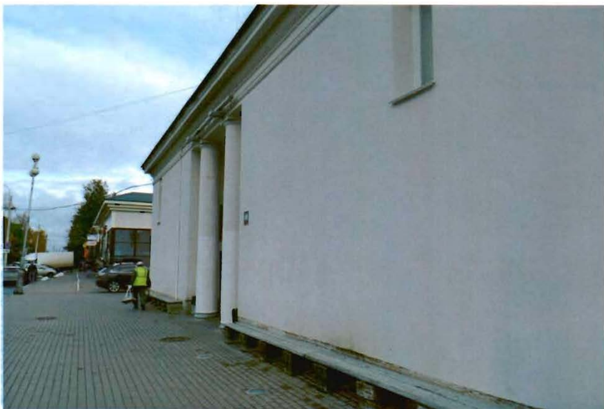
Фото № 23. Западный фасад павильона (Пушкин, Привокзальная пл., 1, лит Б).
