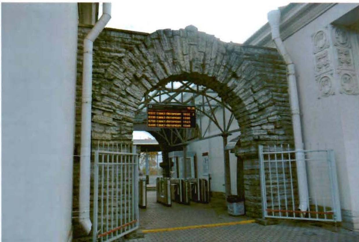
Фото №15. Северные левые пропилеи между Главным зданием и павильоном.
