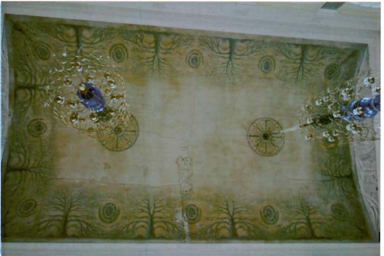
Фото № 10. Интерьер Главного здания, кассовый зал. Потолок.
