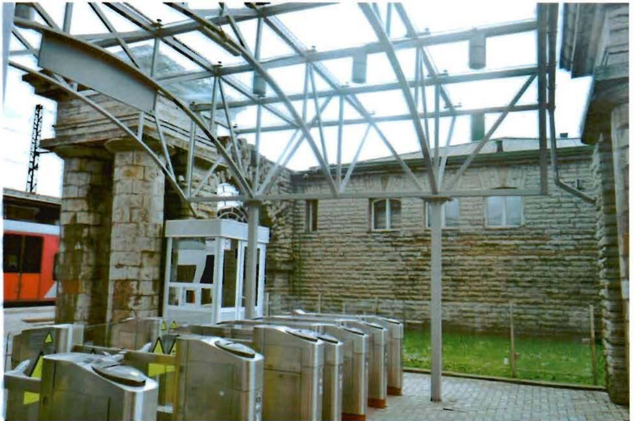
Фото №4. Северный фасад Главного здания.
