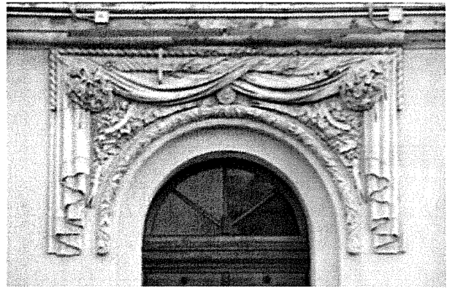
Фрагмент лепного барельефа
