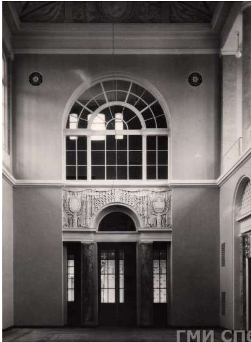
Илл. 6. Вокзал в городе Пушкине. Кассовый вестибюль, период создания: 1950-1951 гг. место создания: СССР. Ленинград. номер в Госкаталоге: 59935791, инвентарный номер: ГМИ СПб Инв. №-П-Б-19392 ф
