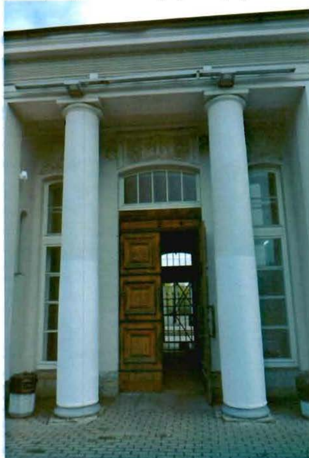
Фото № 24. Часть западного фасада павильона (Пушкин, Привокзальная пл., 1, лит Б).
