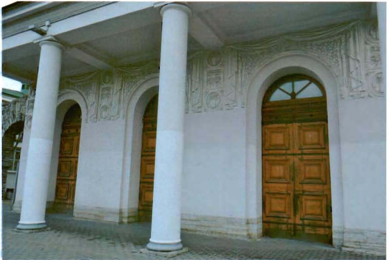
Фото №17. Западный фасад павильона (Пушкин, Привокзальная пл., 1, лит В).
