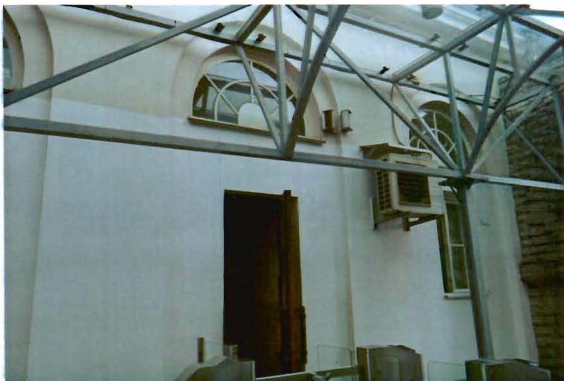
Фото №2. Часть южного фасада Главного здания. Вход в кабинет начальника вокзала.
