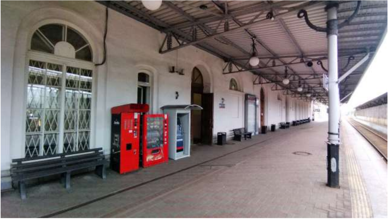
Фото 9. Вокзал., г. Пушкин (Царское Село). Архитектор: Левинсон Е.А.; Архитектор: Грушке А.А., период создания: 1950-е гг.; Платформа.
