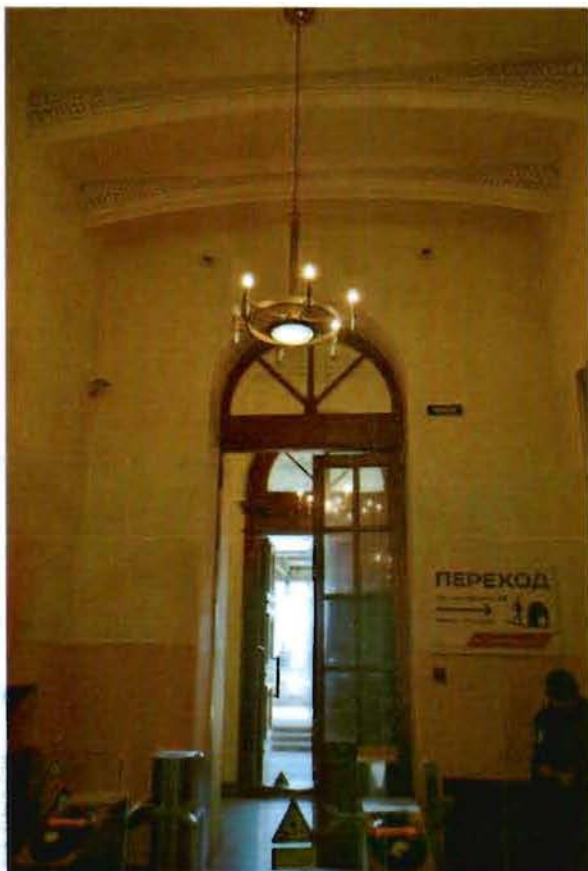
Фото №13. Интерьер Главного здания, проход между кассовым залом и залом ожидания.
