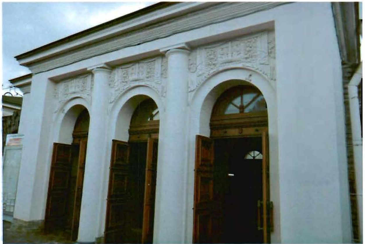
Фото №18. Восточный фасад павильона (Пушкин, Привокзальная пл., 1, лит В).
