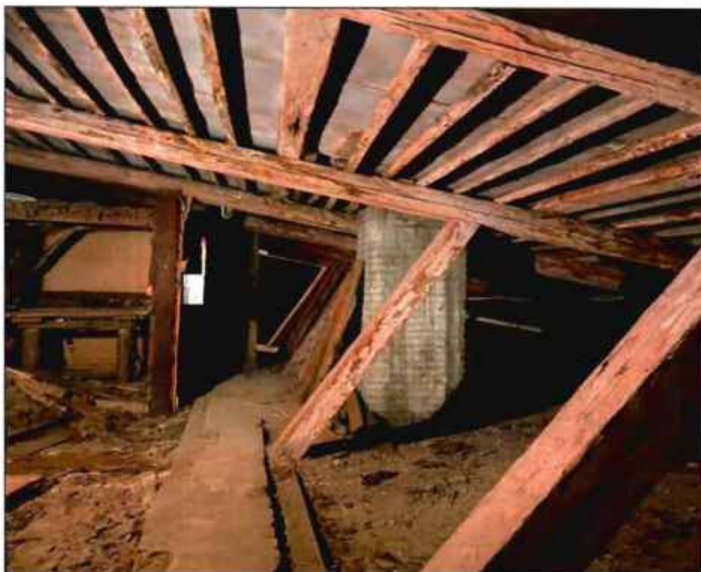
21. Стропильная система. Фото от 16.05.2022 г.
