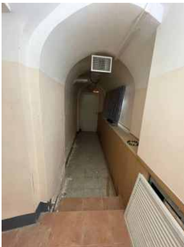
Фото 214. Интерьер подвального этажа объекта культурного наследия федерального значения «Академия», входящего в состав объекта культурного наследия федерального значения «Российская Академия»
