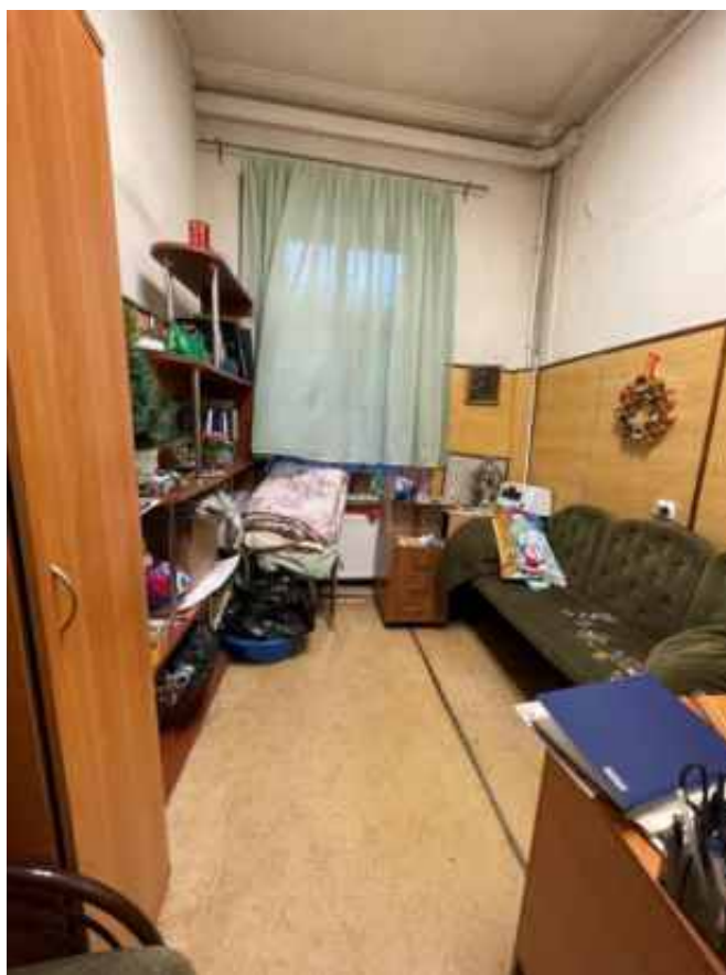
Фото 152. Интерьер 1 этажа объекта культурного наследия федерального значения «Академия», входящего в состав объекта культурного наследия федерального значения «Российская Академия»
