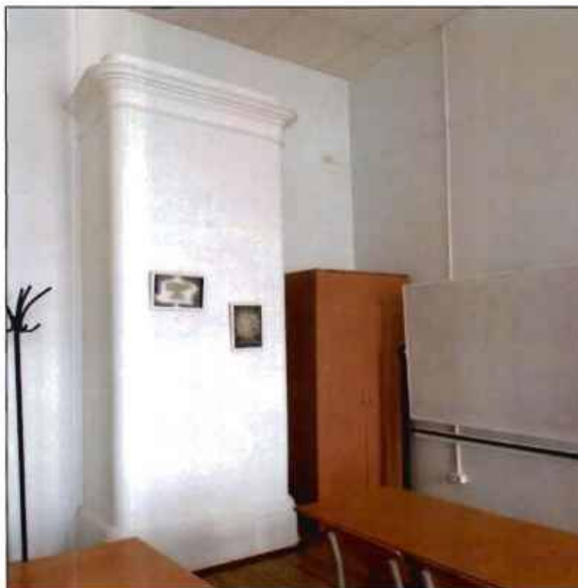
24. Печь в уровне 2-го этажа (окрашена). Фото от 18.02.2022 г.
