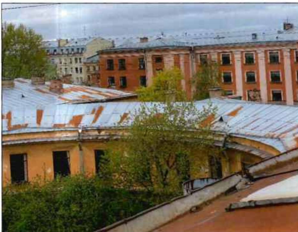
22. Металлическая кровля. Фото от 16.05.2022 г.
