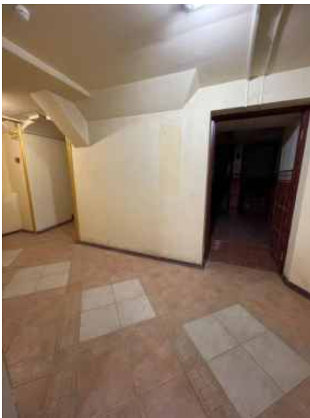
Фото 189. Интерьер подвального этажа объекта культурного наследия федерального значения «Академия», входящего в состав объекта культурного наследия федерального значения «Российская Академия»
