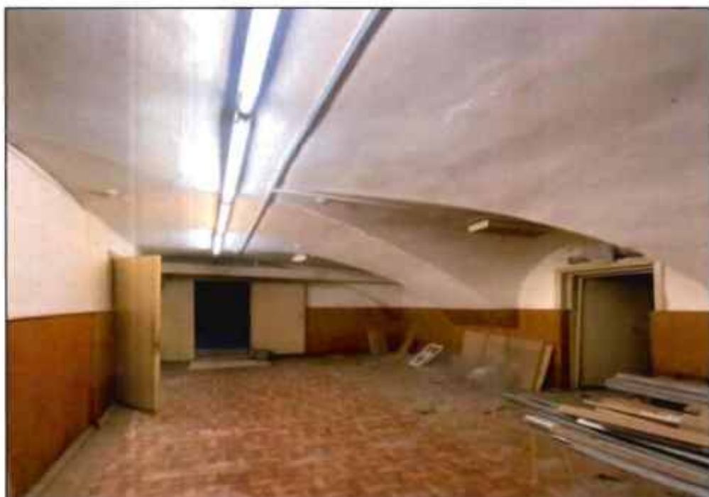
18. Помещения цокольного этажа. Фото от 18.02.2022 г.
