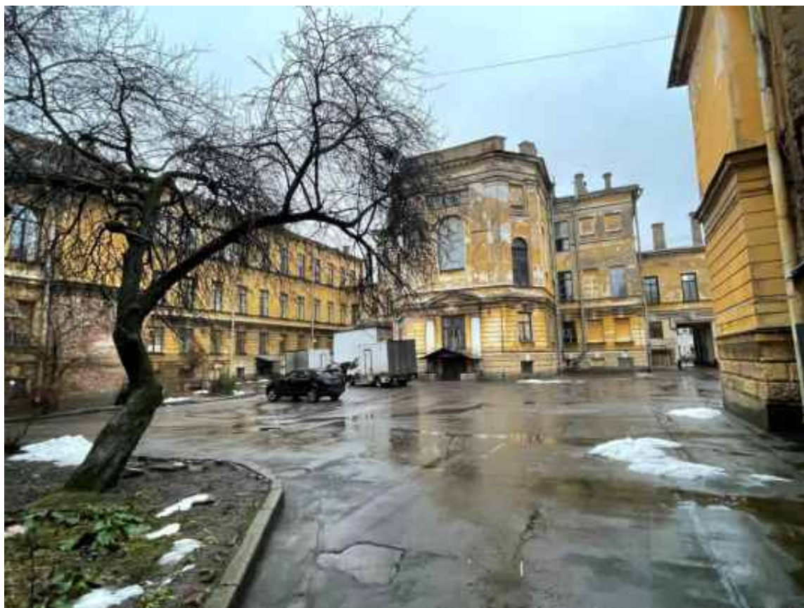
Фото 16. Фрагмент дворового фасада объекта культурного наследия федерального значения «Академия», входящего в состав объекта культурного наследия федерального значения «Российская Академия»
