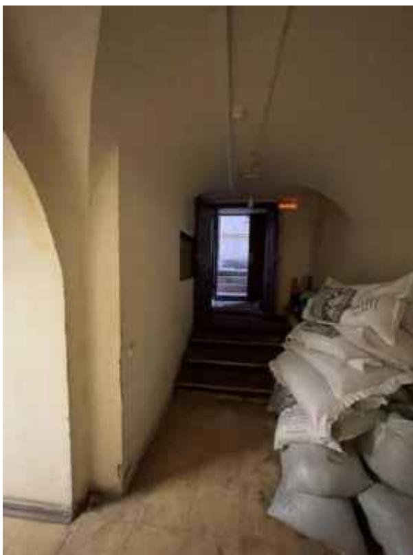
Фото 177. Интерьер подвального этажа объекта культурного наследия федерального значения «Академия», входящего в состав объекта культурного наследия федерального значения «Российская Академия»
