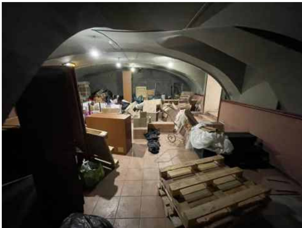
Фото 185. Интерьер подвального этажа объекта культурного наследия федерального значения «Академия», входящего в состав объекта культурного наследия федерального значения «Российская Академия»
