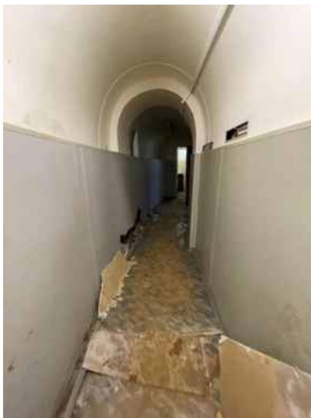
Фото 210. Интерьер подвального этажа объекта культурного наследия федерального значения «Академия», входящего в состав объекта культурного наследия федерального значения «Российская Академия»
