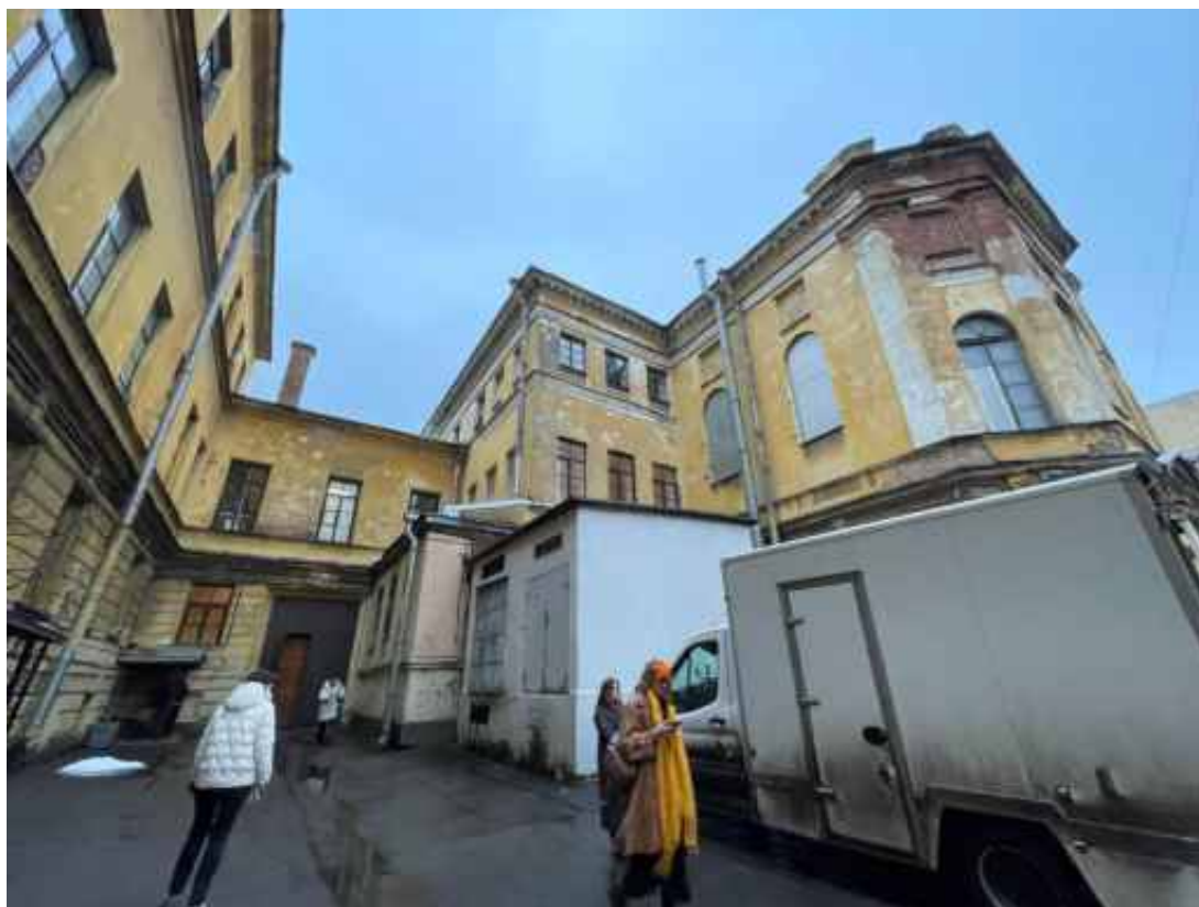
Фото 10. Фрагмент дворового фасада объекта культурного наследия федерального значения «Академия», входящего в состав объекта культурного наследия федерального значения «Российская Академия»
