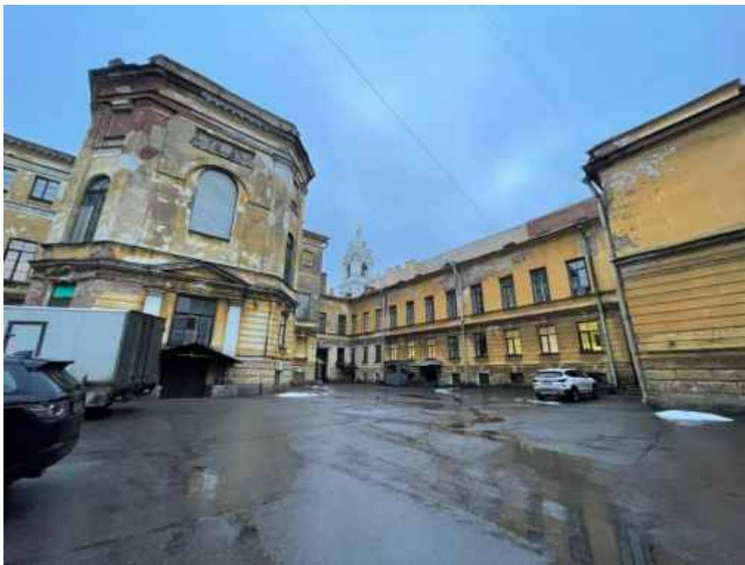
Фото 7. Фрагмент дворового фасада объекта культурного наследия федерального значения «Академия», входящего в состав объекта культурного наследия федерального значения «Российская Академия»
