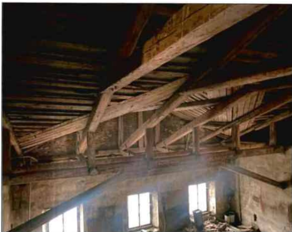
19. Стропильная система. Фото от 18.02.2022 г.
