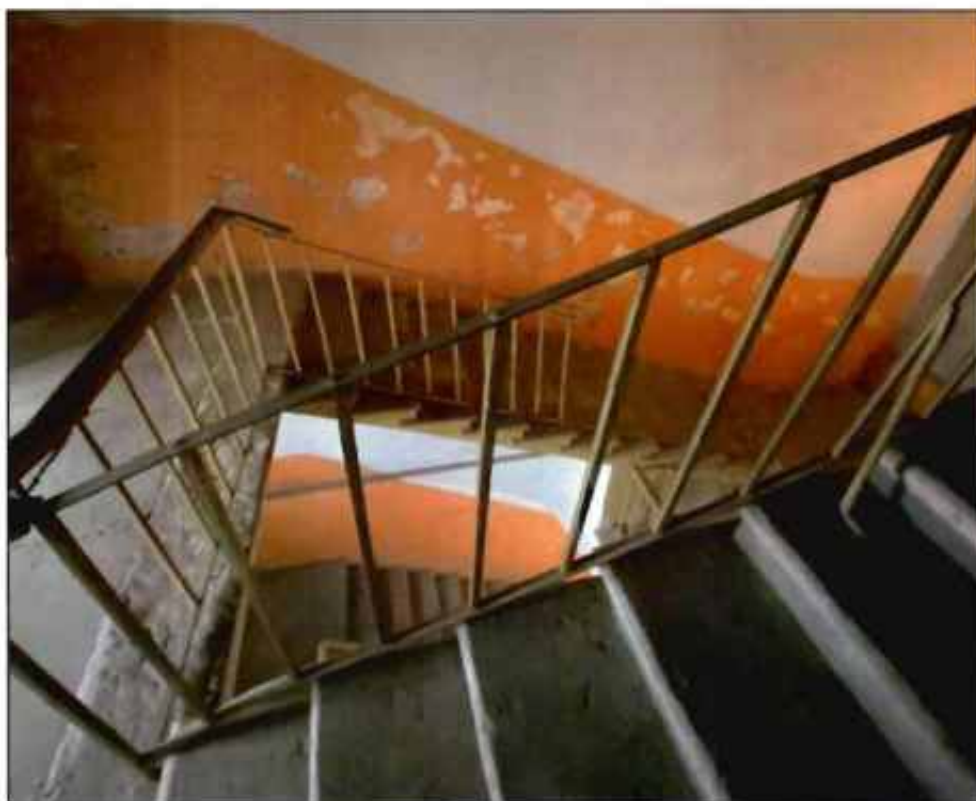
16. Южная лестница главного корпуса двухмаршевая по косоурам. Фото от 16.05.2022 г.
