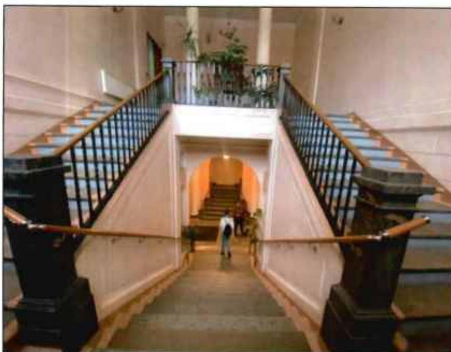
13. . Главная лестница средистенная распашная (пом. 25-Н (88)) в уровне 2-го этажа, с ограждениями в виде металлических вертикальных стоек с перехватами.
