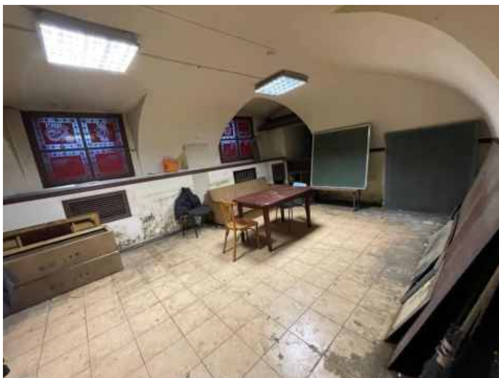
Фото 178. Интерьер подвального этажа объекта культурного наследия федерального значения «Академия», входящего в состав объекта культурного наследия федерального значения «Российская Академия»
