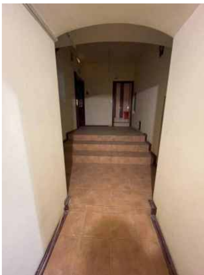
Фото 190. Интерьер подвального этажа объекта культурного наследия федерального значения «Академия», входящего в состав объекта культурного наследия федерального значения «Российская Академия»
