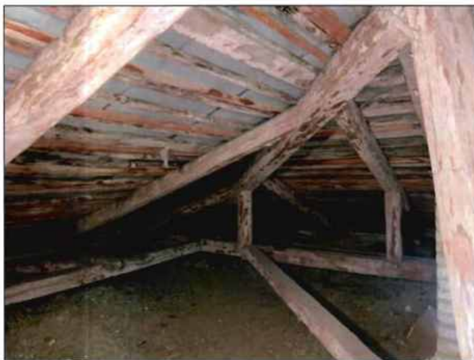
20. Стропильная система. Фото от 18.02.2022 г.
