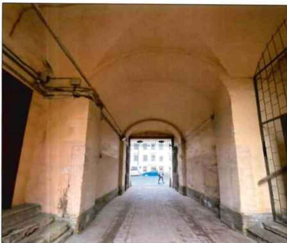
5. Арка воротного проезда южного бокового флигеля лицевого фасада. Фото от 16.05.2022 г.
