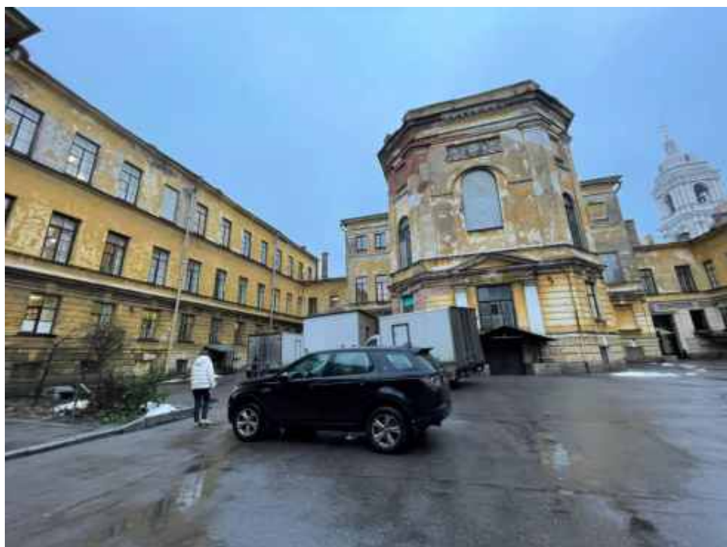
Фото 8. Фрагмент дворового фасада объекта культурного наследия федерального значения «Академия», входящего в состав объекта культурного наследия федерального значения «Российская Академия»
