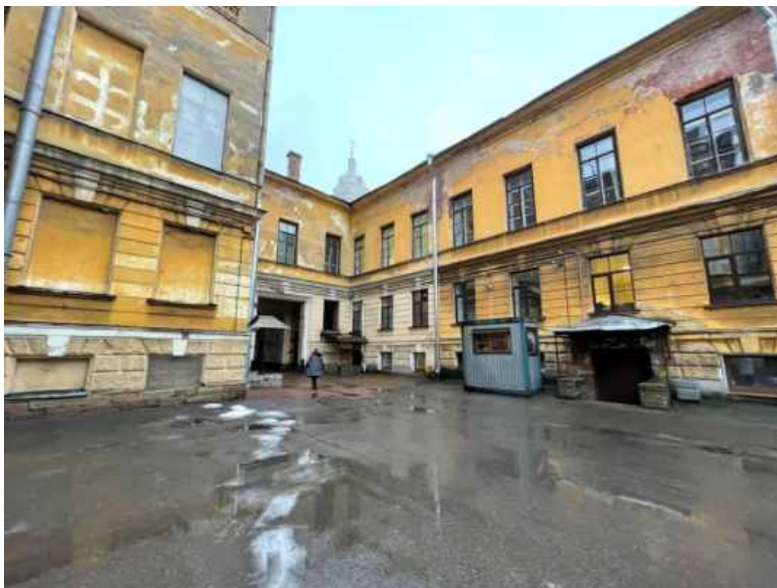
Фото 13. Фрагмент дворового фасада объекта культурного наследия федерального значения «Академия», входящего в состав объекта культурного наследия федерального значения «Российская Академия»
