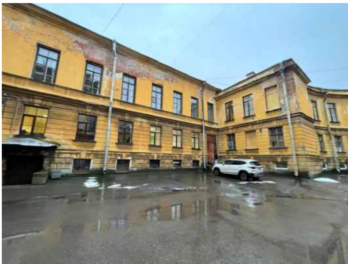
Фото 12. Фрагмент дворового фасада объекта культурного наследия федерального значения «Академия», входящего в состав объекта культурного наследия федерального значения «Российская Академия»
