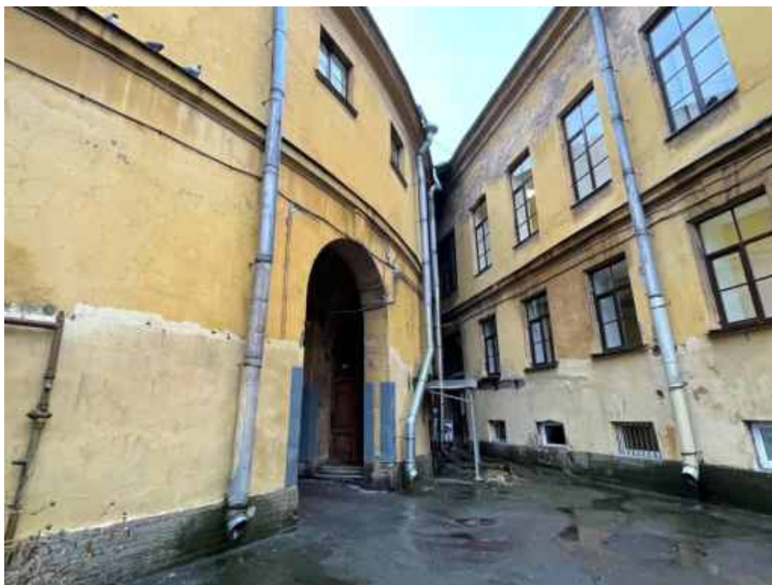
Фото 17. Фрагмент дворового фасада объекта культурного наследия федерального значения «Академия», входящего в состав объекта культурного наследия федерального значения «Российская Академия»
