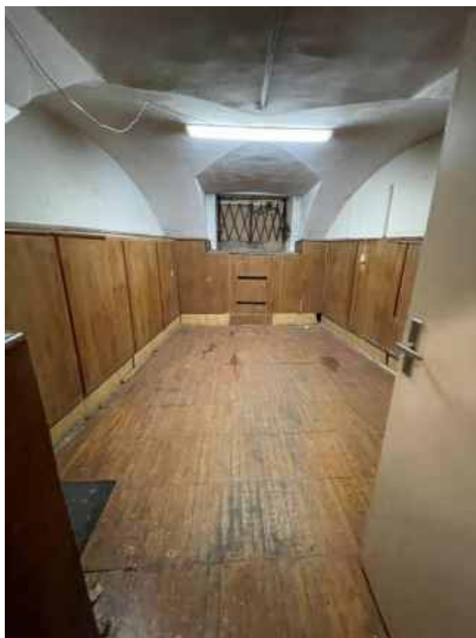
Фото 208. Интерьер подвального этажа объекта культурного наследия федерального значения «Академия», входящего в состав объекта культурного наследия федерального значения «Российская Академия»
