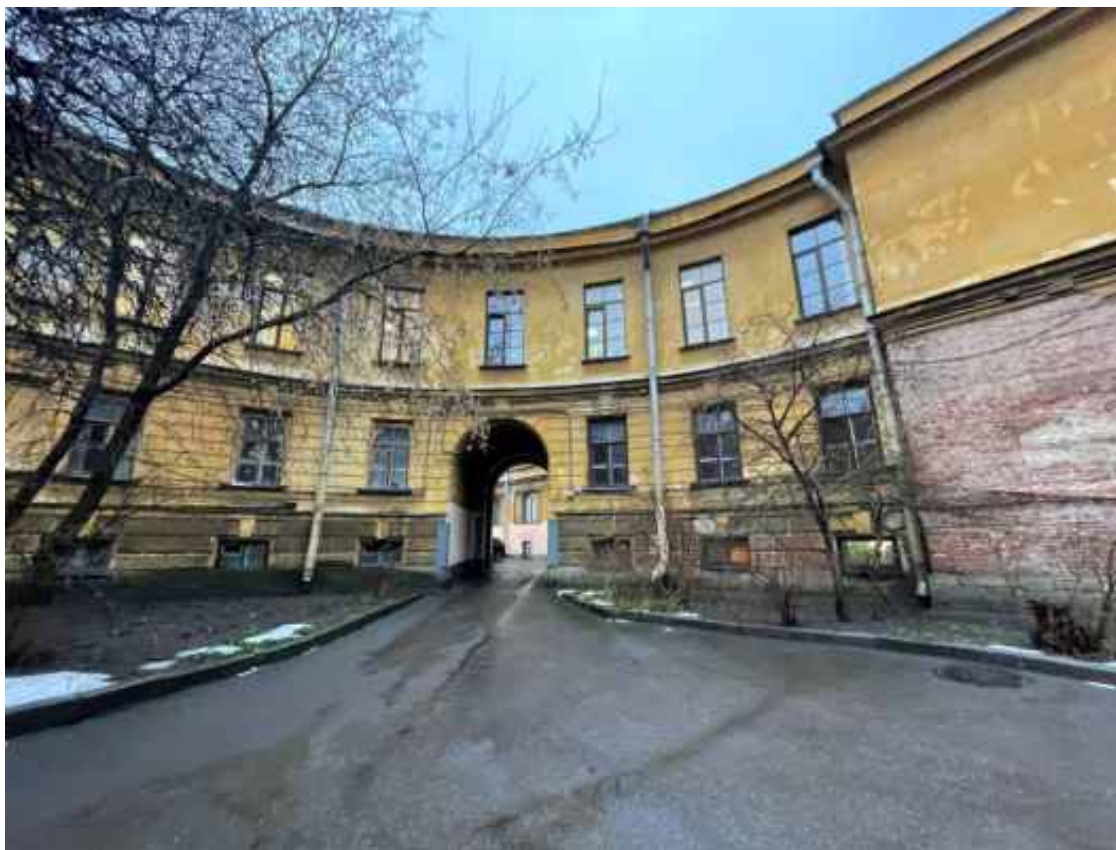
Фото 9. Фрагмент дворового фасада объекта культурного наследия федерального значения «Академия», входящего в состав объекта культурного наследия федерального значения «Российская Академия»
