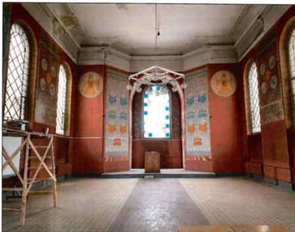
11. Аванзал Церкви (пом.25-Н (140)). Фото от 16.05.2022 г.
