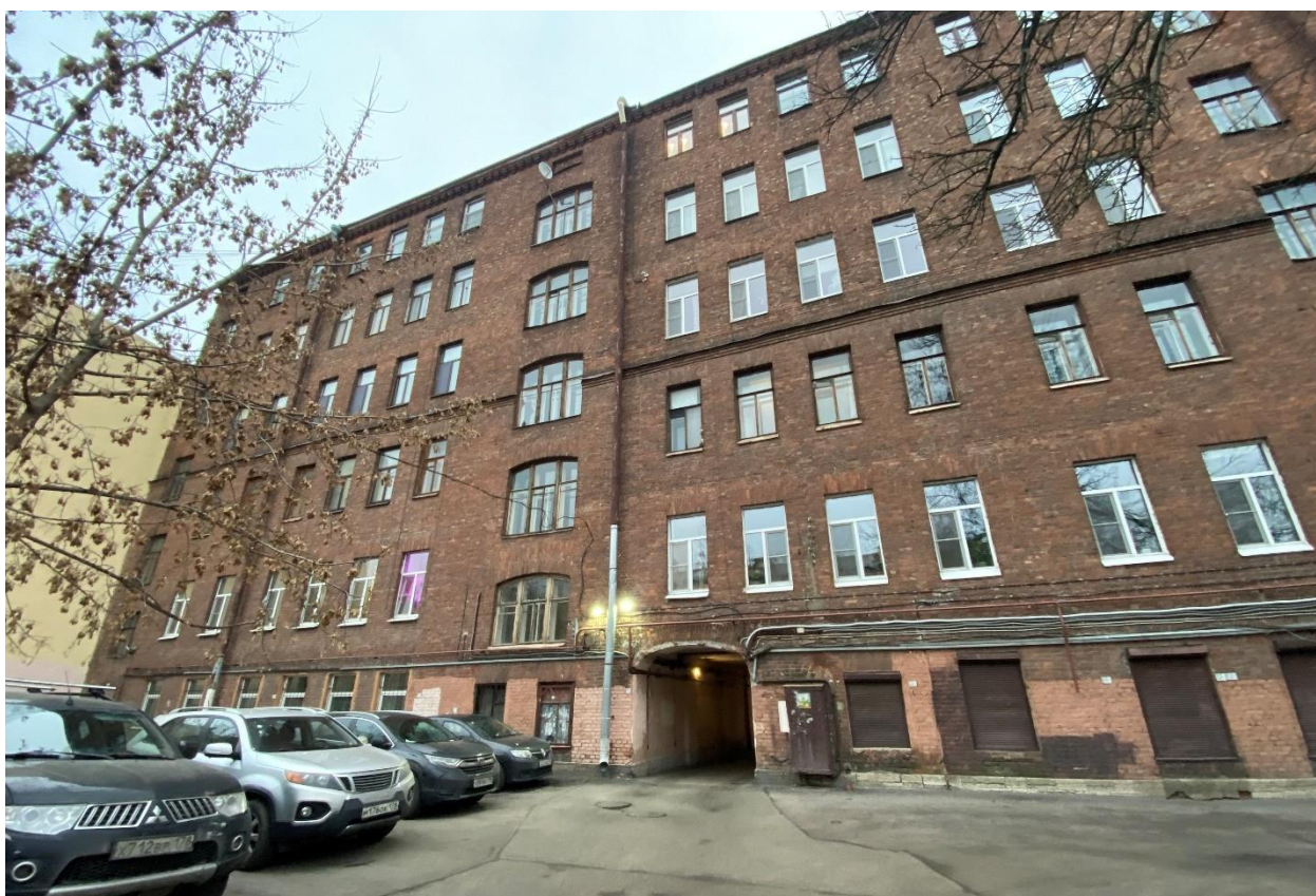
Фото 4. Вид на дворовой фасад.
