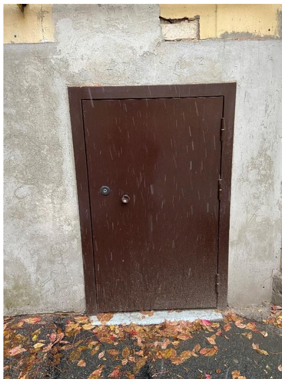
Фото 7. Вид на входной проем исследуемого помещения со двора.
