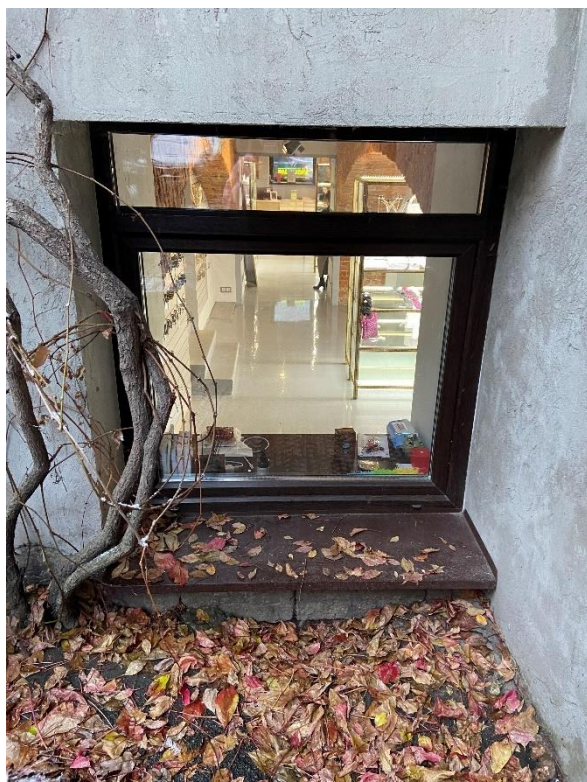
Фото 6. Вид на оконный проем исследуемого помещения со двора.
