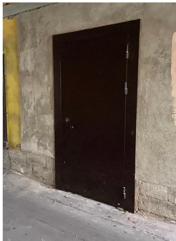
Фото 3. Вид на окно и дверь со стороны дворового фасада.
