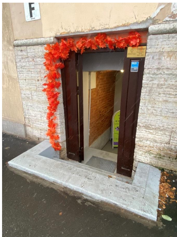
Фото 2. Вид на входную дверь со стороны лицевого фасада.
