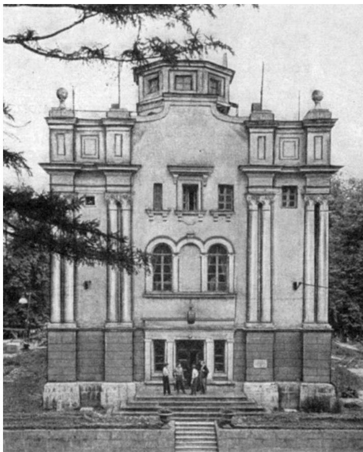
Илл.9. Фото 1937 г. Здание лаборатории электроакустики СПбГЭТУ "ЛЭТИ". Retro View of Mankind's Habitat [Электронный ресурс]. Режим доступа: https://pastvu.com/ .
