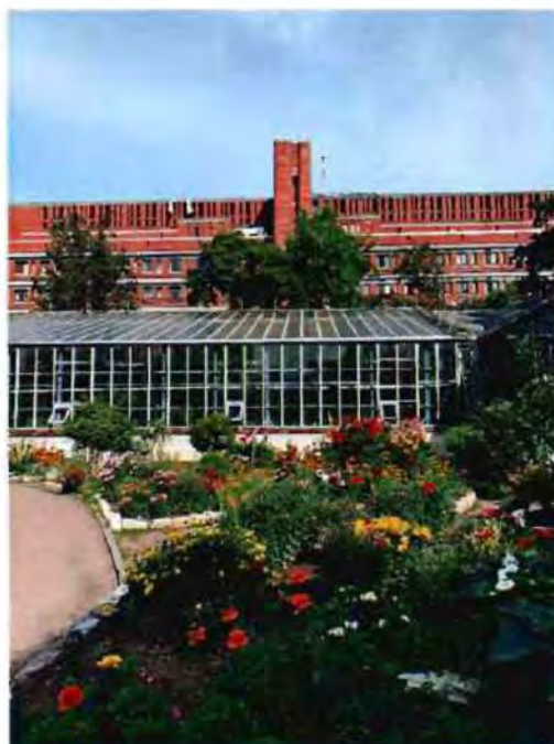
5. Фрагмент объекта культурного наследия с северной стороны (фото от 11.08.2023).
