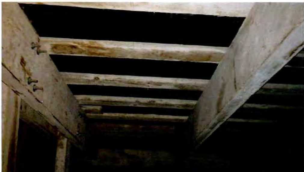
5. Стропильная система.
