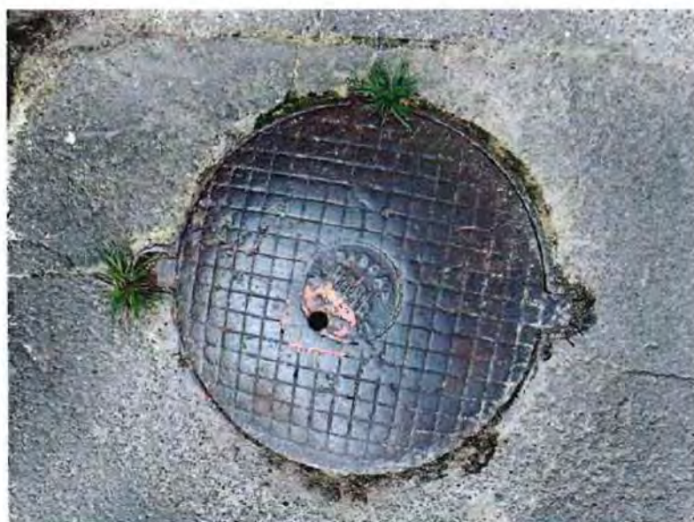
23. Крышка канализационного колодца в западной части объекта культурного наследия (фото от 25.08.2023).
