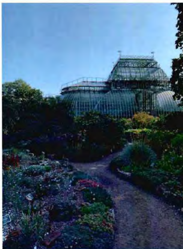
1. Фрагмент объекта культурного наследия с северной стороны (фото от 25.08.2023).
