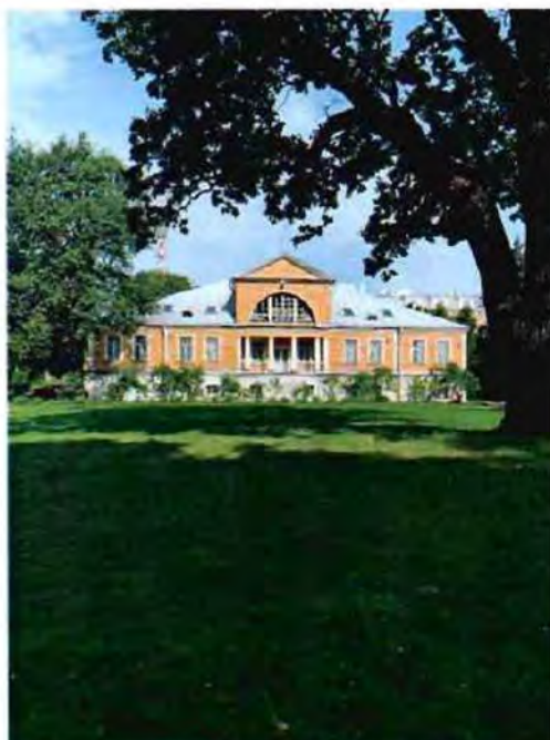
7. Фрагмент объекта культурного наследия с северо-восточной стороны (фото от 11.08.2023).
