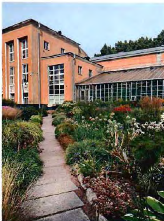
4. Фрагмент объекта культурного наследия с северной стороны (фото от 11.08.2023).
