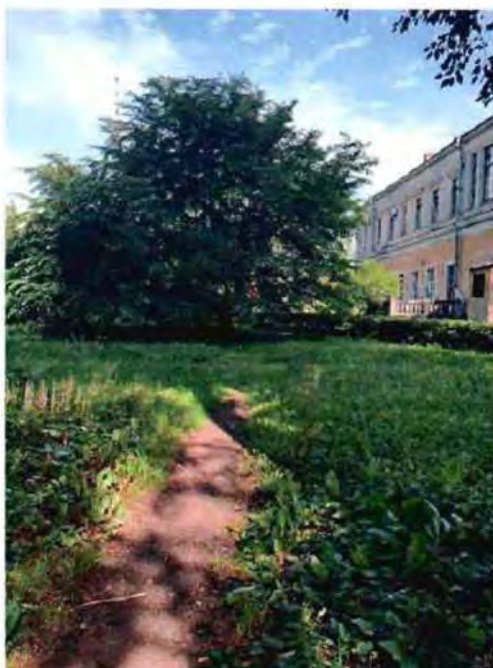
10. Фрагмент объекта культурного наследия с северо-восточной стороны (фото от 11.08.2023).
