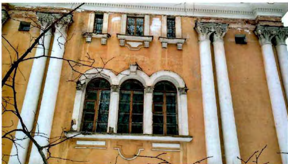
6. Исторические оконные проемы.
