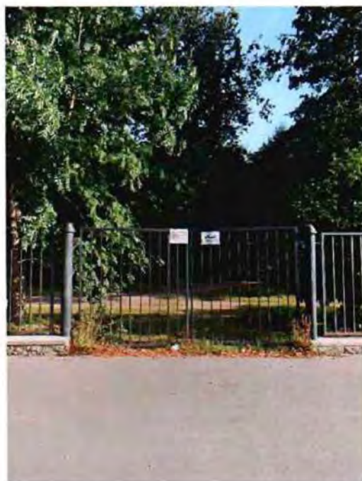
27. Фрагмент ограды объекта культурного наследия с южной стороны (фото от 13.09.2023).
