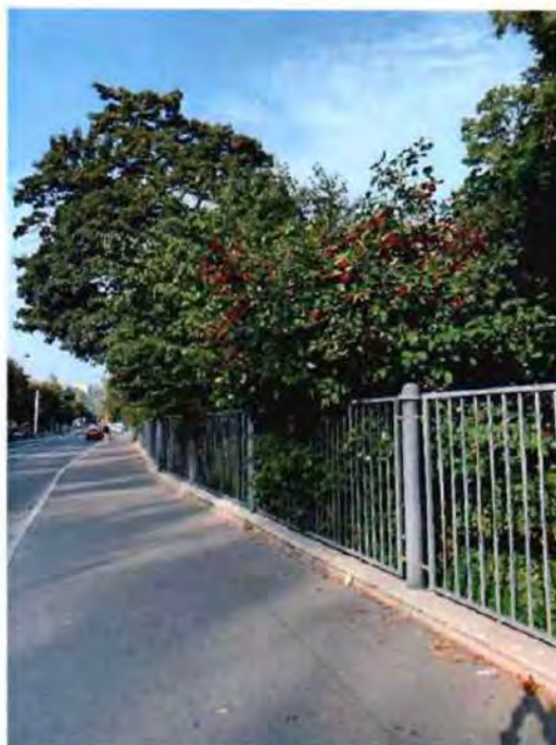
26. Фрагмент ограды объекта культурного наследия с южной стороны (фото от 13.09.2023).
