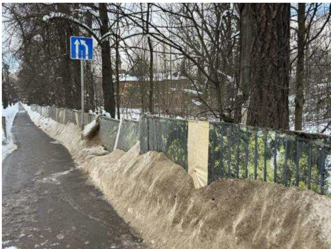
50. Ограда с западной стороны выявленного объекта культурного наследия «Офицерское собрание лейб-гвардии 1-го Стрелкового полка (с садом)». Вид с юго-запада от Павловского шоссе. 29.01.2026 г.
