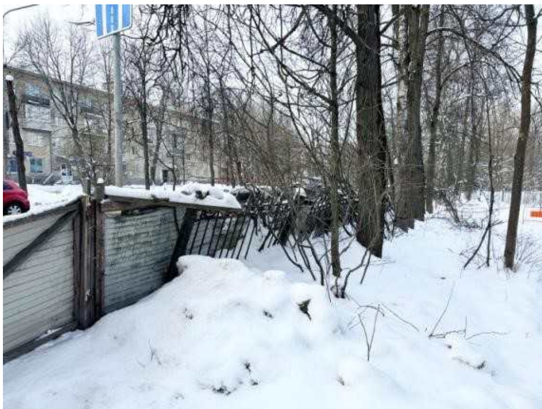
52. Фрагмент ограды с западной стороны выявленного объекта культурного наследия «Офицерское собрание лейб-гвардии 1-го Стрелкового полка (с садом)». Вид с юго-востока. 29.01.2026 г.
