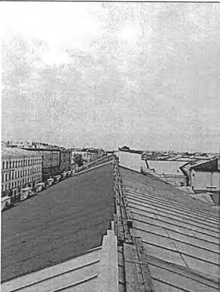
Фото 17. Кровля по Садовой линии
