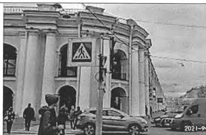
Фото 2. Фасад Невской и Садовой линии
