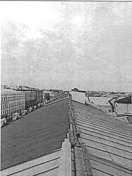
Фото 17. Кровля по Садовой линии
