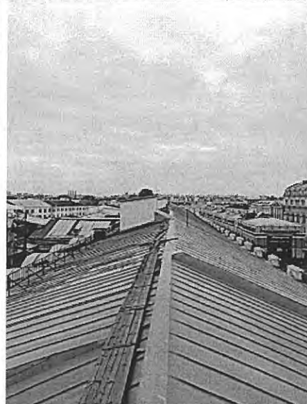
Фото 18. Кровля по Перинной линии
