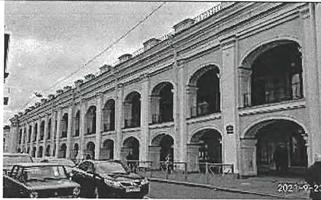
Фото 3. Фасад Садовой линии
