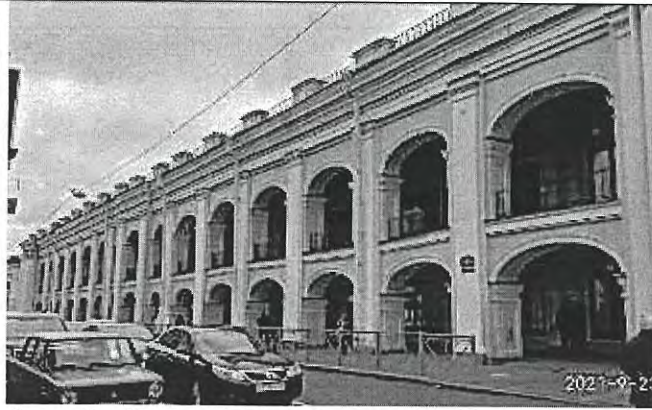
Фото 3. Фасад Садовой линии
