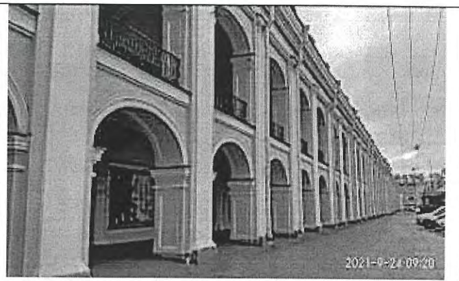
Фото 4. Фасад Садовой линии
