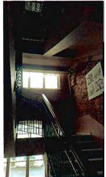
7. Лестница. (Невский пр-кт, дом 35, лит. В)
