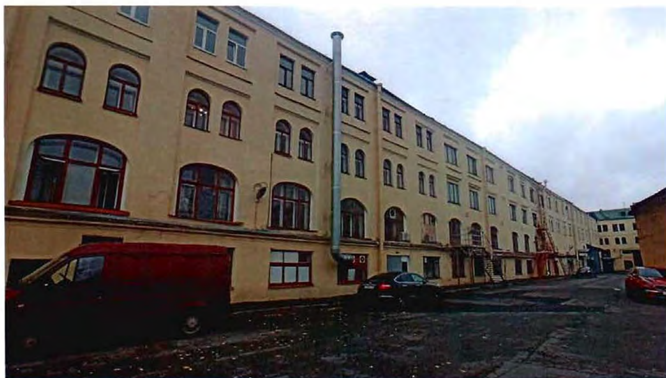
3. Вид на западный дворовой фасад объекта культурного наследия (Невский проспект, дом 35, лит. В).
