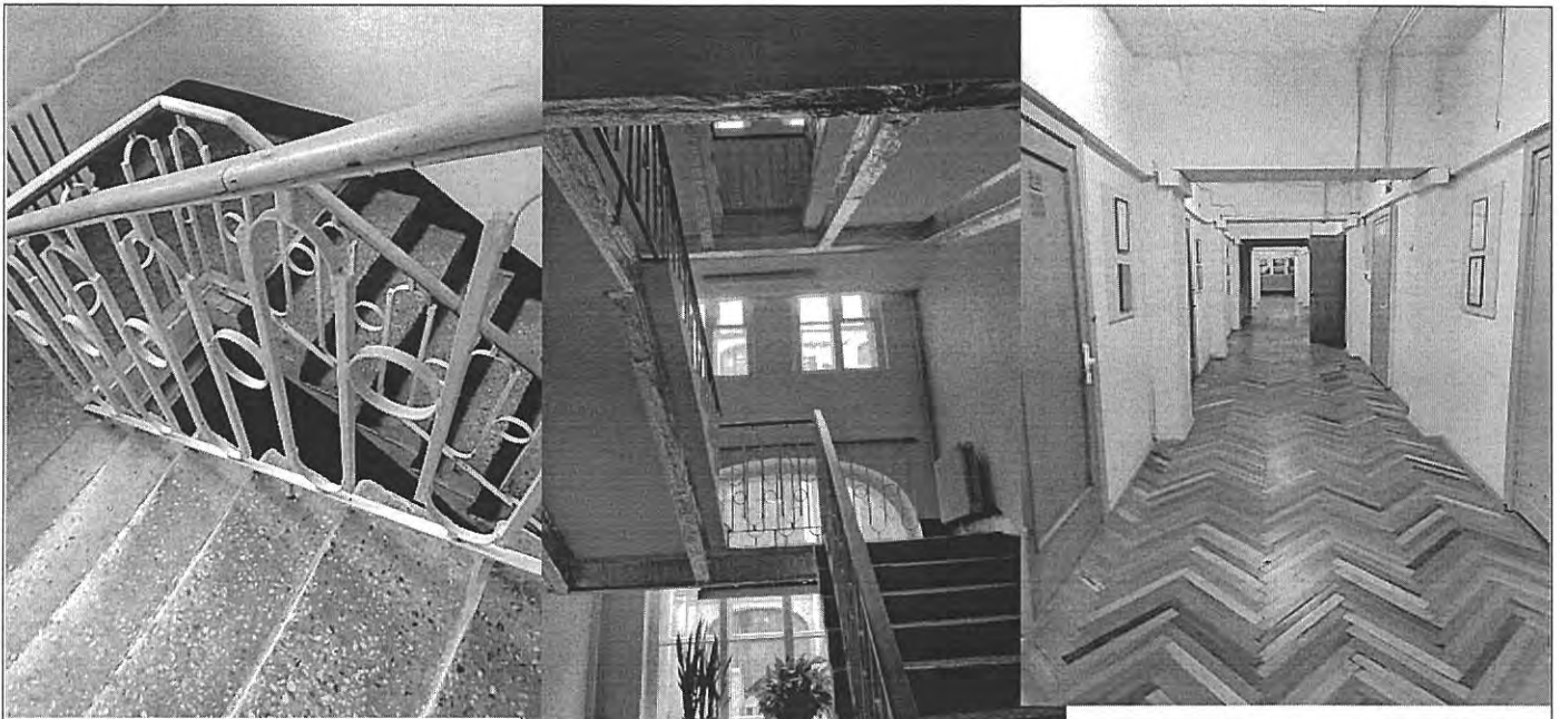
Фото 25-27. Лестница и коридор в дворовом корпусе
