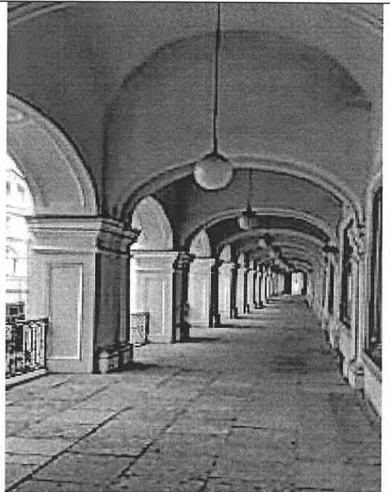
Фото 8. Крытая арочная галерея Ломоносовской линии 2 этажа
