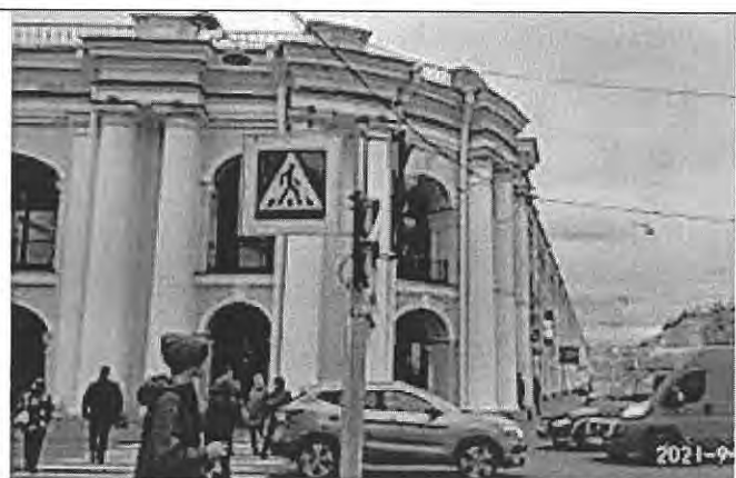
Фото 2. Фасад Невской и Садовой линии
