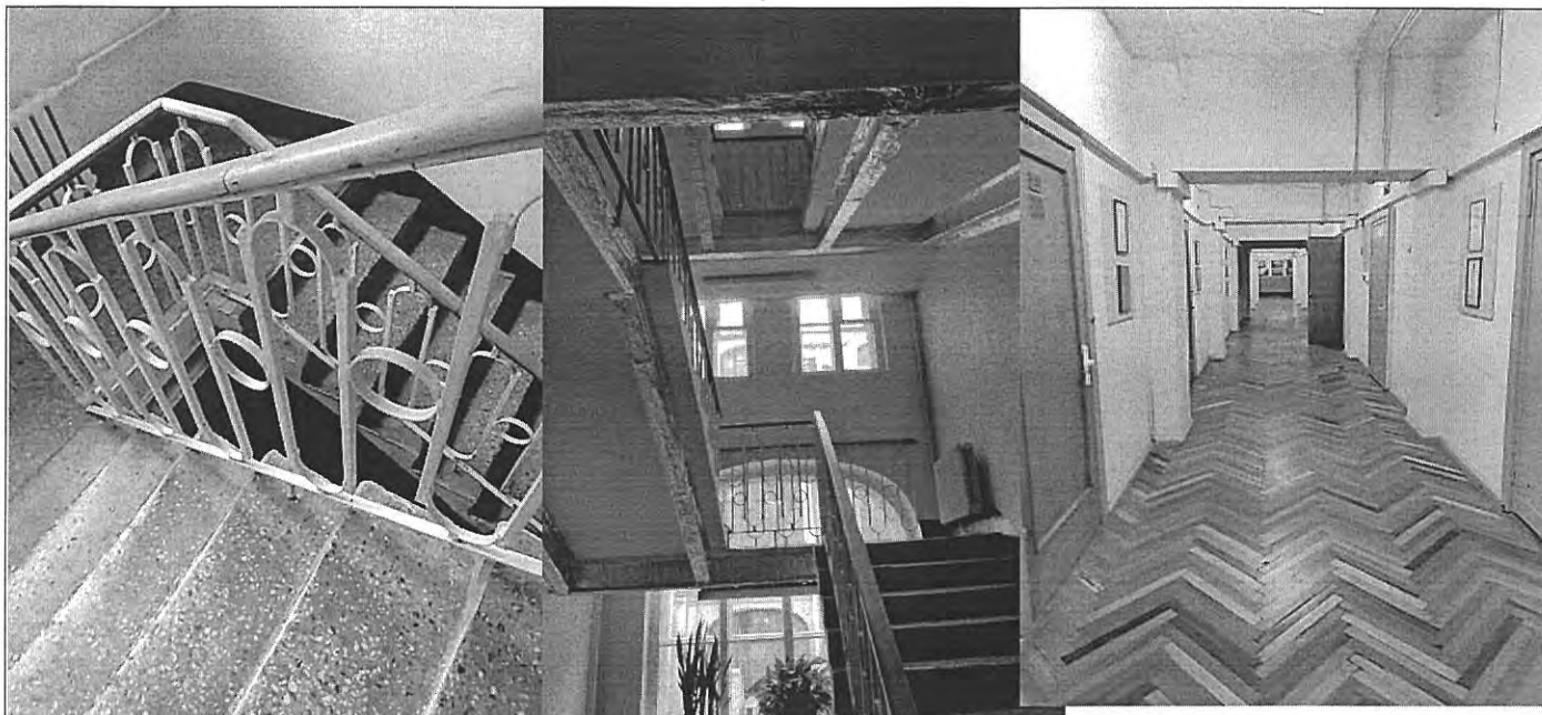
Фото 25-27. Лестница и коридор в дворовом корпусе
