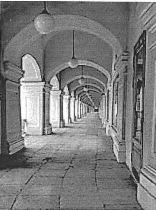
Фото 7. Крытая арочная галерея Садовой линии 1 этажа
