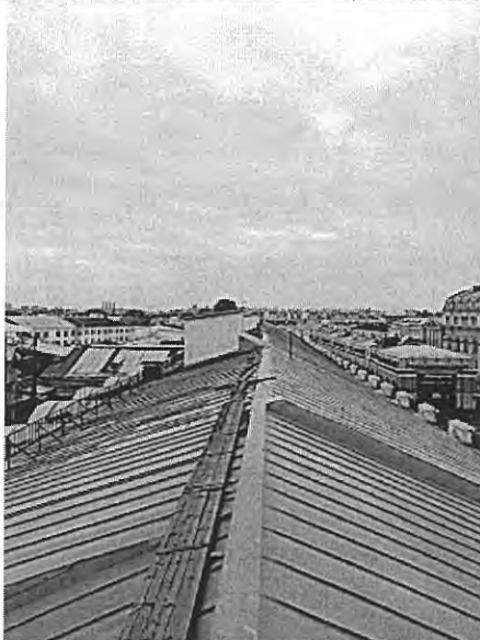
Фото 18. Кровля по Перинной линии
