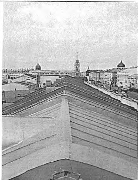
Фото 15. Кровля по Невской линии
