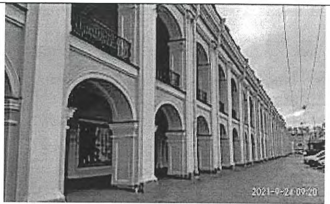
Фото 4. Фасад Садовой линии
