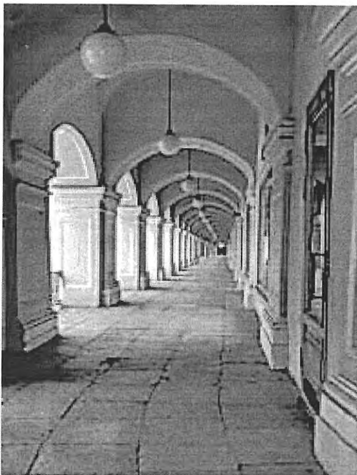
Фото 7. Крытая арочная галерея Садовой линии 1 этажа
