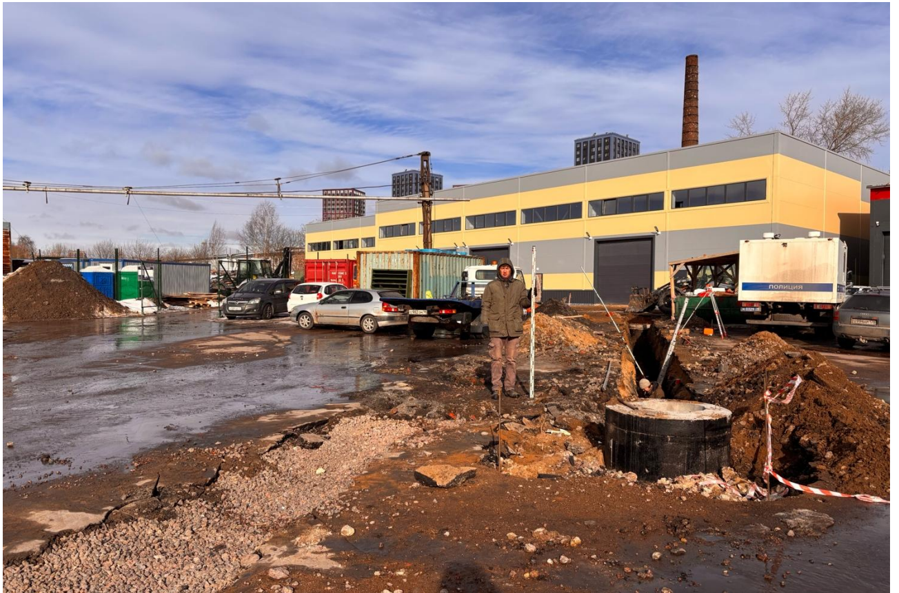
Рис. 27. СПБ-2026. Выборгский район. Шурф №1. Общий вид до начала работ. Вид с юга.
