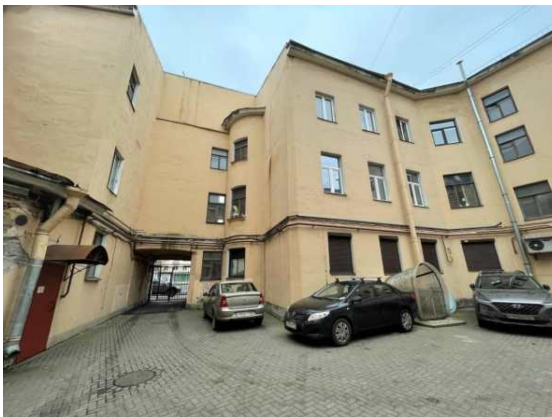
Фото 6. Фрагмент дворового фасада выявленного объекта культурного наследия «Дом А. Эрке»
