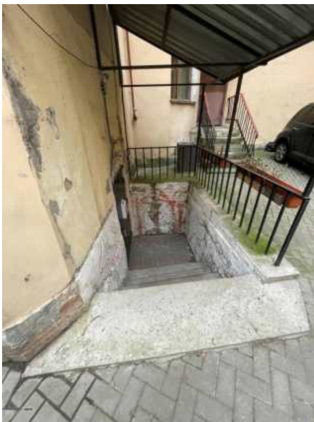
Фото 7. Фрагмент дворового фасада выявленного объекта культурного наследия «Дом А. Эрке», вход в пом. 2-Н
