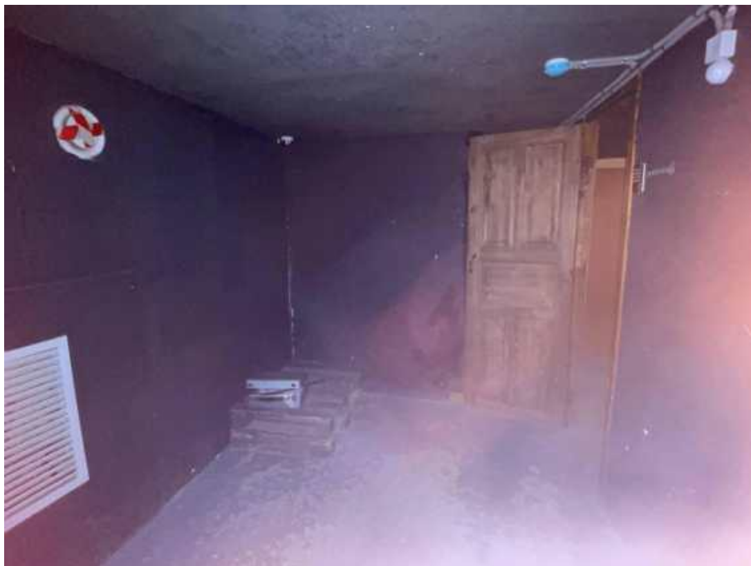
Фото 29. Интерьер пом. 2-Н выявленного объекта культурного наследия «Дом А. Эрке»
