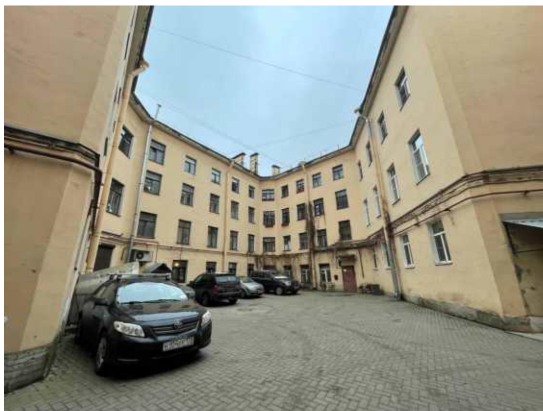
Фото 4. Фрагмент дворового фасада выявленного объекта культурного наследия «Дом А. Эрке»
